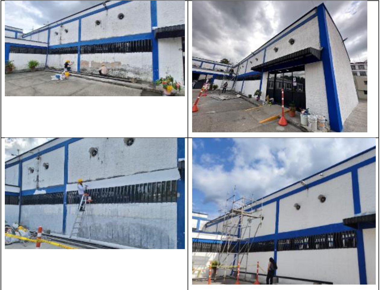
Ilustración 10. Mantenimiento Instalaciones CDU, Universidad del Cauca.
