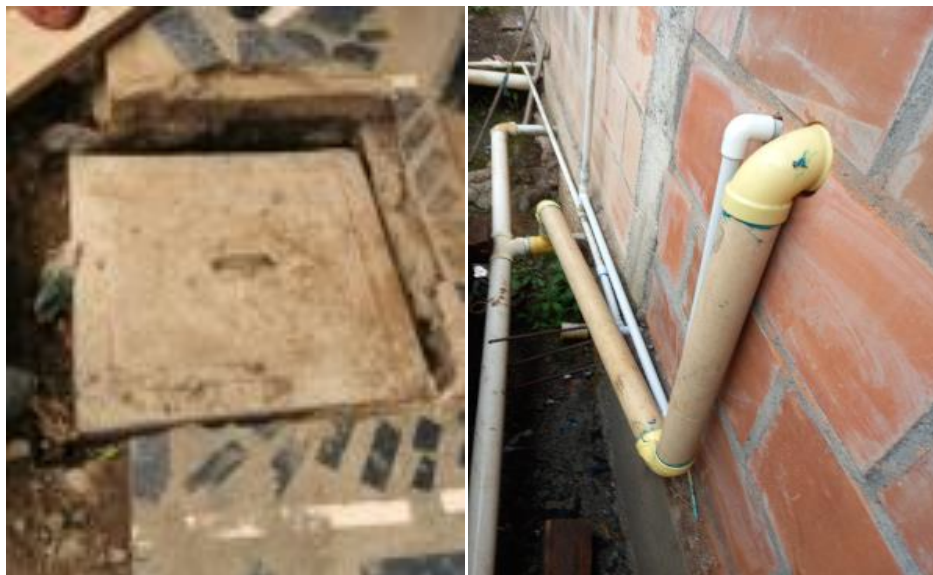
Ilustración 27. Instalación de puntos hidráulicos y sanitarios.
