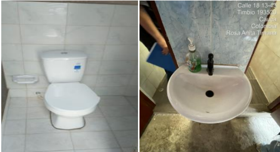
Ilustración 38. Instalación de combo sanitario y lavamanos.
