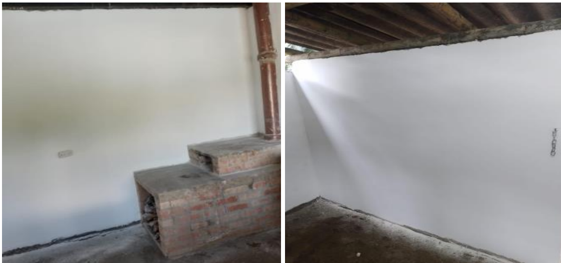
Ilustración 31. Acabados de estuco y pintura.
