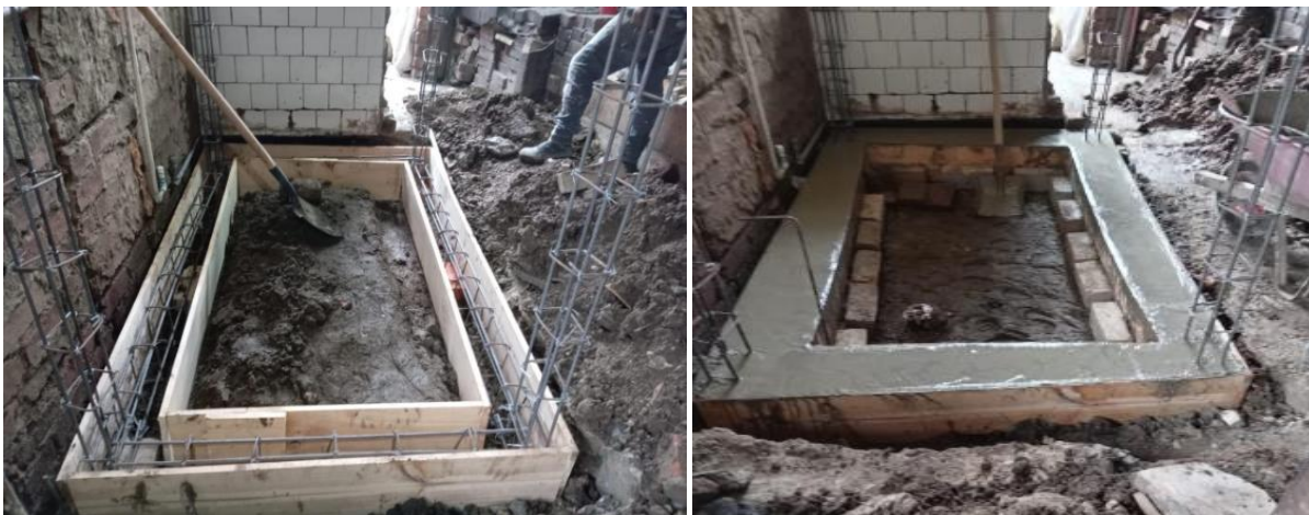
Ilustración 33. Instalación de acero de refuerzo y vaciado de concreto.
