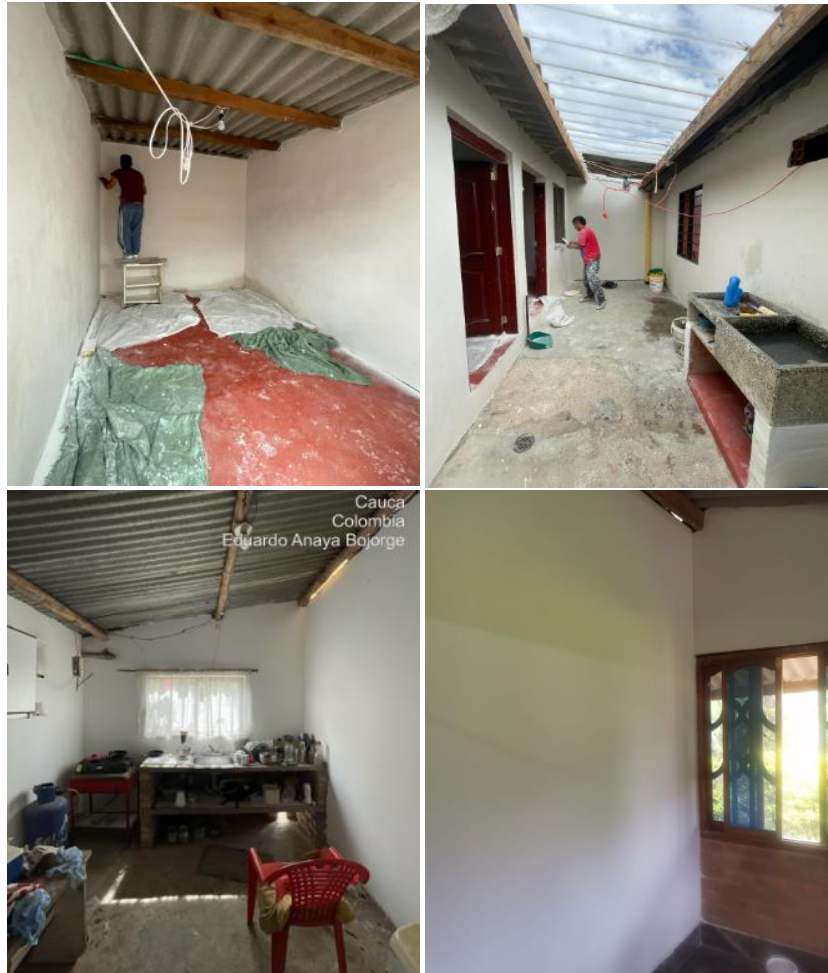
Ilustración 23. Proceso de estucado y pintado de muros
