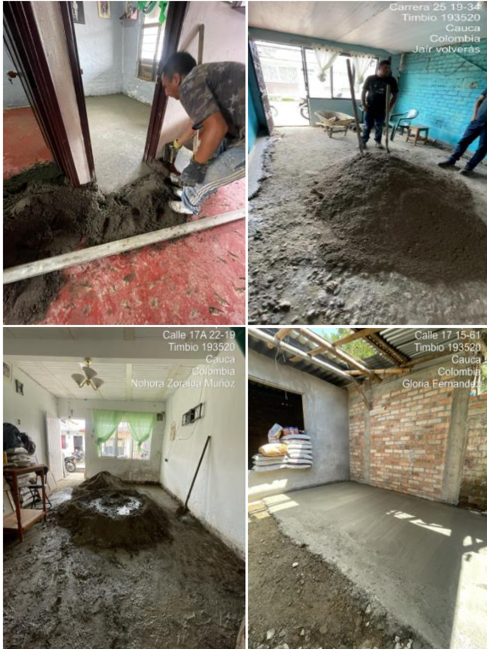
Ilustración 19. Proceso constructivo del mortero de nivelación.
