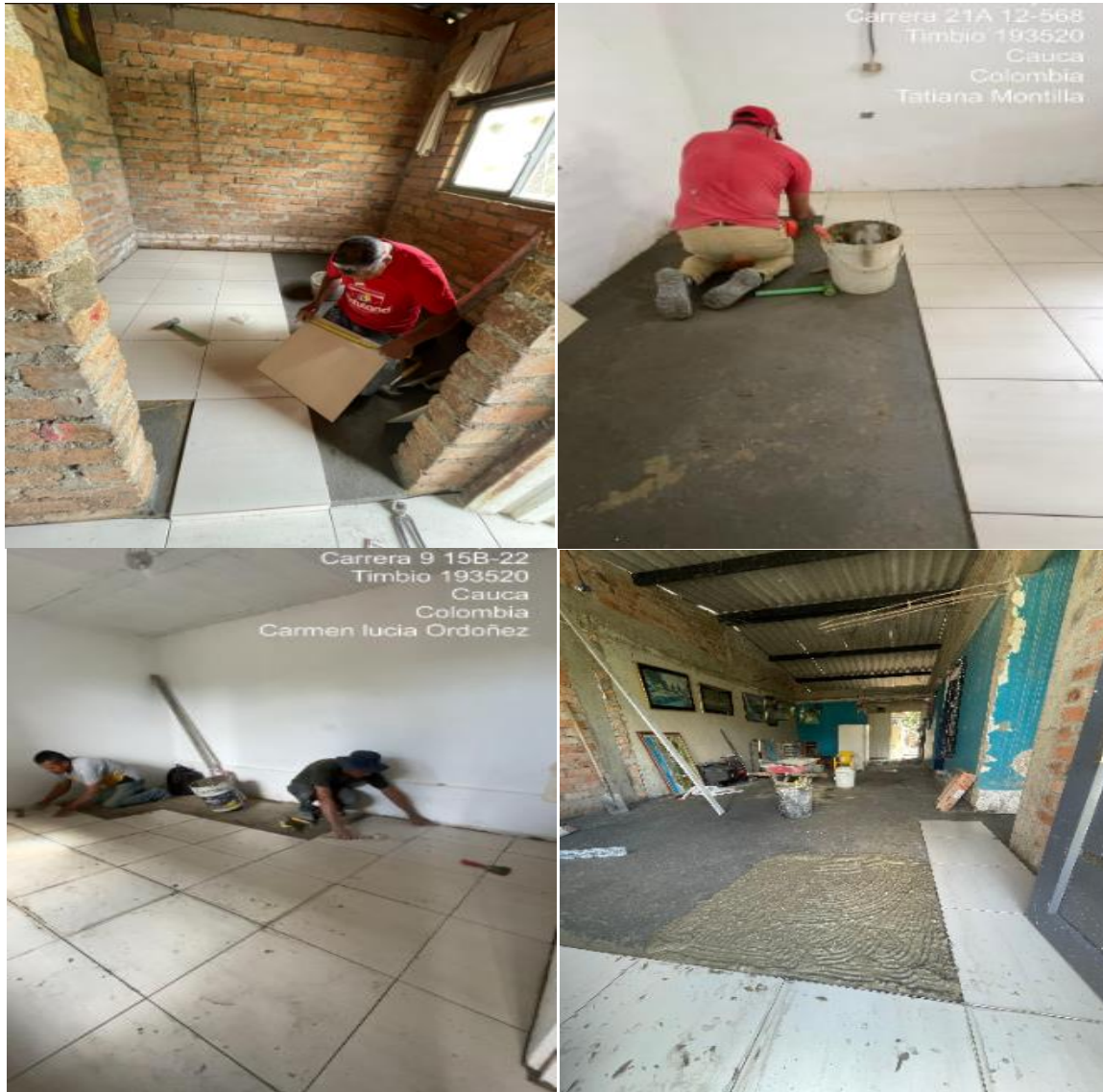
Ilustración 20. Instalación de enchape de piso y guarda escoba.
