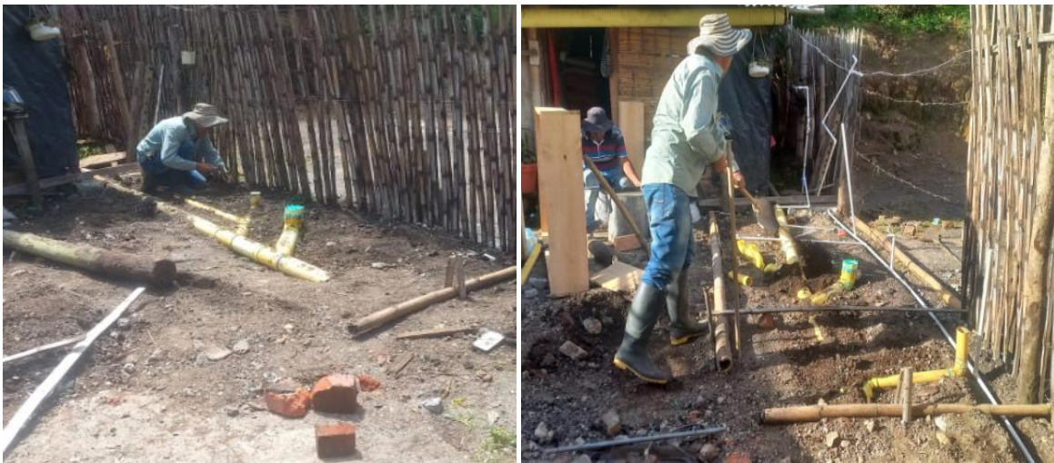
Ilustración 32. Instalación de puntos hidráulicos y sanitarios.
