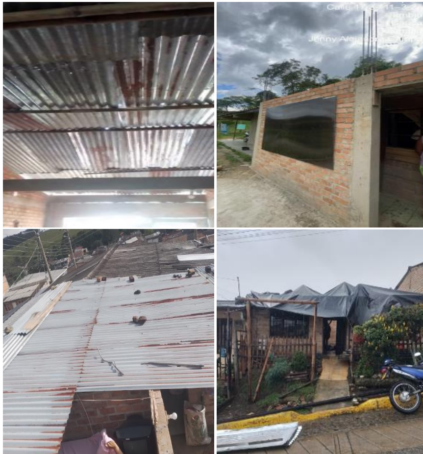
Ilustración 24. Proceso de desmonte de Cubierta.
