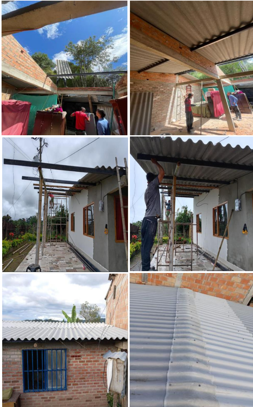
Ilustración 26. Instalación de las tejas de fibrocemento y caballetes.
