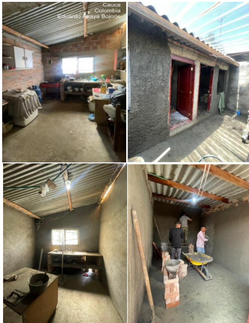
Ilustración 22. Proceso de pañetado de muros.
