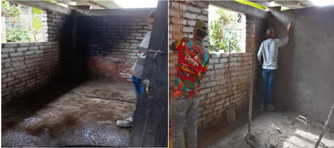
Ilustración 28. Proceso de pañetado de muros.
