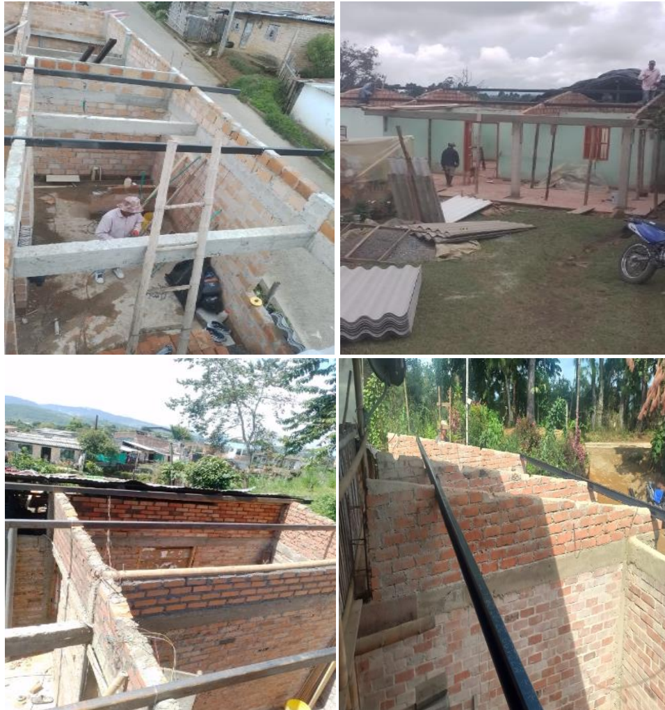
Ilustración 25. Proceso de instalación de perlines metálicos.
