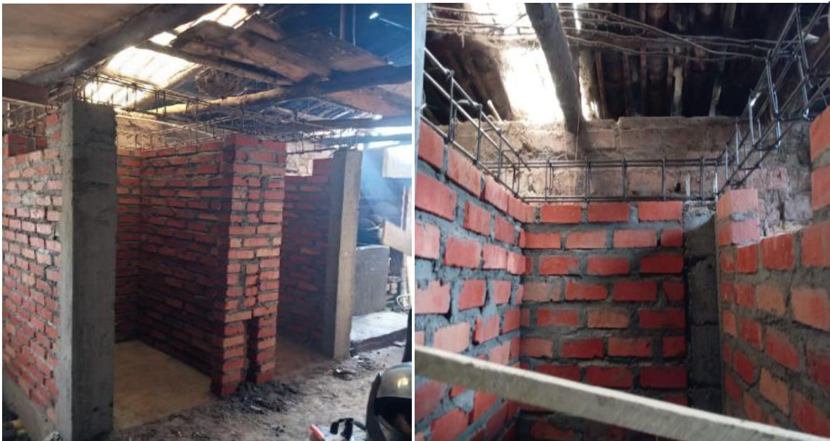
Ilustración 35. Instalación de acero para vigas de amarre según planos.
