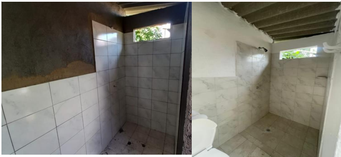
Ilustración 37. Instalación de enchape para piso y muros.
