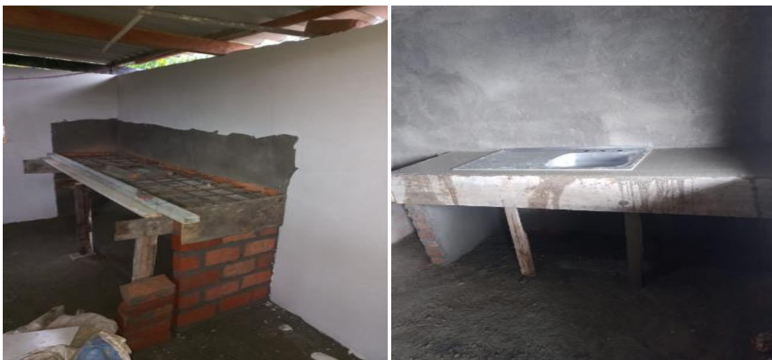
Ilustración 29. Instalación de acero de refuerzo y concreto para el mesón.
