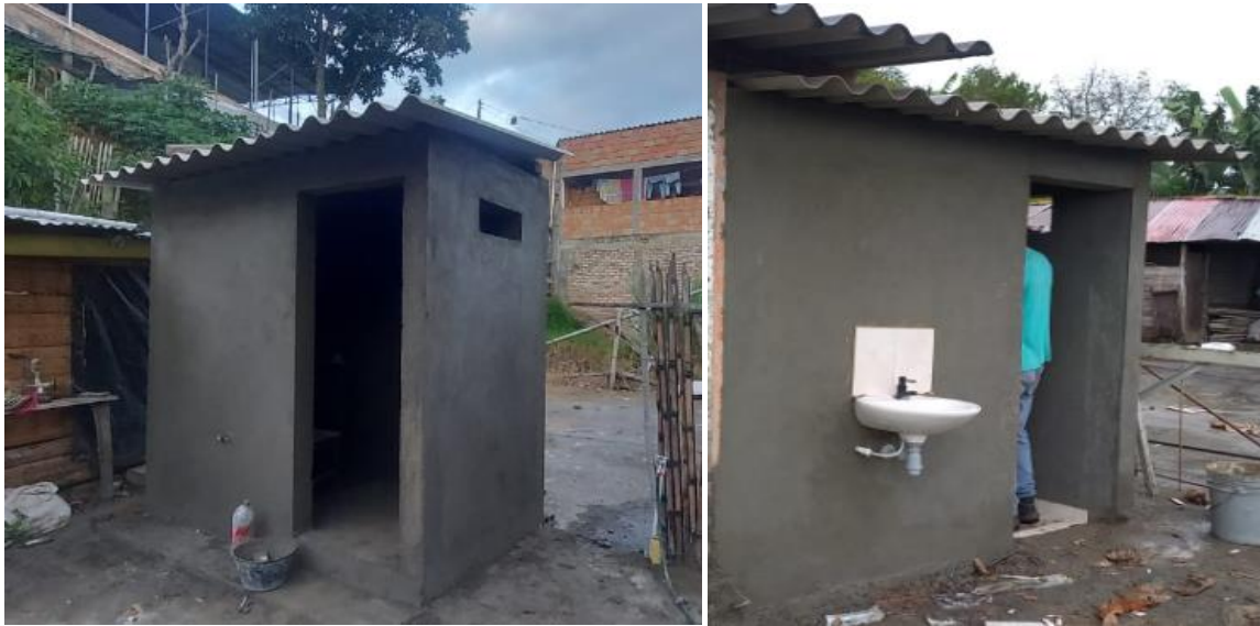
Ilustración 36. Proceso de pañetado e instalación de tejas en fibrocemento.
