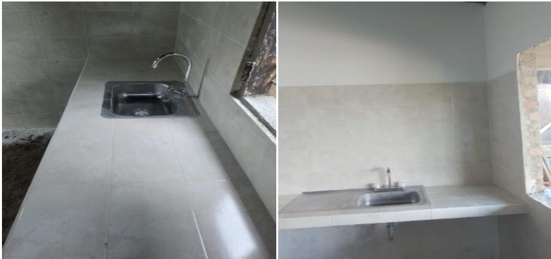
Ilustración 30. Instalación de enchape para muro y meson.
