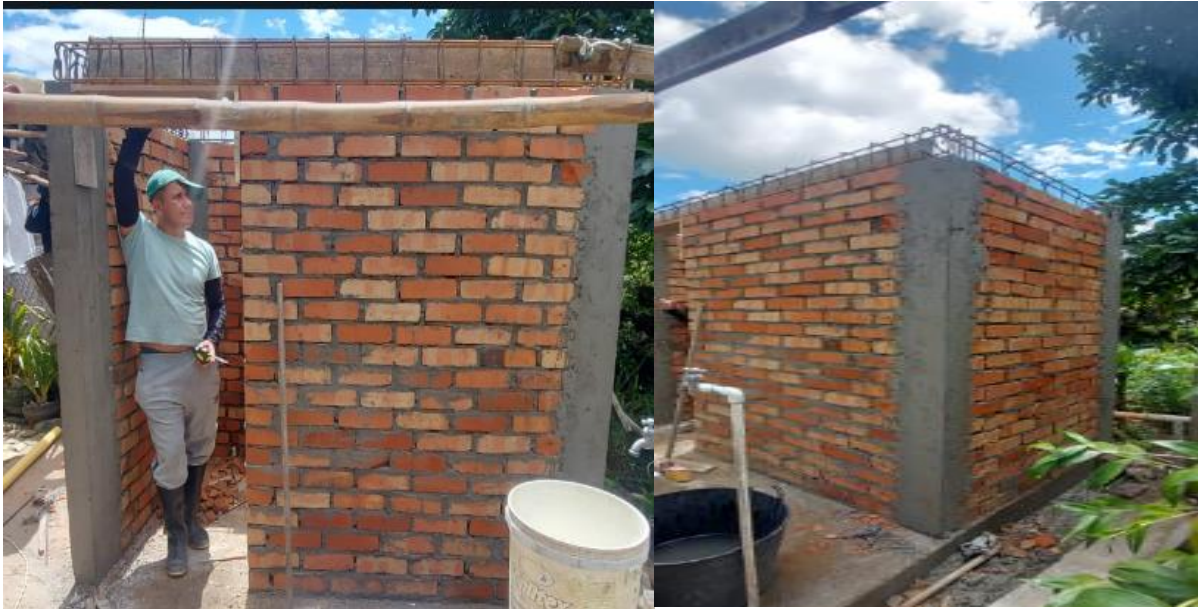
Ilustración 34. Construcción de muros en mampostería.
