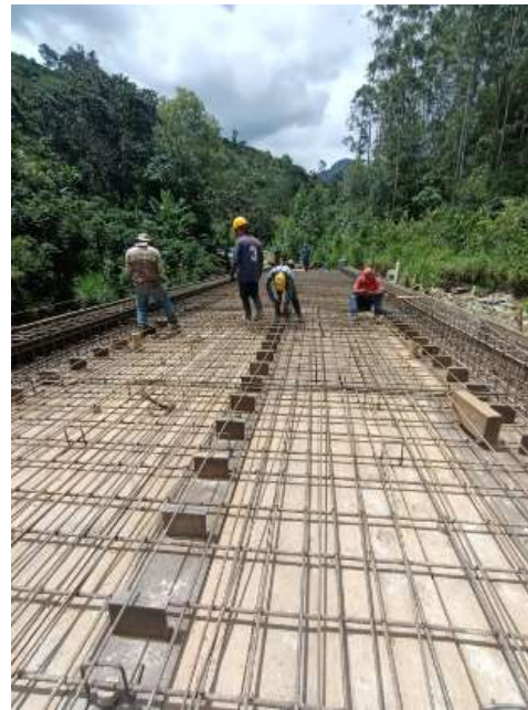
Ilustración 31 acero para tablero.
