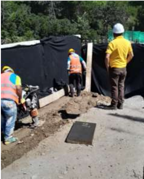
Ilustración 50 geodren y geotextil.
