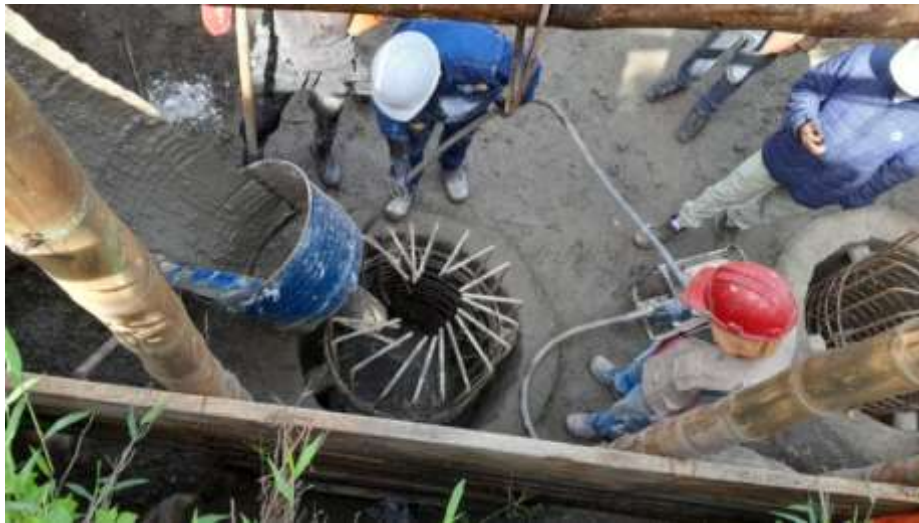
Ilustración 36 concreto para estribo.
