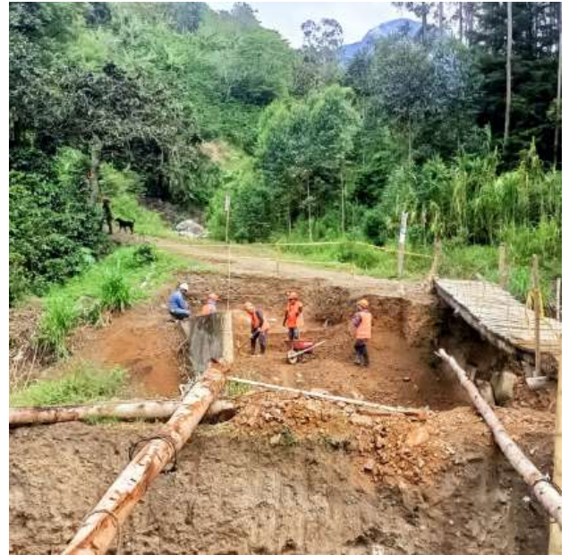
Ilustración 24 excavación para estribo derecho.
