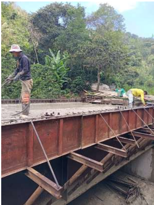
Ilustración 39 concreto para tablero.
