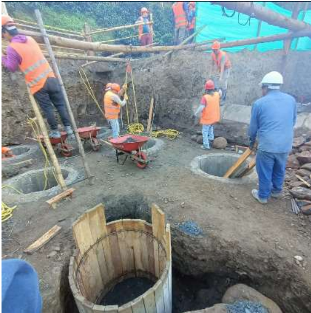
Ilustración 25 excavación de caisson lado izq.
