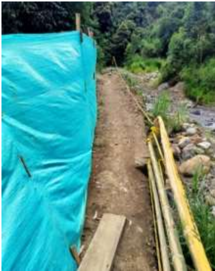
Ilustración 53 cerramiento y señalización.
