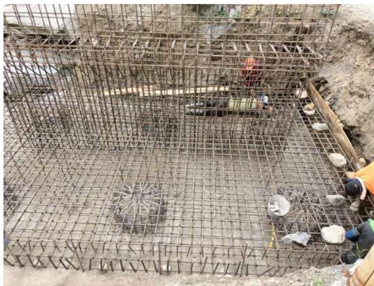
Ilustración 32 acero para estribo.
