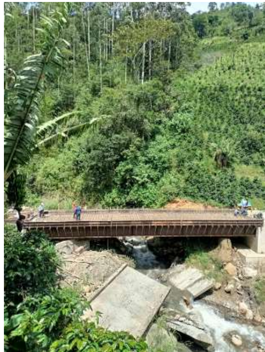
Ilustración 61 después de la obra.
