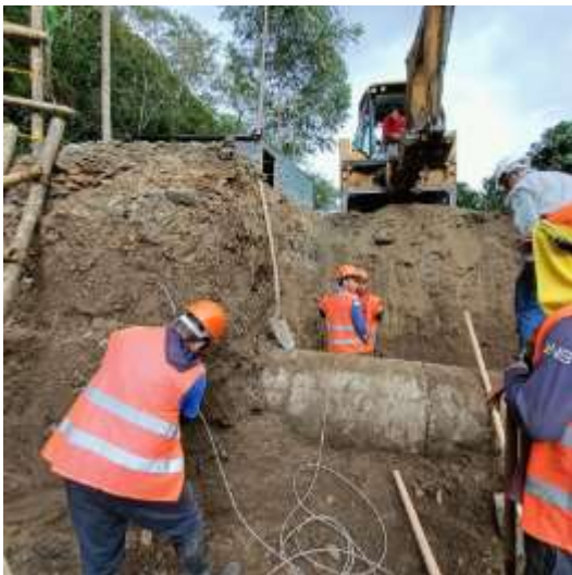
Ilustración 49 excavación de material común y rocas.
