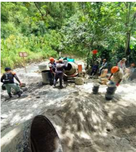
Ilustración 34 preparación de concreto.
