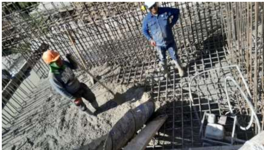
Ilustración 36 concreto para estribo.
