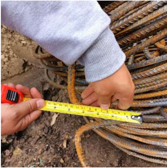
Ilustración 29 control de figurado de acero.
