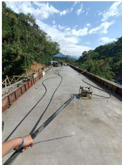
Ilustración 38 tablero fundido.
