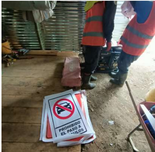
Ilustración 54 campamento de obra.
