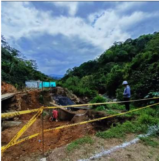
Ilustración 27 cintas y señalización.
