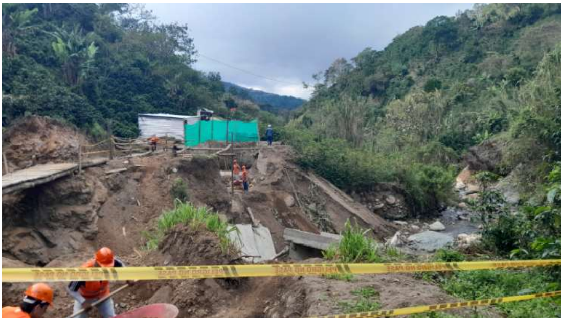
Ilustración 26 vista general de excavación.
