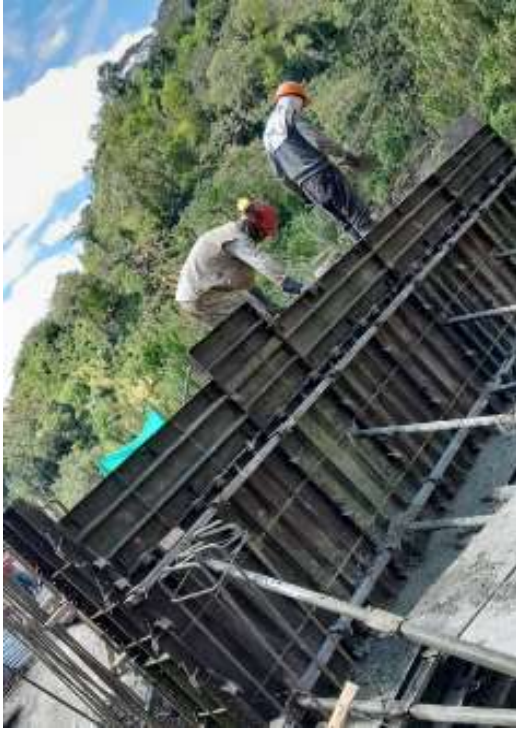
Ilustración 37 estribo fundido.
