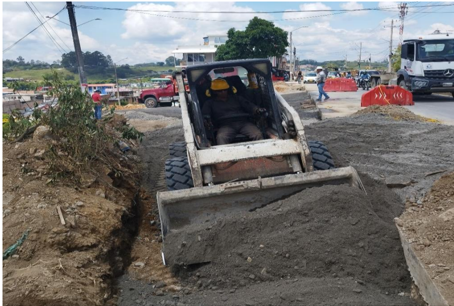
Ilustración 44 Extendido de material de subbase calle 5ªA
