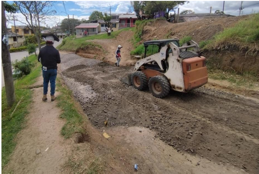
Ilustración 18 Céreo con Bobcat carrera 40B
