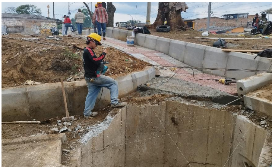
Ilustración 65 Demolición brocal de redes telefónicas carrera 40B
