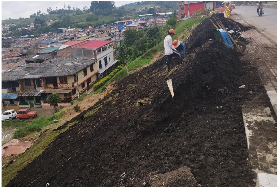
Ilustración 92 Colocación tierra negra relleno muro de contención 5ª Fuente: Occiviles S.A.
