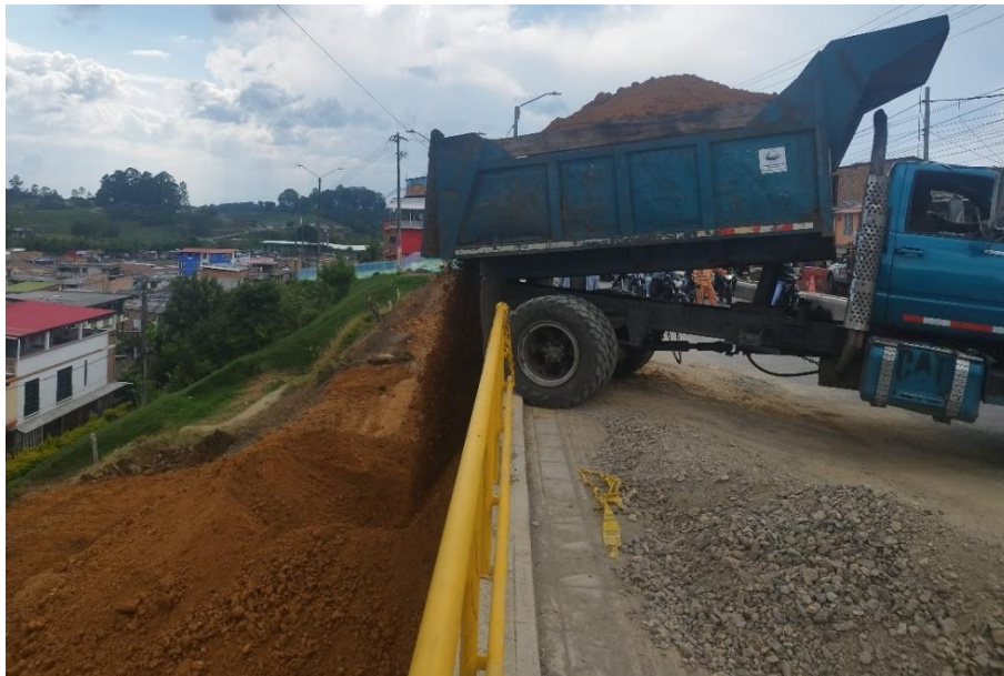
Ilustración 89 Descargue material para relleno muro de contención 5ª
