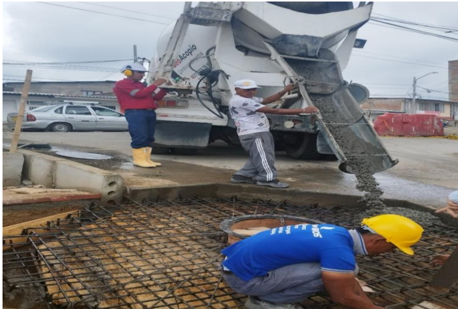
Ilustración 71 Fundición brocal carrera 40B
