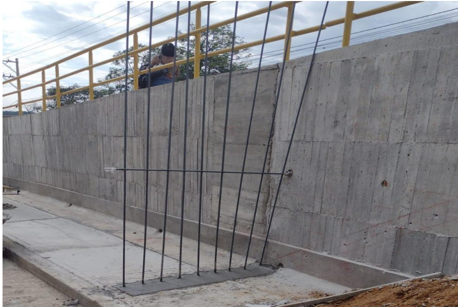
Ilustración 81 Cimentación fundida escaleras villas del palmar
