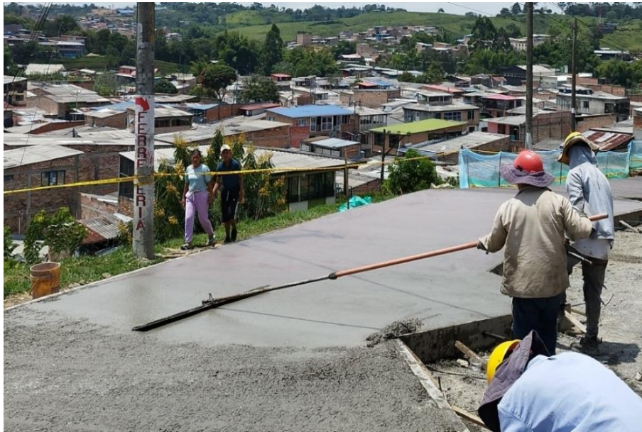
Ilustración 53 Flotado de concreto calle 5ªA
