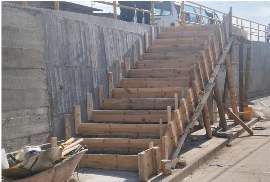
Ilustración 85 Encofrado escaleras villas del palmar
