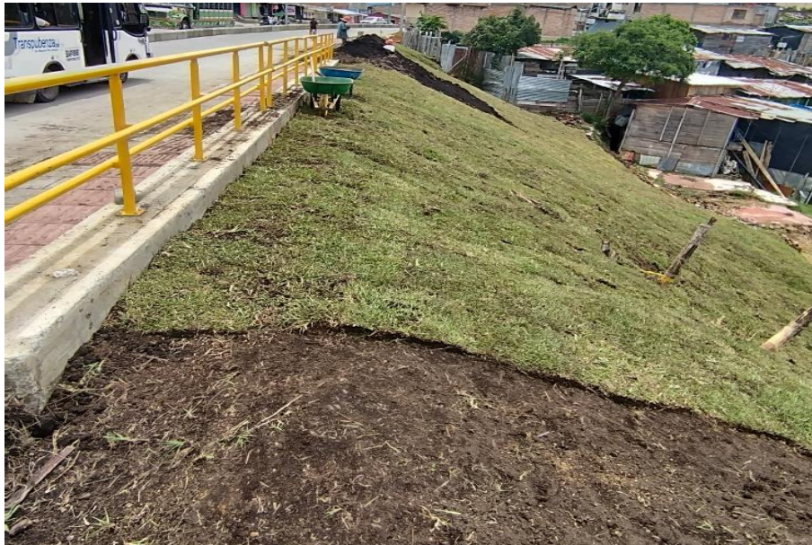
Ilustración 93 Instalación manto protector césped Fuente: Occiviles S.A.
