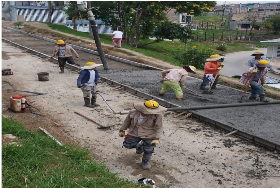
Ilustración 29 Proceso de vaciado de concreto carrea 40B
