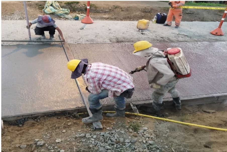
Ilustración 38 Rayado y aplicación de antisol carrera 40B
