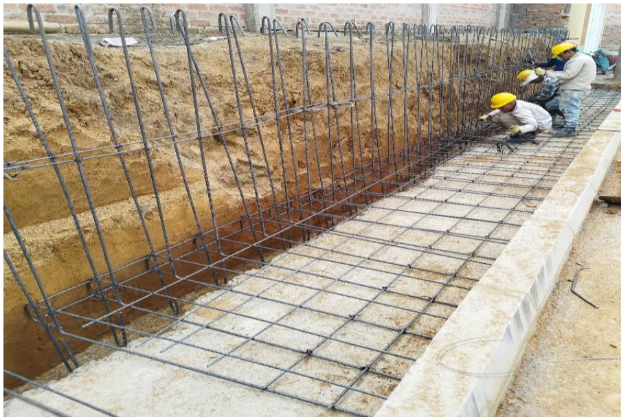
Ilustración 74 Acero de refuerzo muro contención velas el sol
