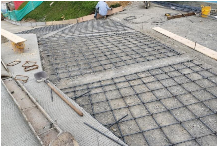
Ilustración 58 Parrillas de refuerzo carril derecho calle 5ªA
