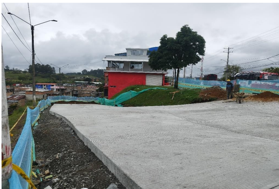
Ilustración 6 Boca calle 5ªA rehabilitada Fuente: Occiviles S.A.
