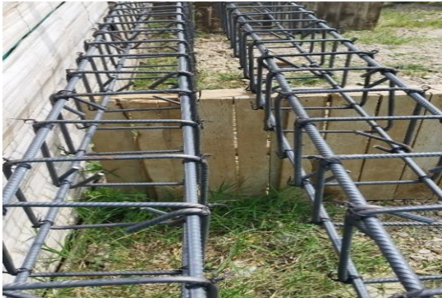
Ilustración 59 Acero de viga de empalme armado
