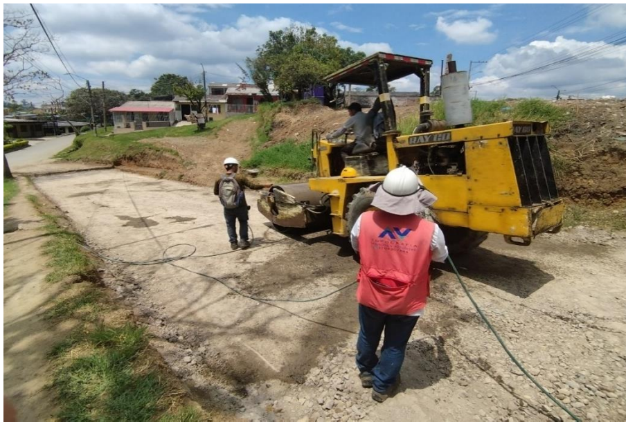
Ilustración 19 Compactación con vibro compactador carrera 40B
