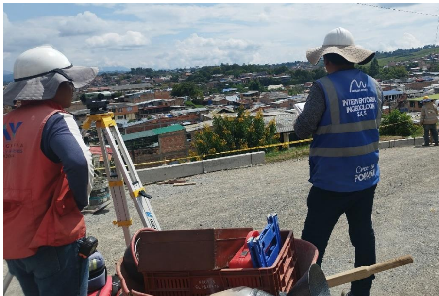
Ilustración 47 Revisión por el personal de interventoría calle 5ªA
