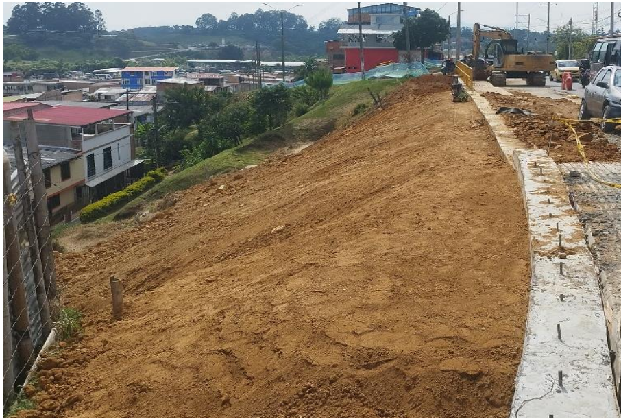
Ilustración 91 Terminado de relleno muro de contención 5ª
