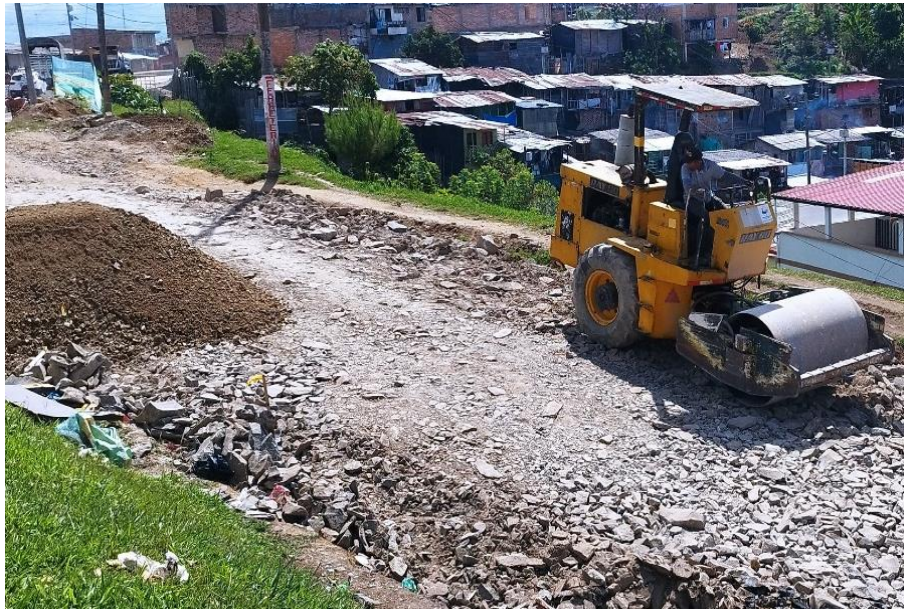
Ilustración 41 Compactación material de relleno calle 5ªA
