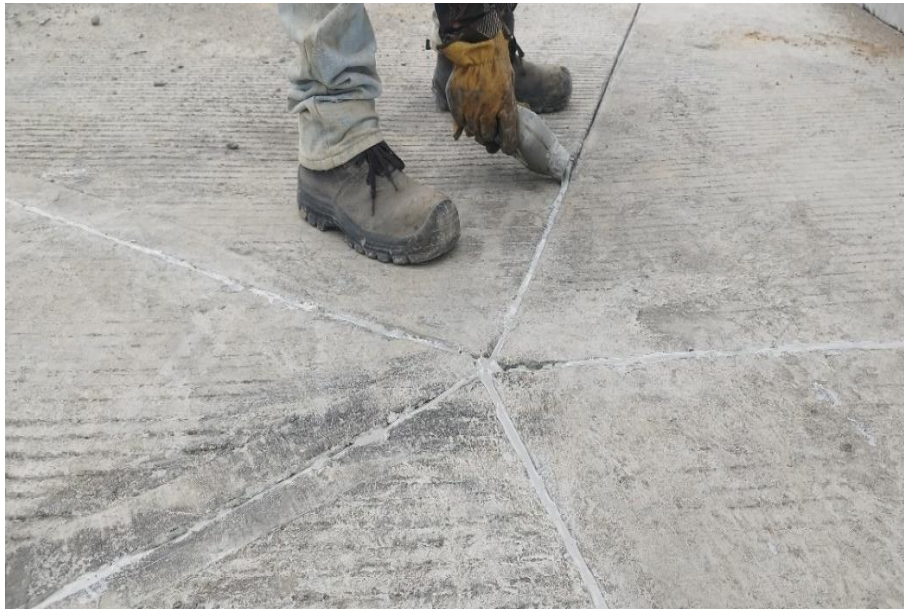
Ilustración 56 Sellado de juntas calle 5ªA
