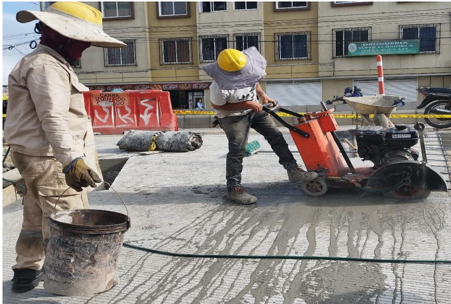
Ilustración 33 Corte de juntas carrera 40B
