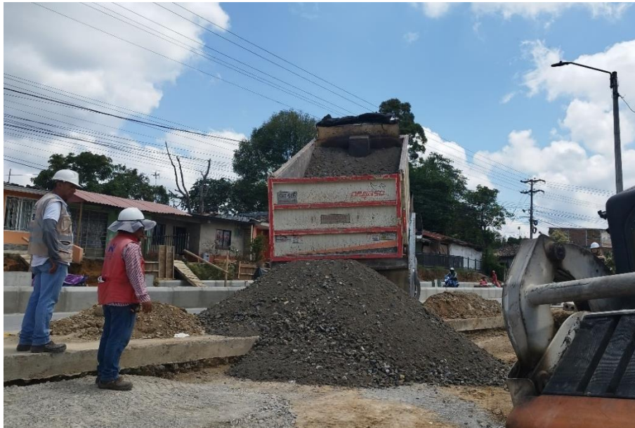
Ilustración 43 Descargue material de subbase calle 5ªA
