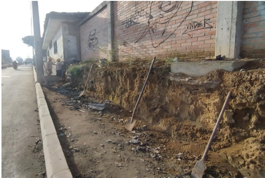
Ilustración 7 Espacio para la construcción de muro un de contención
