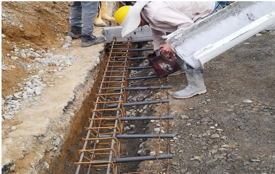
Ilustración 51 Viga de empale previa a su fundición calle 5ªA
