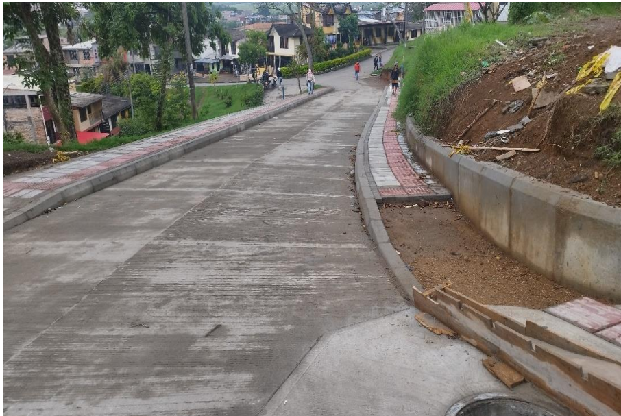
Ilustración 4 Boca calle carrera 40B rehabilitada
