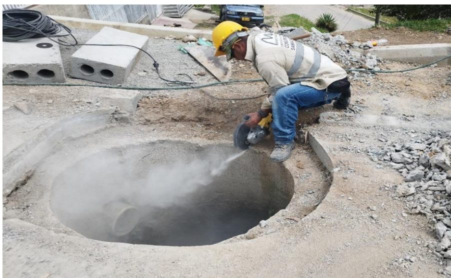
Ilustración 66 Demolición brocal alcantarillado carrera 40B
