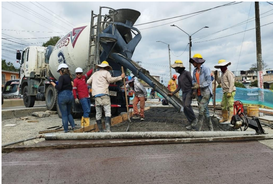
Ilustración 61 Vaciado de mezcla y nivelación con rodillo vibratorio calle 5ªA
