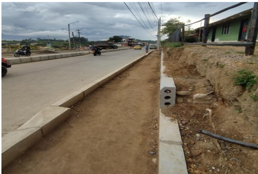
Ilustración 12 Recorrido de obra inicial
