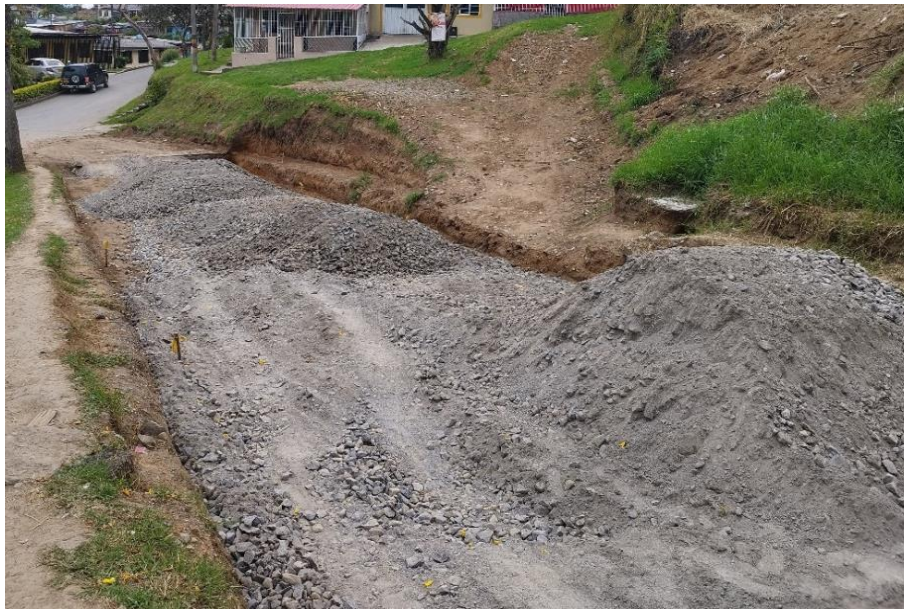
Ilustración 17 Material de subbase acopiado carrera 40B
