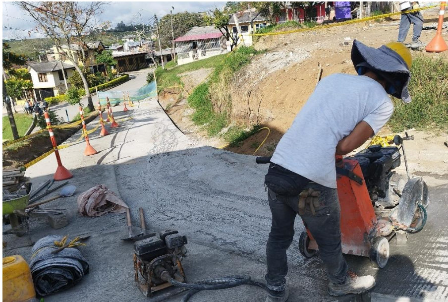
Ilustración 39 Corte juntas carrera 40B
