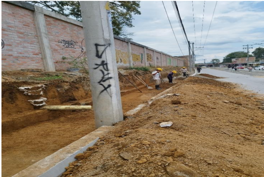
Ilustración 72 Excavación para solado muro contención velas el sol
