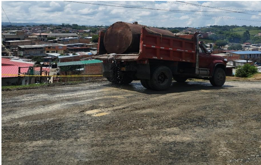
Ilustración 45 Carro tanque de humectación en material de subbase calle 5ªA
