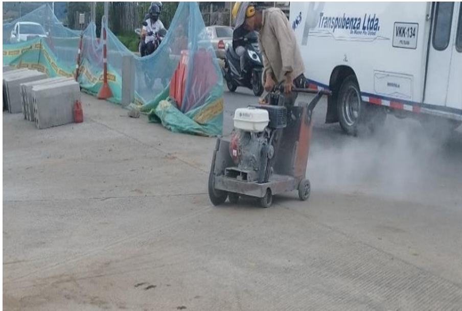
Ilustración 63 Corte de juntas calle 5ªA
