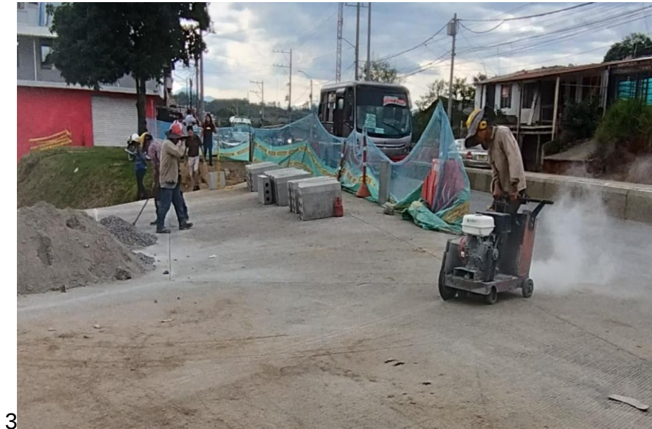
Ilustración 55 Corte de juntas calle 5ªA
