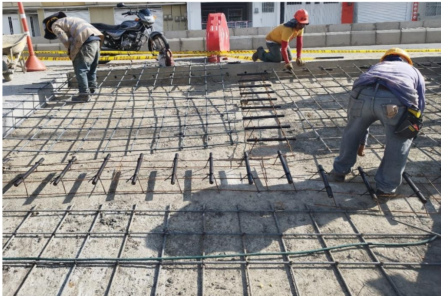
Ilustración 23 Adecuación parrillas de refuerzo carrera 40B
