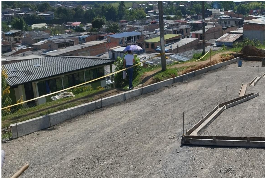
Ilustración 49 Formaleta instalada calle 5ªA
