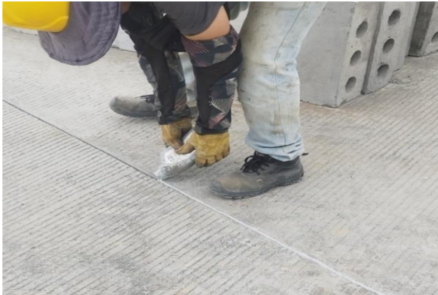
Ilustración 64 Sellado de juntas calle 5ªA
