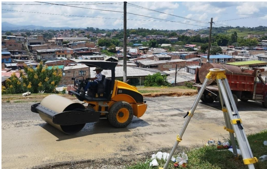
Ilustración 46 Compactación material de subbase calle 5ªA
