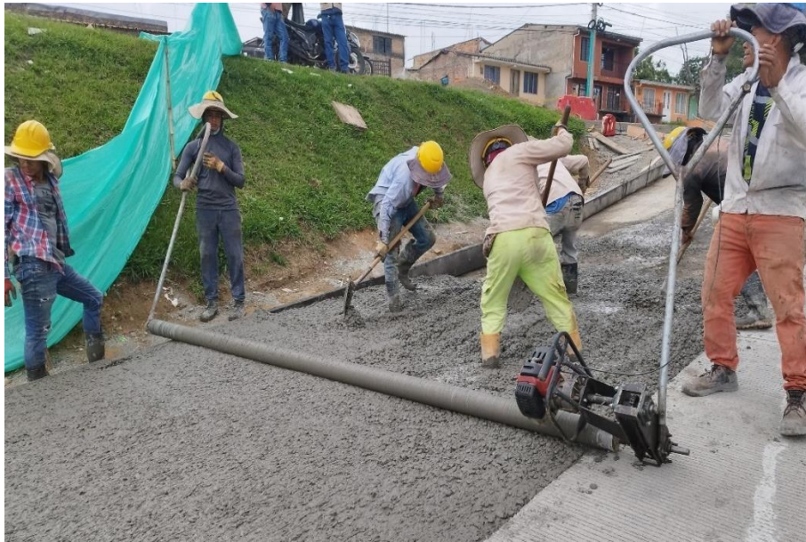
Ilustración 60 Nivelación con rodillo concreto fresco calle 5ªA
