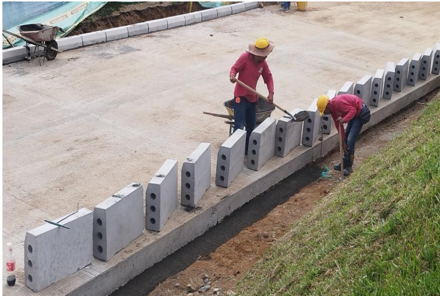
Ilustración 94 Conformación de bordillos
