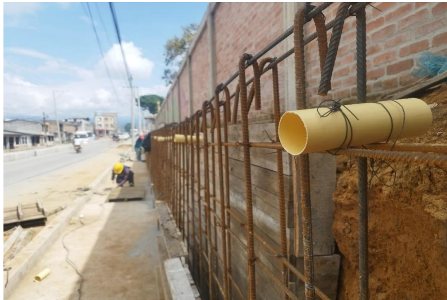
Ilustración 78 Lagrimales en encofrado muro contención velas el sol Fuente: Occiviles S.A.
