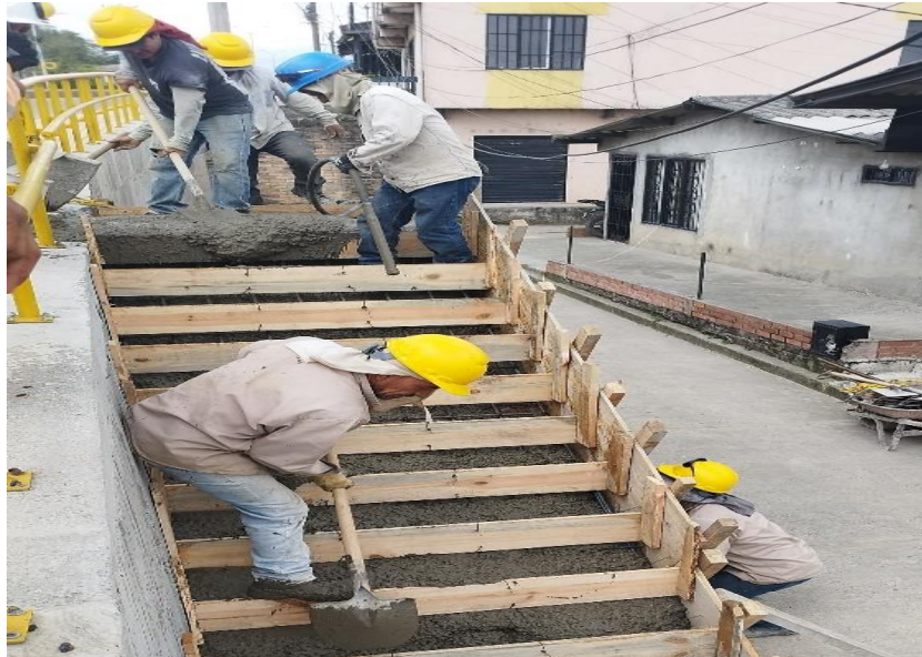
Ilustración 86 Vaciado concreto escaleras villas del palmar
