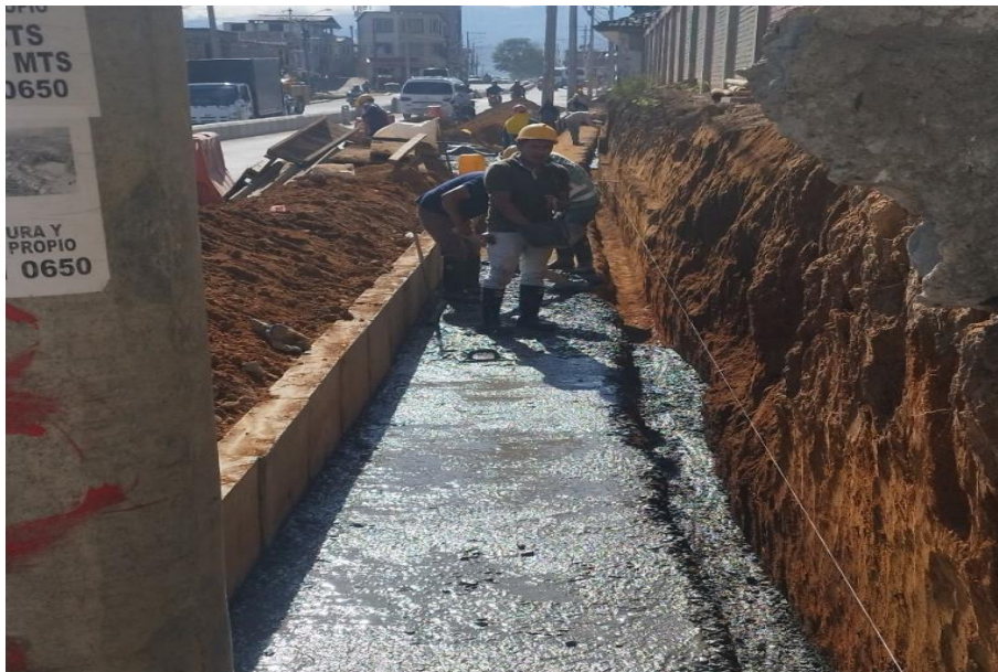
Ilustración 73 Vaciado solado de protección muro contención velas el sol
