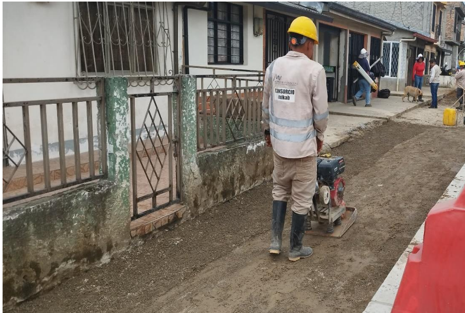
Ilustración 95 Compactación soporte losetas para andén>
