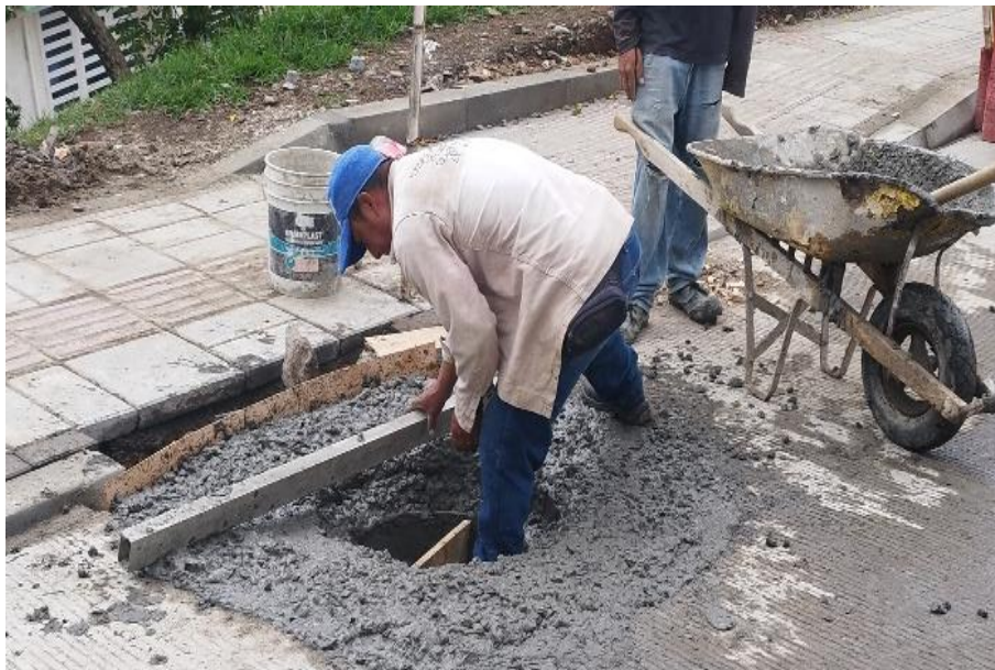
Ilustración 70 Fundición brocal carrera 40B
