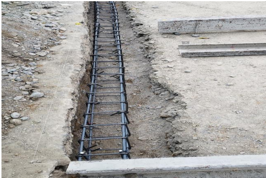
Ilustración 25 Acero viga de empalme carrera 40B
