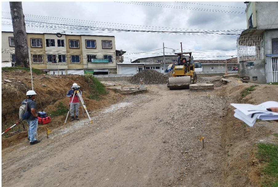
Ilustración 16 Subrasante compactada carrera 40B
