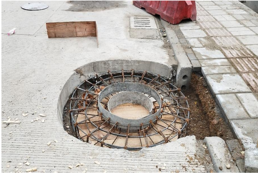
Ilustración 67 Acero de refuerzo brocal alcantarillado carrera 40B
