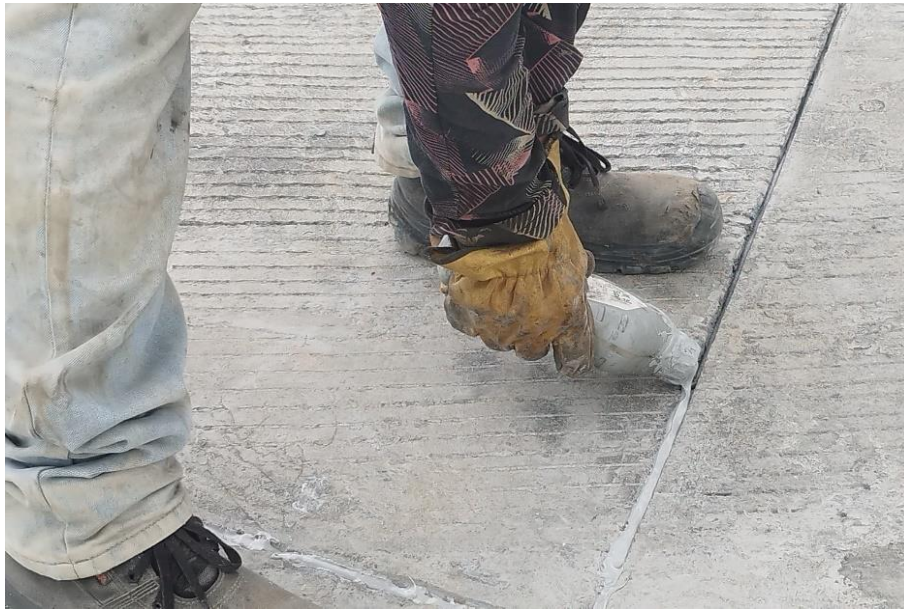
Ilustración 36 Aplicación sello de juntas
