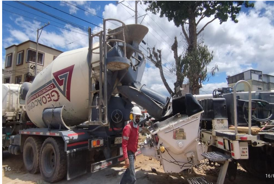
Ilustración 28 Vaciado mixer sobre tolva
