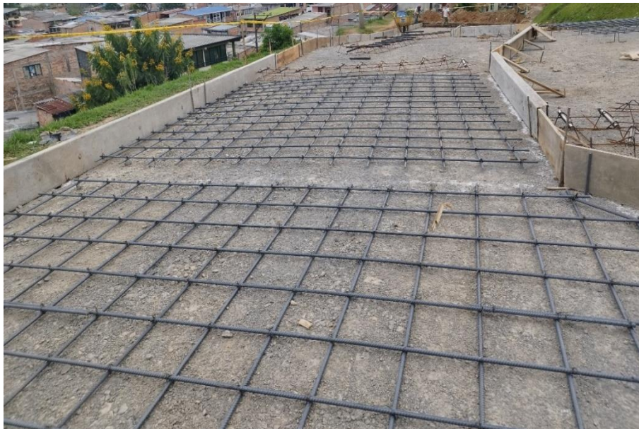
Ilustración 50 Parrillas de refuerzo calle 5ªA
