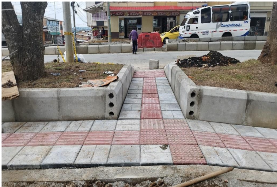
Ilustración 10 Andenes contruidos para la movilidad de peatones Fuente: Occiviles S.A.
