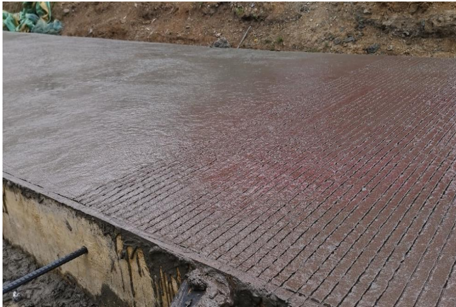
Ilustración 31 Concreto texturizado transversalmente carrea 40B
