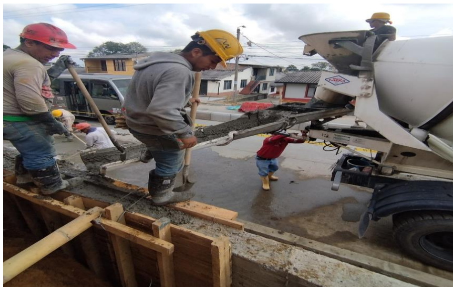
Ilustración 80 Vaciado muro contención velas el sol
