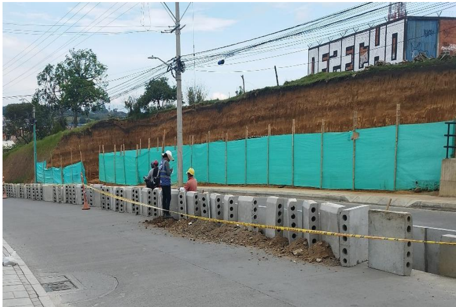
Ilustración 98 Instalación Jersey separador de carril calle 5ª
