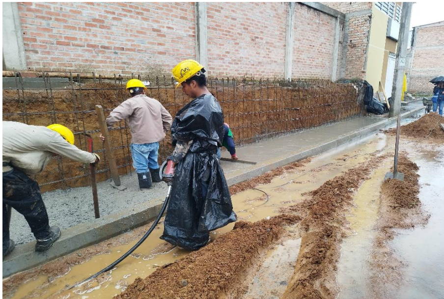
Ilustración 75 Vaciado zarpa muro contención velas el sol
