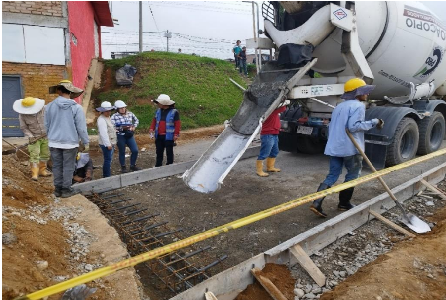
Ilustración 52 Fase inicial para fundición carril izquierdo calle 5ªA
