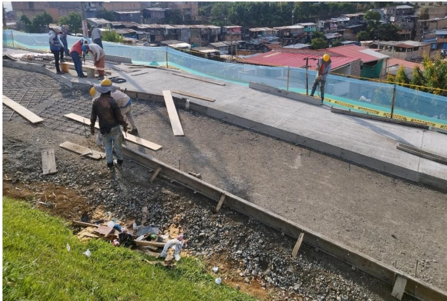
Ilustración 57 Formaleta carril derecho calle 5ªA
