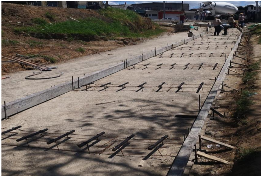
Ilustración 24 Canastillas en posición de las juntas transversales carrera 40B
