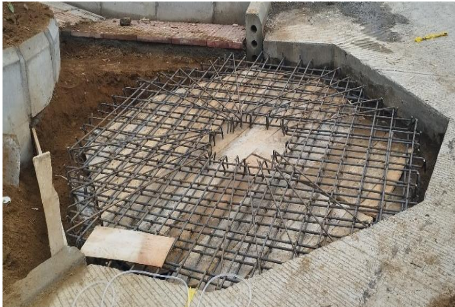
Ilustración 68 Acero de refuerzo brocal carrera 40B
