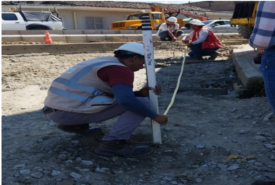
Ilustración 21 Revisión de niveles carrera 40B
