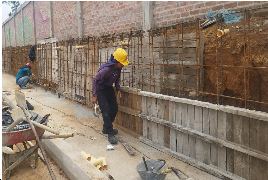
Ilustración 77 Encofrado muro contención velas el sol Fuente: Occiviles S.A.
