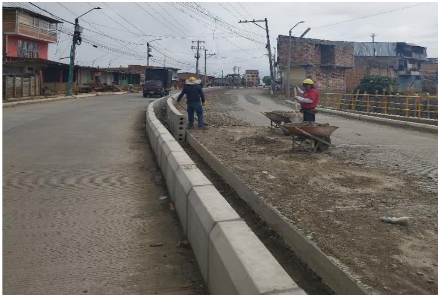
Ilustración 11 Recorrido de obra inicial
