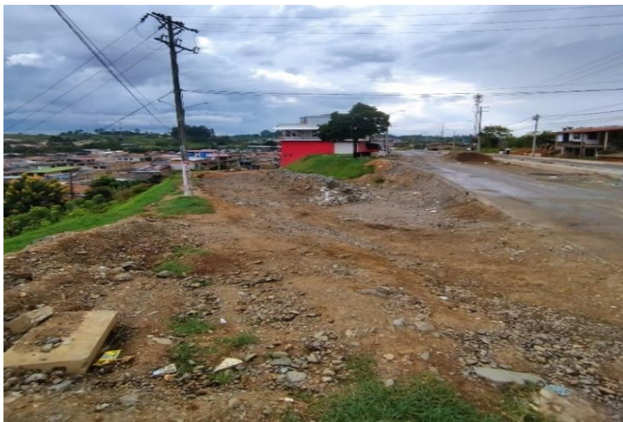
Ilustración 13 Recorrido de obra inicial
