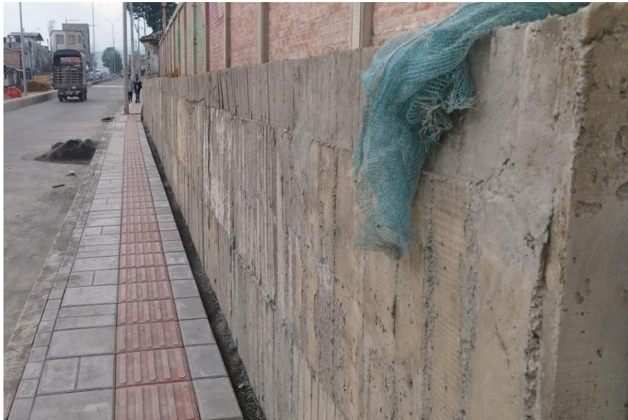
Ilustración 8 Muro de contención construido
