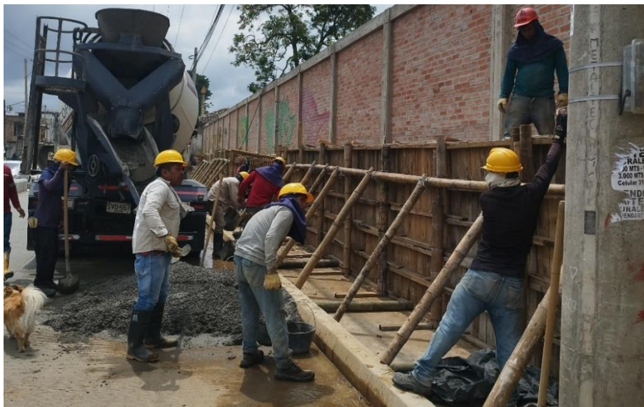
Ilustración 79 Vaciado muro contención velas el sol
