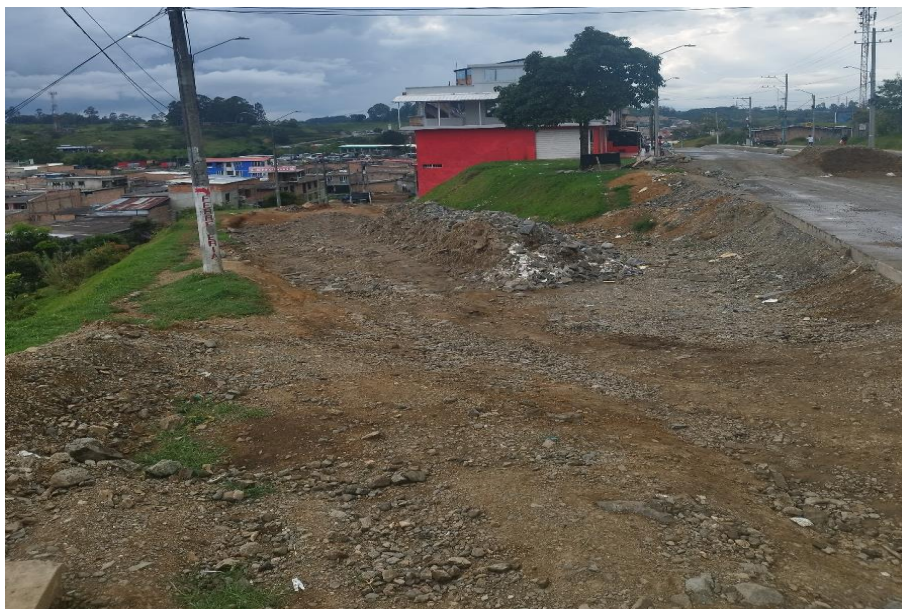
Ilustración 5 Estado inicial boca calle 5ªA Fuente: Occiviles S.A.
