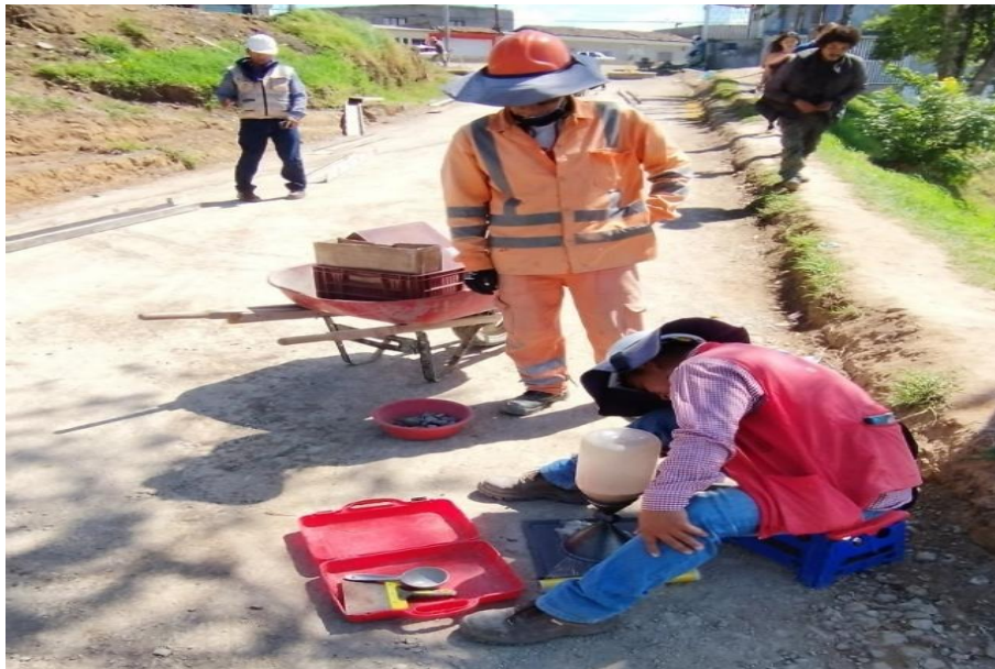
Ilustración 20 Toma de densidad en campo material de subbase carrera 40B
