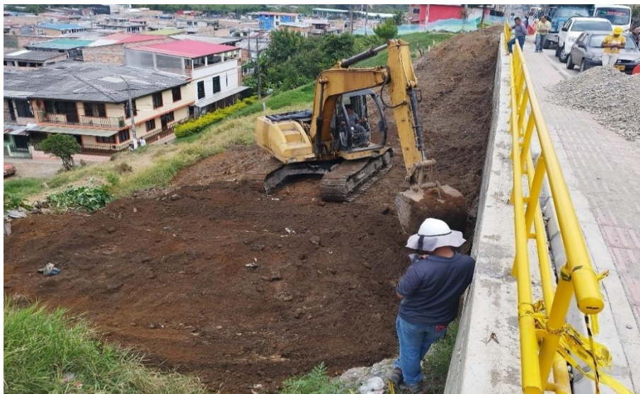
Ilustración 88 Descapote relleno muro de contención 5
