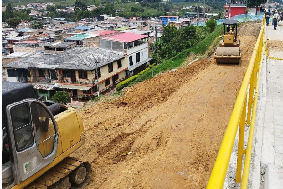
Ilustración 90 Compactación relleno muro de contención 5ª
