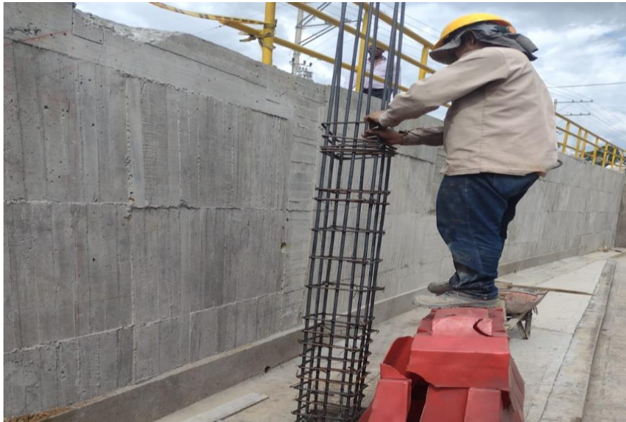
Ilustración 82 Acero de refuerzo columna escaleras villas del palmar
