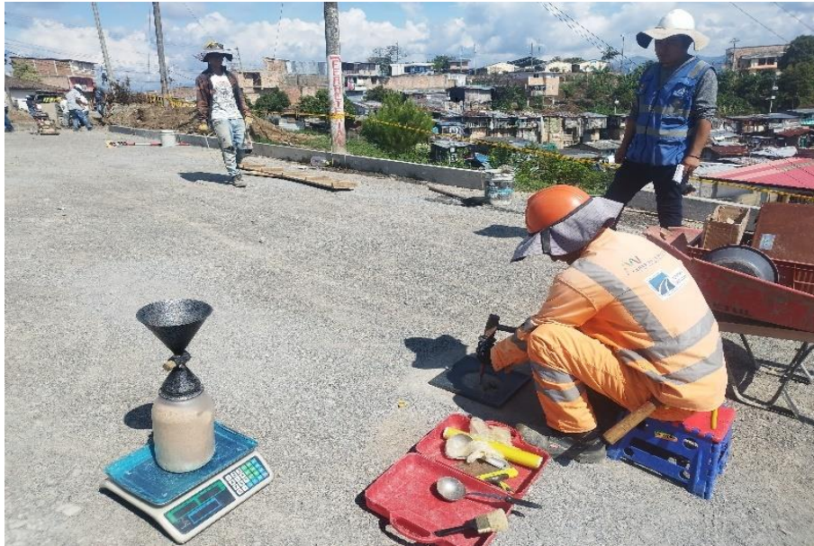
Ilustración 48 Ensayo de densidad en campo calle 5ªA
