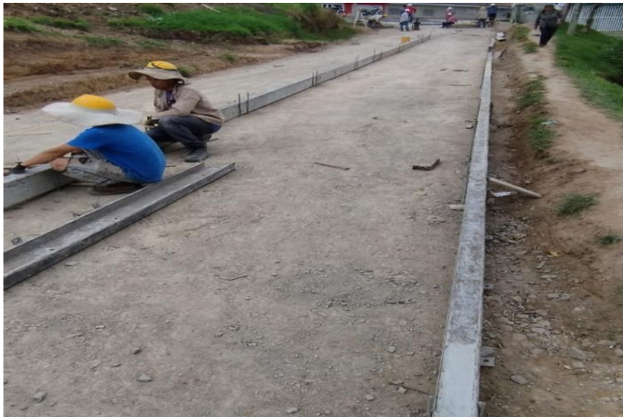
Ilustración 22 Instalación de formaleta carrera 40B carril izquierdo
