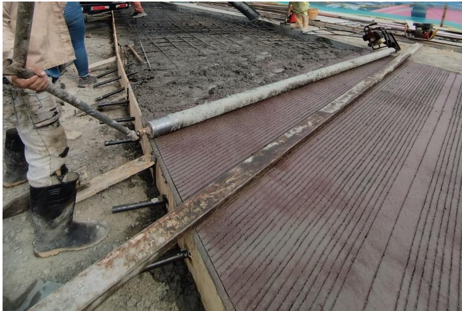
Ilustración 62 Acabado de líneas transversales (rayado) concreto calle 5ªA
