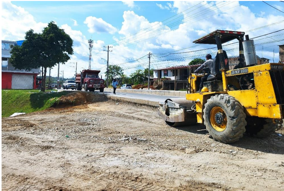
Ilustración 42 Soporte de subbase compactado calle 5ªA
