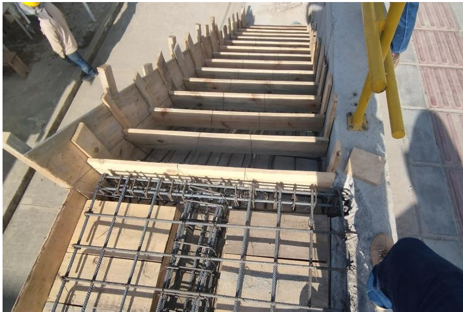
Ilustración 84 Acero de refuerzo y encofrado escaleras villas del palmar
