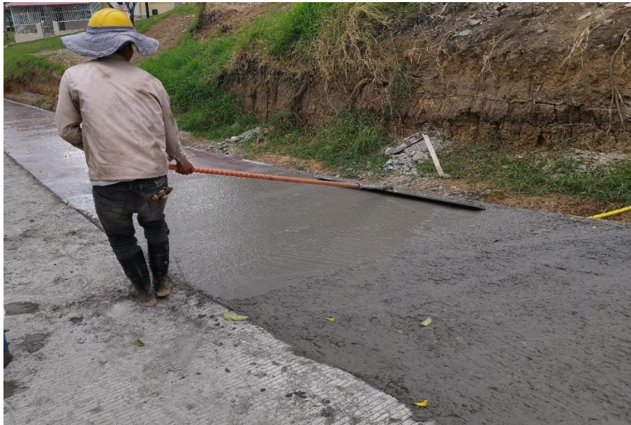
Ilustración 37 Flotado concreto carrera 40B
