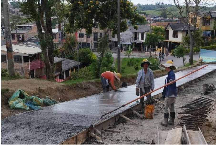
Ilustración 30 Flotado del concreto carrea 40B
