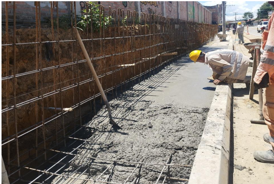
Ilustración 76 Vaciado zarpa muro contención velas el sol
