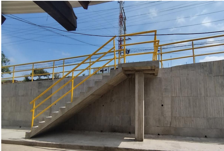
Ilustración 9 Escaleras en uso para acceso a la calle 5ª Fuente: Occiviles S.A.
