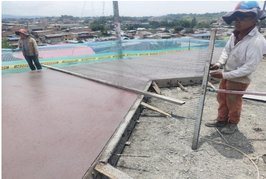
Ilustración 54 Rayado de concreto fresco con rastrillo calle 5ªA Fuente: Occiviles S.A.
