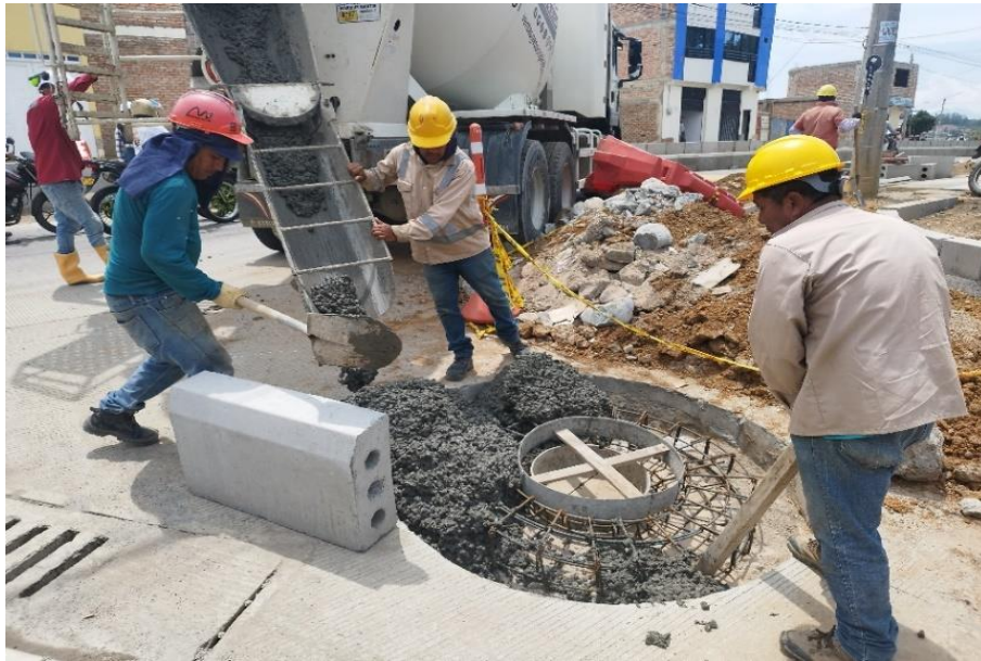
Ilustración 69 Fundición brocal calle 5ª
