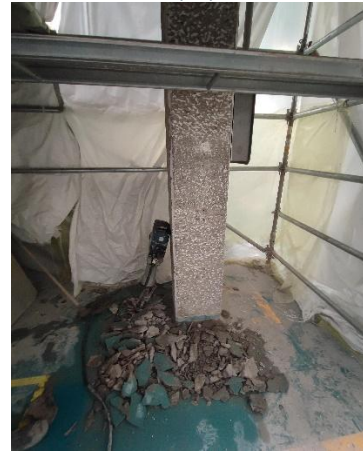
Imagen 13. Demolición de piso de columna con taladro rompe pavimento
