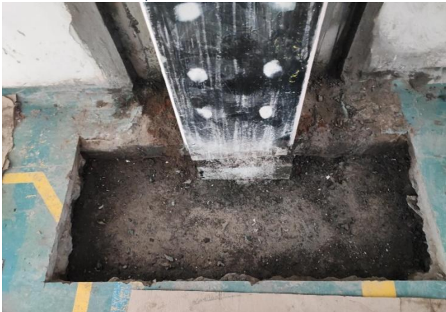
Imagen 30. Relleno de la excavación de columna de fachada posterior al encamisado
