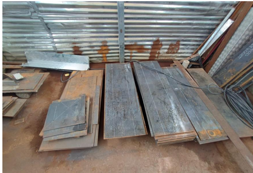
Imagen 15. Láminas de acero en la herrería de la obra
