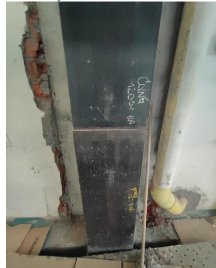
Imagen 31. Reforzamiento de columna de fachada vista interior
