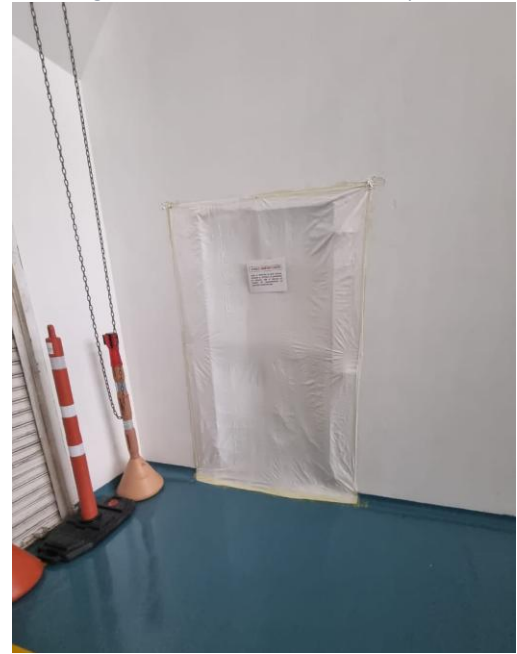
Imagen 6. Puerta de acceso desde la planta
