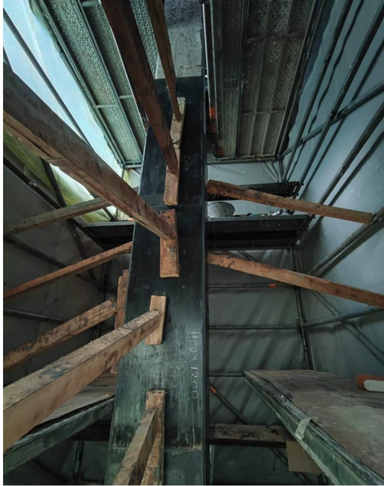
Imagen 19. Láminas de acero instaladas en la parcialidad de la columna
