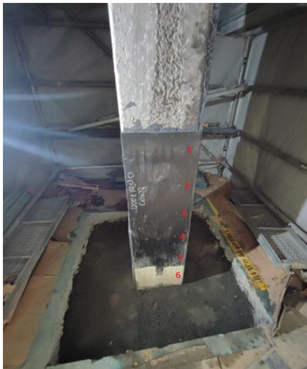
Imagen 18. Lamina de acero instalada con agujeros de clavos de fijación
