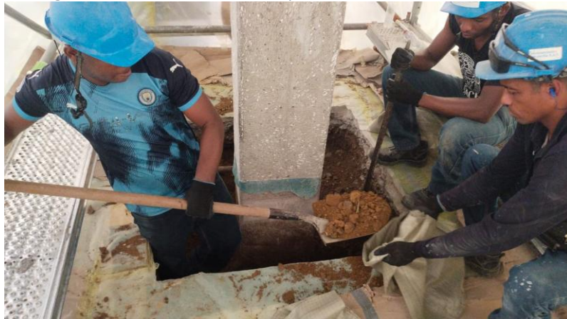
Imagen 14. Excavación de escombros y material hasta nivel de cimentación
