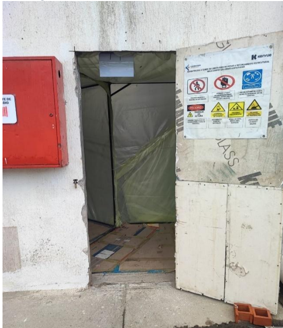
Imagen 5. Puerta de acceso al túnel desde fachada
