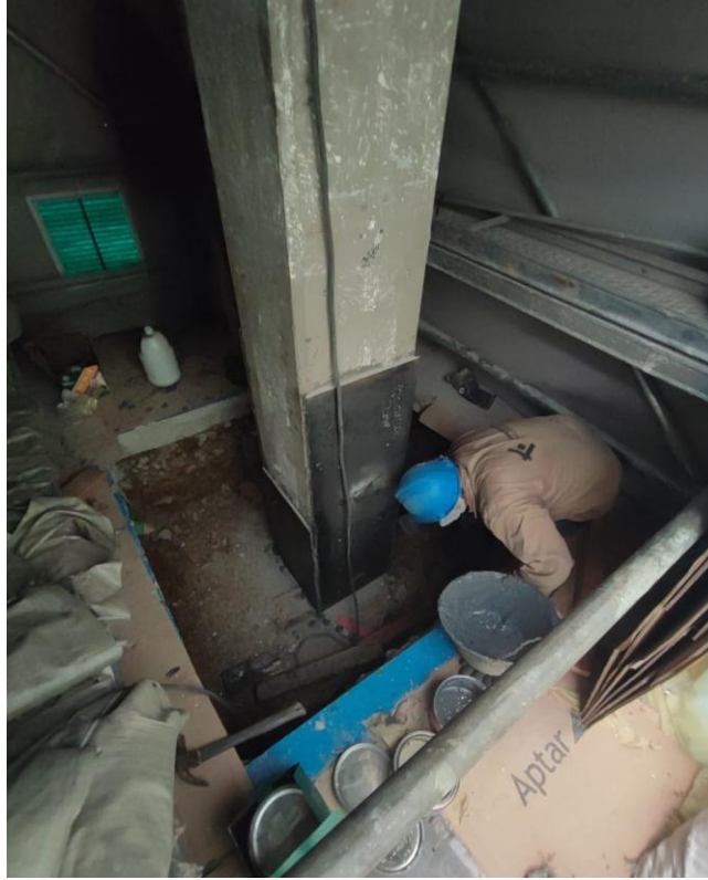
Imagen 16. Instalación de láminas y preparación del adhesivo
