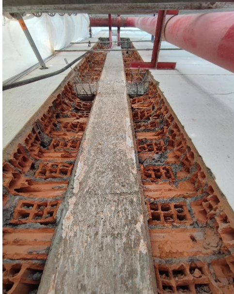
Imagen 25. Corte de muros adosados a las columnas de fachada
