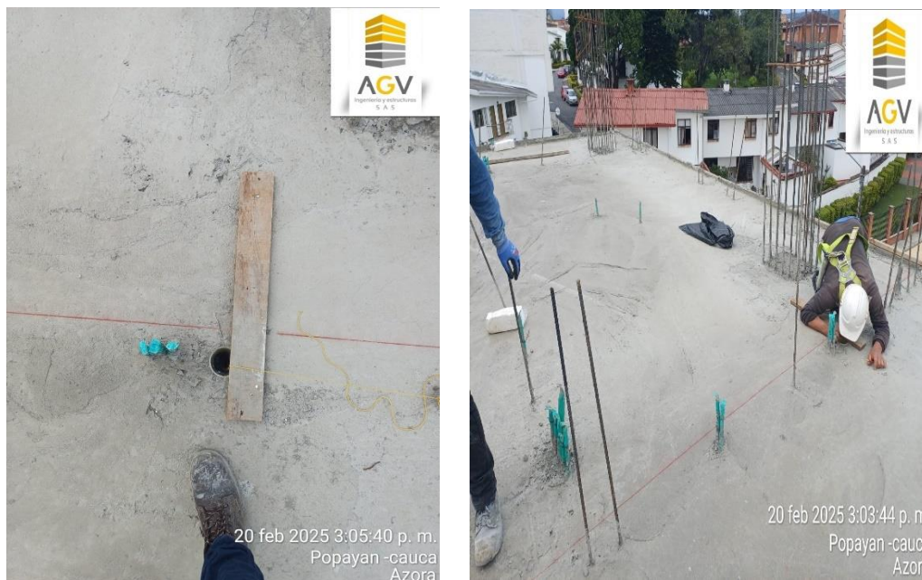
Imagen 7 y 8. Verificación de simbra, Edificio AZORA
