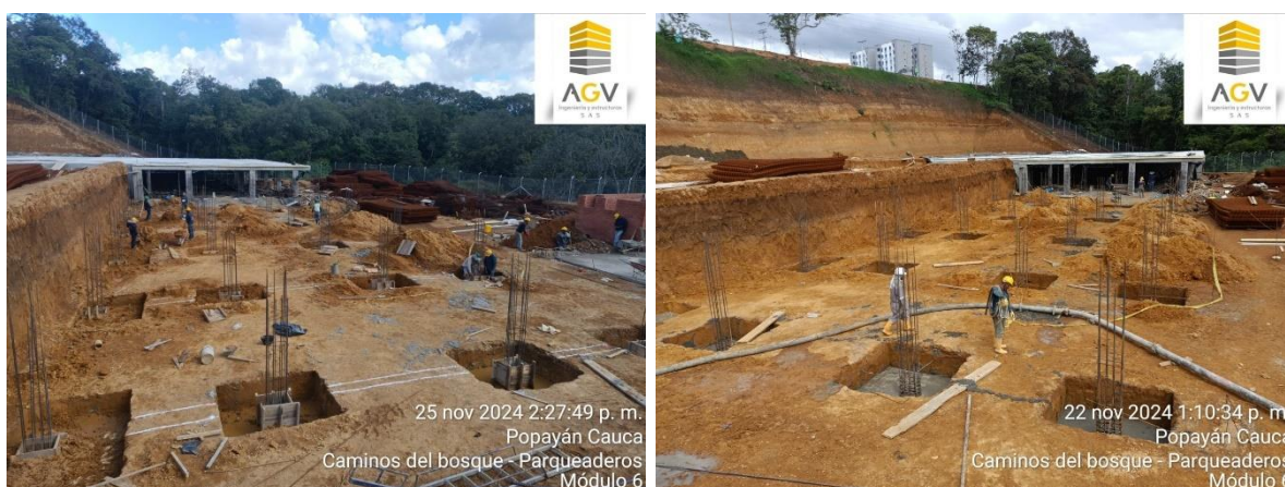
Imagen 46,47. Acero de refuerzo en zapatas, pedestales de cimientos del módulo 6, Caminos del Bosque
