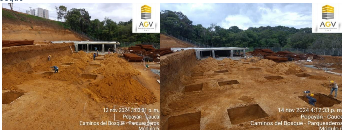
Imagen 44,45. Verificación de la excavación cimientos del módulo 6, Caminos del Bosque
