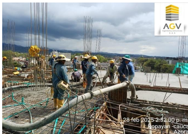
Imagen 31, 32. Fundición de losa, piso 4, Edificio AZORA
