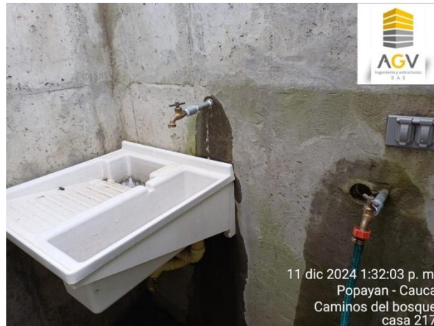
Figura 67. inspección y entrega de las instalaciones hidráulicas casa 217
