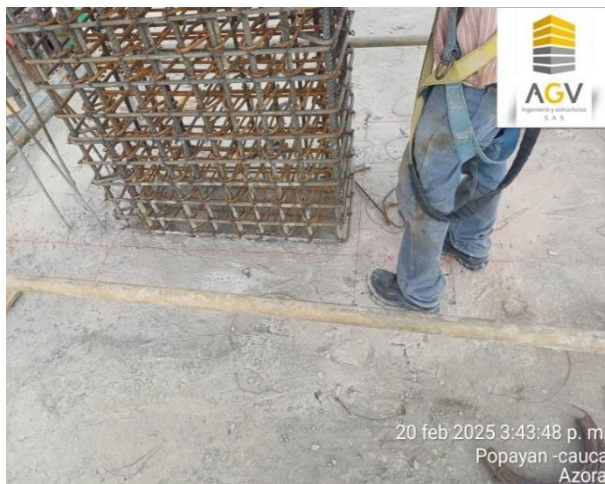
Imagen 10 y 11. Revisión de aceros, Edificio AZORA
