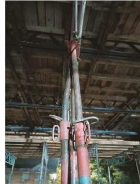
Imagen 27, 28. Apuntalamientos de losa, piso 4, Edificio AZORA
