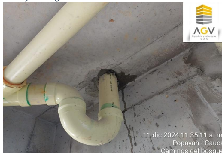
Figura 68. inspección y entrega de las instalaciones hidráulicas casa 212
