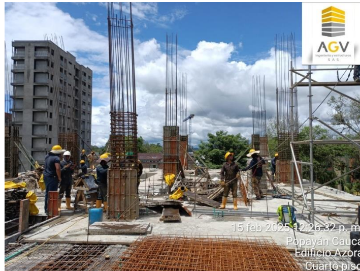
Imagen 9. Verificación de formaleta, Edificio AZORA
