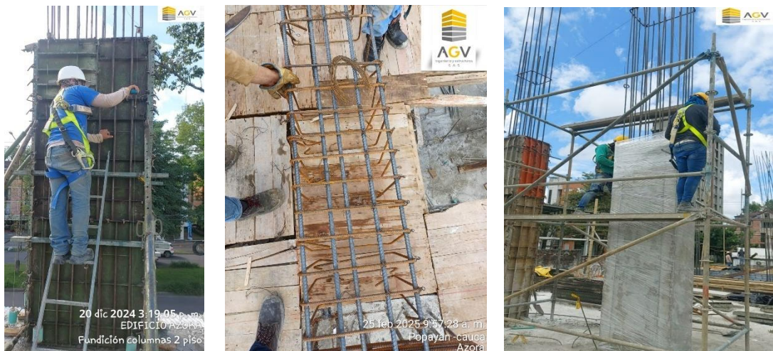
Imagen 18, 19, 20. Control de plomos y refuerzos, Edificio AZORA
