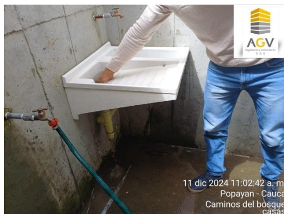
Figura 64. inspección y entrega de las instalaciones hidráulicas casa 292
