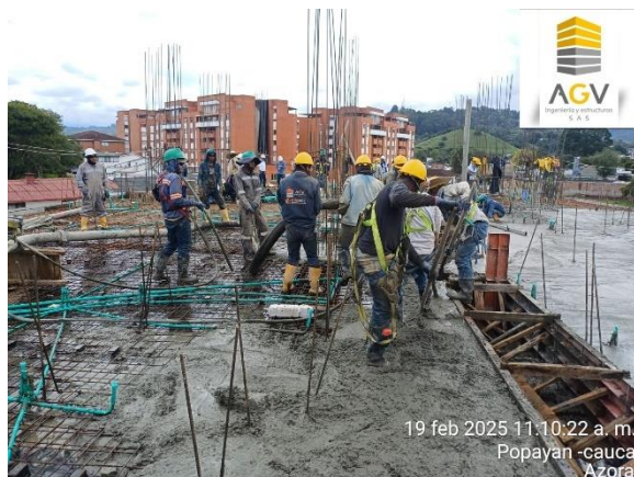
Imagen 31, 32. Fundición de losa, piso 4, Edificio AZORA
