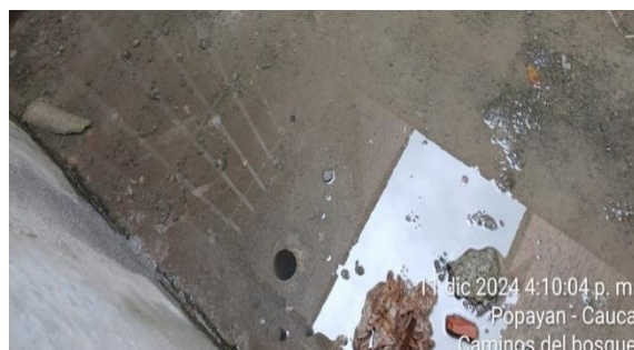
Figura 71. inspección y entrega de las instalaciones hidráulicas casa 289
