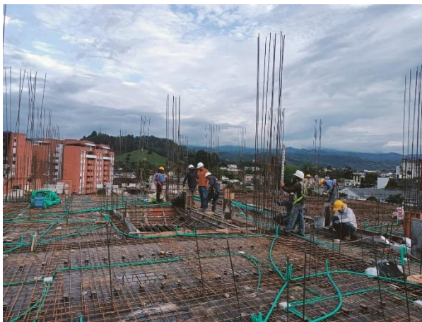
Imagen 29, 30. Instalación de tuberías eléctricas y drenajes, piso 4, Edificio AZORA
