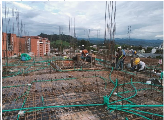
Imagen 29, 30. Instalación de tuberías eléctricas y drenajes, piso 4, Edificio AZORA
