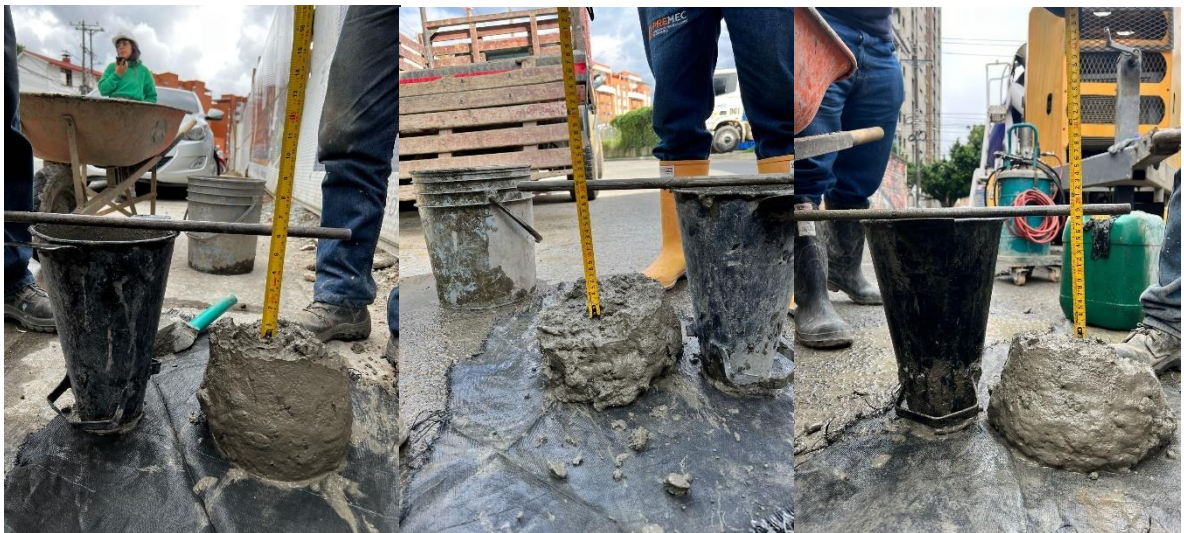
Figura 73. Toma de Asentamientos de Concreto, Edificio Azora
