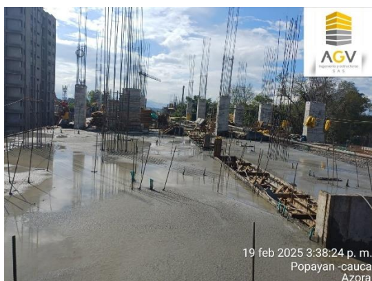
Imagen 33, 34, 35. Fraguado de losa, piso 4, Edificio AZORA
