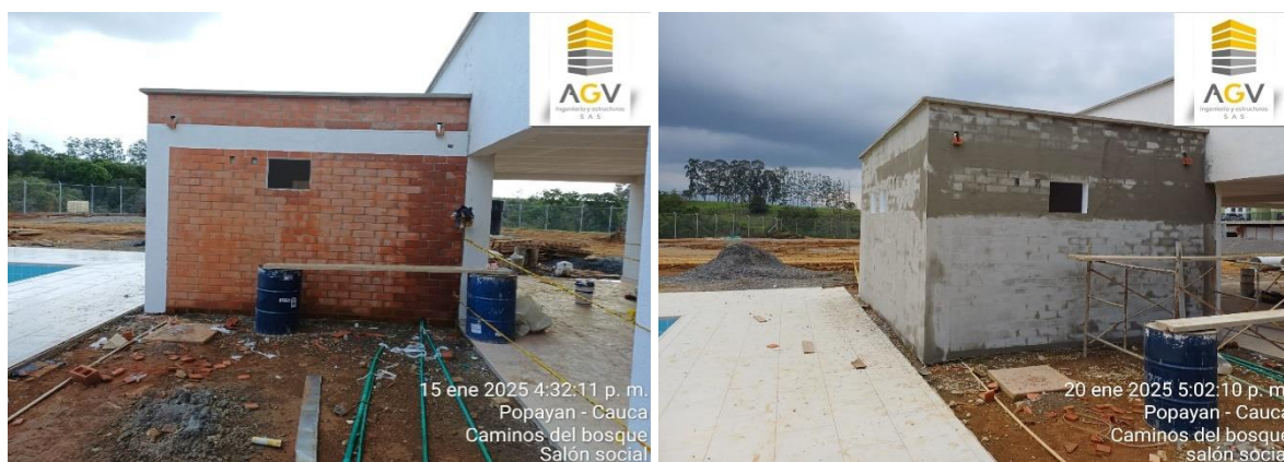
Imagen 48,49. Nivelación y rellenos salón social, Caminos del Bosque
