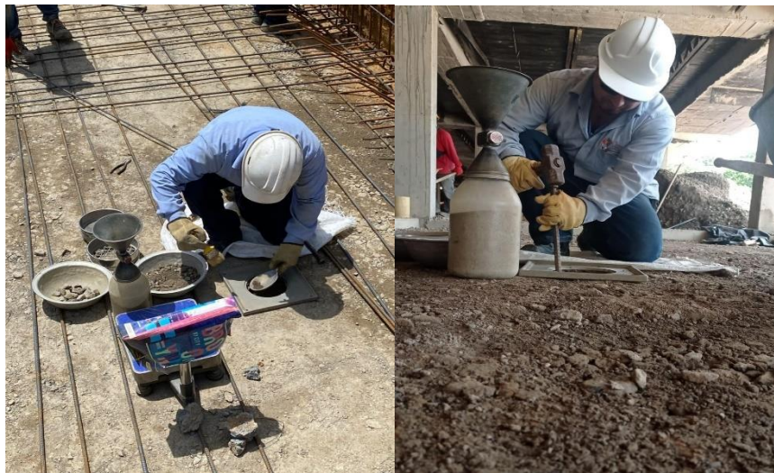
Figura 72. Toma de Densidades de Subbase de Pavimentos, Caminos del Bosque
