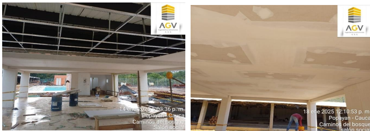
Imagen 56,57. Acabados finales y cielo raso, Caminos del Bosque
