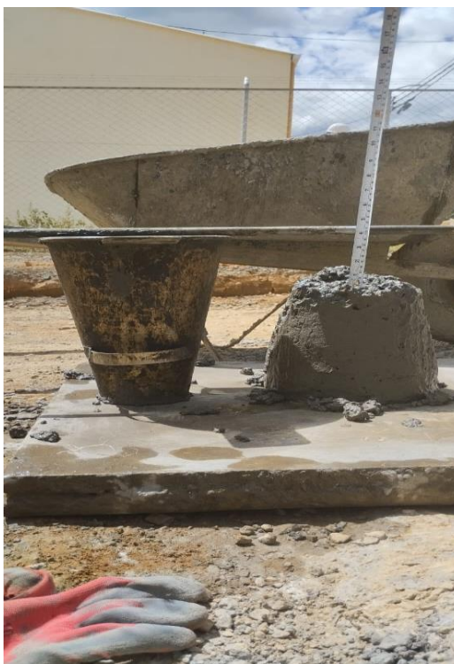
Figura 74. Toma de Asentamientos de Concreto, Caminos del Bosque
