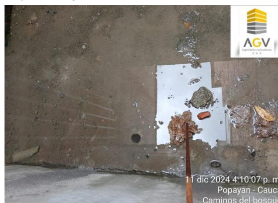
Figura 66. inspección y entrega de las instalaciones hidráulicas casa 294
