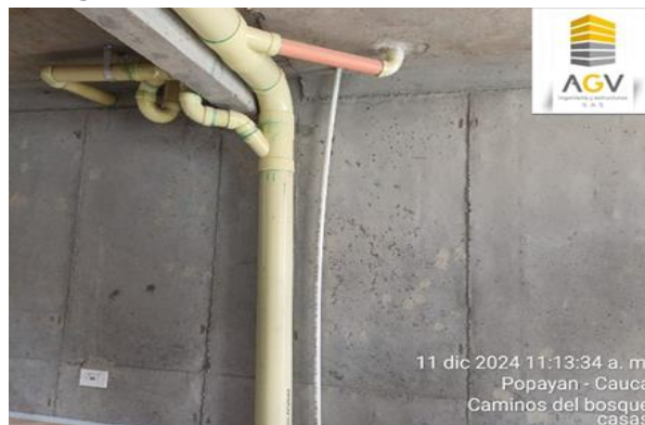
Figura 65. inspección y entrega de las instalaciones hidráulicas casa 294
