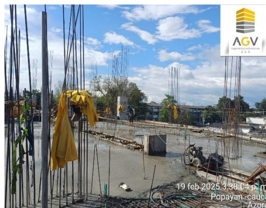
Imagen 33, 34, 35. Fraguado de losa, piso 4, Edificio AZORA
