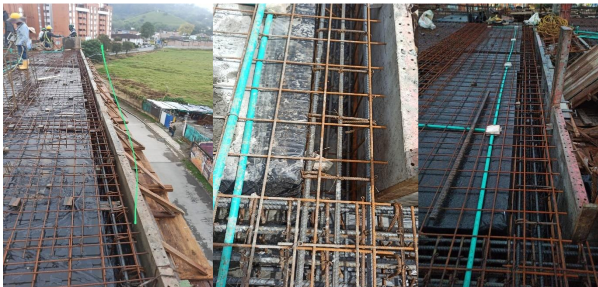
Imagen 39, 40, 41. Alineamientos y ajustes de aceros de losa del piso 4, Edificio AZORA
