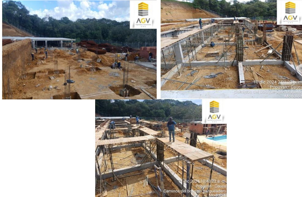
Imagen 15, 16, 17. Ubicación de refuerzos de cimientos a losa, Caminos del Bosque
