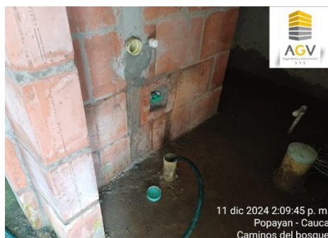
Figura 70. inspección y entrega de las instalaciones hidráulicas casa 339
