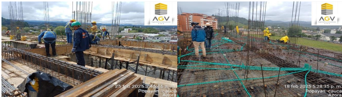
Imagen 42,43. Alineamientos y ajustes de losa del piso 4, Edificio AZORA
