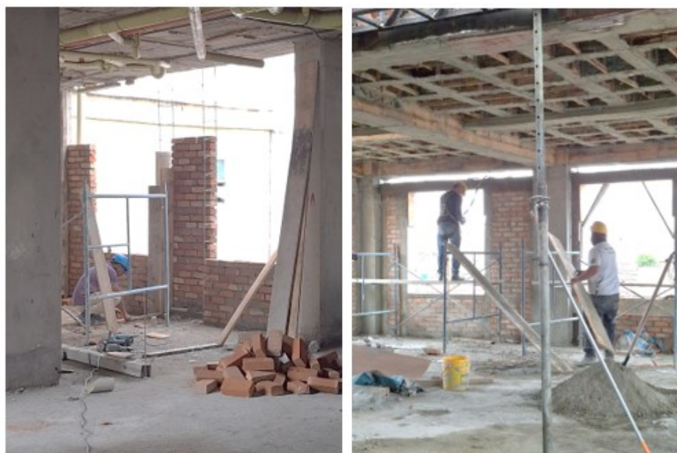
Ilustración 12 Levantamiento de muros de mampostería
