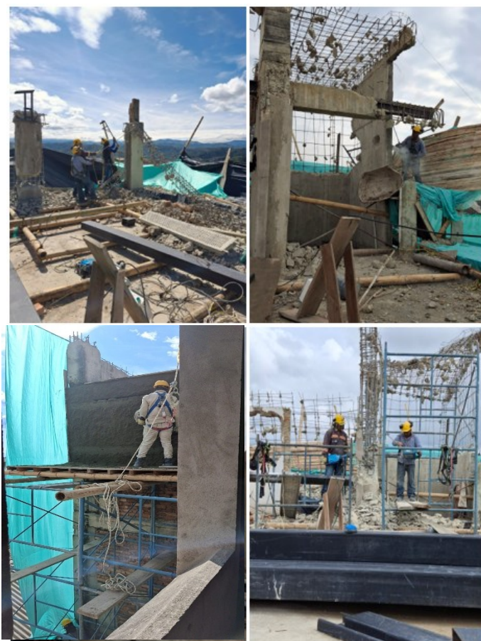
Ilustración 6 Labores de demolición en el cuarto nivel de la edificación
