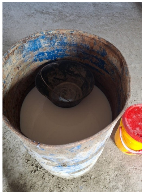
Ilustración 22 Preparación de agua más aditivo impermeabilizante
