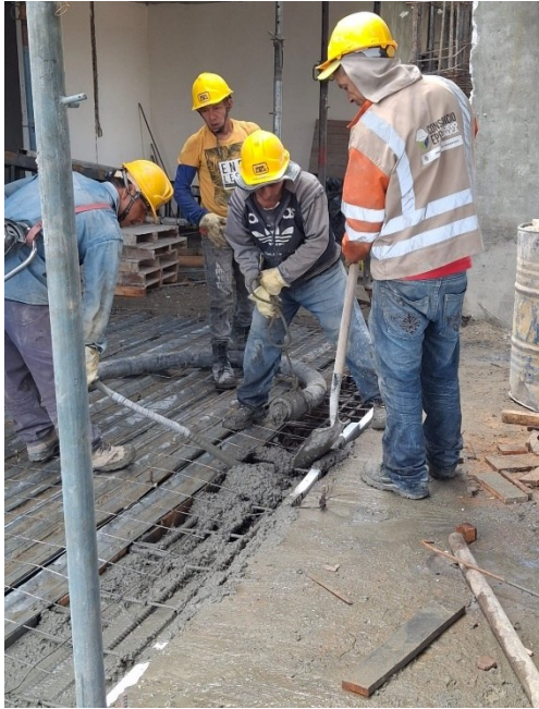
Ilustración 20 Fundición de losa y vigas empalme nivel dos
