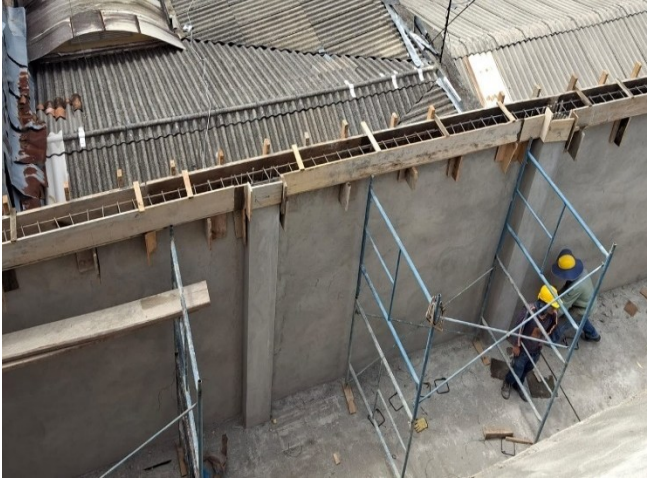
Ilustración 18 Armado formaleta para alfajía
