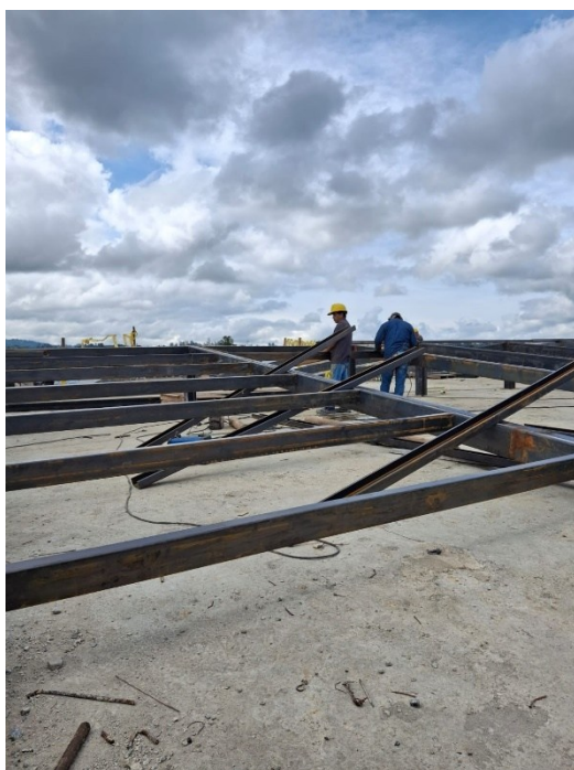
Ilustración 27 Armado de estructura metálica de la cubierta
