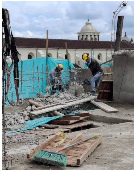
Ilustración 14 Demolición cuarto nivel
