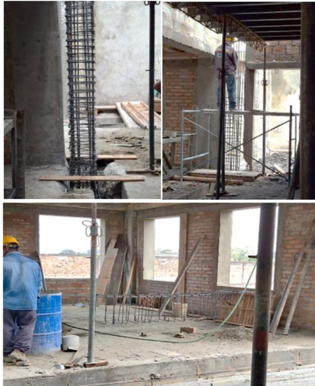
Ilustración 9 Colocación acero de refuerzo en vigas y columnas
