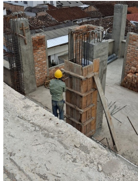
Ilustración 17 Armado formaleta para columna
