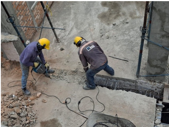
Ilustración 15 Demolición de viga para empalme de cuerpo dos y tres
