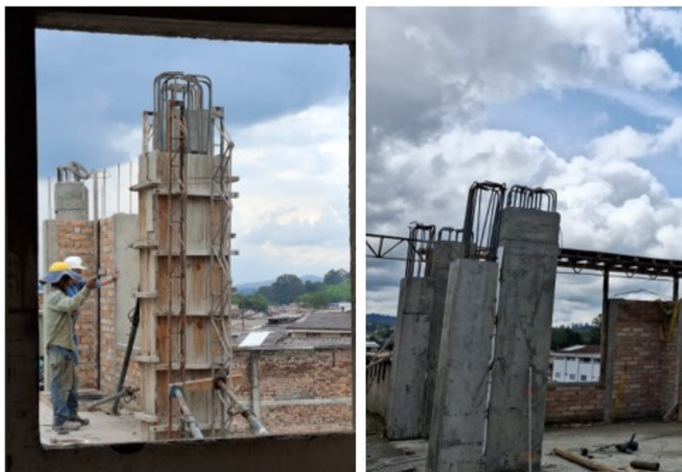
Ilustración 11 Encofrado y desencofrado de columnas
