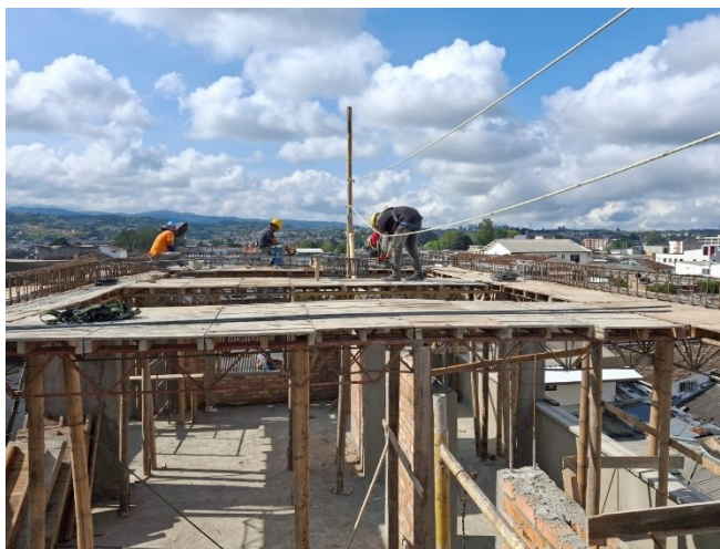
Ilustración 26 Armado de encofrado y castillos cubierta cuerpo tres
