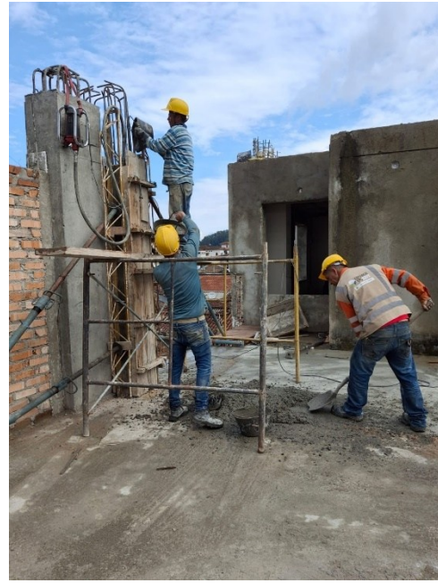
Ilustración 19 Fundición columnas cuerpo tres
