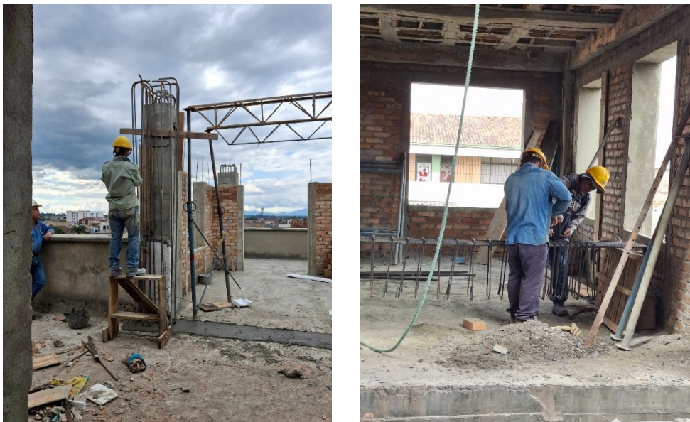
Ilustración 16 Armado de castillos, vigas y columnas
