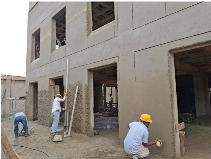
Ilustración 23 Repello muros externos cuerpo tres
