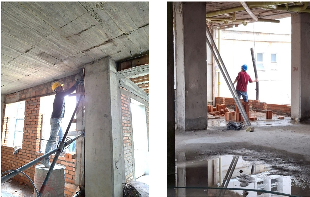
Ilustración 21 Levantamiento de muros de mampostería
