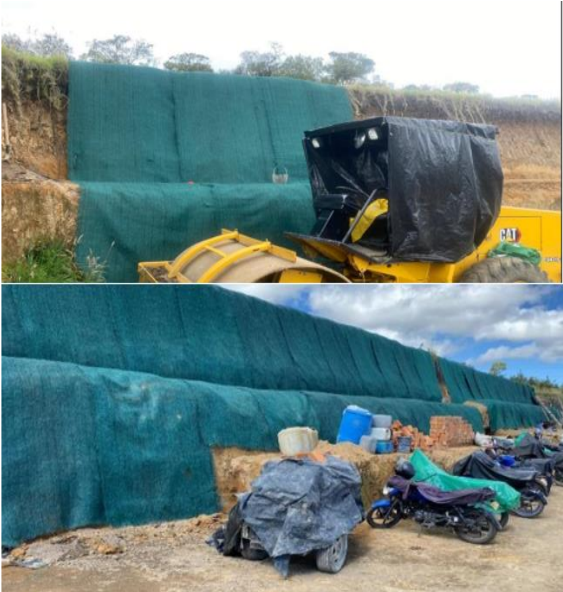
Ilustración 23 Instalación Geo Manto.
