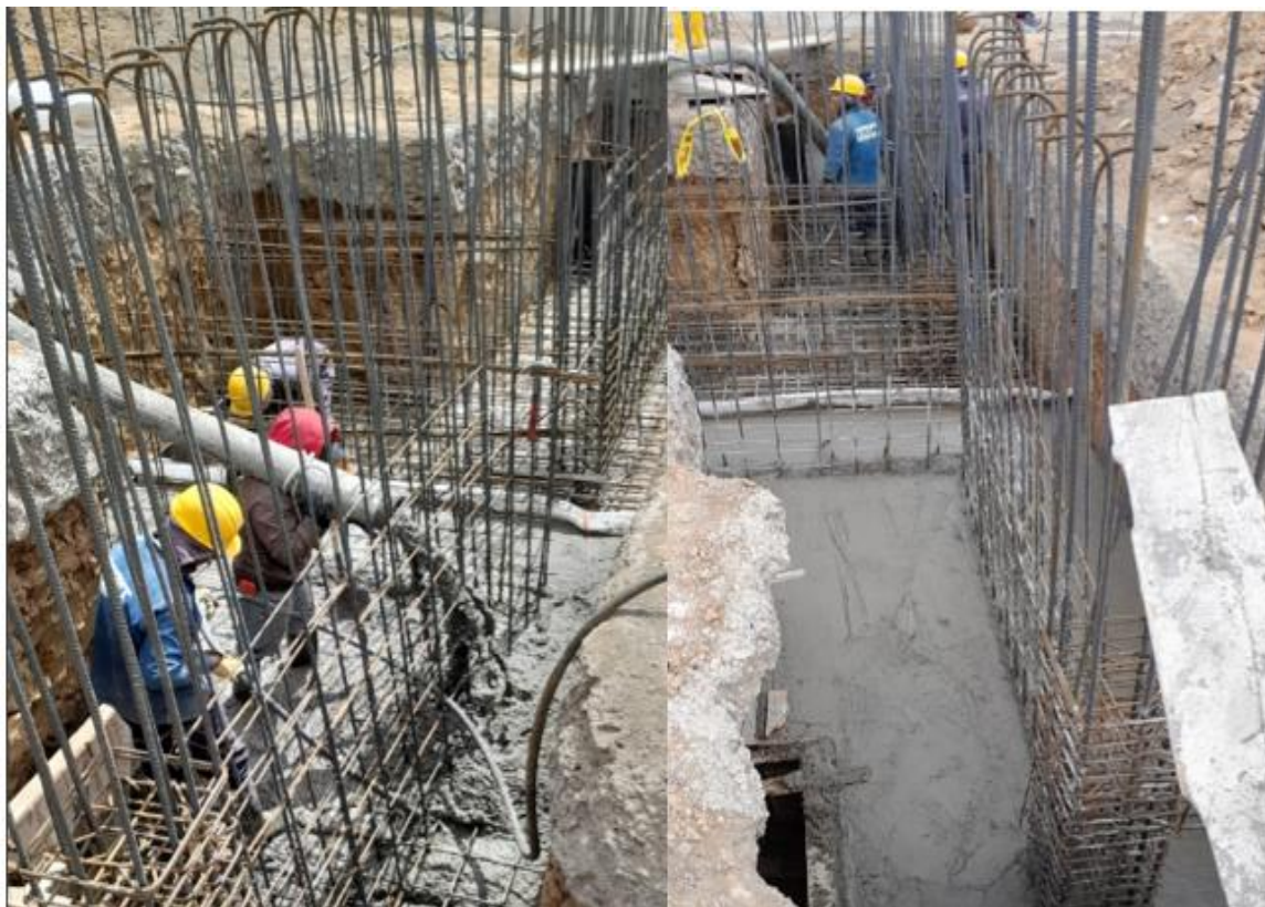
Ilustración 31 Fundición Zarpa Muros Internos.
