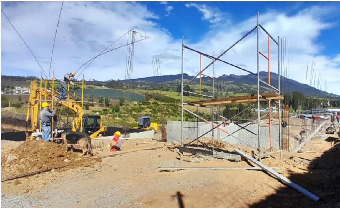
Ilustración 79 Instalación Acero Columnas [N+1.50m-N+4.56m]
