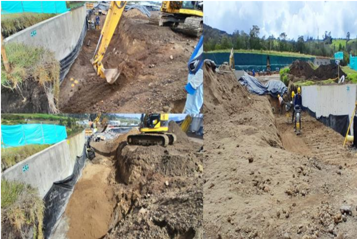
Ilustración 54 Instalación Relleno Estructural Muro M8.
