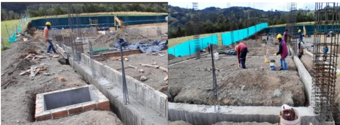
Ilustración 78 Desencofrado Columnas y Vigas de Cimentación N+1.50m.
