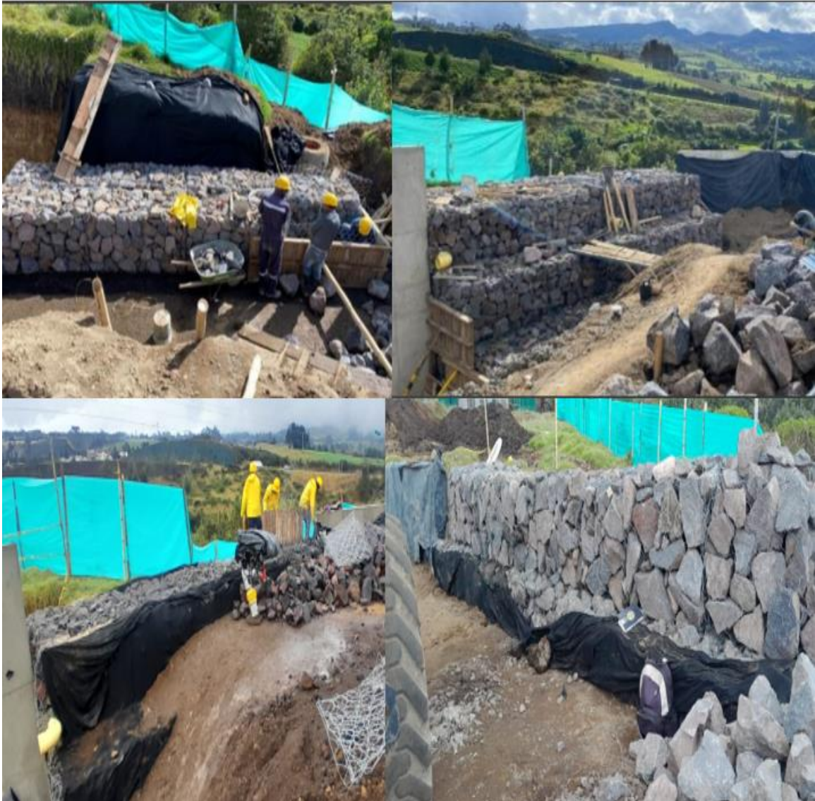
Ilustración 62 Construcción Muro en Gavión.
