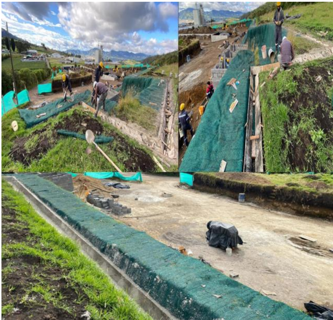
Ilustración 24 Fundición Cuneta de Coronación Talud Superior
