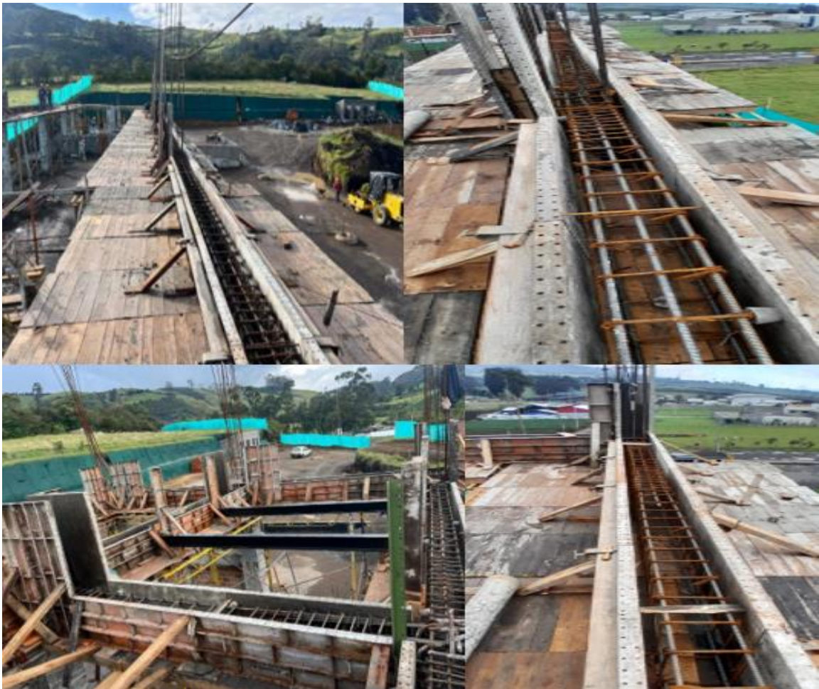
Ilustración 91 Encofrado Viga Aérea N+4.56m.
