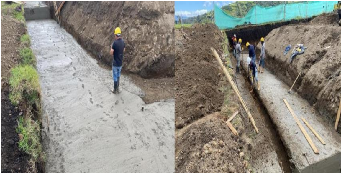
Ilustración 13 Fundición concreto de limpieza y Excavación dentellón de muros.
