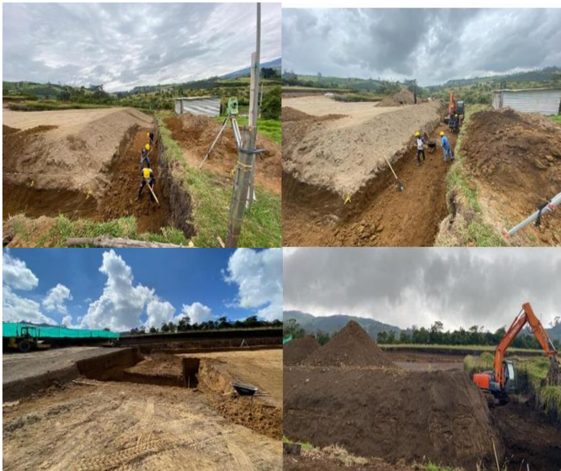
Ilustración 11 Excavaciones mecánicas muros de contención.
