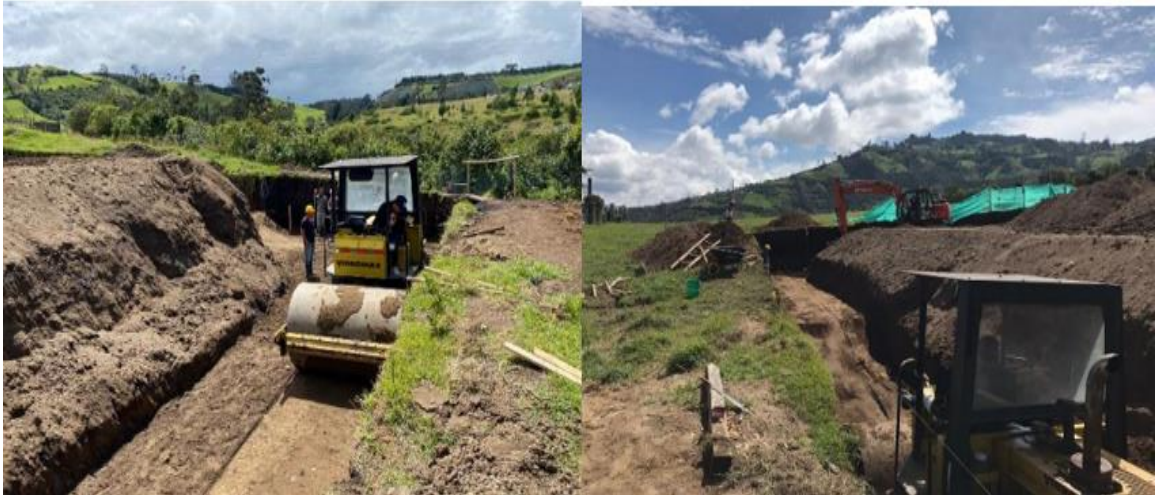
Ilustración 12 Instalación material de mejoramiento áreas de cimentación de muros.
