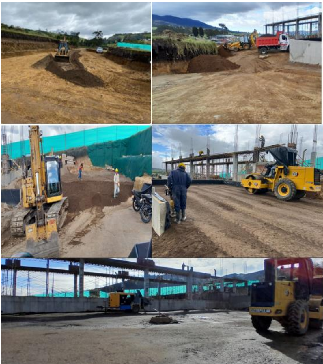
Ilustración 97 Mejoramiento y Compactación Sub Rasante N+0.00
