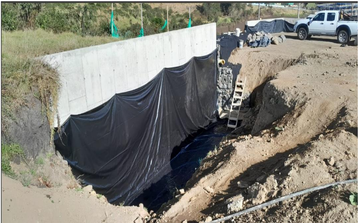
Ilustración 49 Instalación Capa Impermeable de Polietileno.
