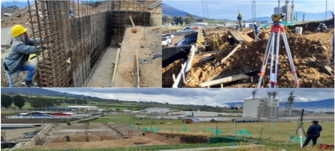
Ilustración 32 Replanteo Muros Internos.
