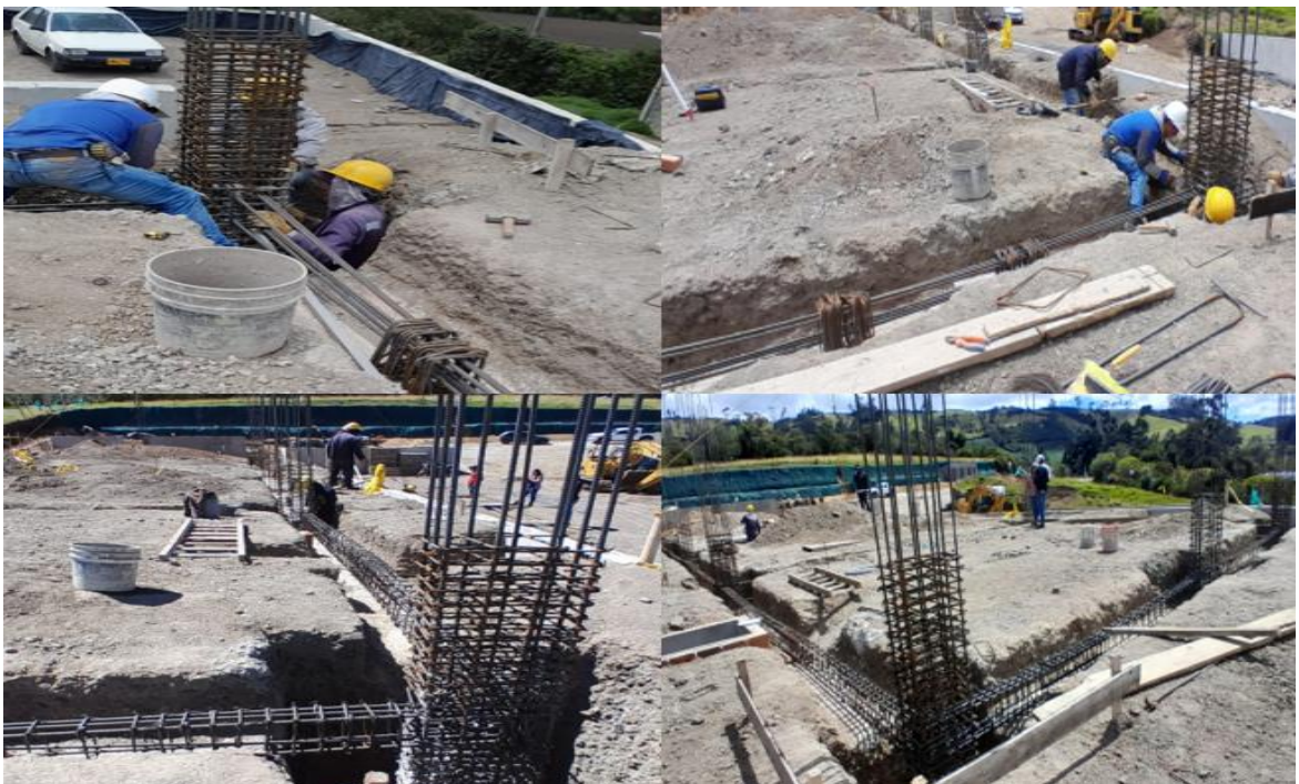
Ilustración 74 Instalación Acero Vigas de Cimentación.
