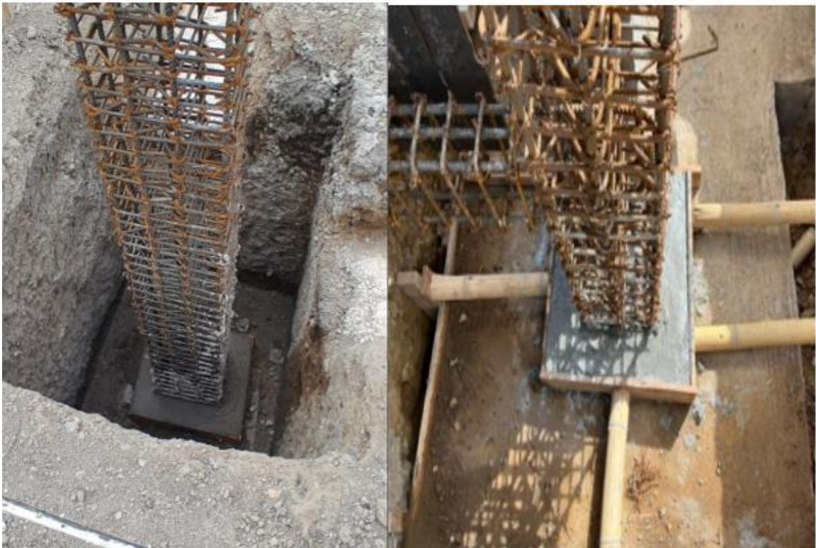
Ilustración 72 Fundición de Pedestales.
