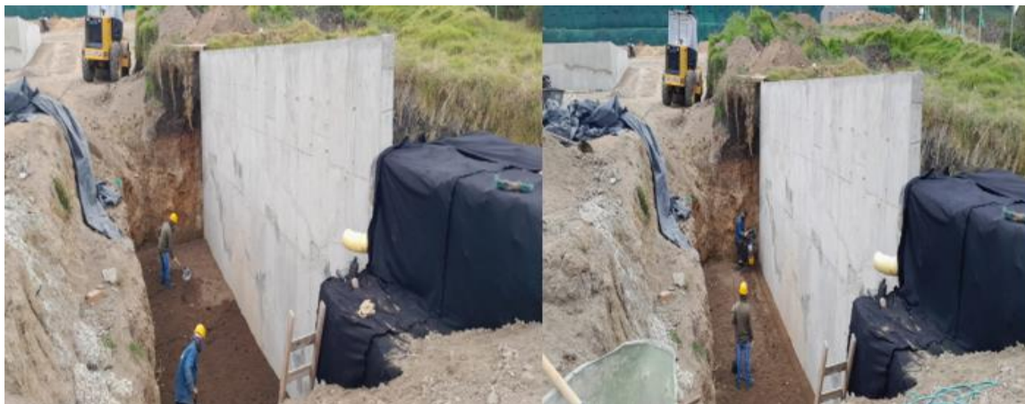
Ilustración 48 Instalación Relleno Estructural.
