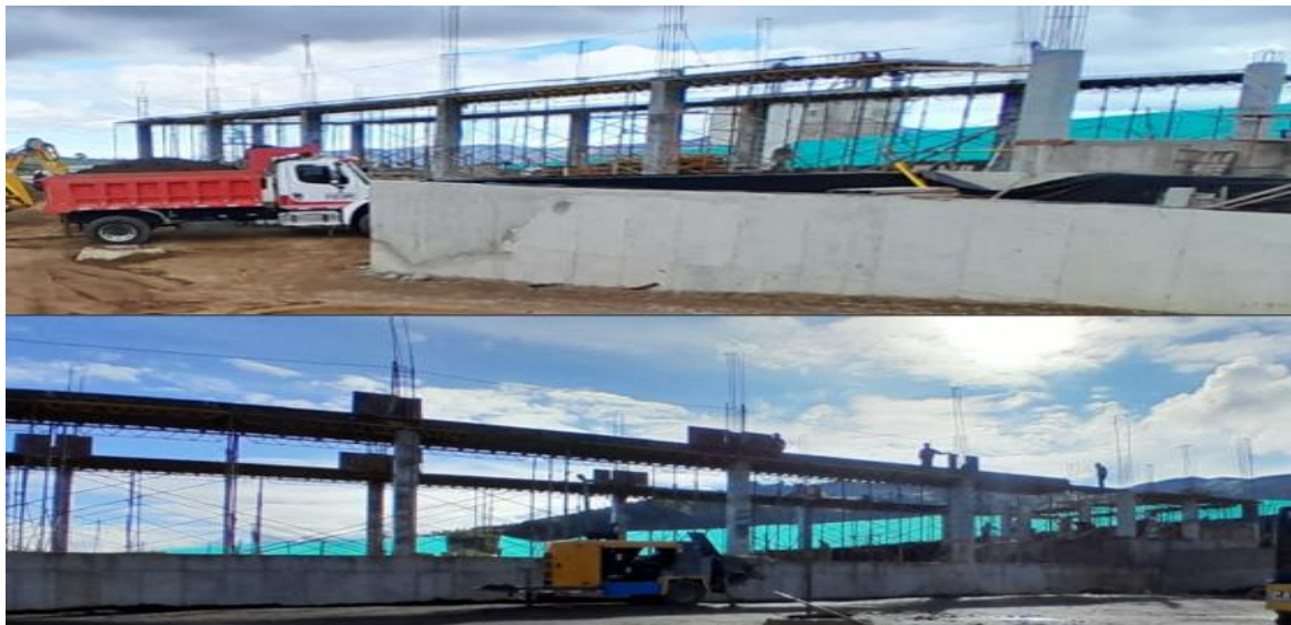
Ilustración 88 Construcción Plataforma de Trabajo.
