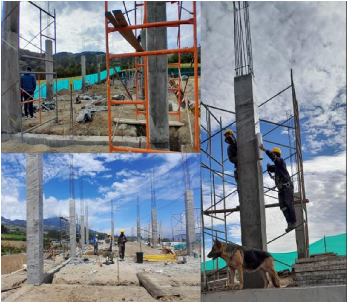
Ilustración 85 Desencofrado y Curado Columnas [N+1.50m-N+4.56m].
