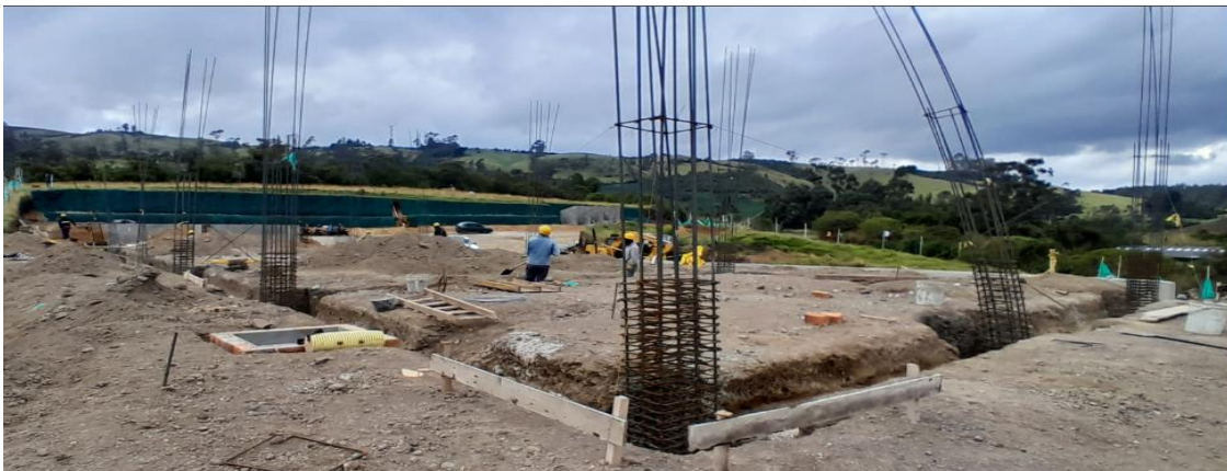
Ilustración 70 Armado Acero de Zapatas
