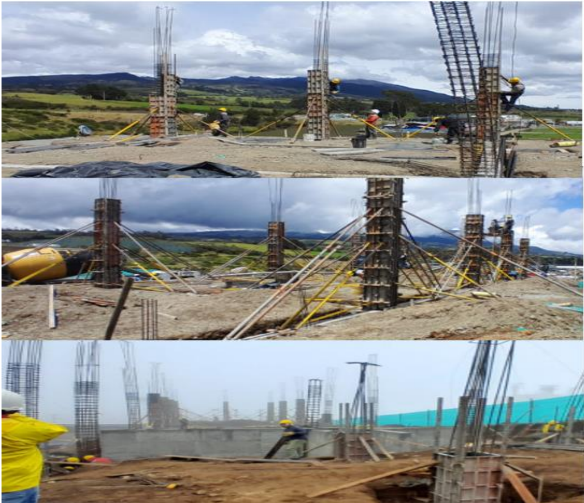
Ilustración 82 Encofrado Columnas [N+1.50m-N+4.56m]
