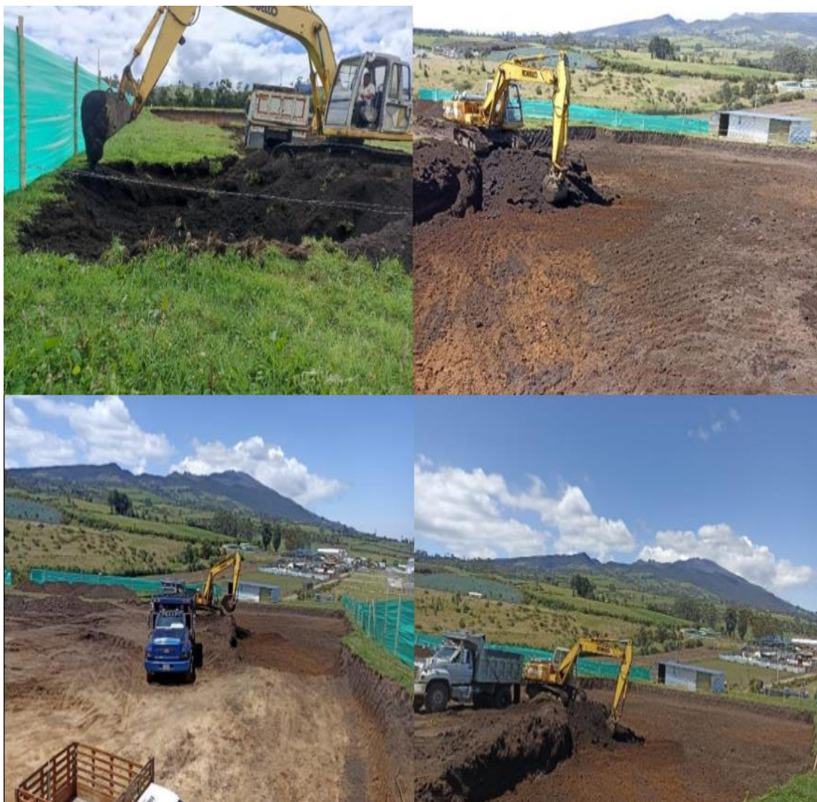
Ilustración 6 Excavación y movimiento de tierras.
