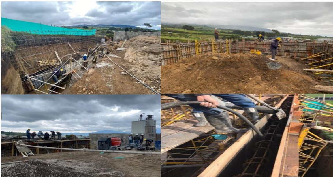
Ilustración 16 Fundición vástagos de muros.
