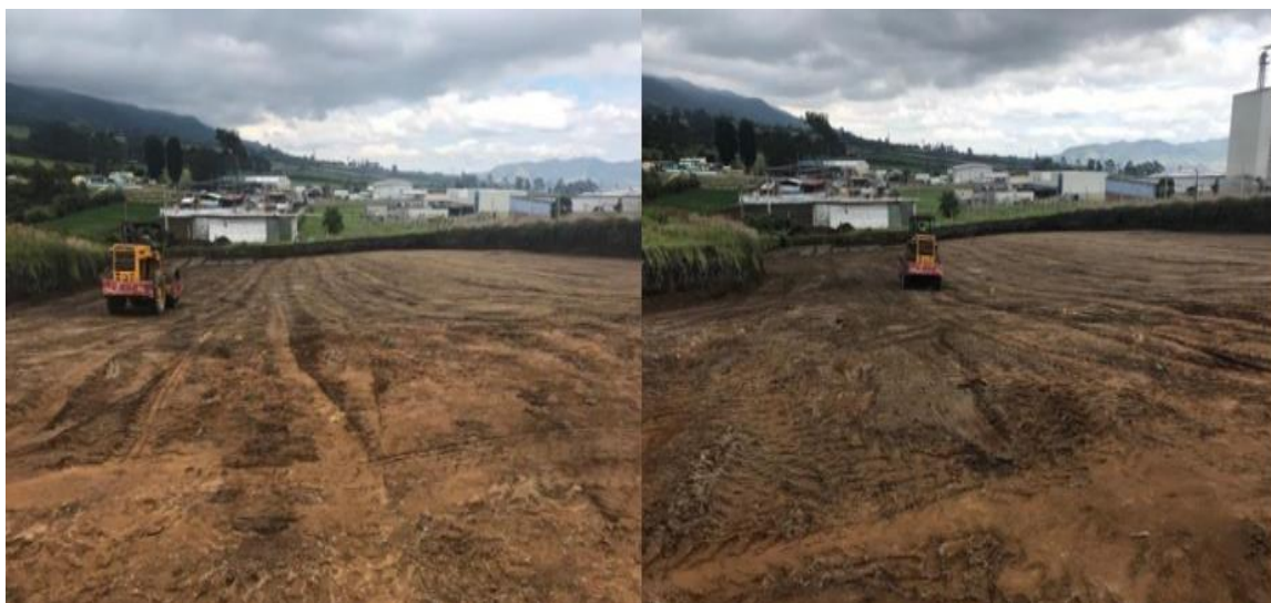
Ilustración 8 Conformación de Sub Rasante.
