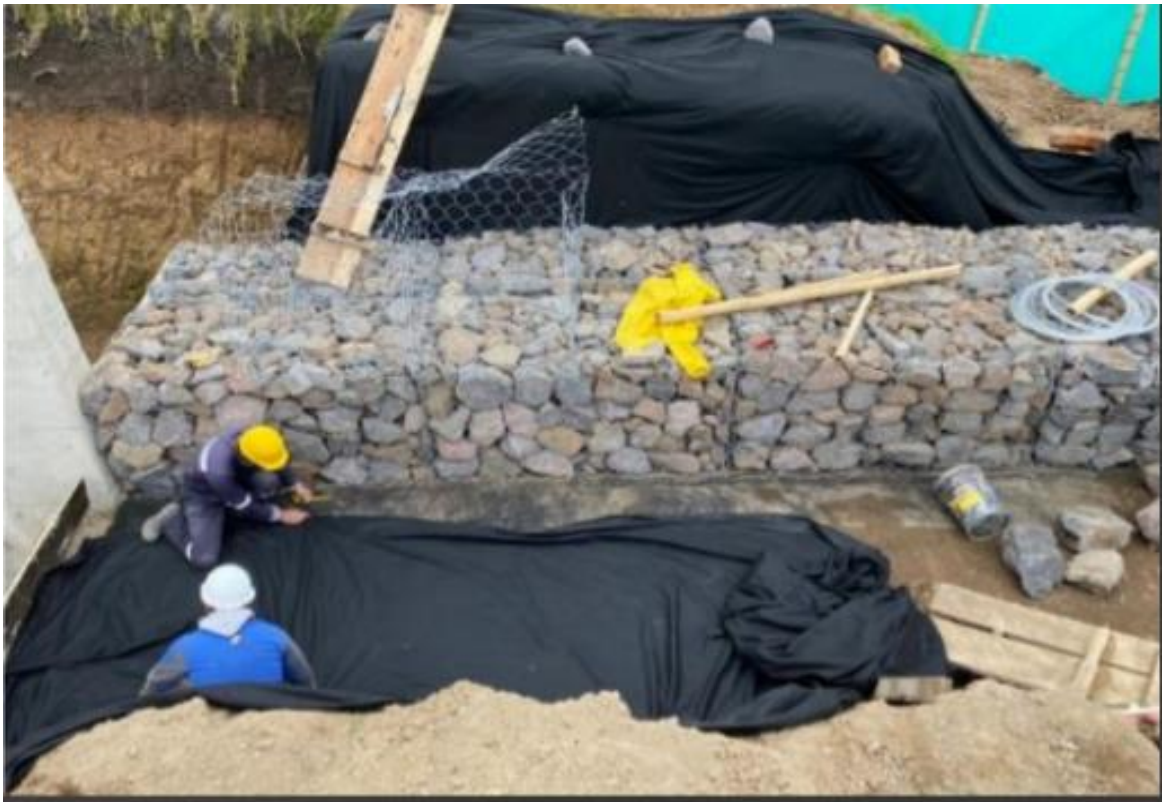
Ilustración 59 Instalación Geotextil Muro en Gavión.
