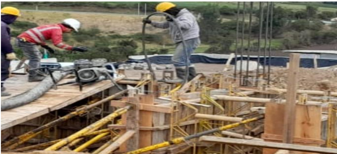
Ilustración 34 Vibración de Concreto.
