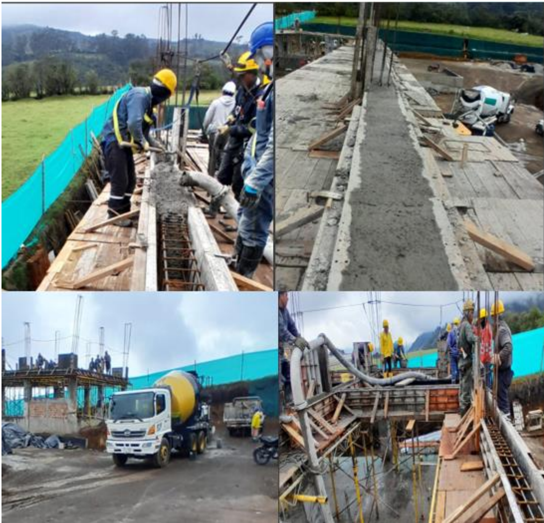
Ilustración 92 Fundición Viga Aérea, N+4.56m.
