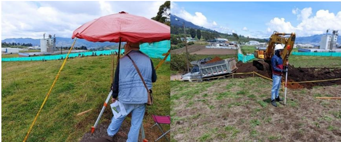
Ilustración 5 Localización y Replanteo
