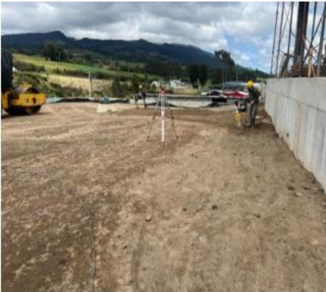
Ilustración 95 Replanteo Niveles Sub Rasante.
