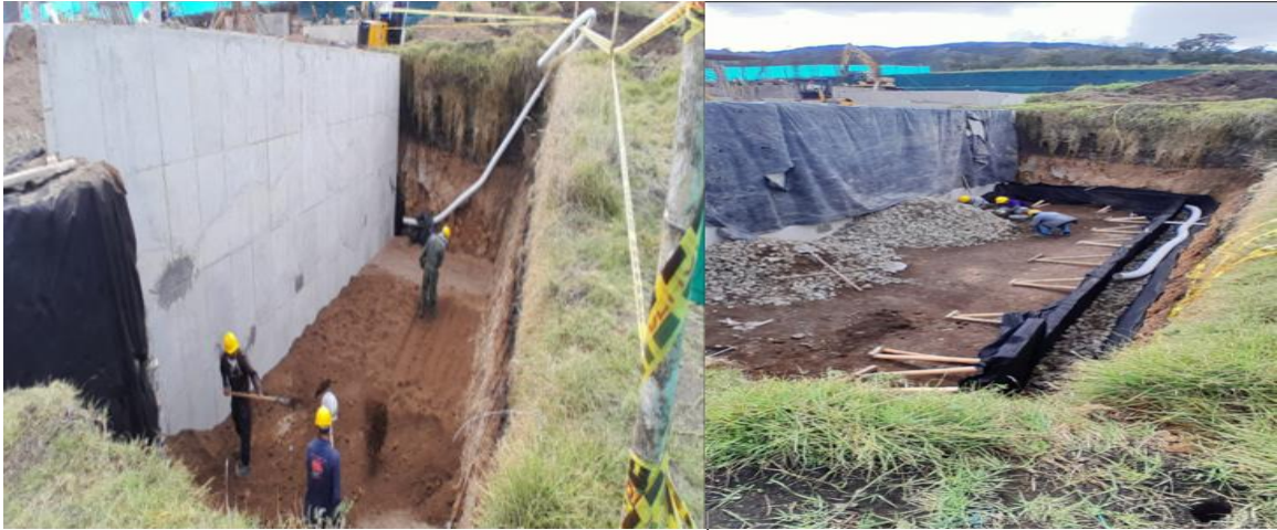
Ilustración 52 Construcción Filtro M8
