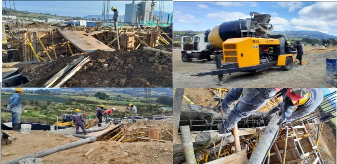
Ilustración 35 Fundición Vástago Muros Internos.
