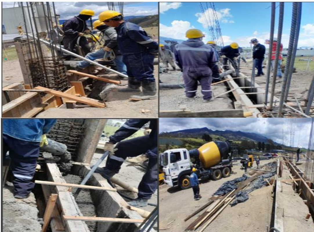
Ilustración 76 Fundición columnas y vigas de Cimentación N+1.50m.
