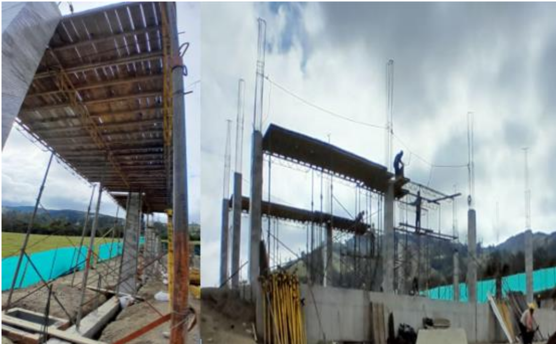
Ilustración 86 Construcción Plataforma de Trabajo.
