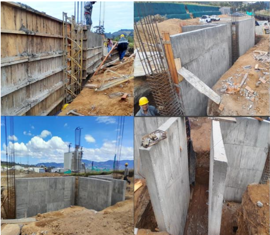
Ilustración 37 Desencofrado y Curado Muros Internos.
