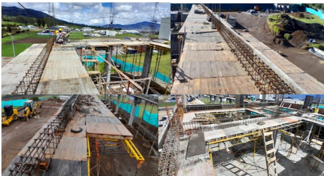
Ilustración 90 Instalación Acero de Refuerzo Viga Aérea N+4.56m.
