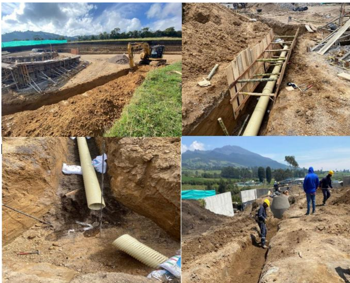
Ilustración 18 Construcción red principal de alcantarillado.
