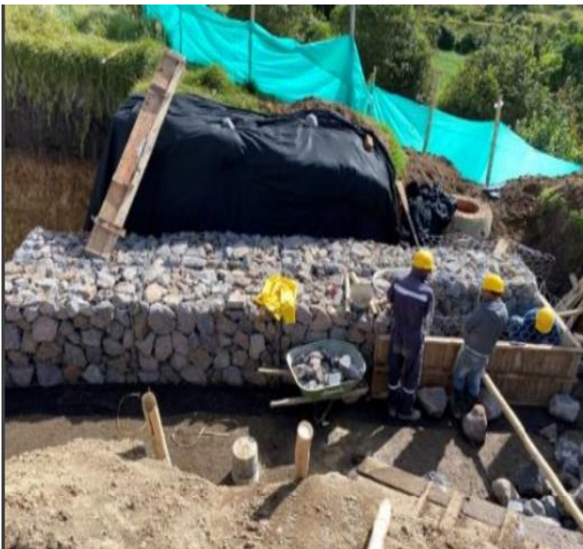
Ilustración 61 Construcción Muro en Gavión.
