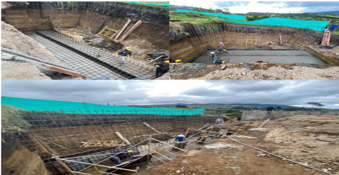
Ilustración 44 Fundición Zarpa Muro M8.
