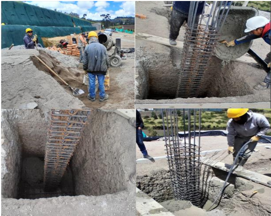
Ilustración 71 Fundición Zapatas.
