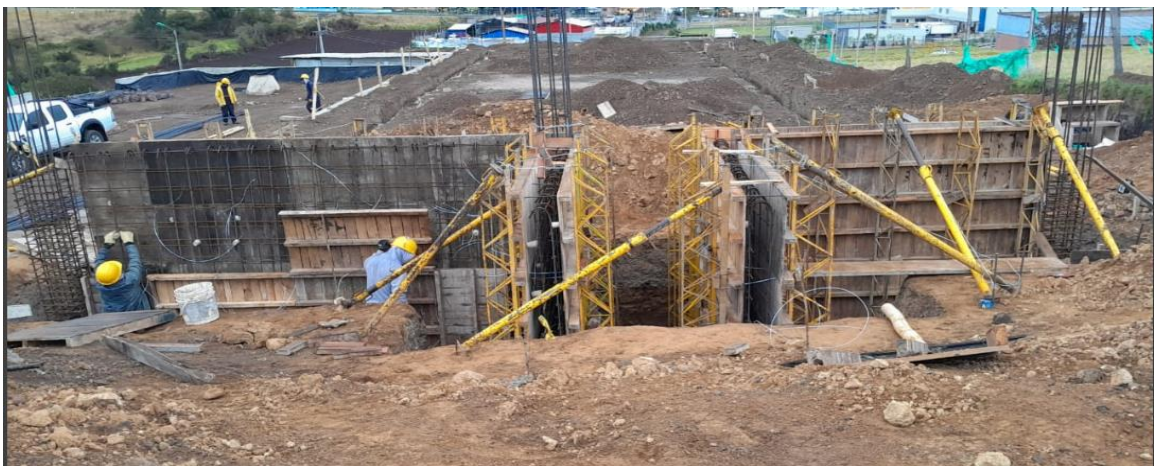
Ilustración 33 Encofrado Muros Internos.
