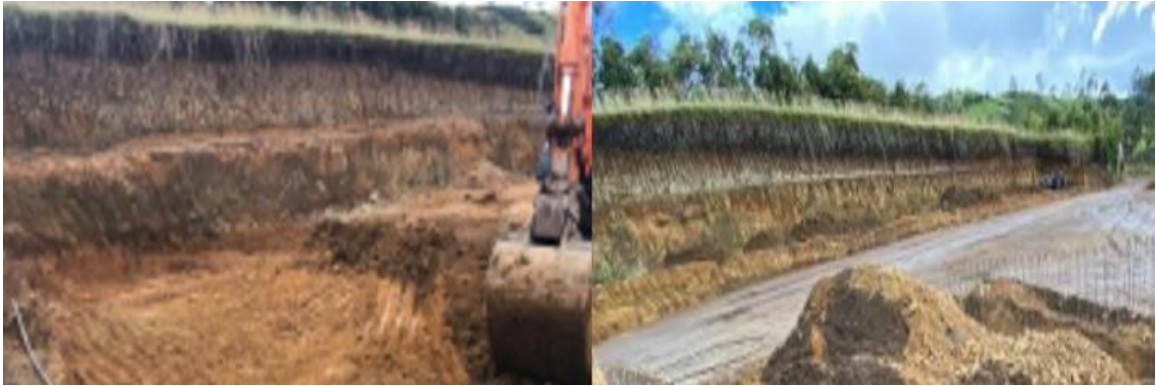
Ilustración 20 Corte y conformación Talud Superior.
