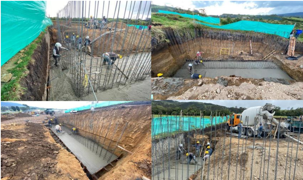
Ilustración 15 Fundición zarpa de muros.
