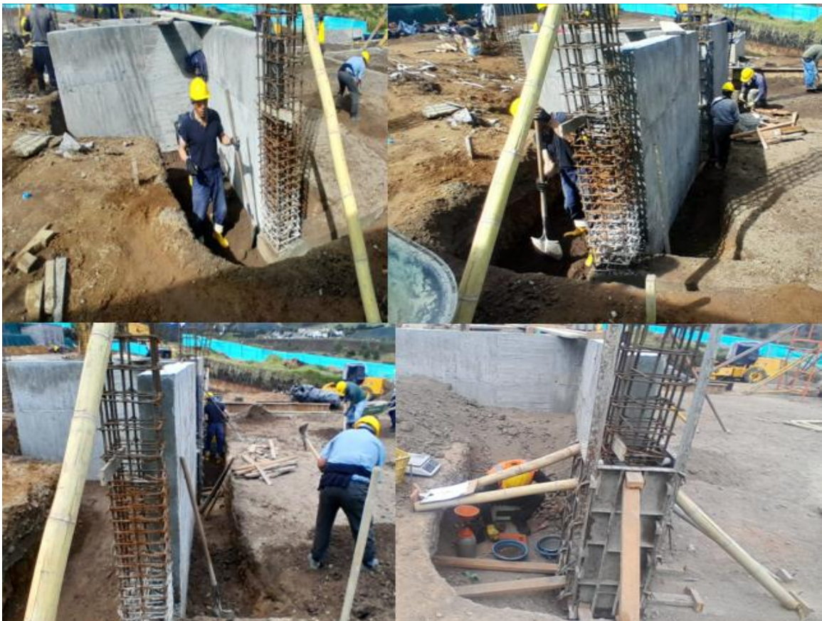
Ilustración 38 instalación Material de Relleno Estructural.
