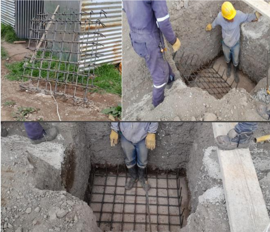
Ilustración 68 Instalación Acero de Zapatas.
