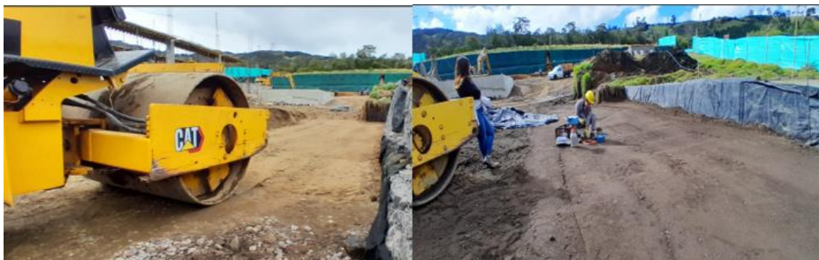
Ilustración 55 Instalación Relleno Estructural Muro M8.
