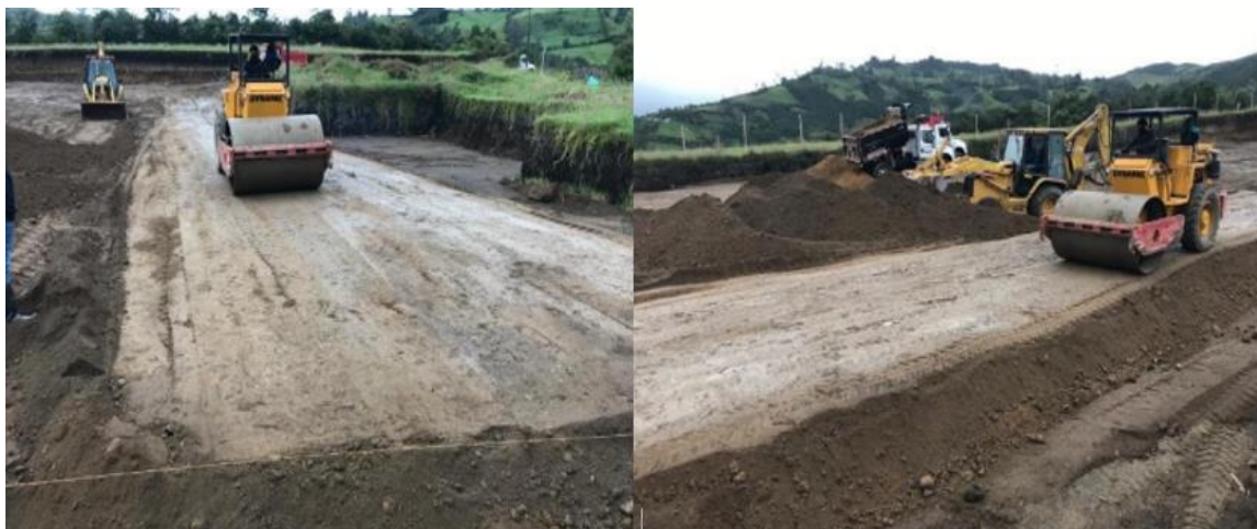
Ilustración 9 Mejoramiento de suelo con material de afirmado.
