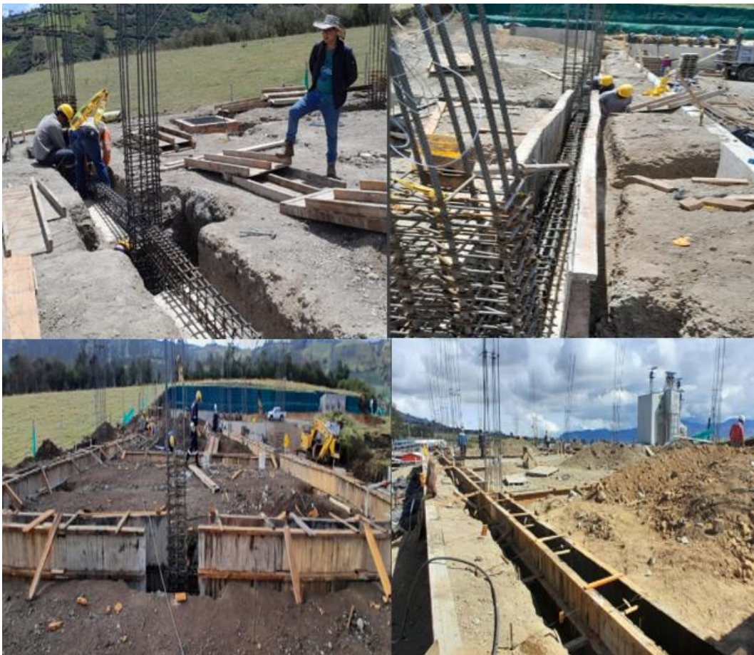
Ilustración 75 Encofrado Vigas de Cimentación.
