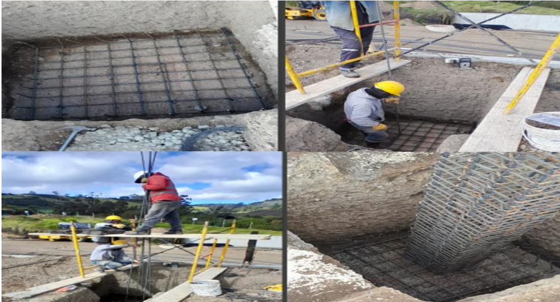
Ilustración 69 Instalación Acero de Zapatas.
