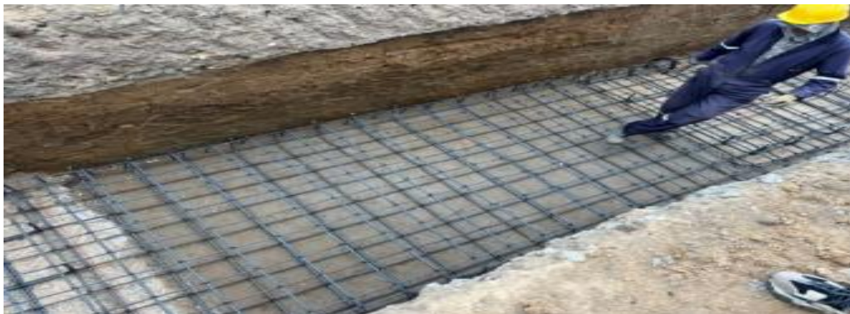
Ilustración 29 Instalación Acero Zarpa Muros Internos.
