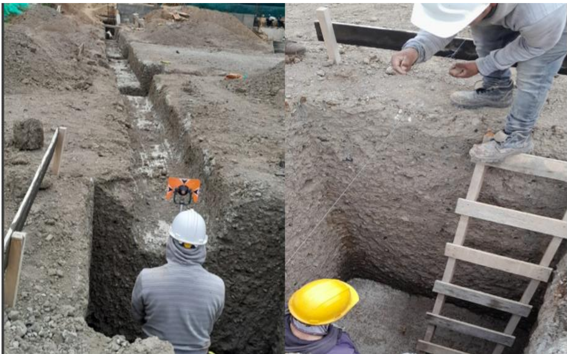
Ilustración 67 Replanteo Ejes de Estructura.
