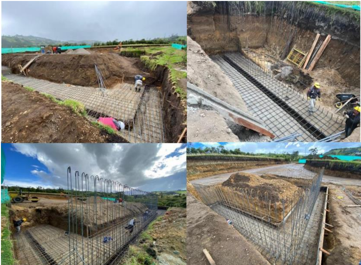
Ilustración 14 Instalación acero de refuerzo para muros.
