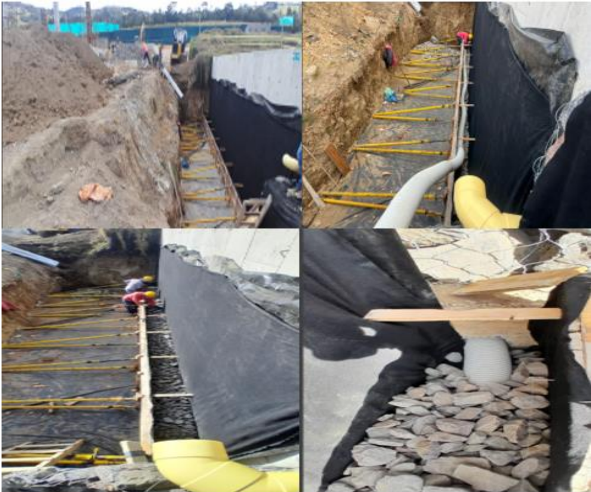
Ilustración 51 Construcción Filtro M8.
