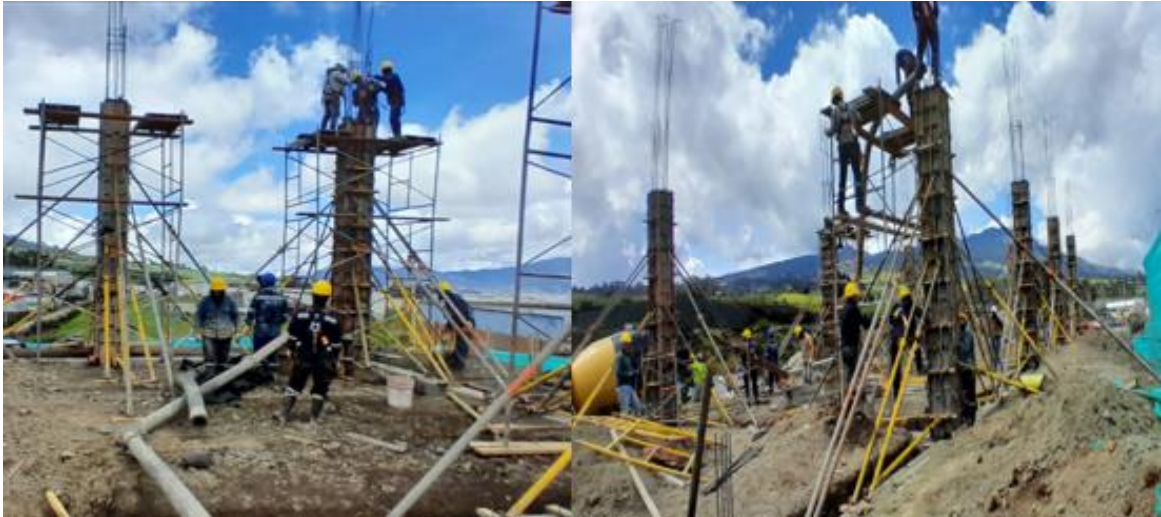
Ilustración 83 Fundición Columnas [N+1.5m-N+4.56m].
