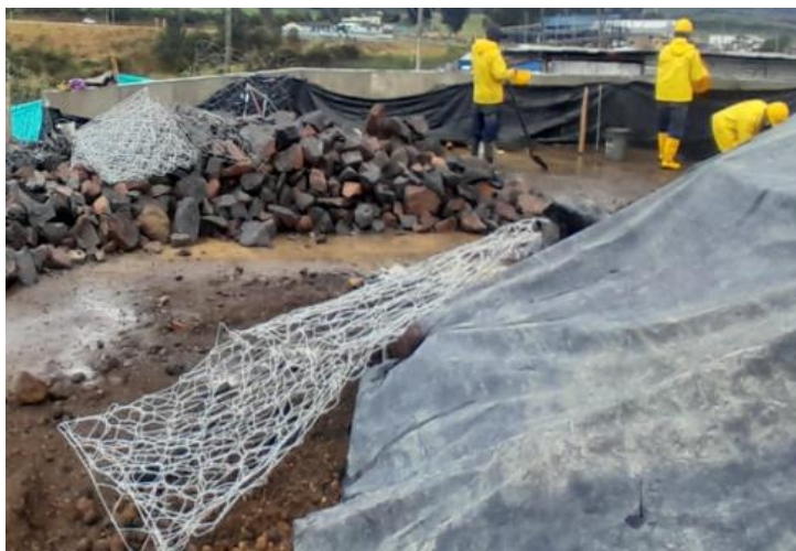
Ilustración 57 Elementos Constructivos Muro en Gavión.
