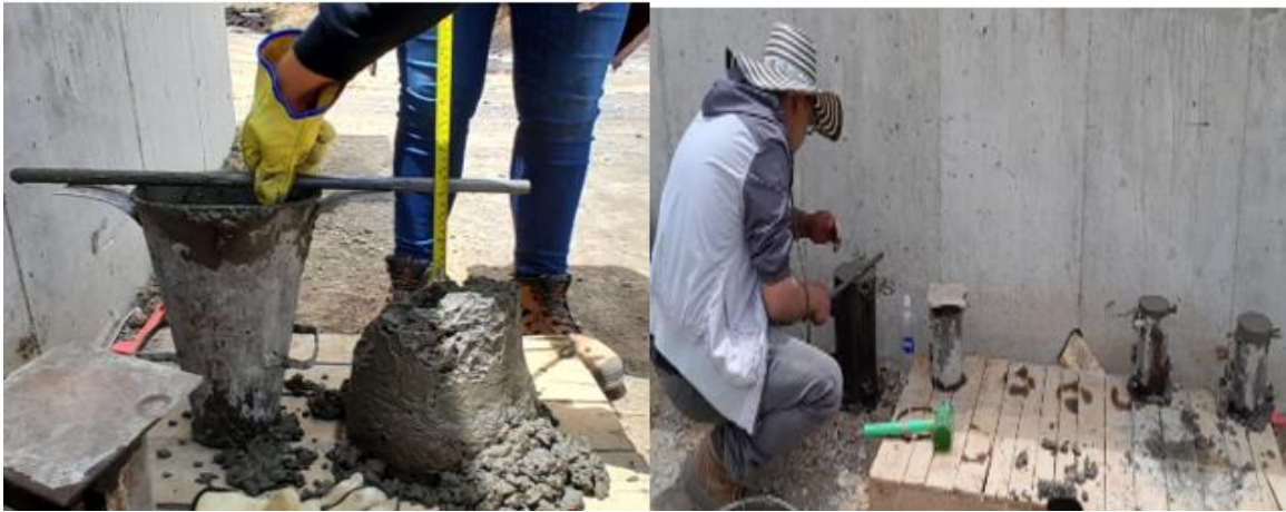
Ilustración 77 Ensayo de Slum, Elaboración de Cilindros Columnas y Vigas cimentación N+1.50m.
