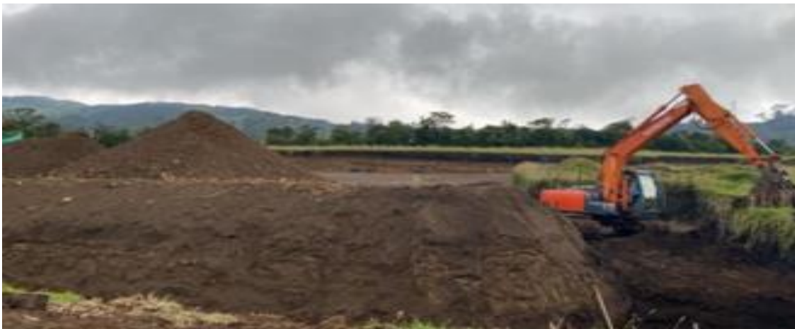
Ilustración 42 Excavación Muro M8.
