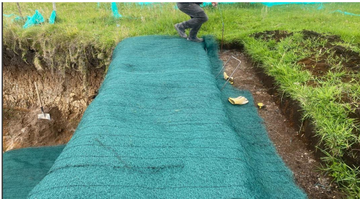
Ilustración 22 Excavación Trinchera Superior.
