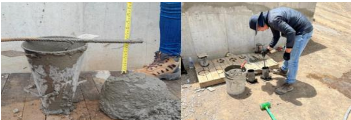
Ilustración 84 Ensayo de Slum, Elaboración de Cilindros Columnas [ N+1.50m-N+4.56m].
