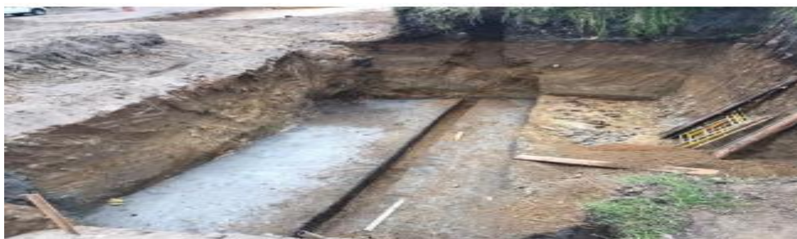
Ilustración 43 Fundición Concreto de Limpieza Muro M8.
