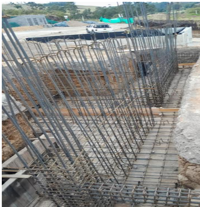
Ilustración 30 Armado Acero de Refuerzo Muros Internos.
