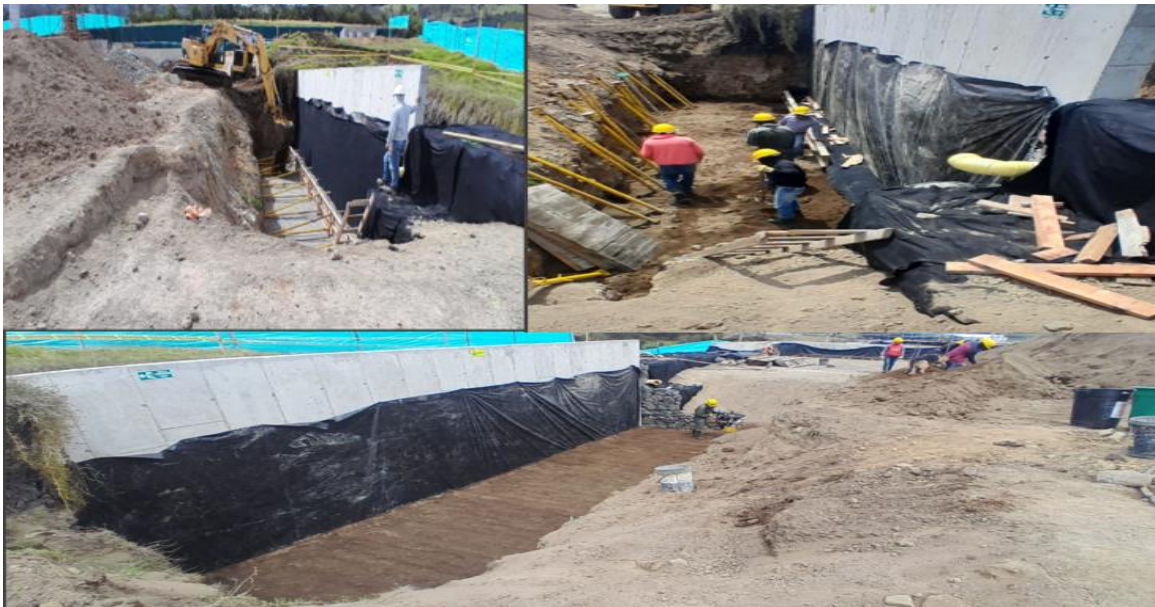
Ilustración 53 Instalación Relleno Estructural Muro M8.
