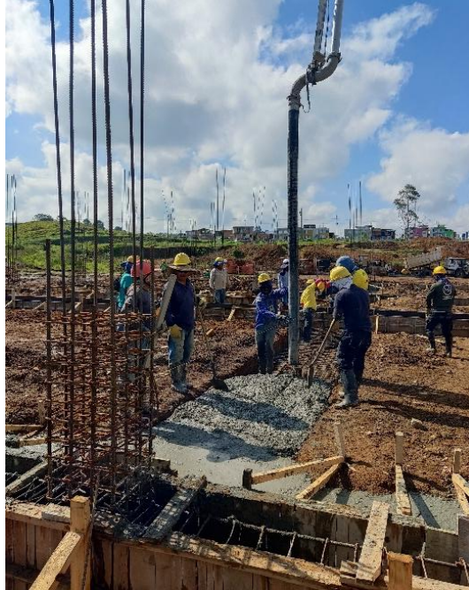
Ilustración 36 - Fundición de cimentación
