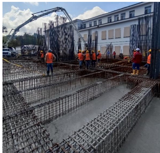
Ilustración 39 - Fundición de losa de contrapiso
