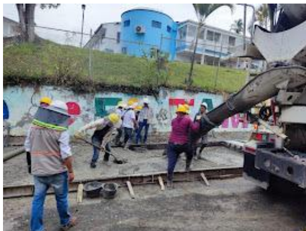
Ilustración 41 - Fundición de pavimento rígido en El Tambo
