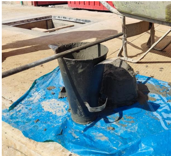
Ilustración 37 - Asentamiento en obra de 6 in
