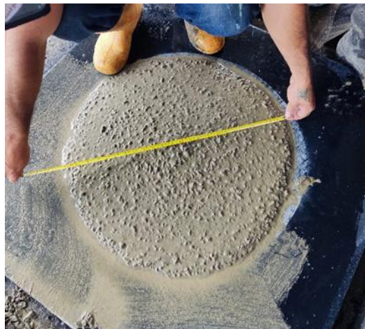
Ilustración 25 - Medición del asentamiento
