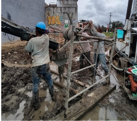
Ilustración 38 - Fundición de pilotes en proyecto de vivienda multifamiliar
