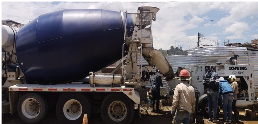
Ilustración 67 Vertimiento de concreto desde mixer a bomba estacionaria
