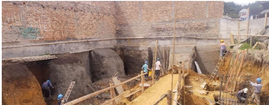
Ilustración 38 Vista general de la excavación por bataches y sistema de contención
