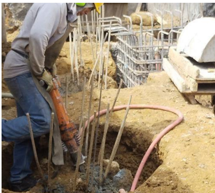
Ilustración 40 Descabezado de pilotes con martillo neumático
