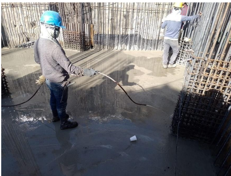
Ilustración 72 Proceso de curado para que el concreto adquiera su resistencia
