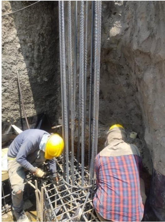
Ilustración 64 Armado de acero arranque columna C1
