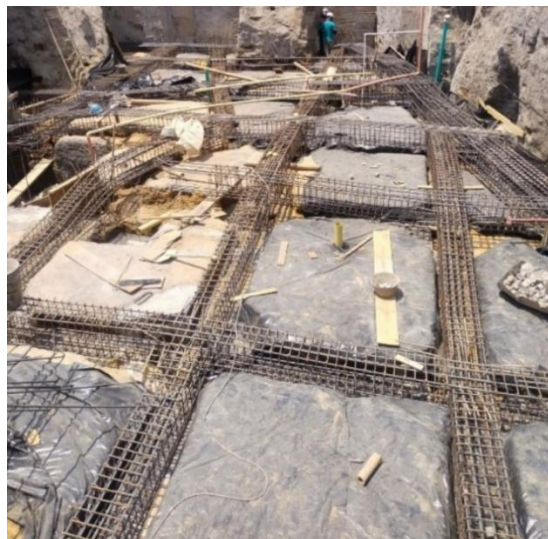
Ilustración 61 Instalación de plástico negro para proteger el acero y concreto
