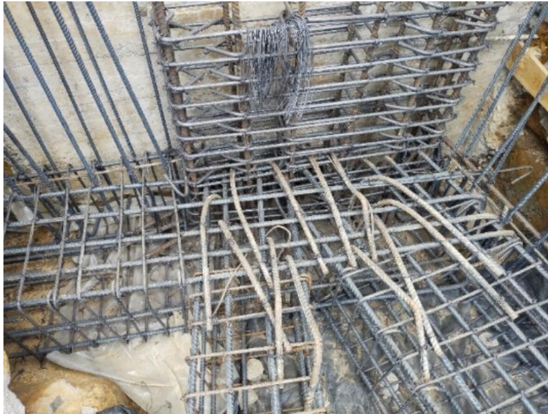
Ilustración 92 Revisión de nudos y longitud adecuada de anclaje
