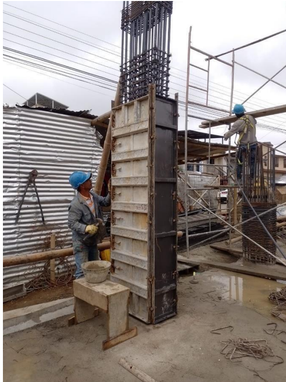
Ilustración 88 Colocación de formaletas en columnas de piso 1
