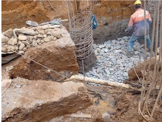
Ilustración 48 Colocación de piedra sobre la superficie del terreno foso del ascensor
