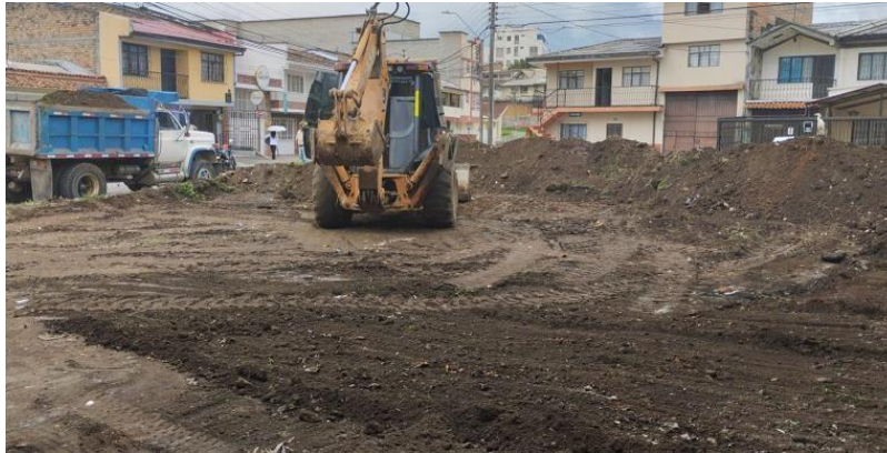
Ilustración 8 Cargue y retiro de material del descapote del terreno
