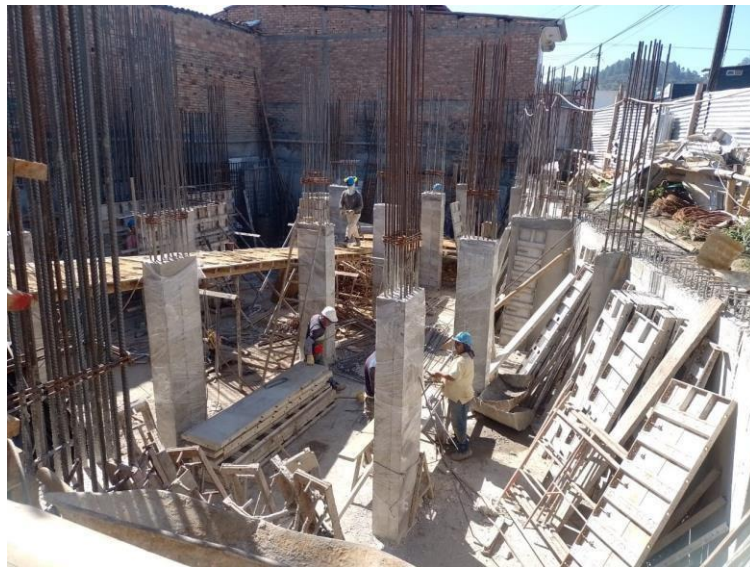
Ilustración 79 Columnas sin formaletas
