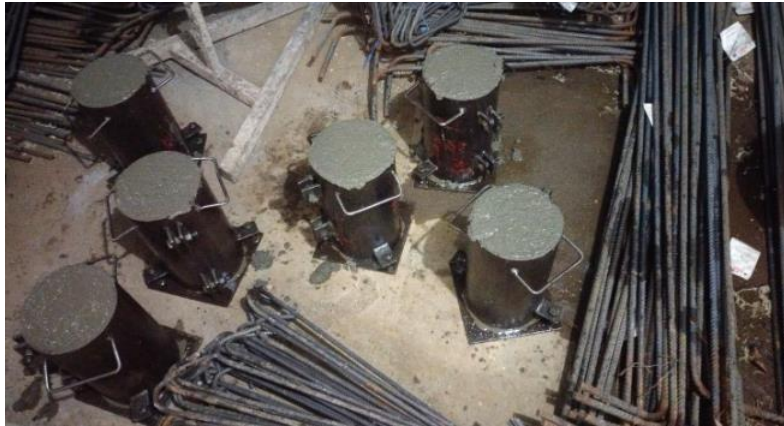
Ilustración 96 Toma de muestras concreto premezclado de cimentación
