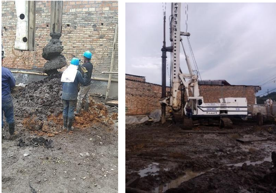
Ilustración 15 Perforación mediante piloteadora con rotación helicoidal
