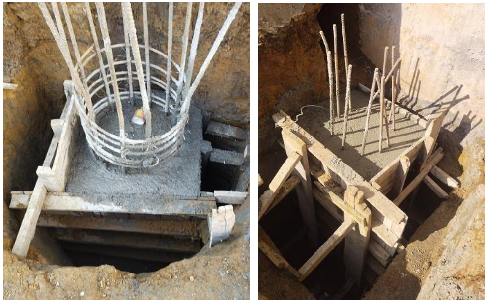
Ilustración 46 Pilotes a nivel de cimentación
