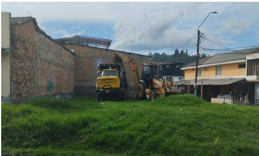
Ilustración 7 Descapote del terreno con maquinaria pesada
