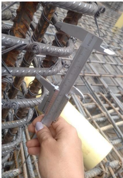
Ilustración 91 Revisión aceros de vigas de cimentación
