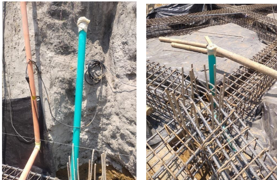
Ilustración 51 Instalaciones de tuberías pluviales y eléctricas
