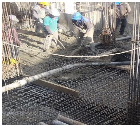
Ilustración 69 Vertimiento y vibrado del concreto premezclado en cimentación
