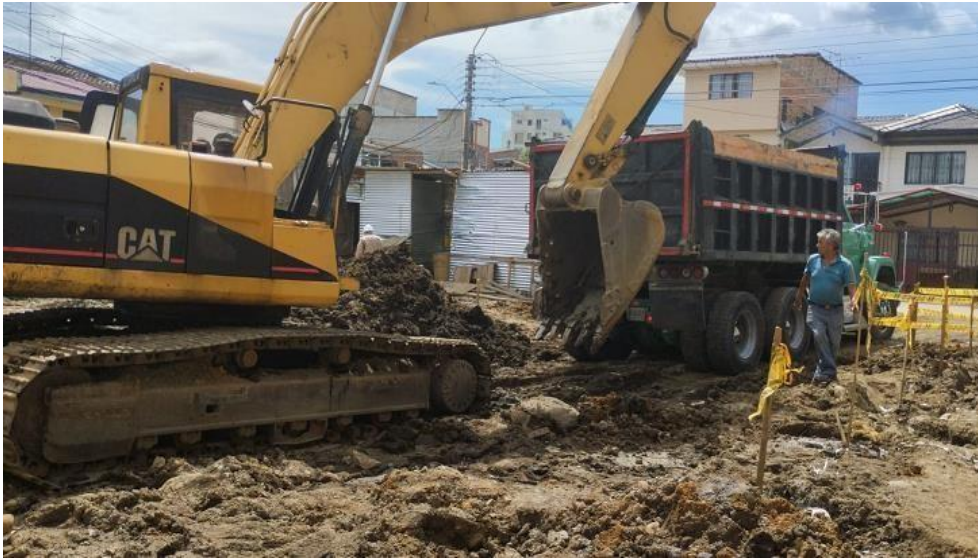
Ilustración 20 Excavaciones, cargue y retiro material con maquinaria pesada
