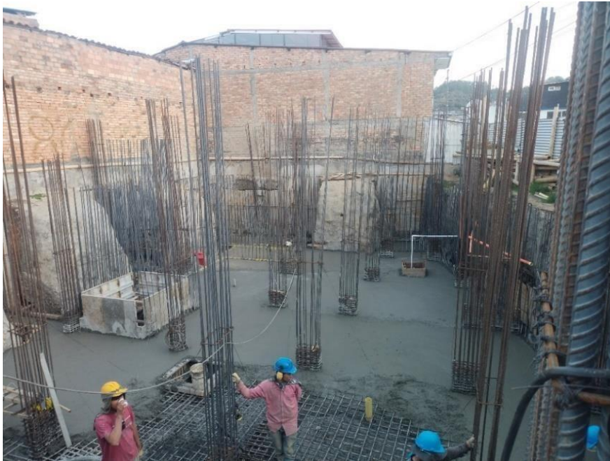
Ilustración 71 Proceso fundición de la estructura de cimentación
