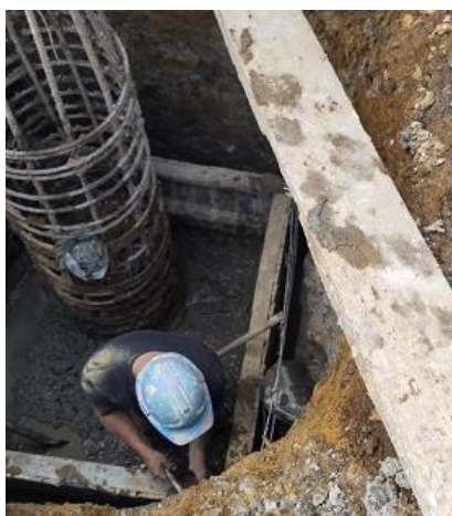
Ilustración 42 Construcción de anillo de seguridad
