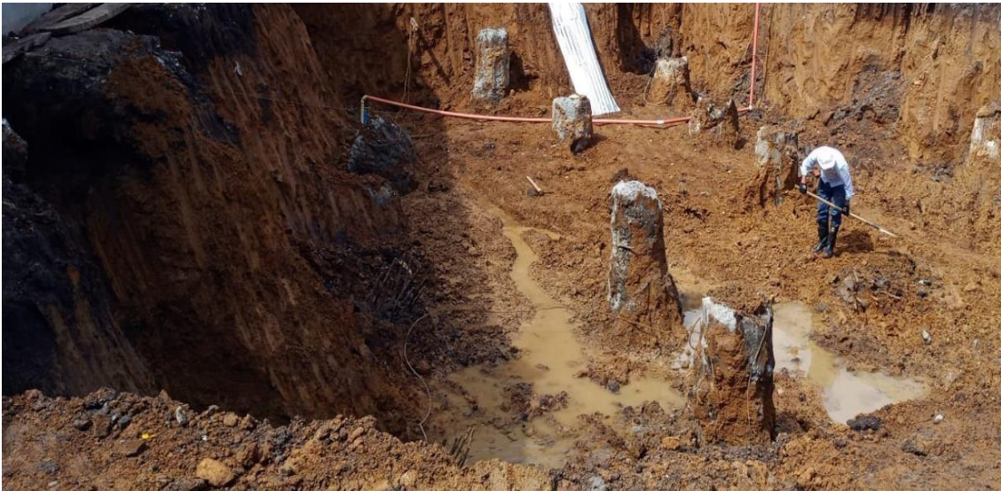
Ilustración 21 Proceso de excavación sótano
