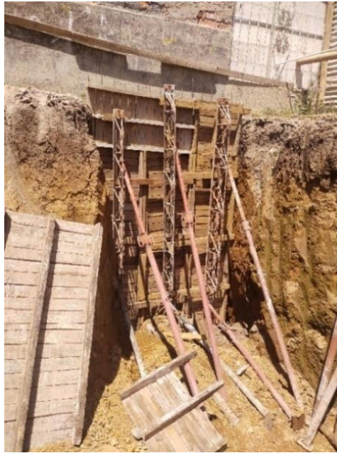
Ilustración 37 Apuntalamiento para sostener el encofrado
