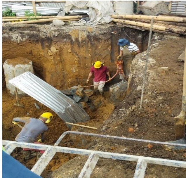
Ilustración 22 Proceso de excavación sótano
