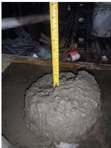
Ilustración 95 Prueba de asentamiento concreto premezclado de cimentación
