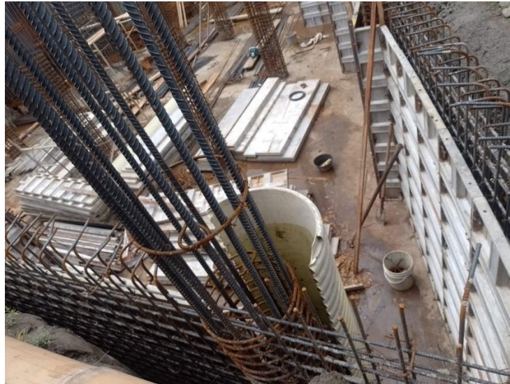
Ilustración 76 Algunos muros con formaleta
