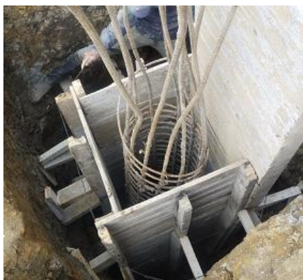
Ilustración 41 Encofrado para fundición de pilotes
