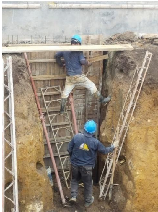
Ilustración 36 Proceso encofrado de muros por el sistema tradicional
