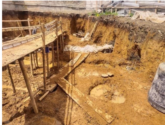
Ilustración 24 Armado de rampa para evacuación de material excavado
