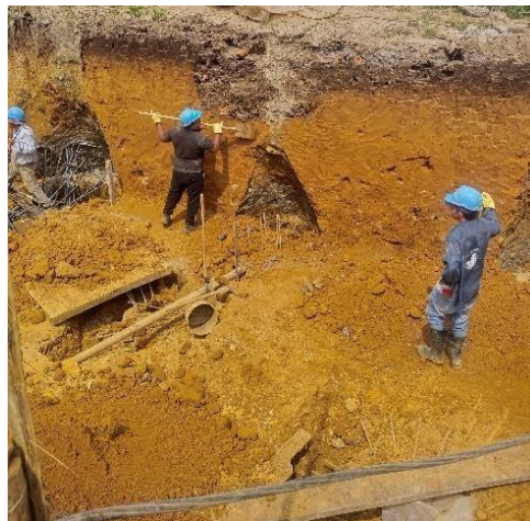
Ilustración 34 Proceso de perfilación de muros
