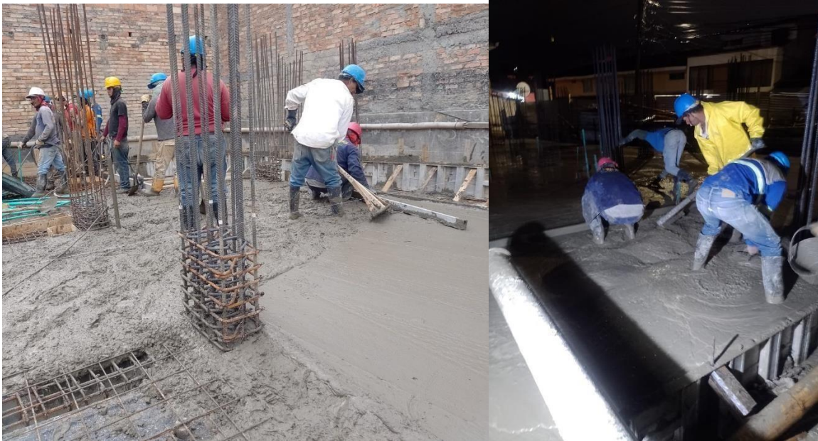
Ilustración 87 Vertimiento de concreto para losa piso 1
