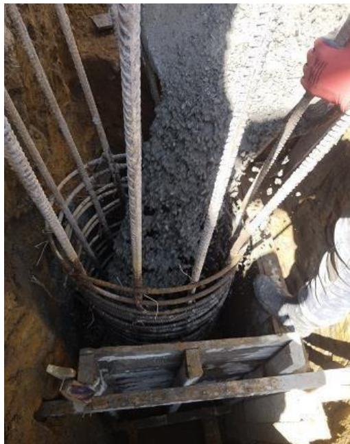
Ilustración 45 Vaciado de concreto premezclado en pilotes por debajo del nivel de cimentación
