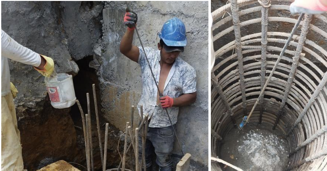
Ilustración 44 Colocación de sikadur 32 sobre pilotes
