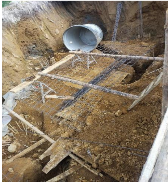
Ilustración 35 Armado de parrillas de acero de sistema de contención
