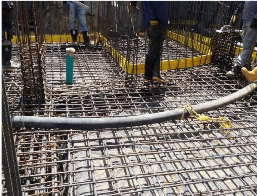
Ilustración 70 Cinta SIKA PVC donde se situará el tanque de agua potable
