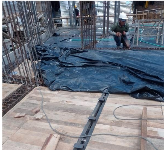
Ilustración 85 Colocación de plástico
