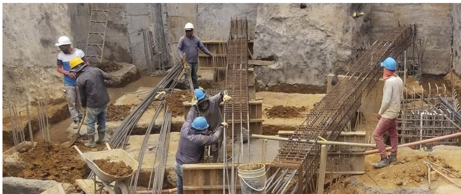
Ilustración 59 Armado de elementos de acero vigas cimentación
