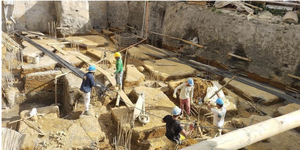
Ilustración 58 Colocación de varillas de acero en los ejes correspondientes de la cimentación
