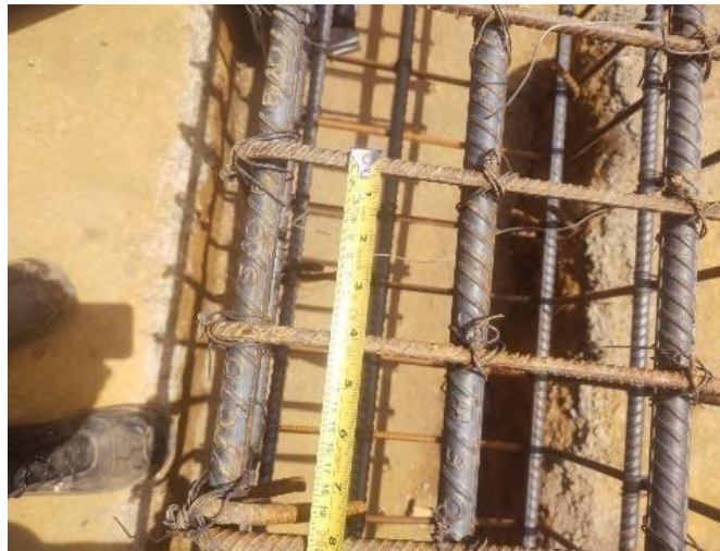
Ilustración 93 Revisión separación de estribos en vigas de cimentación
