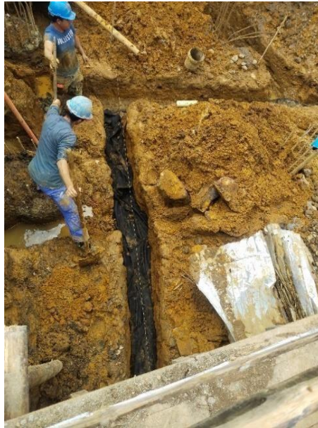
Ilustración 28 Filtros de drenaje con geotextil no tejido NTC 1600
