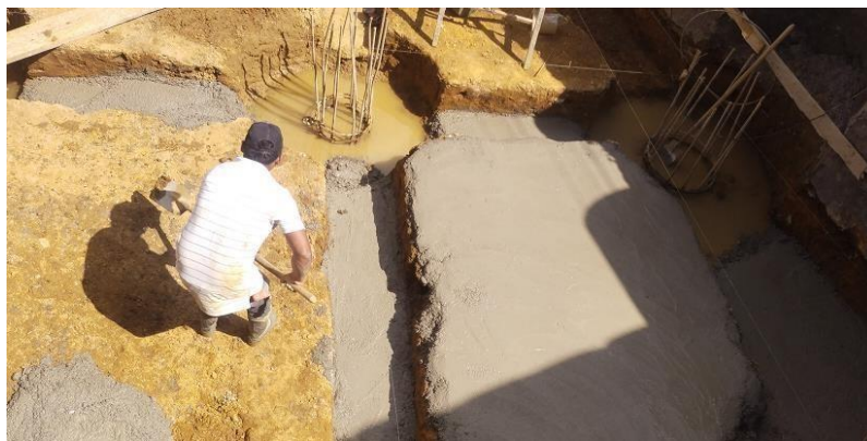
Ilustración 57 Colocación de solado de limpieza en cimentación superficial
