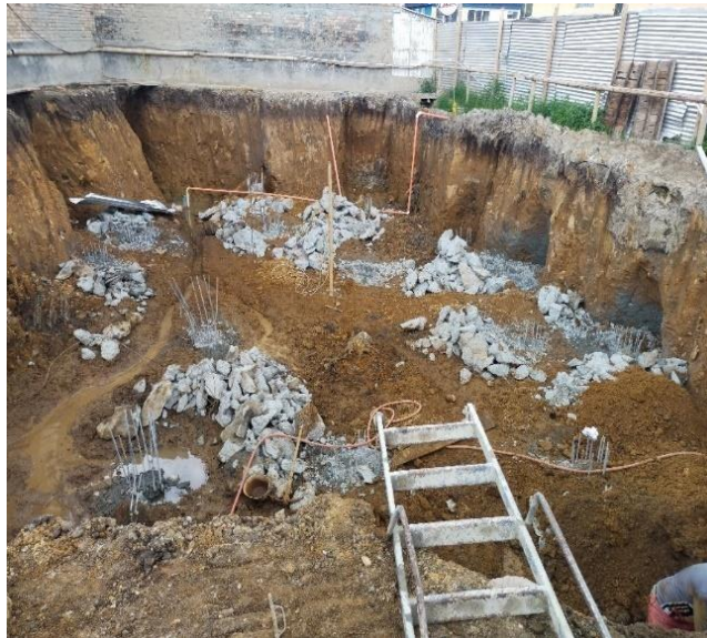
Ilustración 23 Vista general de pilotes descabezados
