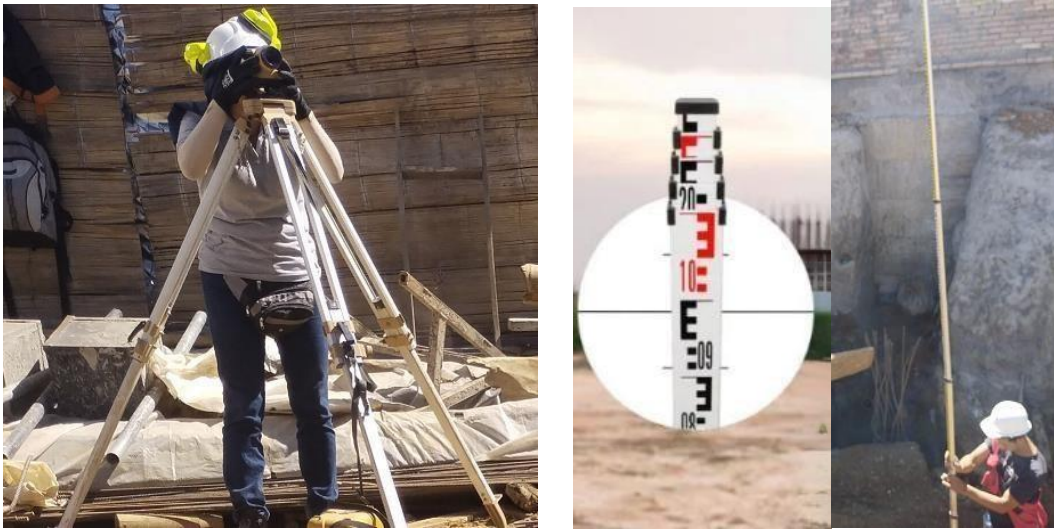
Ilustración 33 Toma de niveles con teodolito y mira topográfica
