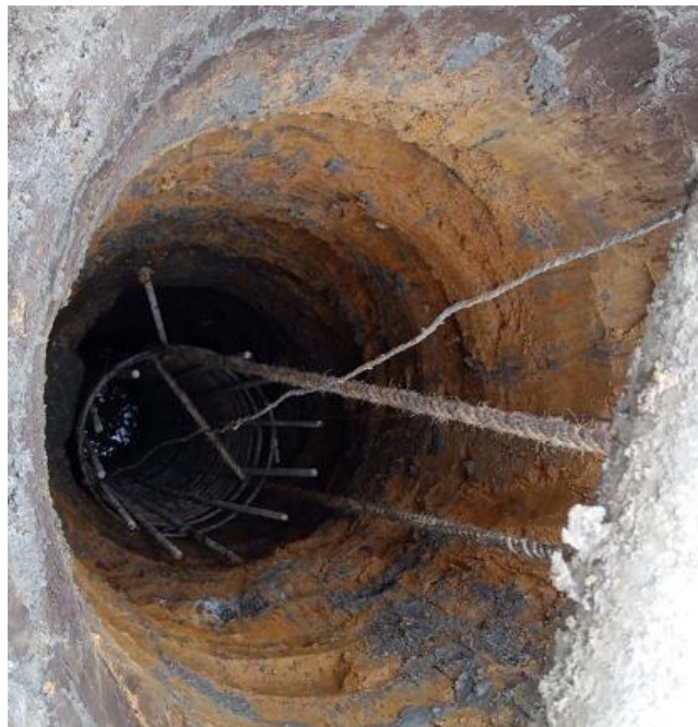
Ilustración 16 Proceso colocación de acero de pilotes
