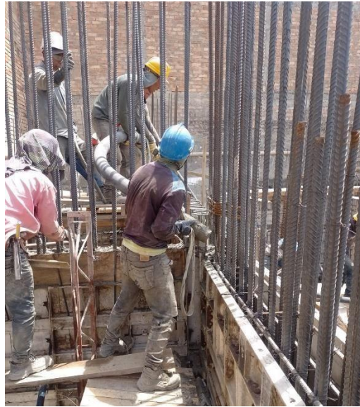
Ilustración 78 Vertimiento de concreto en muros y columnas de primer piso
