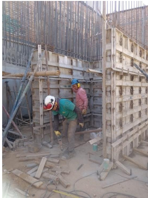
Ilustración 77 Formaletas muros de ascensor
