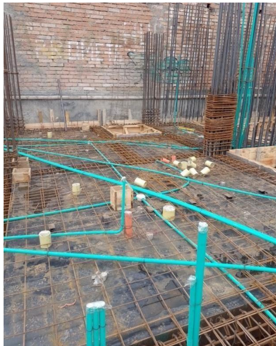
Ilustración 86 Instalación eléctrica de losa piso 1
