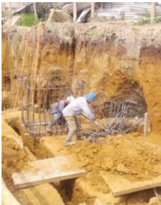
Ilustración 30 Armado refuerzo de acero caja pluvial
