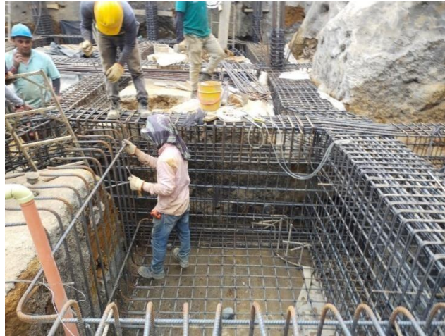
Ilustración 50 Armado de muros ubicados alrededor foso del ascensor
