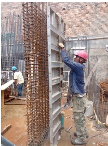
Ilustración 75 Proceso de formaleteo en columna
