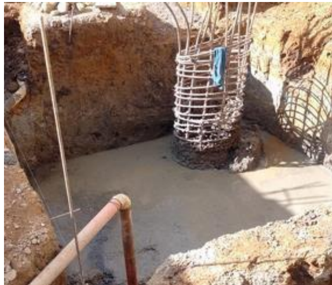
Ilustración 49 Solado de limpieza sobre el foso del ascensor
