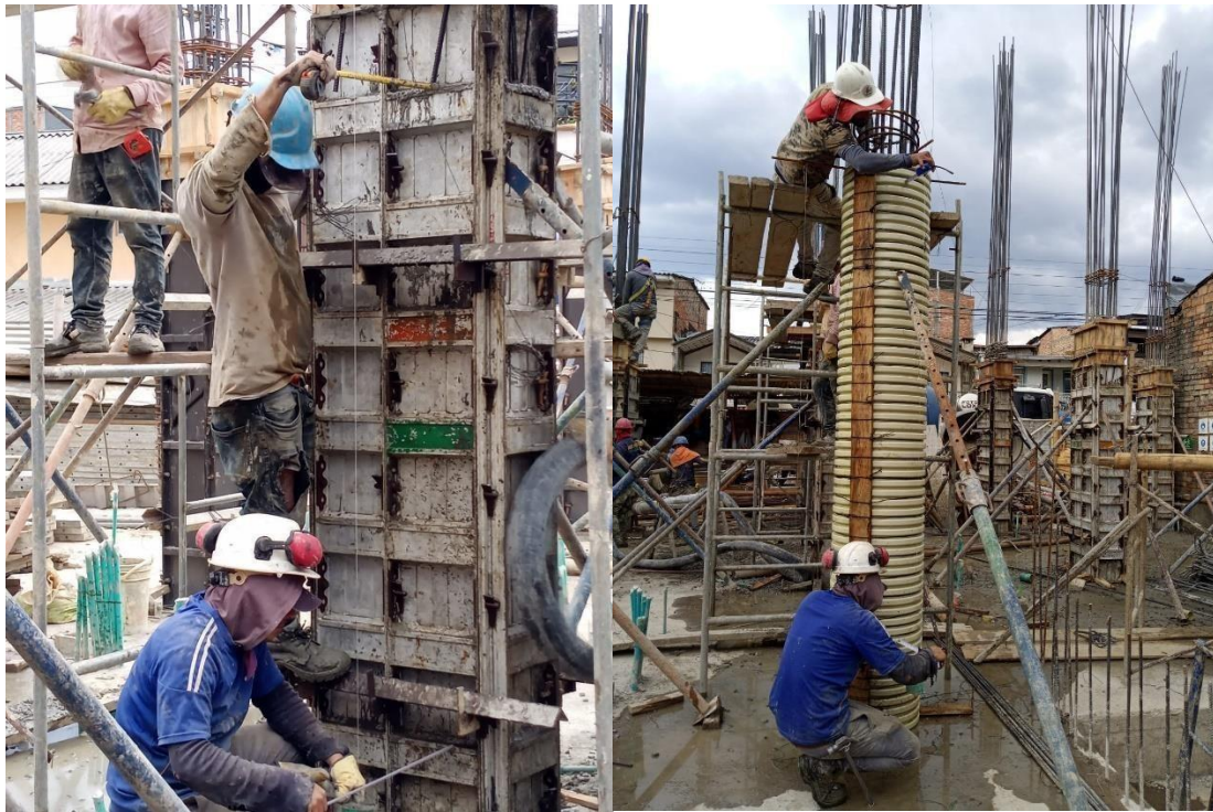
Ilustración 89 Toma de plomo de columnas piso 1
