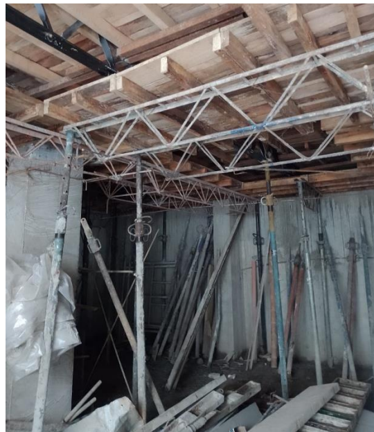
Ilustración 84 Vista de viga joist instalada
