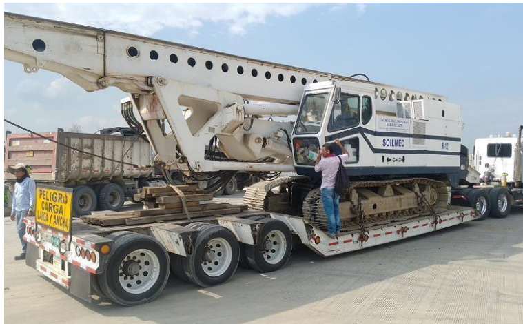
Ilustración 12 Máquina de perforación para pilotes
