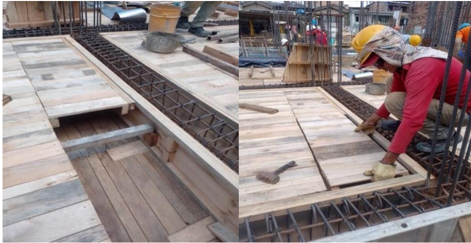
Ilustración 83 Instalación de tabloncillos para sistema de entrepiso con viga joist
