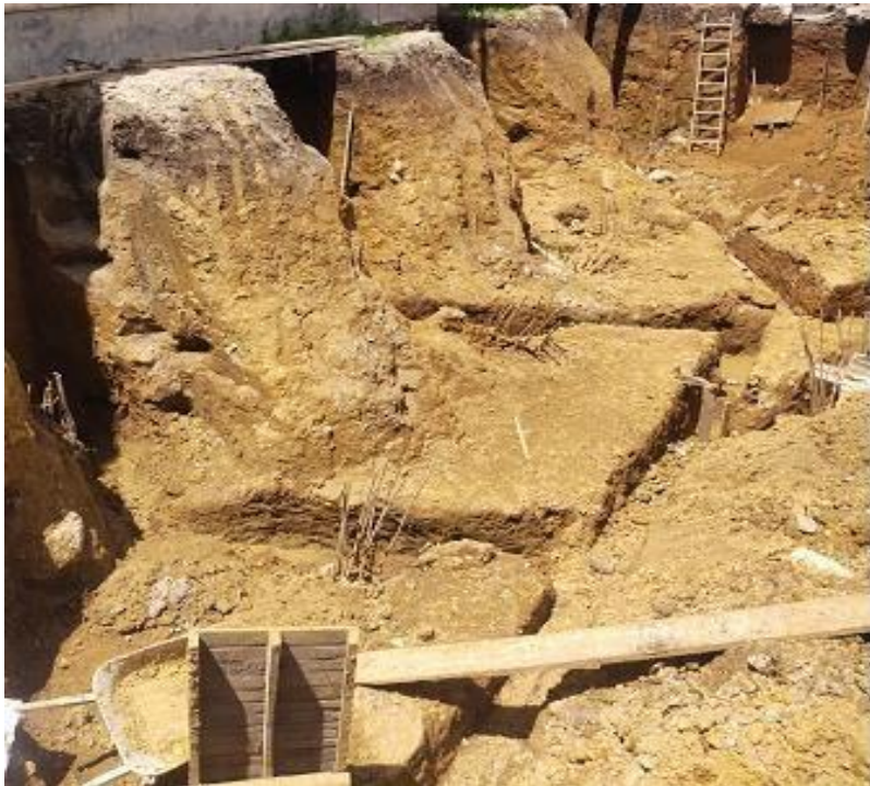
Ilustración 29 Terreno después de colocación del sistema de subdrenaje
