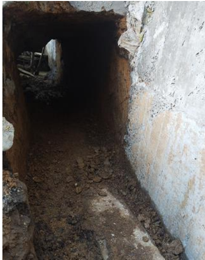
Ilustración 56 Excavación cimentación eje 1 por detrás de los bataches
