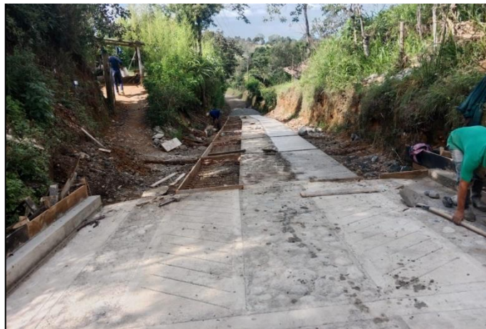
Ilustración 24. Continuación tramo 2 vereda Sachacoco
