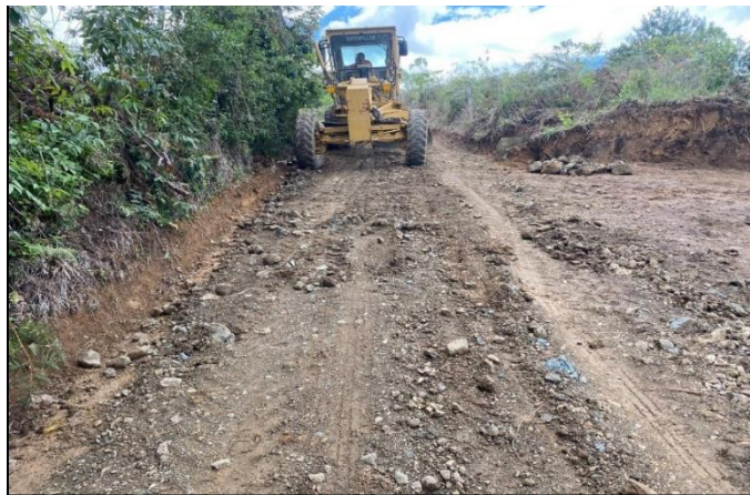
Ilustración 56. Nivelación y regado de material granular
