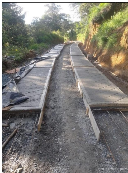
Ilustración 68. Fundición Placa huella El Crucero
