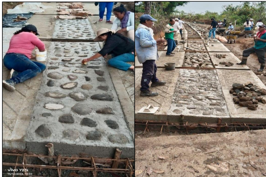
Ilustración 53. Concreto ciclópeo vereda Poblaceña
