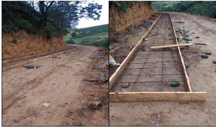
Ilustración 33. Armado de acero placas de concreto El Líbano
