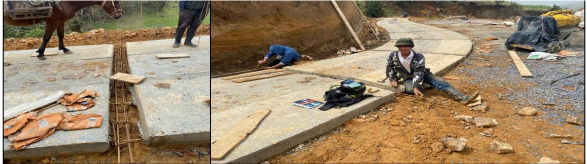
Ilustración 38. Armado de vigas riostras vereda El Líbano
