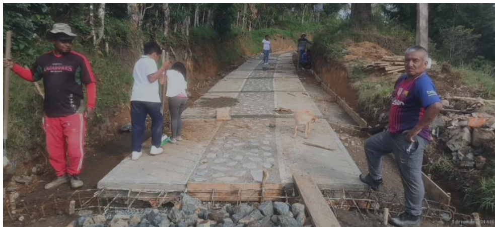
Ilustración 70. Concreto ciclópeo vereda El Crucero
