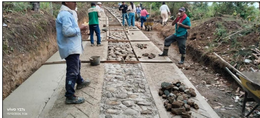
Ilustración 52. Concreto ciclópeo vereda Poblaceña
