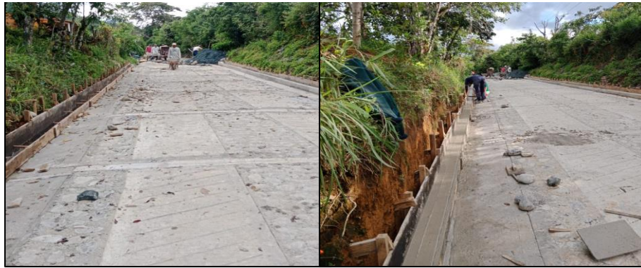
Ilustración 23. Vigas riostras y bordillos
