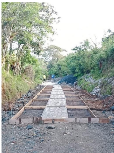
Ilustración 17. Formaleta placas de concreto vereda Sachacoco tramo 1.
