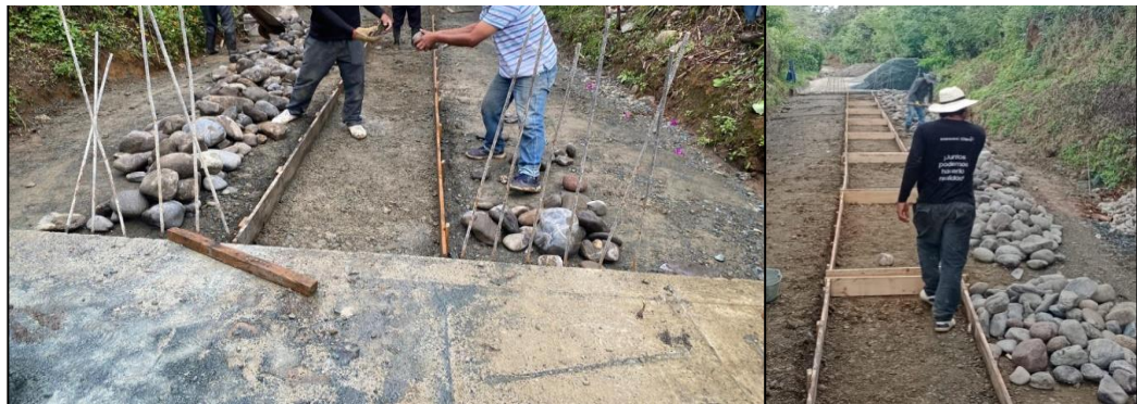
Ilustración 13. Instalación formaleta de ciclópeo central - placa huella vereda Sachacoco
