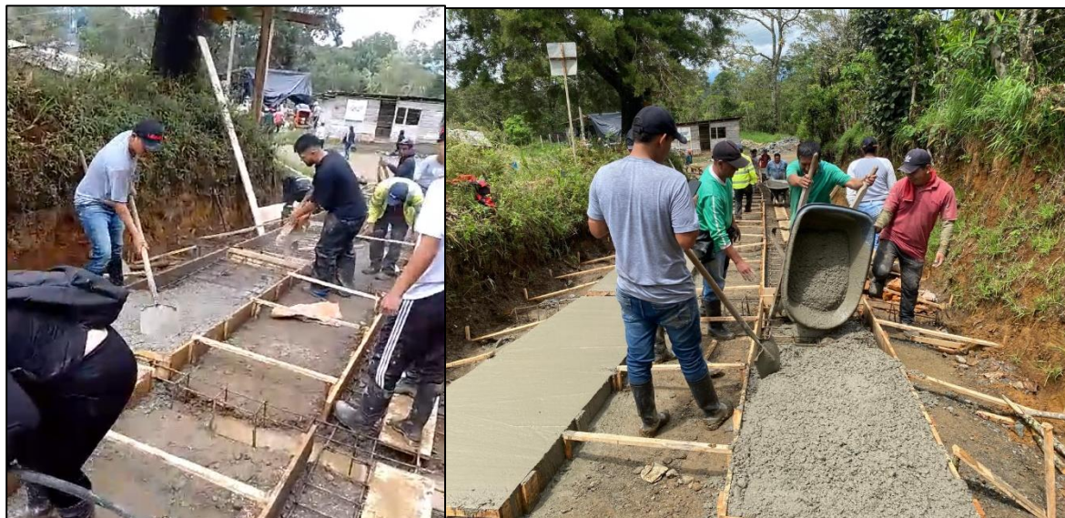
Ilustración 67. Fundición placas de concreto (placa huellas)
