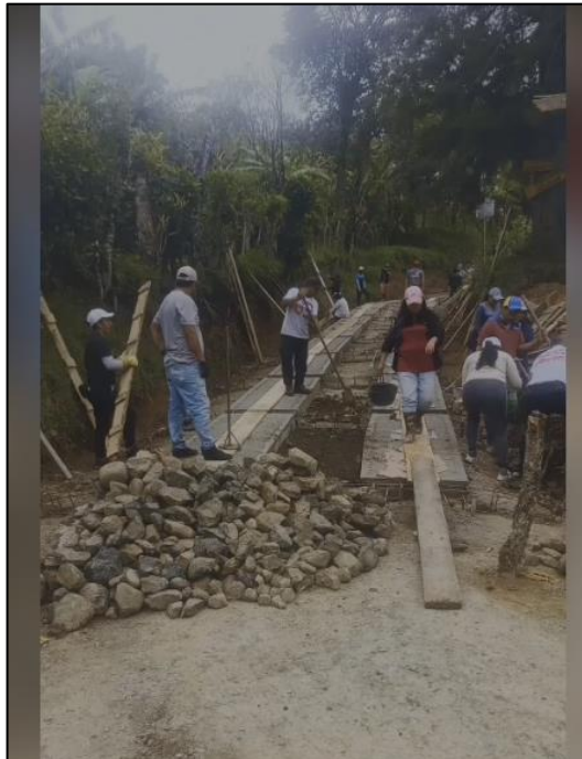
Ilustración 69. Concreto ciclópeo vereda El Crucero
