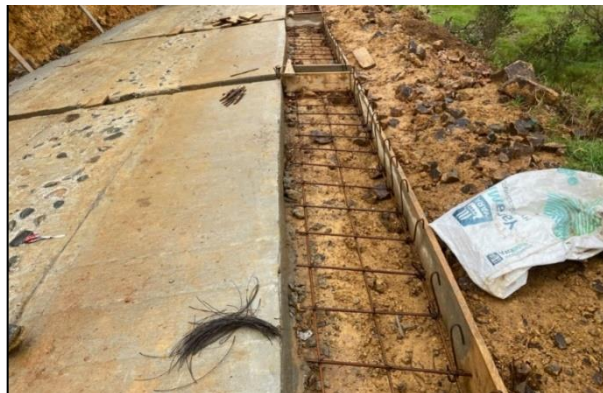
Ilustración 39. Cunetas y bordillos vereda El Líbano
