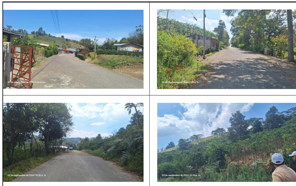
Ilustración 93. Visita preliminar vereda El Nuevo Boquerón
