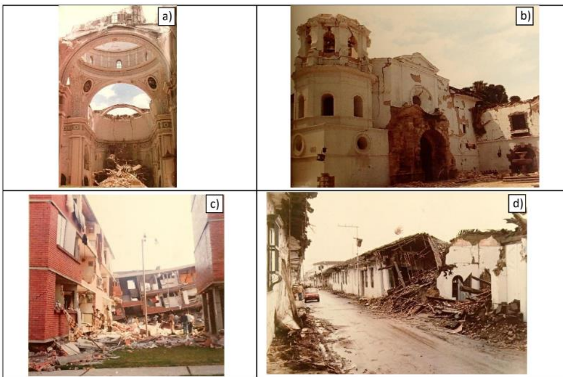
Figura 3. Fotografías de edificaciones afectadas en Popayán por el sismo de 1983.
