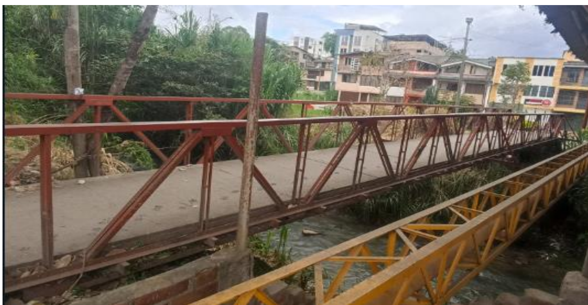
Figura 9. Puente peatonal simplemente apoyado.
