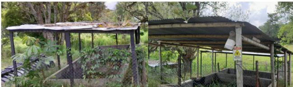
Ilustración 6. Infraestructura existente de cubierta y columnas, Sena Alto Cauca
