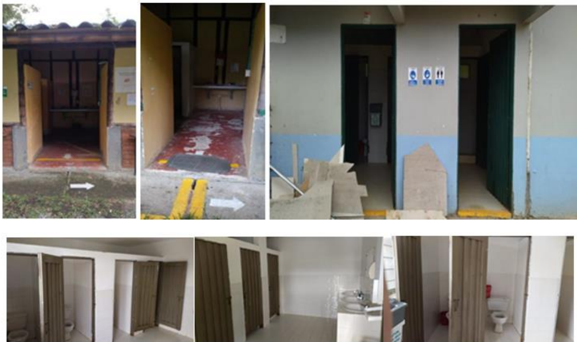
Ilustración 36. Registro fotográfico de accesibilidad a baños
