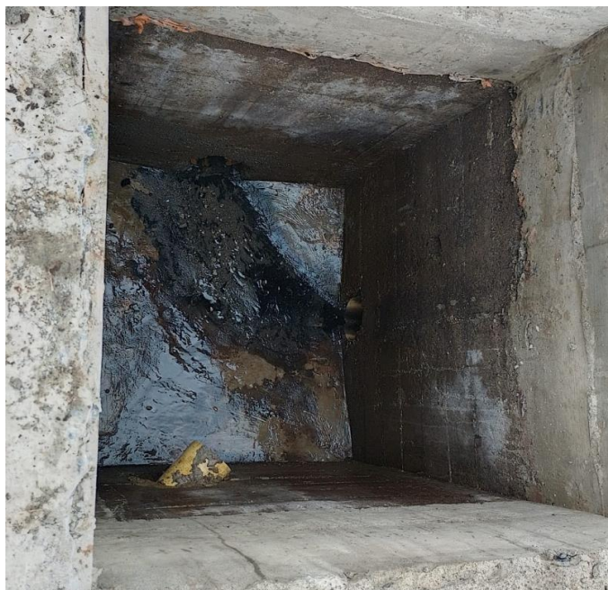
Ilustración 24. Mantenimiento a caja de alcantarillado
