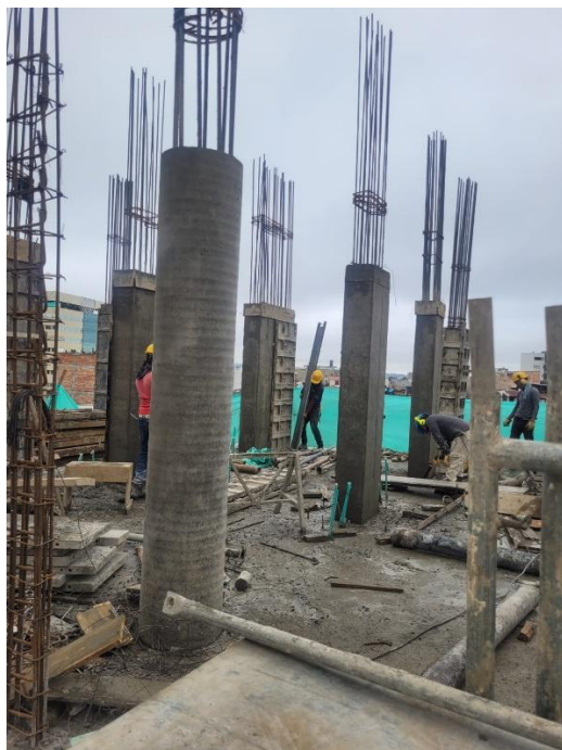
Ilustración 94. Desencofrado de columnas.
