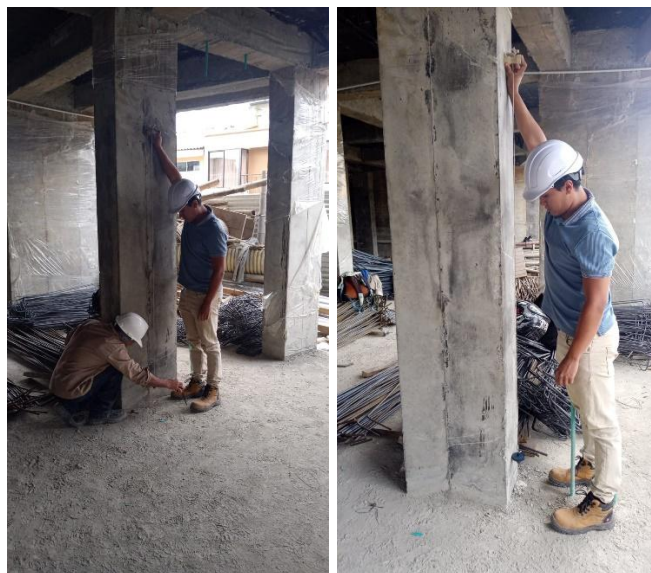
Ilustración 49. Toma de plomos en campo.
