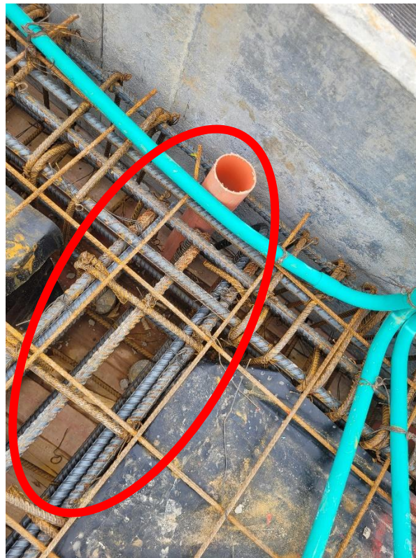
Ilustración 55. Recomendación de refuerzo en anclaje.
