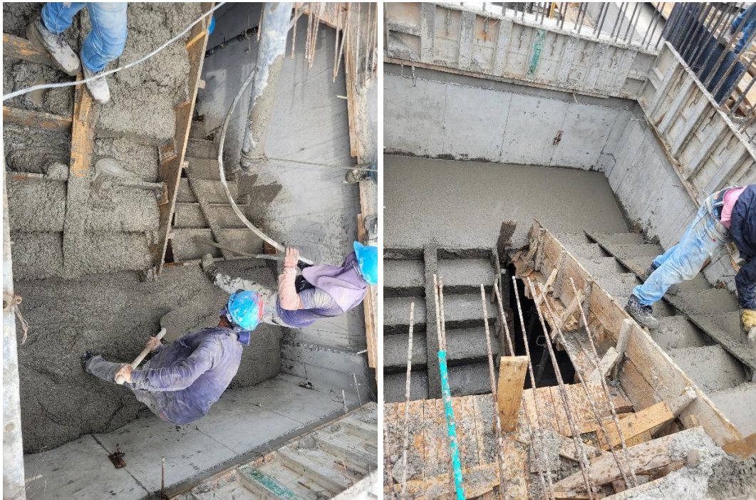
Ilustración 88. Vaciado y vibrado de concreto en gradas.
