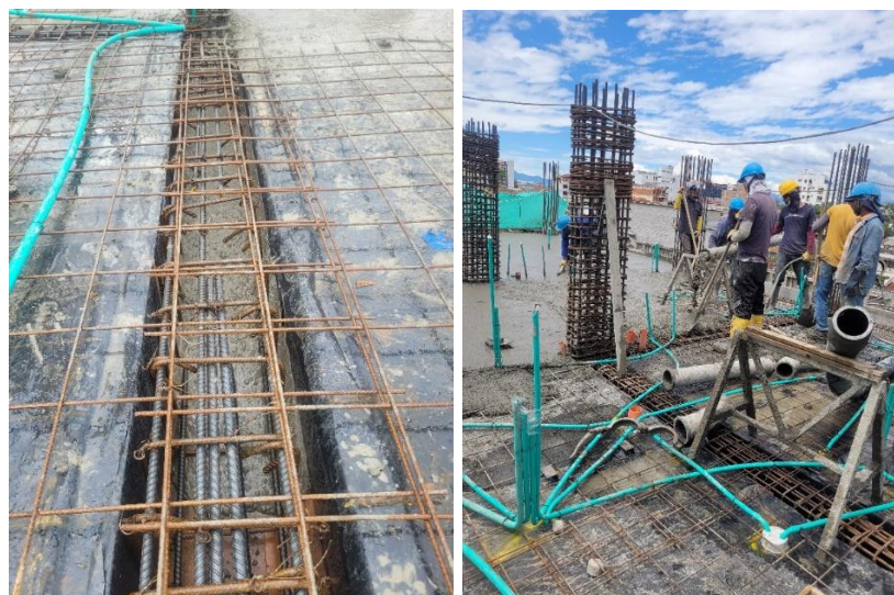
Ilustración 86. Vaciado y vibrado de concreto en vigas y losa.
