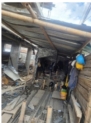
Ilustración 16. Campamento de obra.
