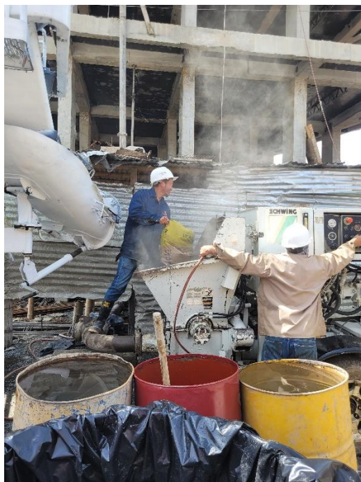
Ilustración 82. Preparación de la ceba agua-cemento previo a la fundición.
