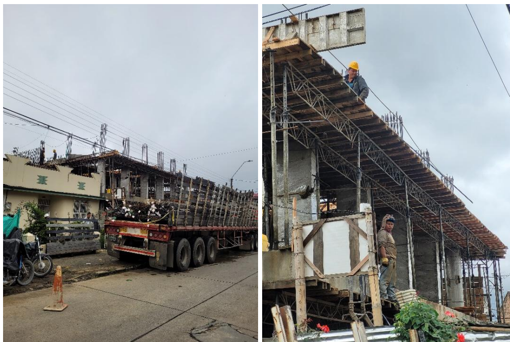
Fuente: Registro fotográfico de obra, tomada por el autor.
