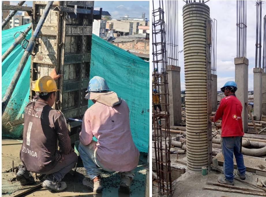
Ilustración 91. Toma de plomos después del vaciado del concreto.
