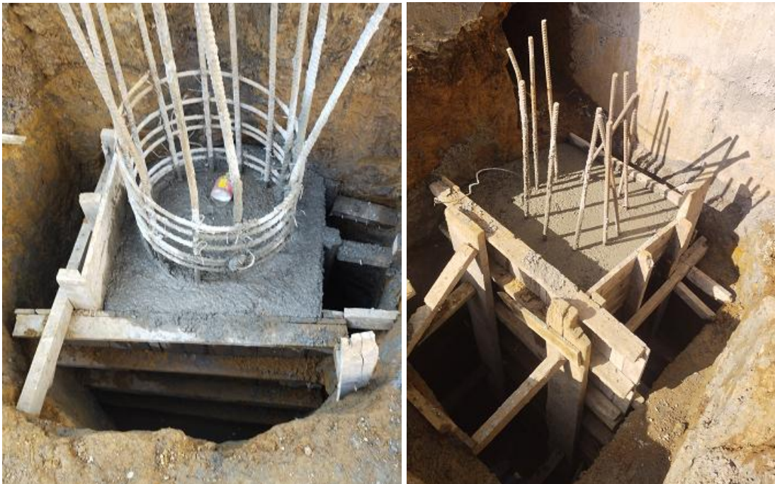
Ilustración 7. Pilotes a nivel de la cimentación.
