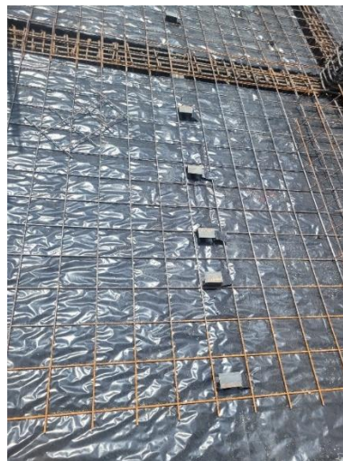
Ilustración 68. Instalación de malla electrosoldada para losa de entrepiso.
