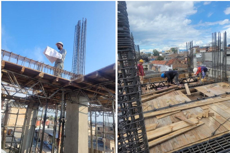
Ilustración 70. Entablerado de losa según los planos.
