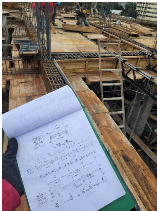
Ilustración 56. Supervisión de aceros en obra.
