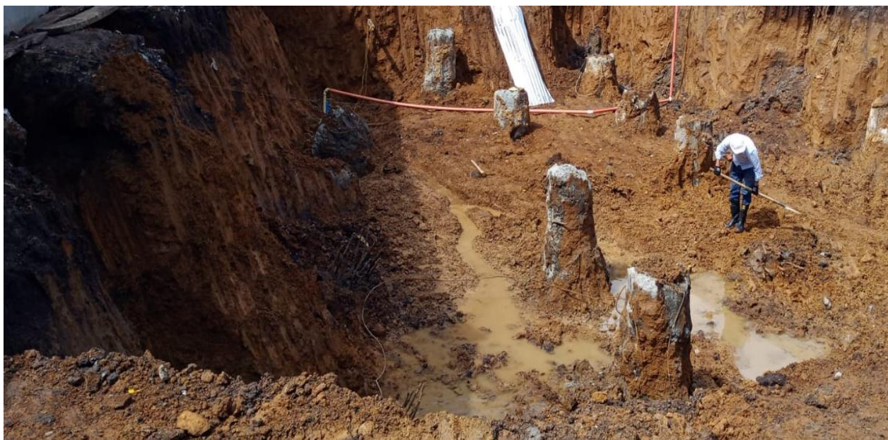
Ilustración 5. Pilotes y excavación del sótano.
