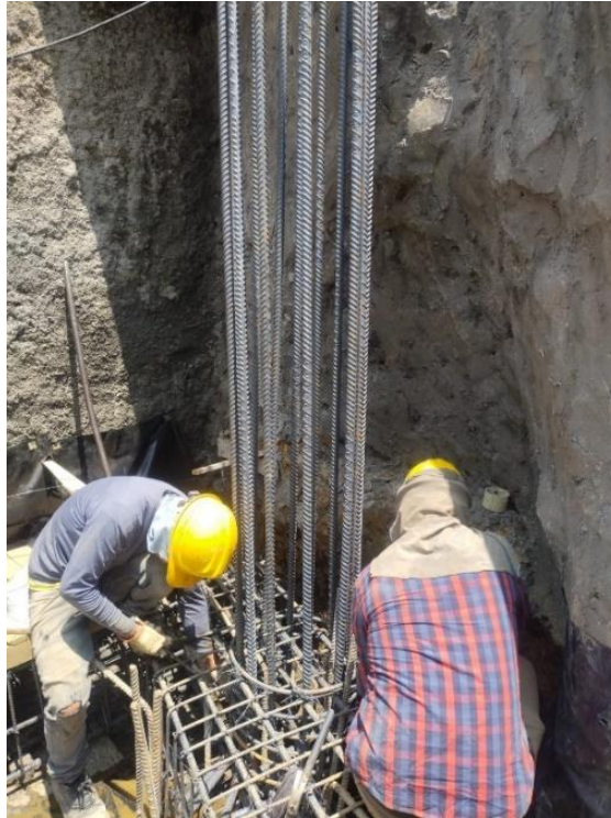
Ilustración 10. Armado de arranque columna C1.
