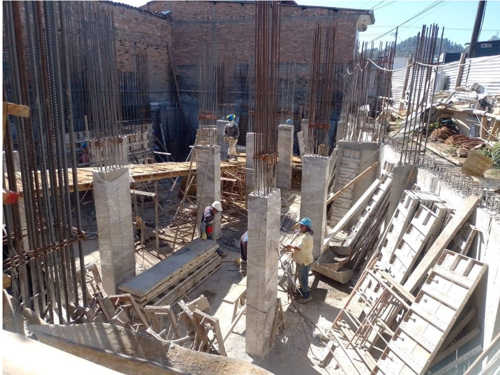
Ilustración 12. Columnas y muros del sótano.
