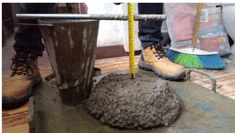
Ilustración 36. Toma de medida del asentamiento del concreto en obra.
