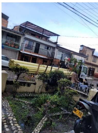
Ilustración 27. Recepción de pedido de tubería.
