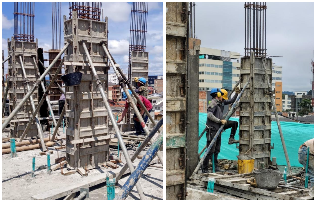
Ilustración 78. Apuntalamiento de columnas encofradas.
