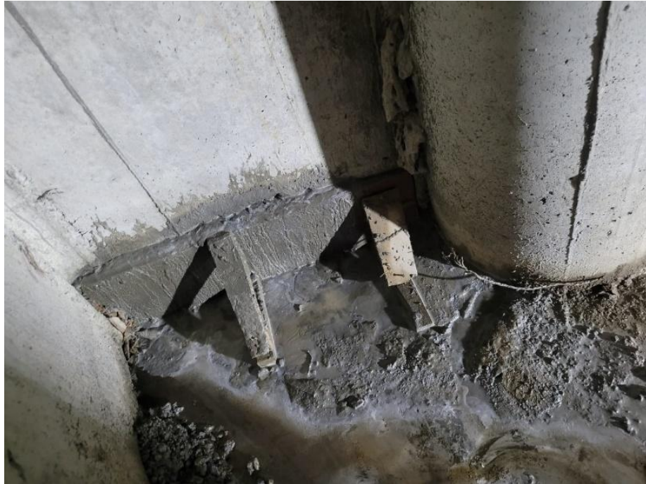
Ilustración 123. Reparación en uno de los muros con mezcla de concreto más aditivo.
