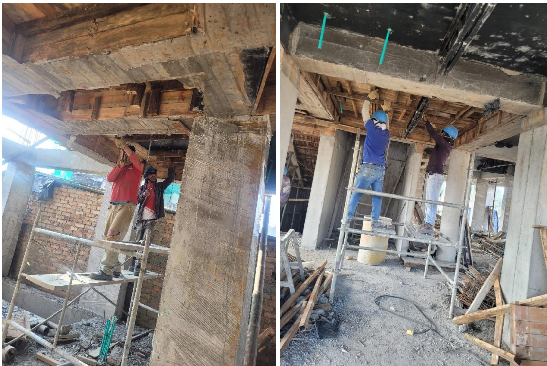
Ilustración 92. Desencofrado de losa y vigas.
