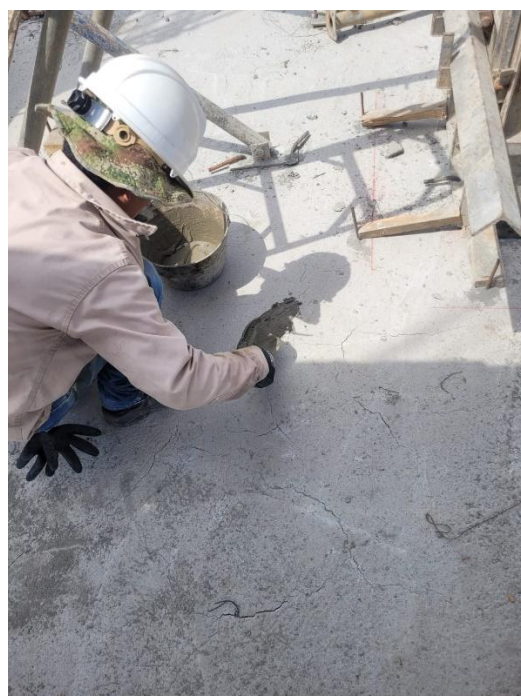
Ilustración 99. Resane con lechada de cemento en fisuras de la losa.
