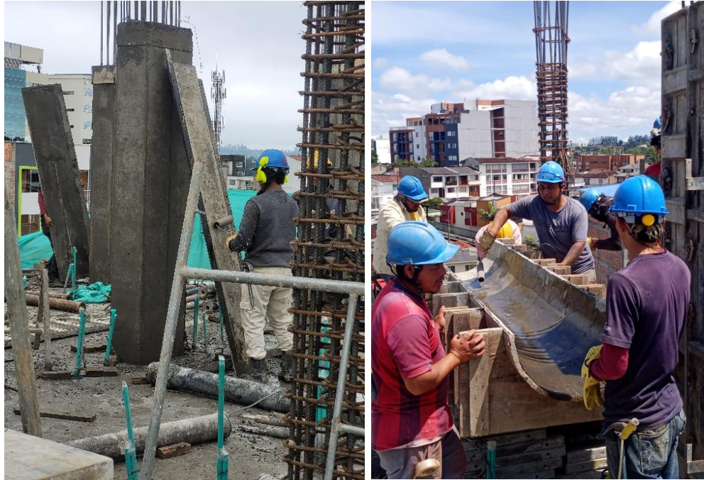
Ilustración 75. Aplicación del desmoldante en las formaletas.
