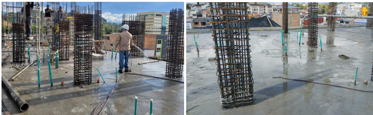
Ilustración 93. Curado de la losa.
