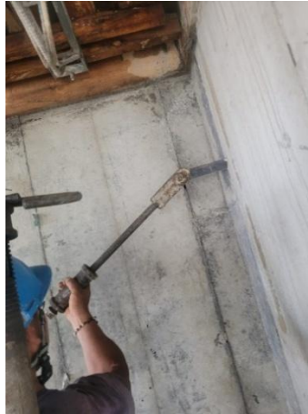
Ilustración 96. Retiro de "corbatas" en los muros.
