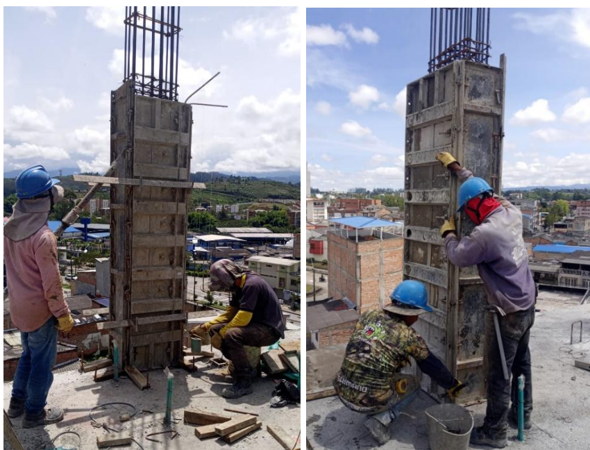
Fuente: Registro fotográfico de obra, tomada por el autor.
