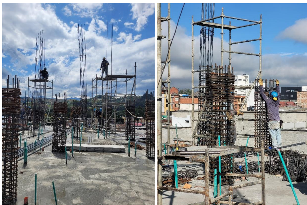
Ilustración 57. Supervisión del armado de columnas.
