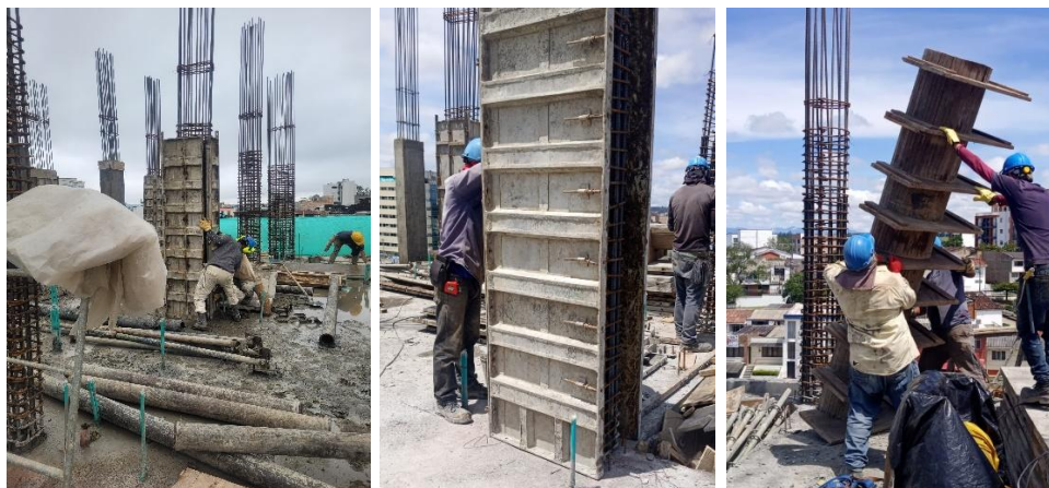
Ilustración 76. Encofrado de columnas.
