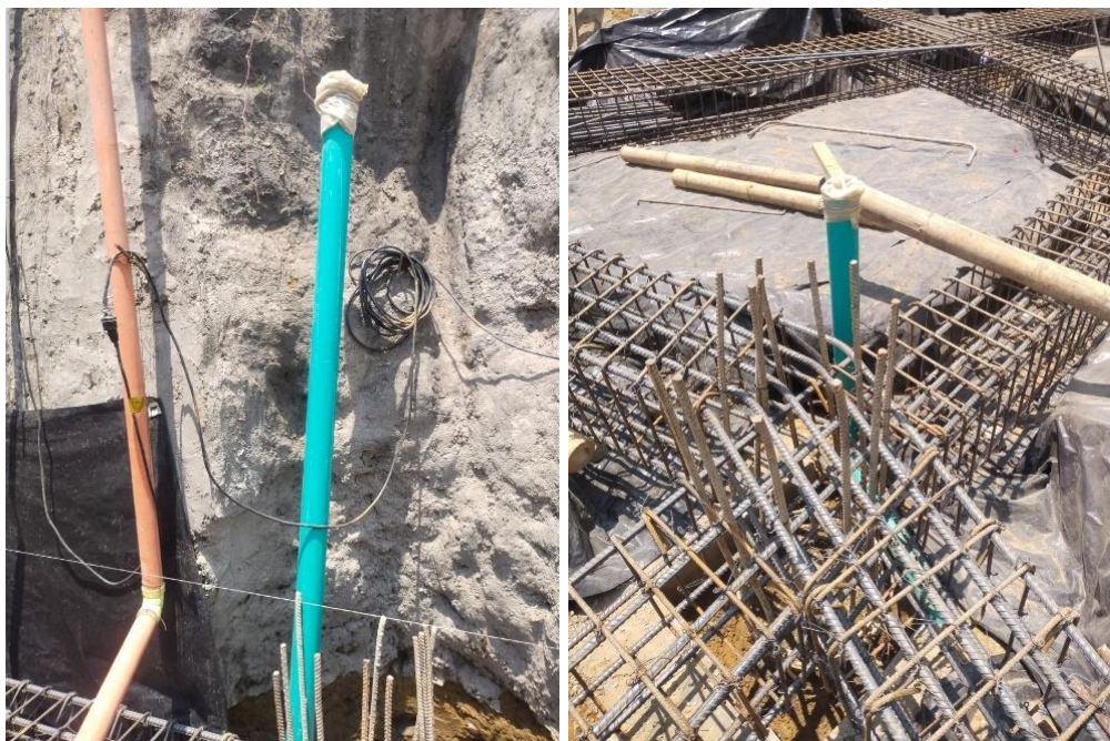
Ilustración 9. Instalación de tuberías pluviales y eléctricas.
