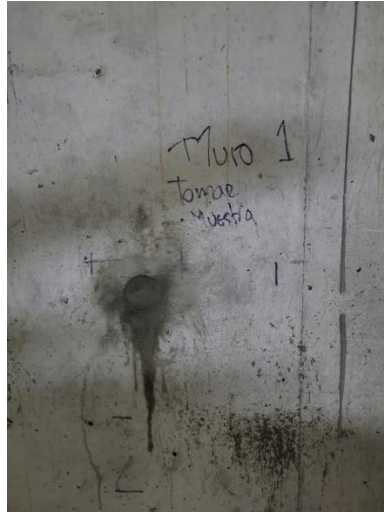
Ilustración 120. Relleno de perforaciones.
