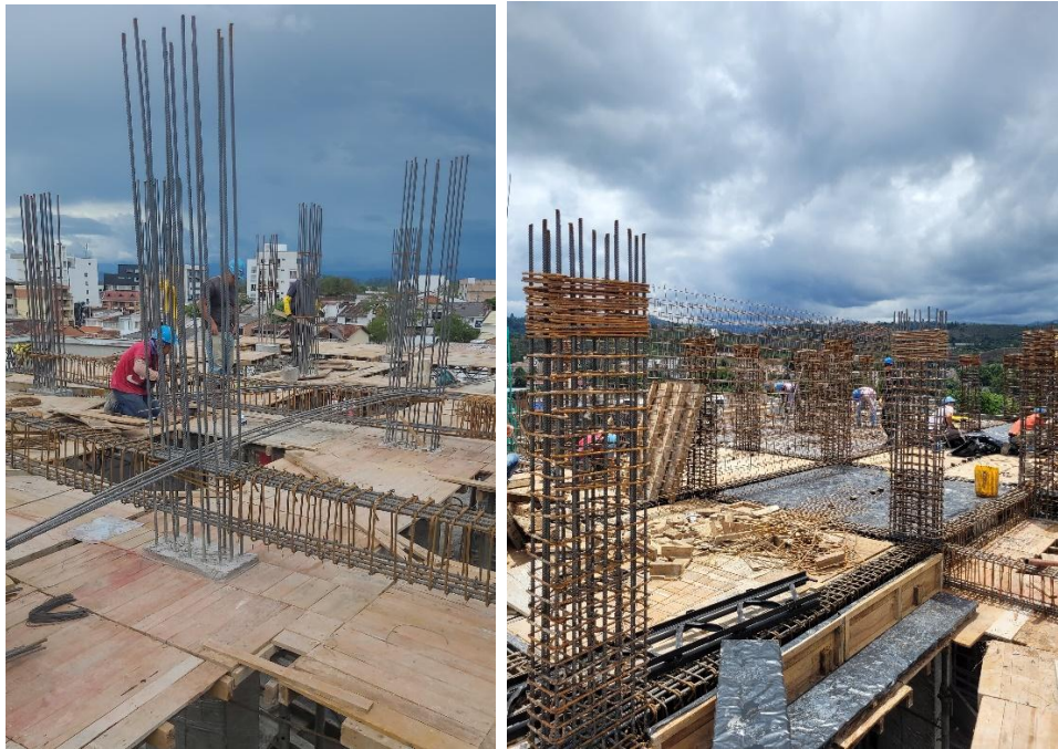
Fuente: Registro fotográfico de obra, tomada por el autor.
