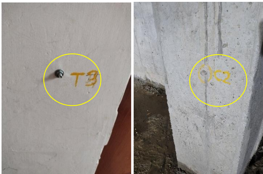
Ilustración 100. Tornillos en el punto de referencia para medir asentamientos.
