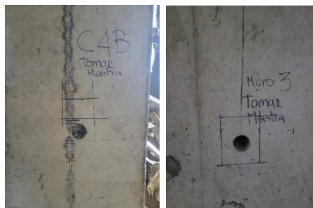
Ilustración 119. Puntos específicos de toma de núcleos.
