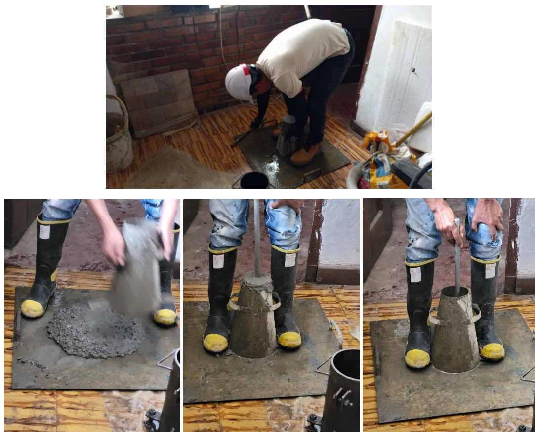
Ilustración 34. Prueba del Slump en obra.
