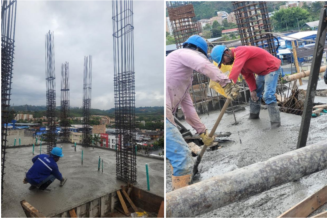
Ilustración 87. Nivelación del concreto.
