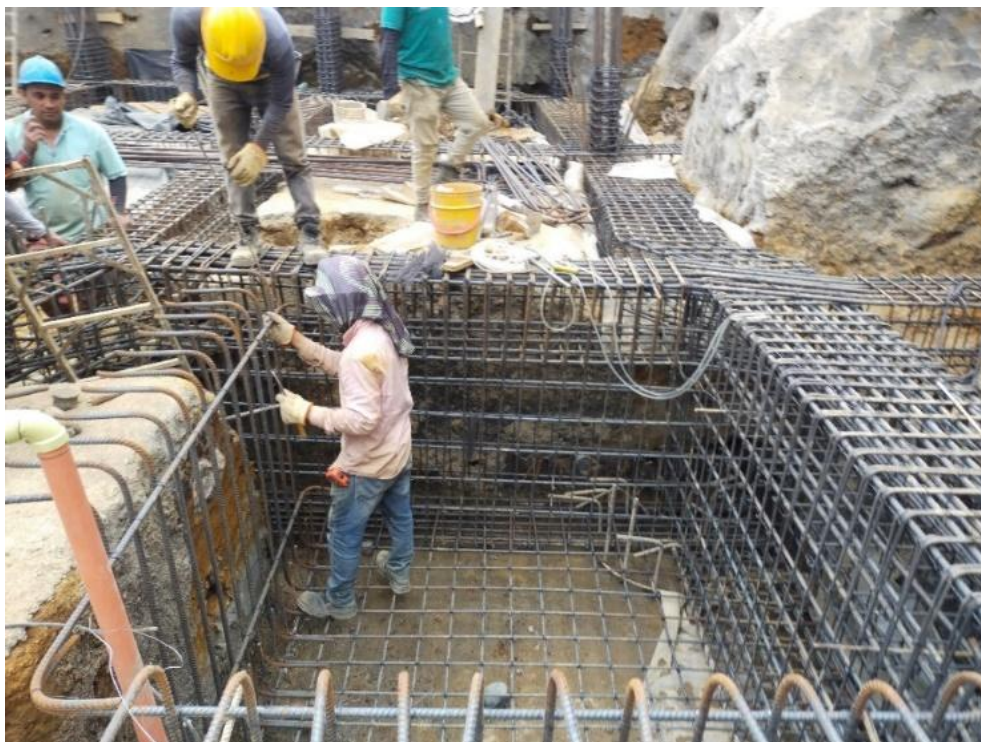
Ilustración 8. Armado inicial de acero.
