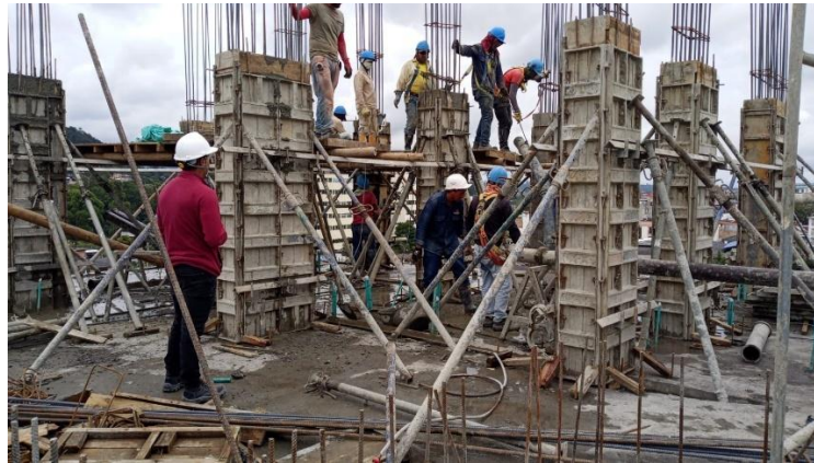
Ilustración 85. Comando y dirección de fundiciones.
