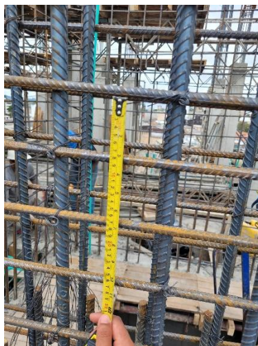
Se realizó un cambio en la separación de las varillas horizontales sugerido por el diseñador, debido a que se cambió el diámetro de #5 a #4.
