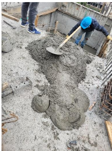
Ilustración 107. Concreto sobrante de fundición.
