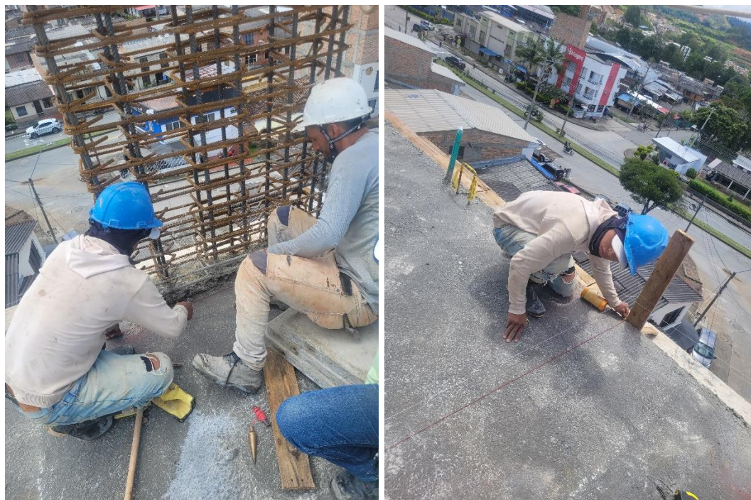
Ilustración 73. Replanteo de columnas mediante hilo entizado.
