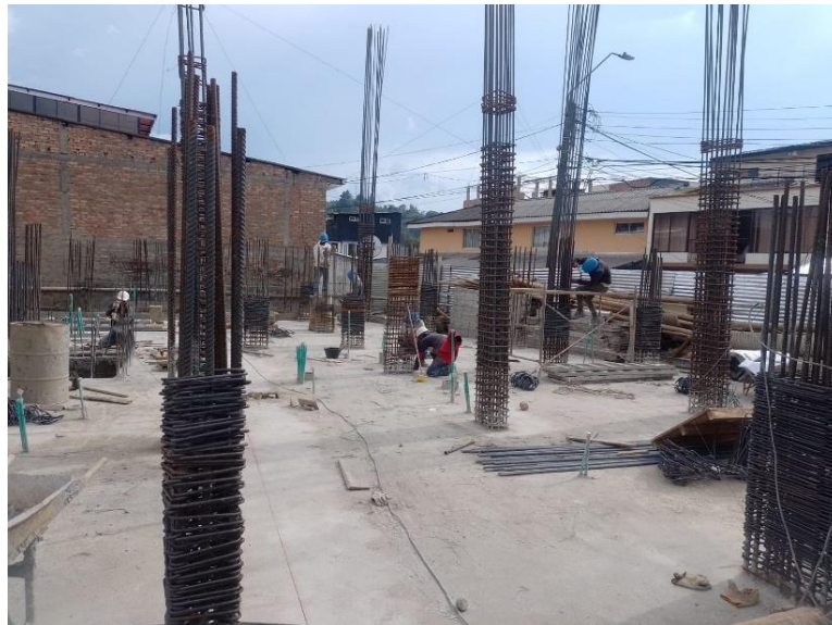
Ilustración 13. Losa y columnas de primer piso.
