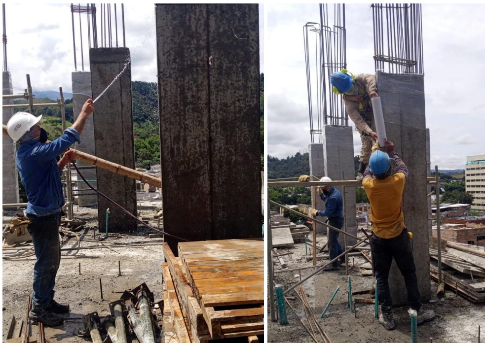
Ilustración 95. Hidratación y curado de columnas.
