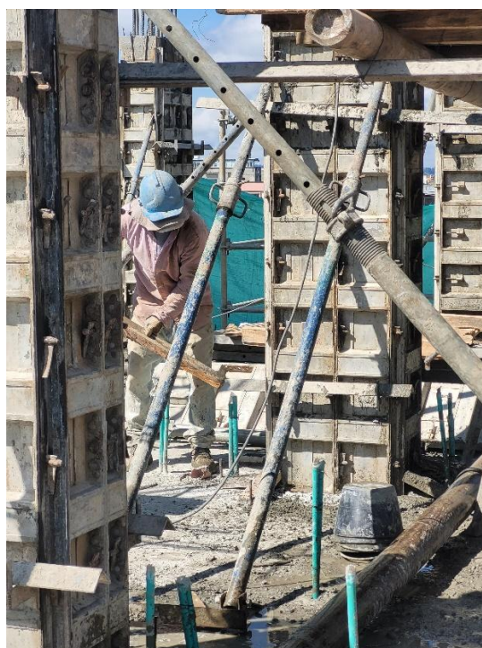
Ilustración 90. Chipoteo de columnas durante la fundición.
