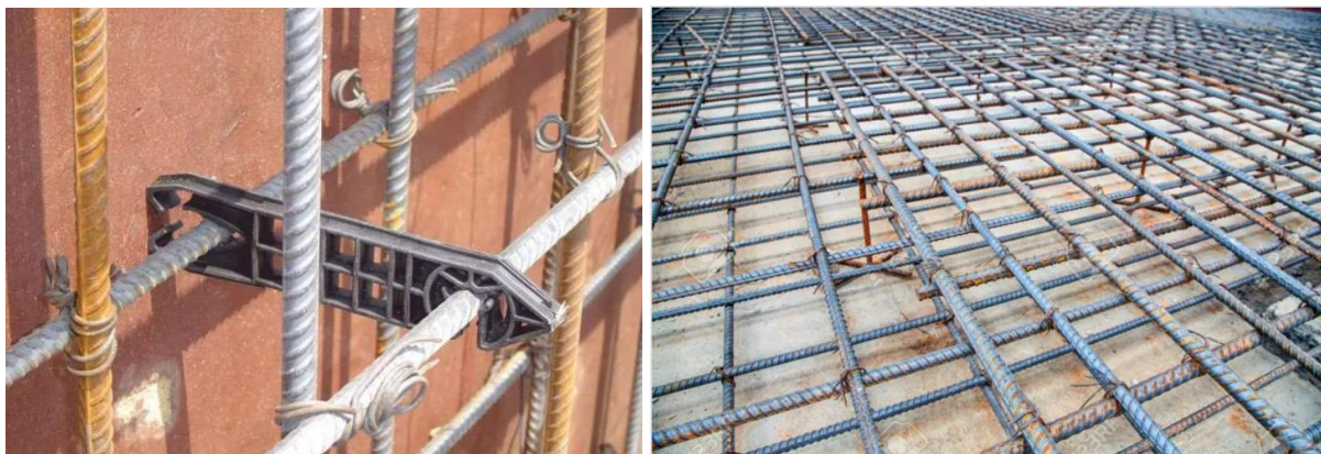
Ilustración 81. Distanciadores para garantizar recubrimiento.
