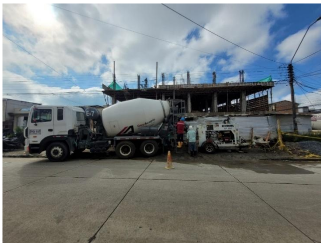
Fuente: Registro fotográfico de obra, tomada por el autor.
