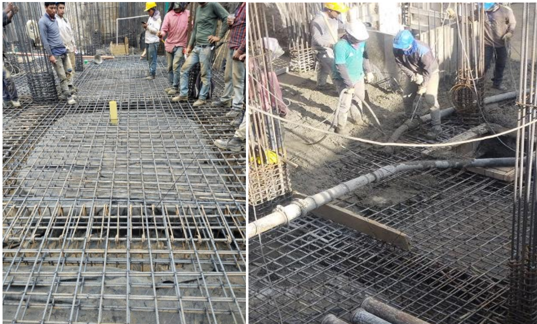
Ilustración 11. Acero y fundición de la losa de cimentación.
