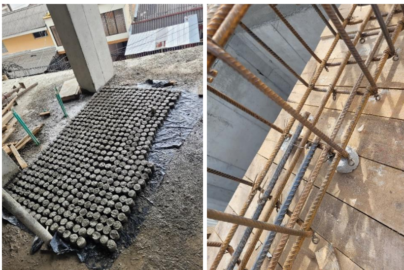
Ilustración 80. Paneles para separación del acero con los tableros.
