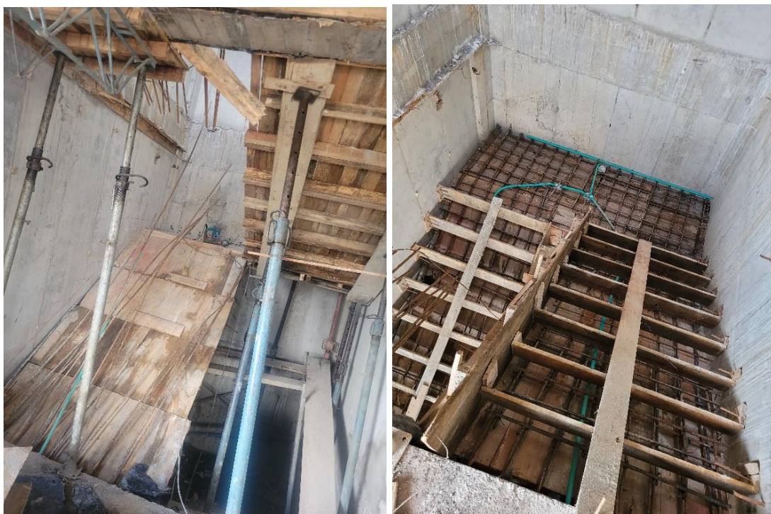
Ilustración 72. Armado de las gradas.
