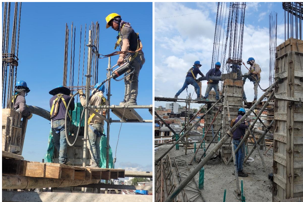
Ilustración 89. Vaciado y vibrado de concreto en columnas.
