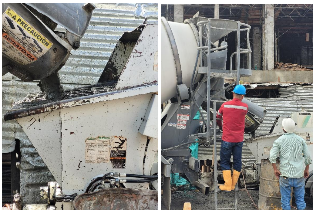
Ilustración 83. Vaciado de concreto en la bomba.
