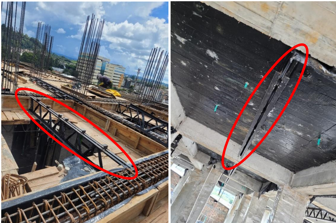
Ilustración 65. Instalación de vigas Joist.
