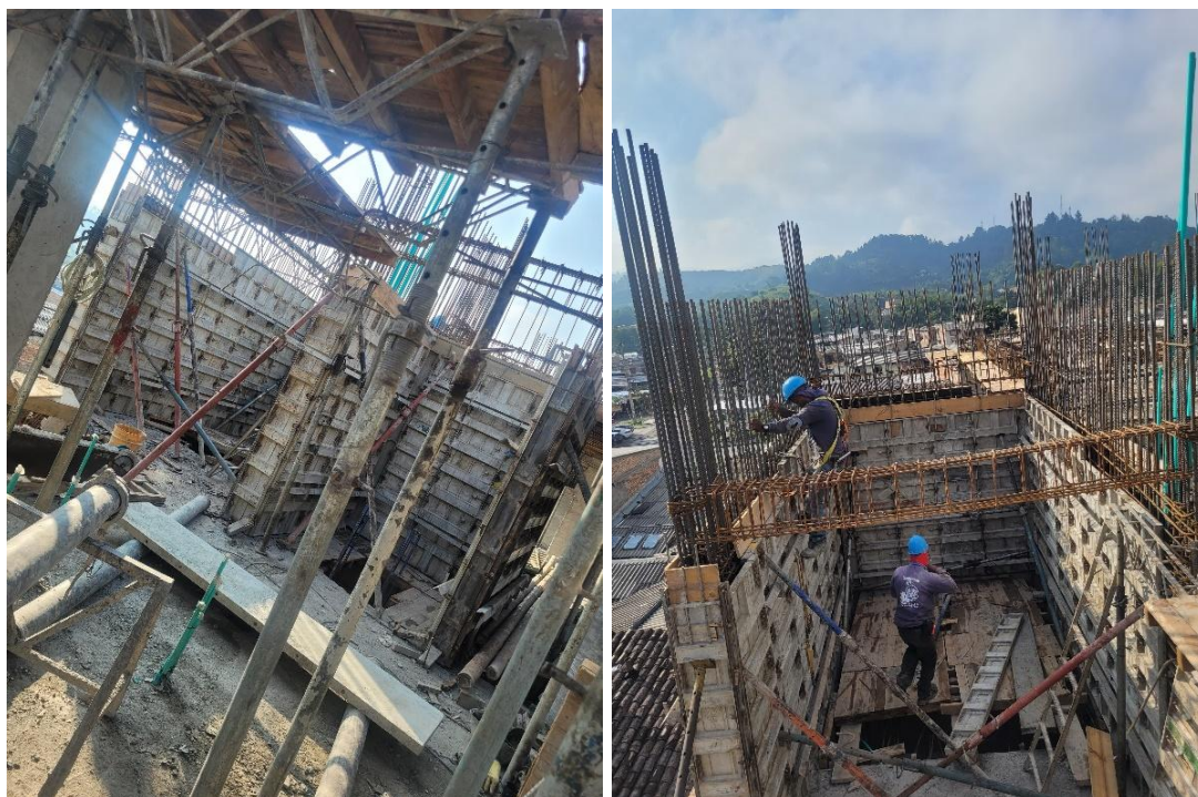
Ilustración 79. Encofrado del punto fijo (muros de ascensor y escaleras).
