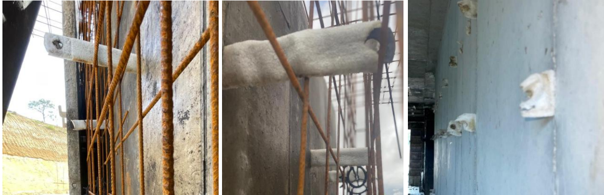
Ilustración 11. Corbatas utilizadas en formaletas (izquierda y centro), y orificio residual tras su retiro (derecha) Fuente: Propia
