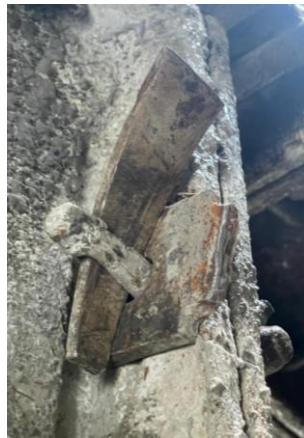
Ilustración 42. Trabajo en conjunto pasador y cuña. Fuente: Propia
