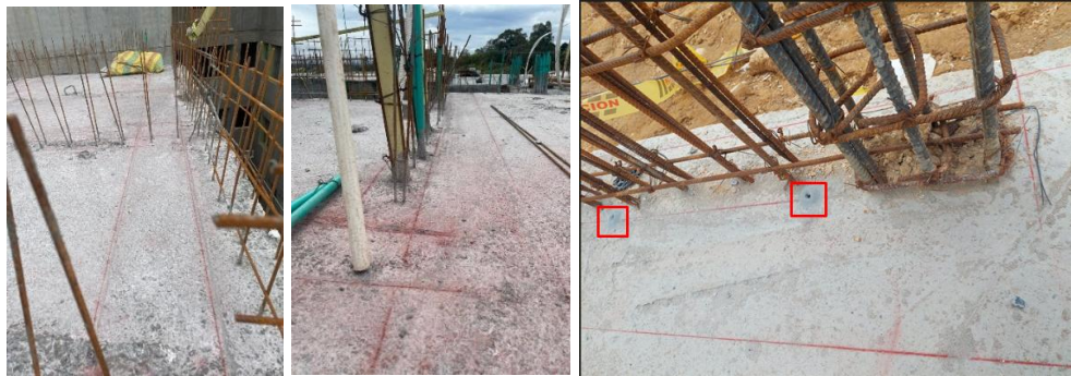
Ilustración 38. Colocación de simbra Fuente: Propia
