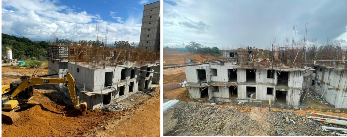
Ilustración 7. Avance de obra – Torre C desde diferentes ángulos Fuente: Propia
