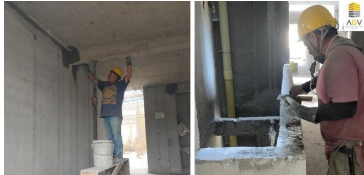
Ilustración 9. Resanador realizando labores de reparación
