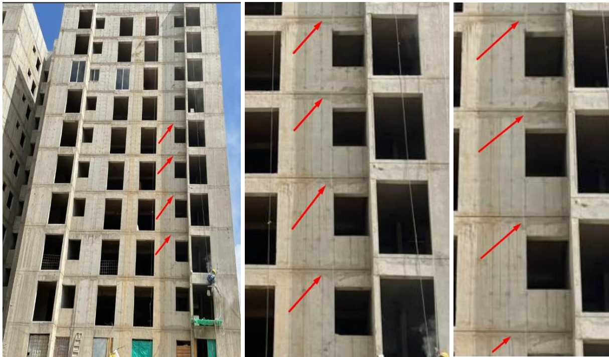
Ilustración 12. Ejecución de dilataciones exteriores para prevenir agrietamientos Fuente: Propia
