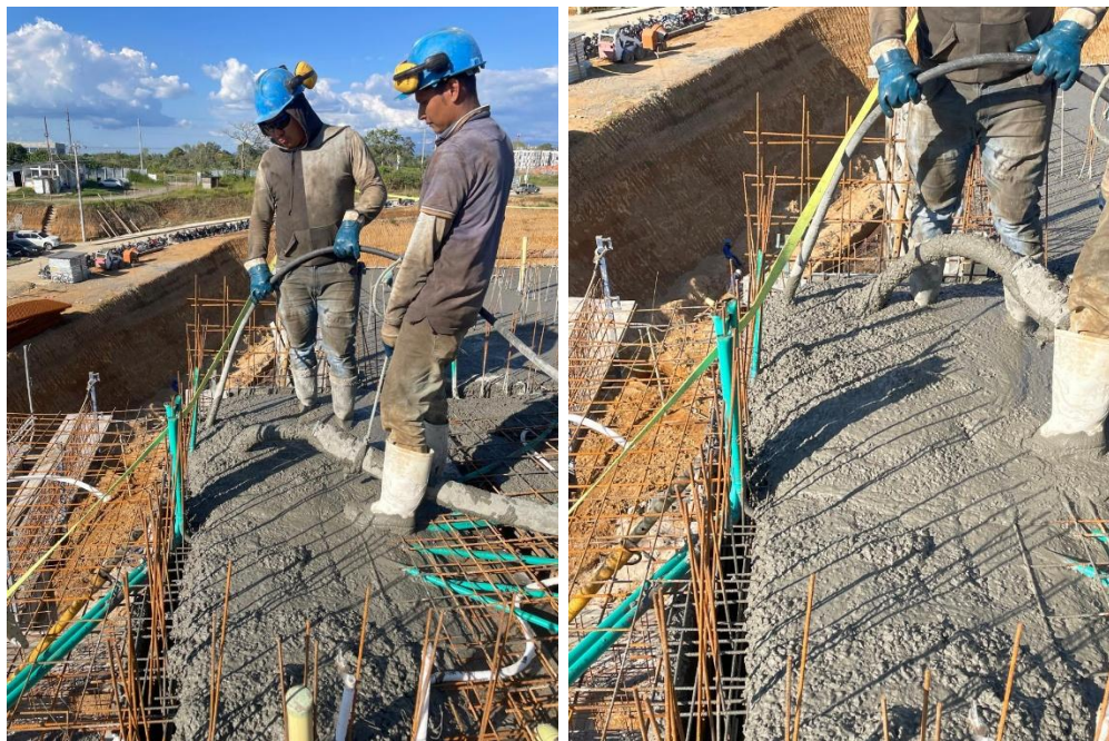
Ilustración 69. Vibrado del concreto. Fuente: Propia
