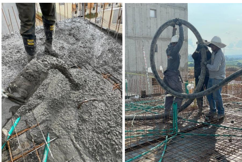
Ilustración 68. Vaciado de concreto de apartamentos.
