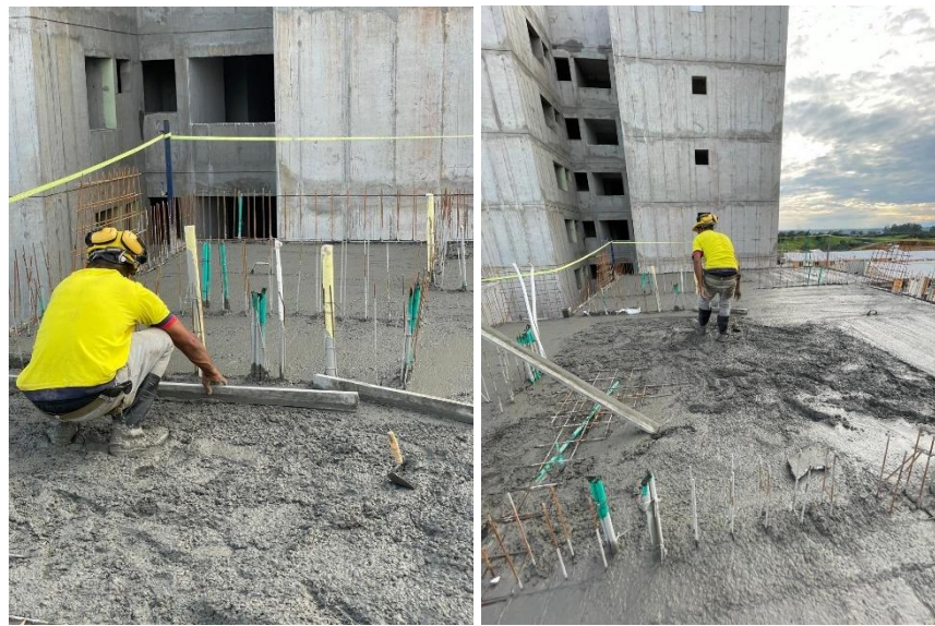
Ilustración 51. Distribución uniforme del concreto de losa entrepiso Fuente: Propia
