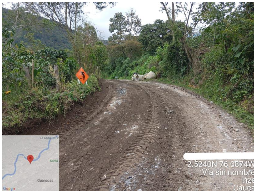
Ilustración 39 Nivelación de Subrasante con Motoniveladora Tramo 1 (Colegio)
