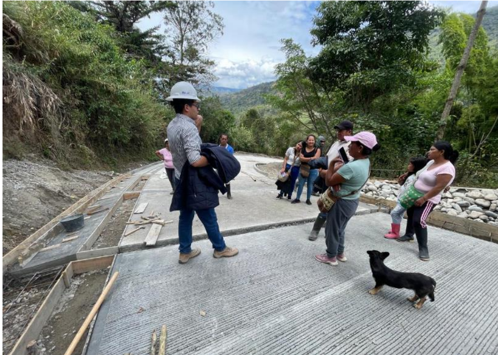
Ilustración 87 Socialización sobre Procesos Constructivos y Controles de Calidad
