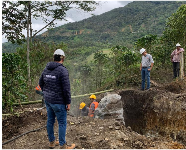
Ilustración 12. Demolición de Alcantarilla 1 Tramo 1 (Colegio)
