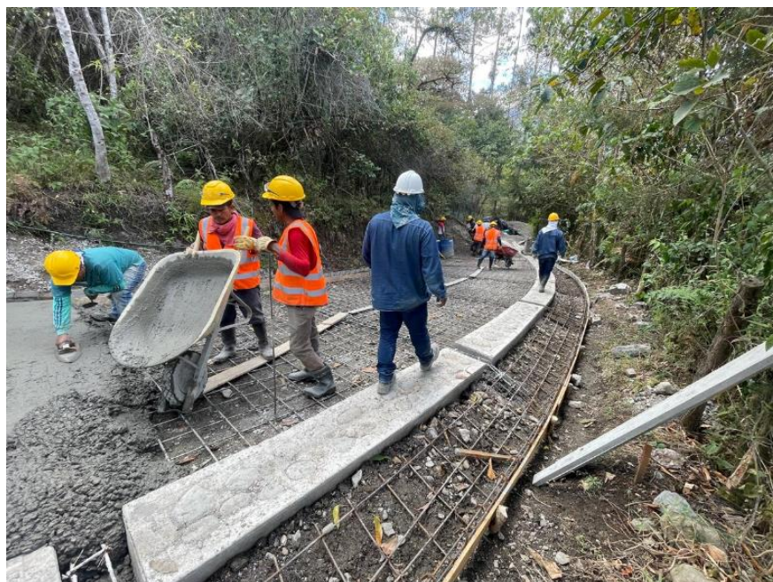
Ilustración 65. Fundición de Placa solida Tramo 3
