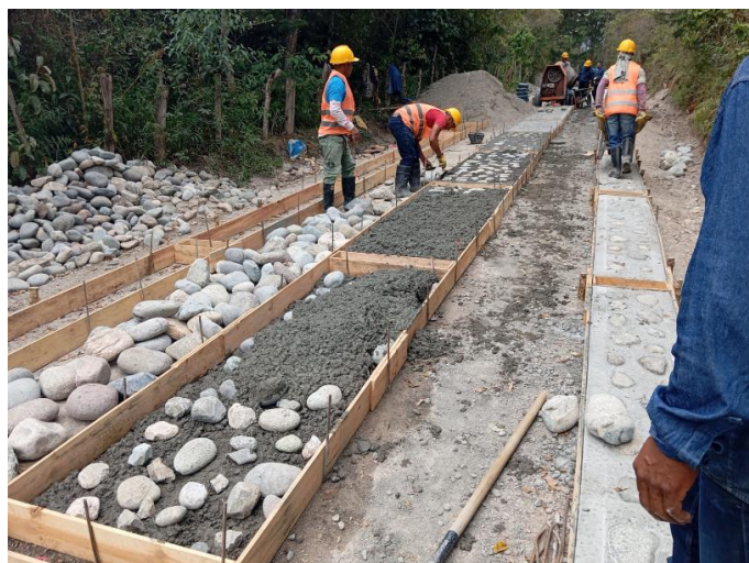
Ilustración 57. Fundición Concreto Ciclópeo Tramo 3
