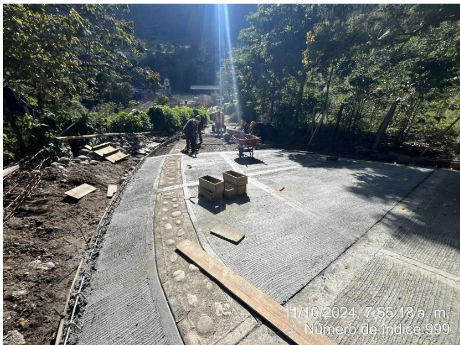
Ilustración 70. Fundición de Placa Solida y Cuneta Tramo 1
