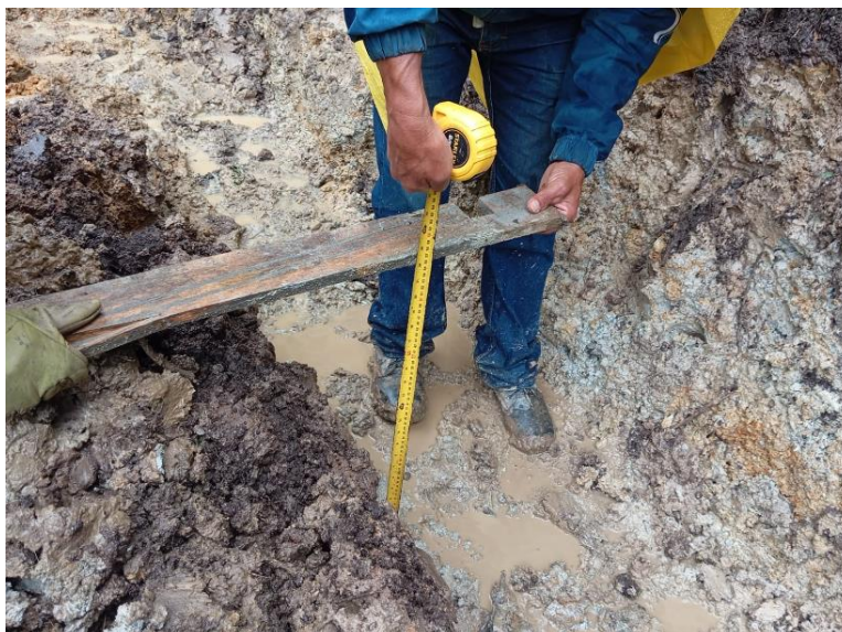
Ilustración 30. Verificación de Profundidad de Excavación para Filtro Francés
