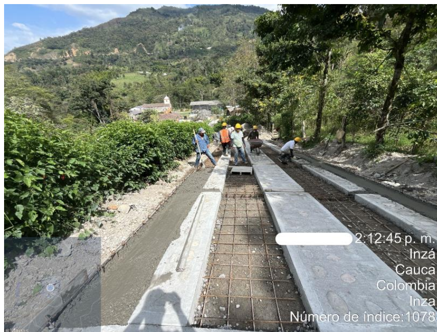
Ilustración 71 Fundición de Cuneta, Cinta Huella y Viga Riostra Tramo 1
