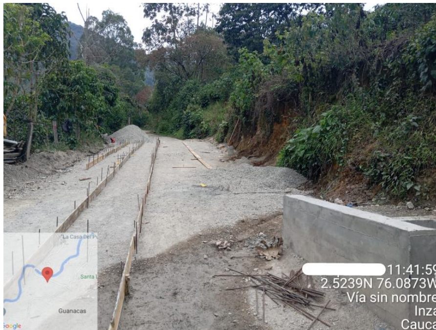
Ilustración 55. Formaleta para Ciclópeo Tramo 1 (Colegio)
