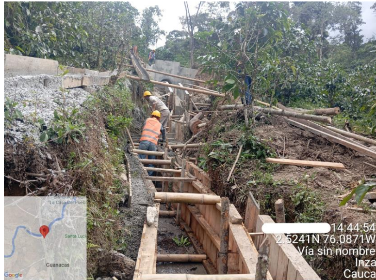
Ilustración 36. Fundición con Concreto Case D para Canal
