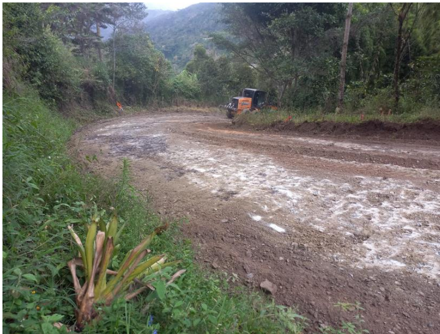
Ilustración 41 Nivelación de Subrasante con Motoniveladora Tramo 2 (Cementerio)
