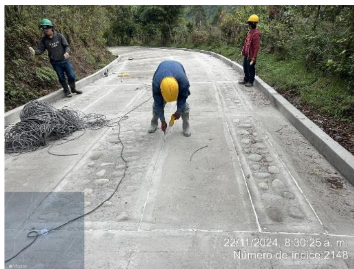
Ilustración 79. Sello de Juntas Tramo 3
