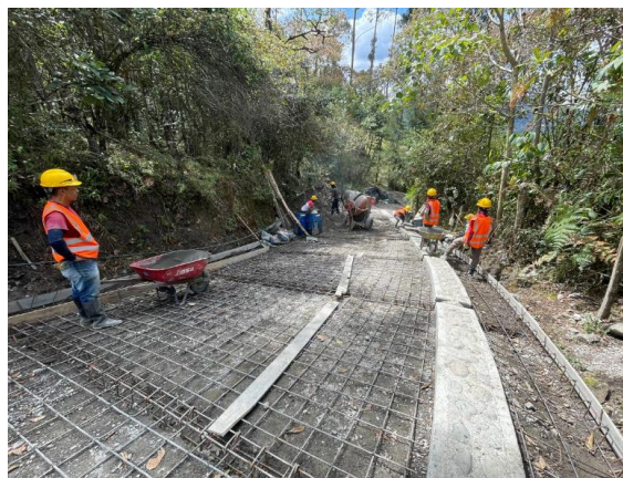
Ilustración 62 Acero de Refuerzo en Placa Solida Tramo 3
