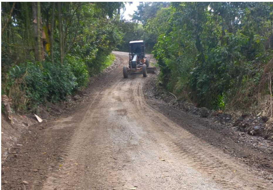
Ilustración 40 Nivelación de Subrasante con Motoniveladora Tramo 2 (Cementerio)
