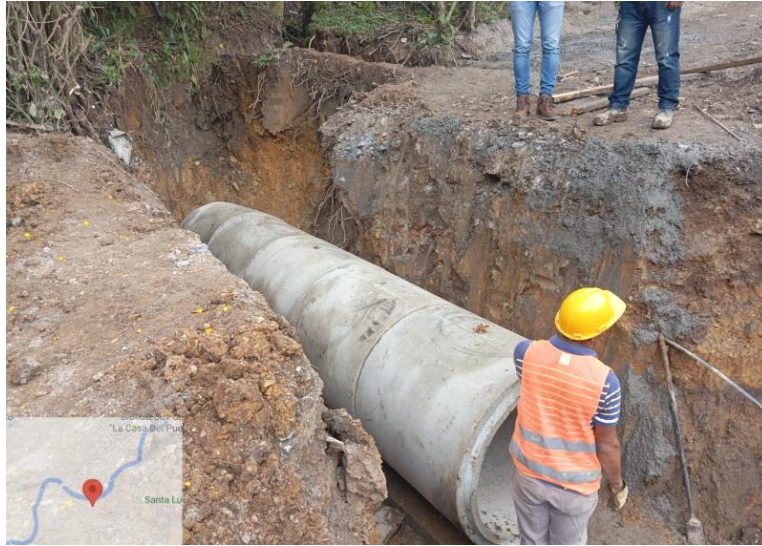
Ilustración 18 Instalación de Tubería de Concreto Reforzada de 900mm, Alcantarilla 2 Tramo 1 (Colegio)
