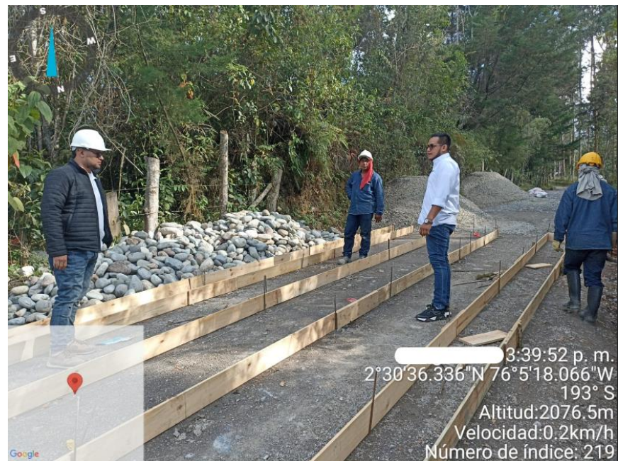
Ilustración 53. Instalación de Formaleta Tramo 3
