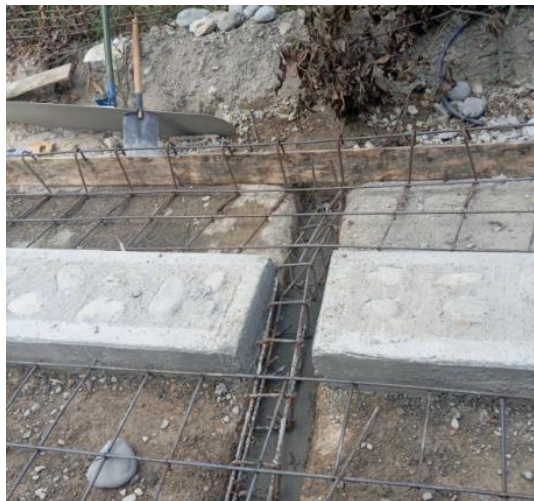
Ilustración 59 Acero de Refuerzo Cinta Huella, Cuneta, bordillo y Viga Riostra
