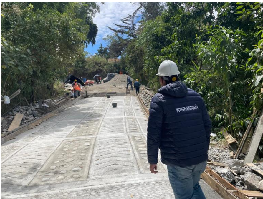
Ilustración 68. Revisión de Instalación de Formaleta para Bordillo y Ciclópeo Tramo 2
