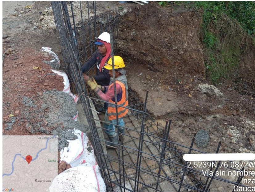
Ilustración 23. Armado y Figurado de Acero para Descole de Alcantarilla
