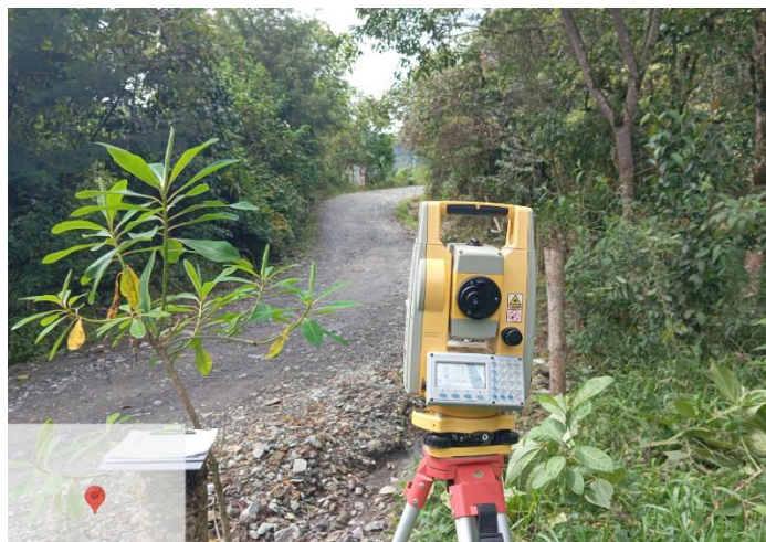
Ilustración 9 Localización y Replanteo Tramo 3 (Estación Total)
