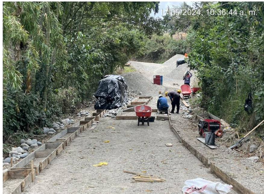
Ilustración 54. Instalación Formaleta para Ciclópeo Tramo 2 (Cementerio)
