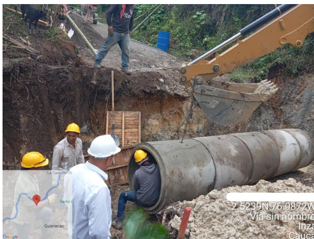
Ilustración 17 Instalación de Tubería de Concreto Reforzada de 900mm, Alcantarilla 1 Tramo 1 (Colegio)
