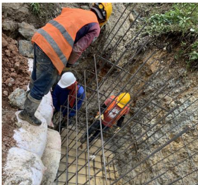
Ilustración 22. Armado y Figurado de Acero para Cole de Alcantarilla
