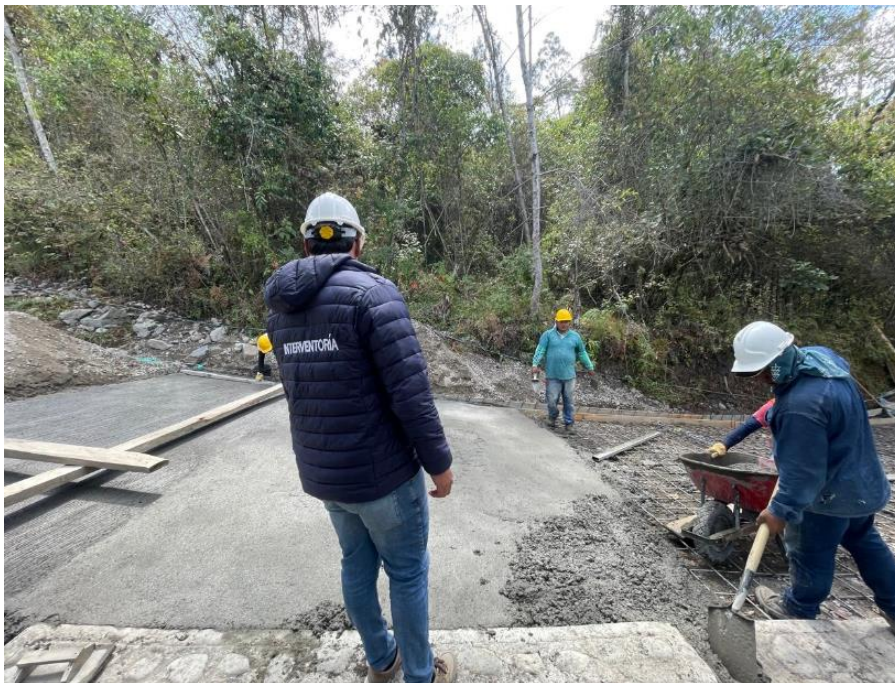
Ilustración 64. Fundición Placa Solida de Concreto Clase D Tramo 3
