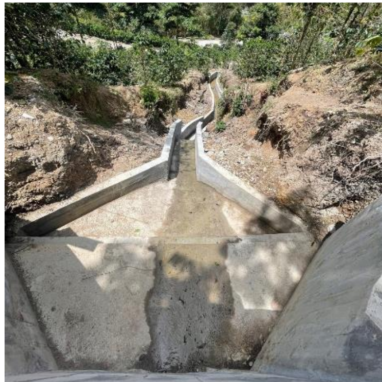
Ilustración 37. Acabado Final de Canal Complementario
