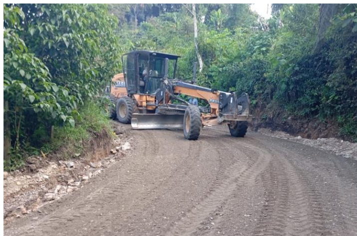
Ilustración 46. Nivelación de Subbase Granular con Motoniveladora Tramo 1
