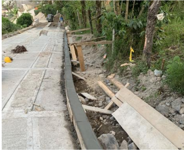
Ilustración 72 Fundición de Bordillo Tramo 1
