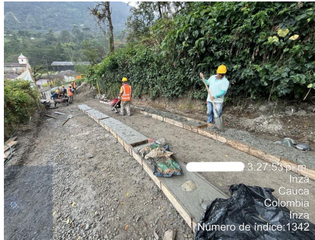
Ilustración 58. Fundición de Ciclópeo Tramo 1 (Colegio)
