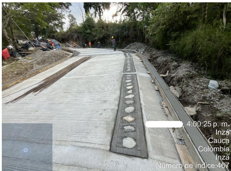
Ilustración 69. Fundición de Bordillo Placa huella Tramo 2
