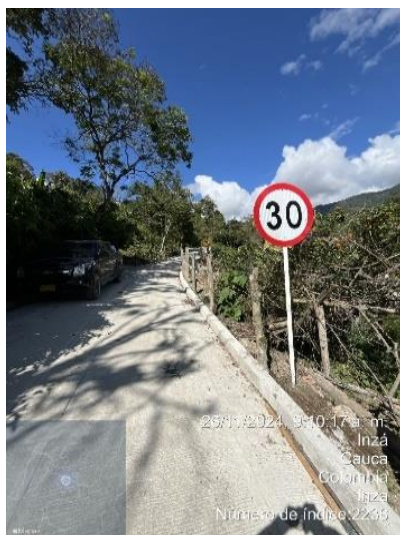
Ilustración 75. Placa Huella Terminada y Señalización Tramo 1
