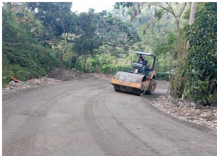
Ilustración 47. Compactación y Nivelación de Subbase Granular Tramo 2 (Cementerio)
