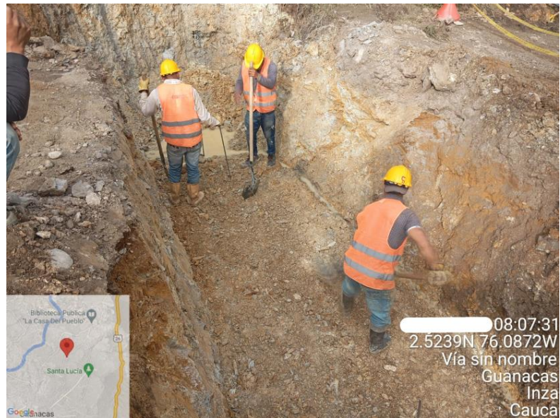
Ilustración 14. Excavación y Nivelación Alcantarilla 1 Tramo 1 (Colegio)
