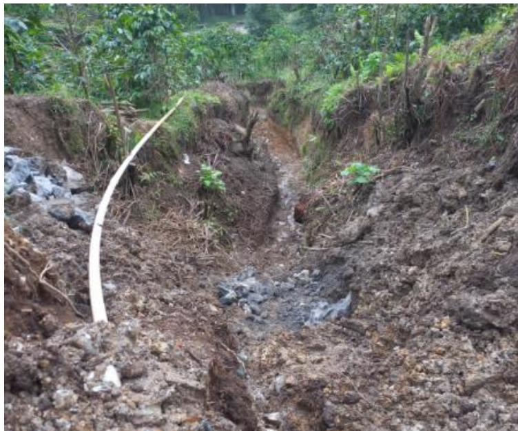
Ilustración 34. Ampliación, Excavación y Relleno sobre Zanja Existente
