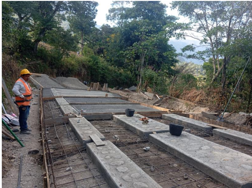
Ilustración 66. Fundición de Placa Solida, Cinta Huella y Cuneta Tramo 2 (Cementerio)
