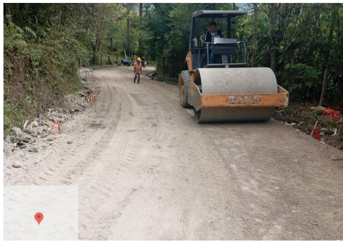
Ilustración 45. Compactación y Nivelación de Subbase Granular Tramo 3
