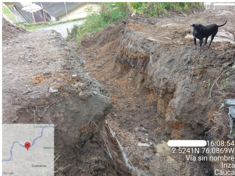
Ilustración 15. Excavación para Construcción de Alcantarilla 2 Tramo 1 (Colegio)
