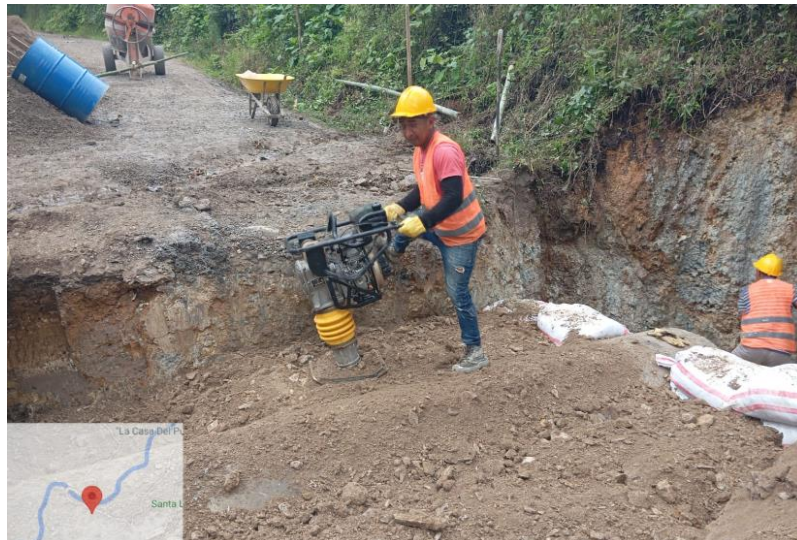
Ilustración 19 Relleno y Compactación alrededor de tubería de concreto
