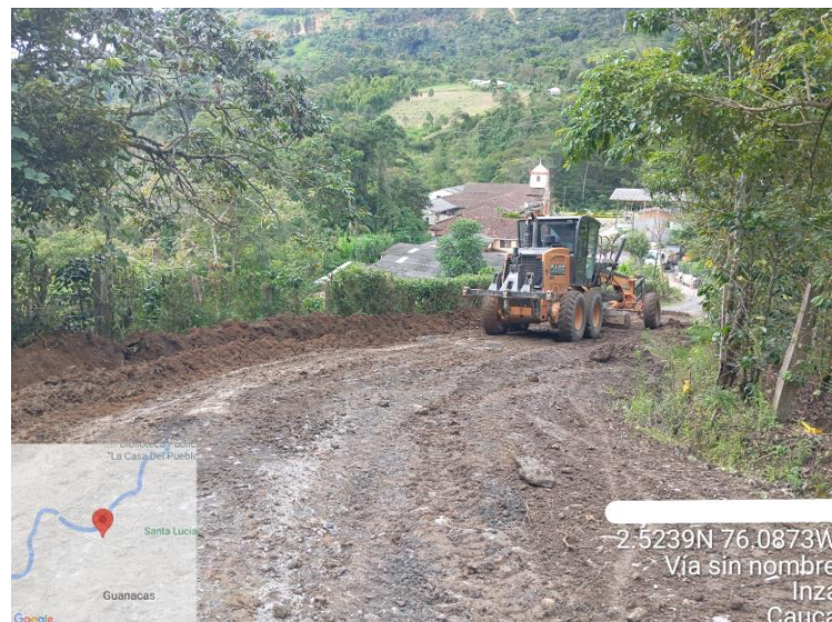
Ilustración 38 Nivelación de Subrasante con Motoniveladora Tramo 1 (Colegio)
