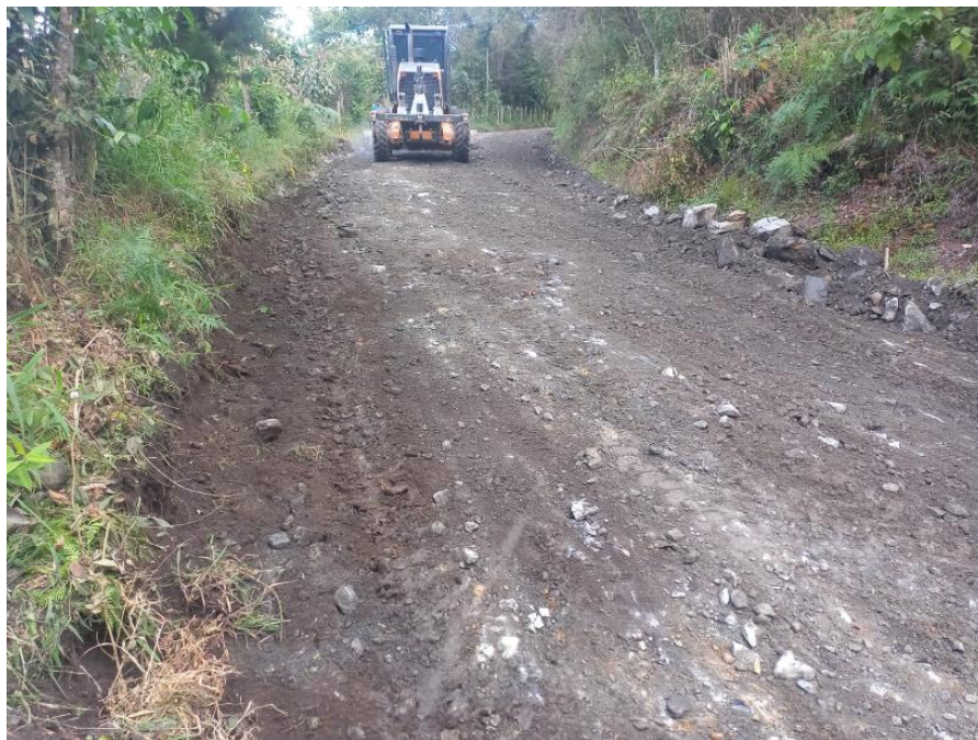
Ilustración 42 Nivelación de Subrasante con Motoniveladora Tramo 3
