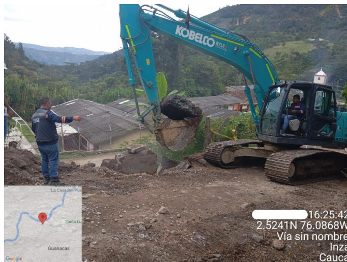
Ilustración 13. Demolición de Alcantarilla 2 Tramo 1 (Colegio)
