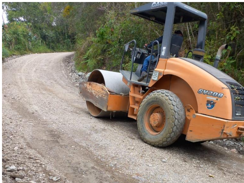
Ilustración 43 Nivelación y Compactación con Material de Mejoramiento para Subrasante Tramo 3
