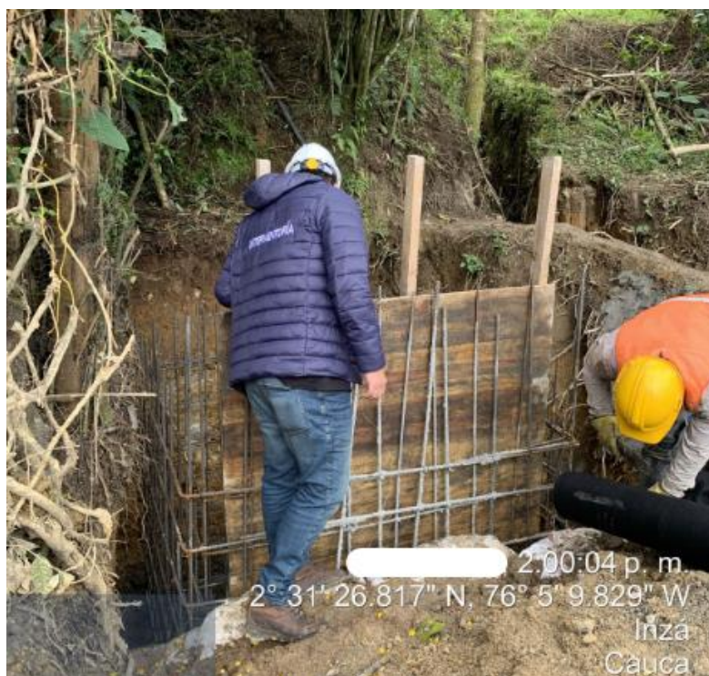
Ilustración 24. Instalación de Formaleta para Cole de Alcantarilla
