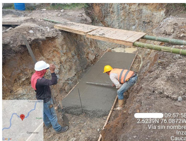
Ilustración 16 Suministro de Concreto Clase F (2000 psi) Alcantarilla 1 Tramo 1
