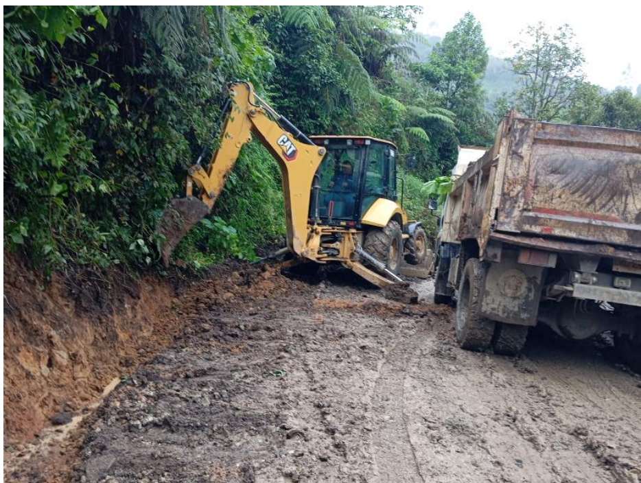
Ilustración 29. Excavación con maquinaria Pajarita para Instalación de Filtro Frances
