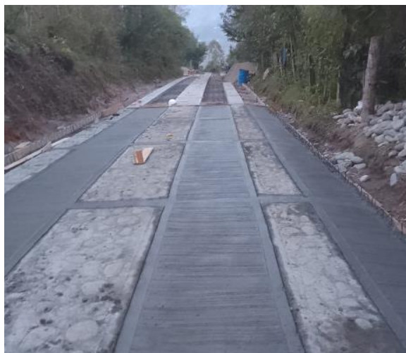
Ilustración 63 Fundición de Cinta Huella, Viga Riostra y Cuneta Tramo 3
