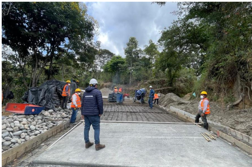
Ilustración 67. Fundición de Placa Solida en Concreto Clase D Tramo 2
