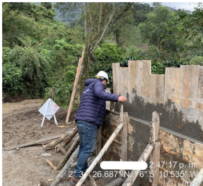
Ilustración 26. Inspección a Fundición de Concreto de Descole de Alcantarilla
