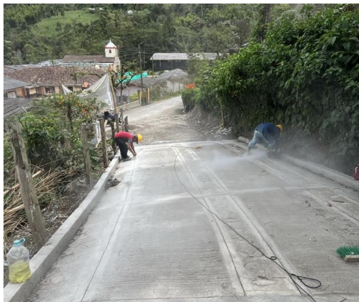
Ilustración 78 Sello de Juntas Tramo 1
