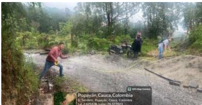
Figura 10 Medición del ancho de la placa huella
