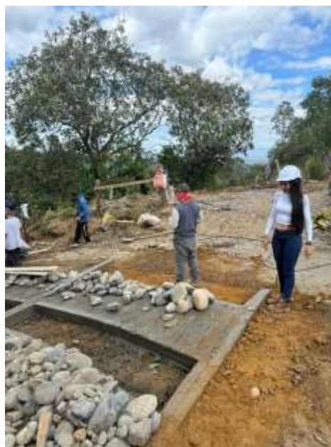
Figura 21 Concreto ciclópeo
