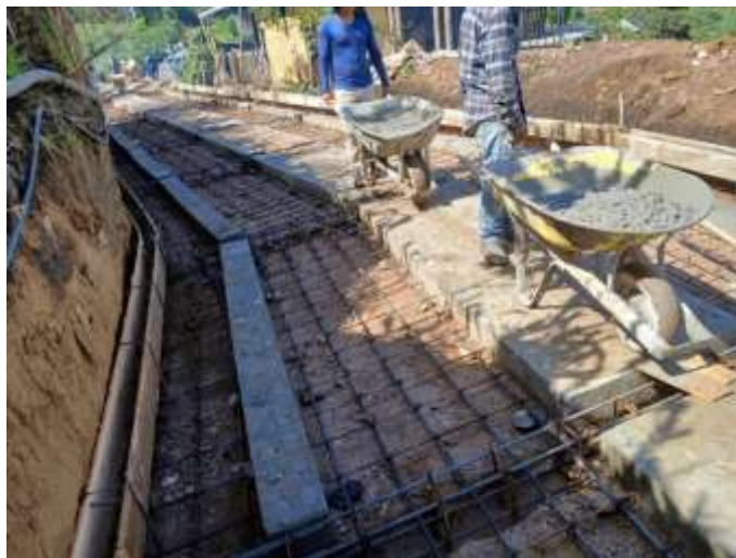
Figura 37 Ejecución de obra JAC San José la Paila
