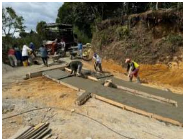
Figura 19 Fundición de huellas y riostras
