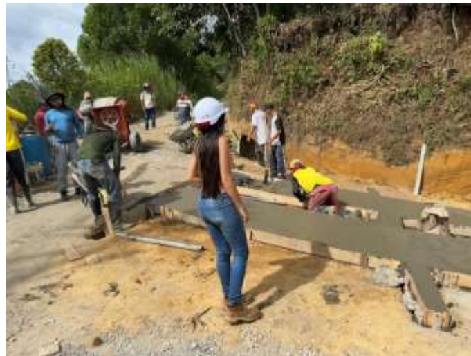
Figura 18 Fundición de huellas y riostras
