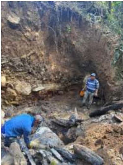
Figura 29 Muro de contención JAC Quintana
