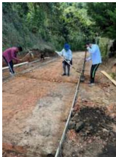
Figura 12 Excavación manual para riostras
