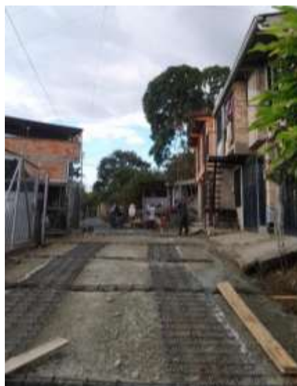
Figura 38 Ejecución de obra JAC El Túnel
