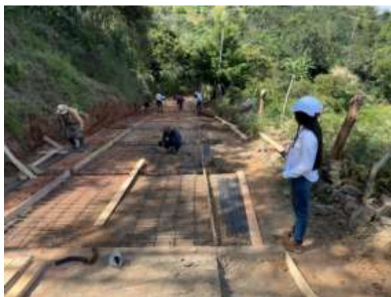
Figura 13 Armado de Acero
