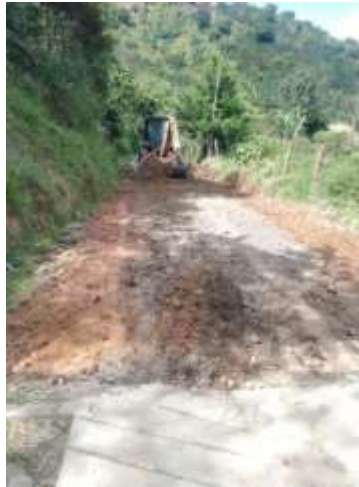
Figura 11 Preparación del Terreno
