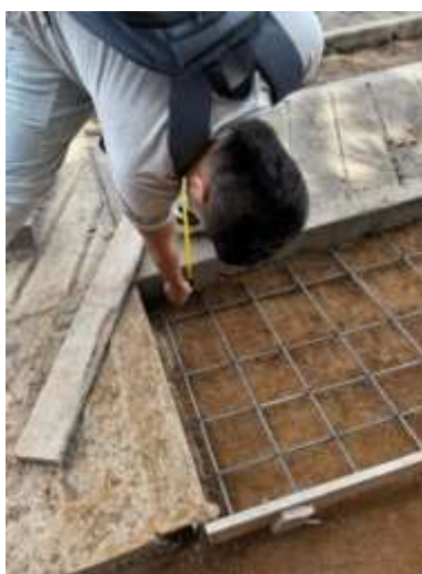
Figura 16 Espesor de Losa
