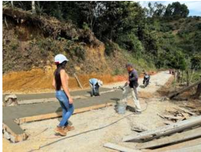
Figura 17 Fundición de huellas y riostras
