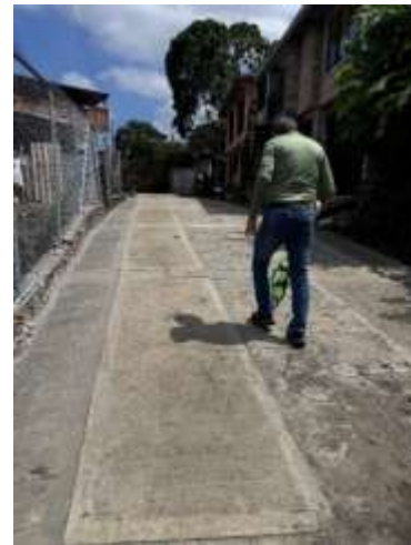
Figura 40 Placa Huella El Túnel
