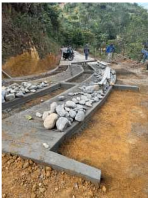
Figura 20 Concreto ciclópeo
