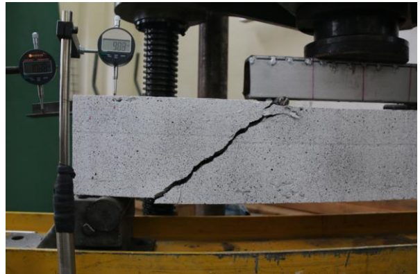
b (viga 2.2 Estado final)
