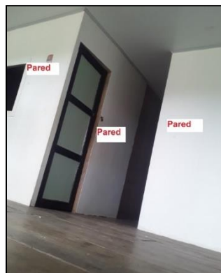
Fotografía 20. Pared de super-board
