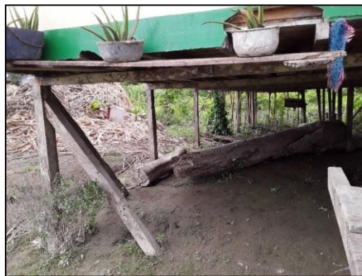
Fotografía 11. Horcones de una vivienda
