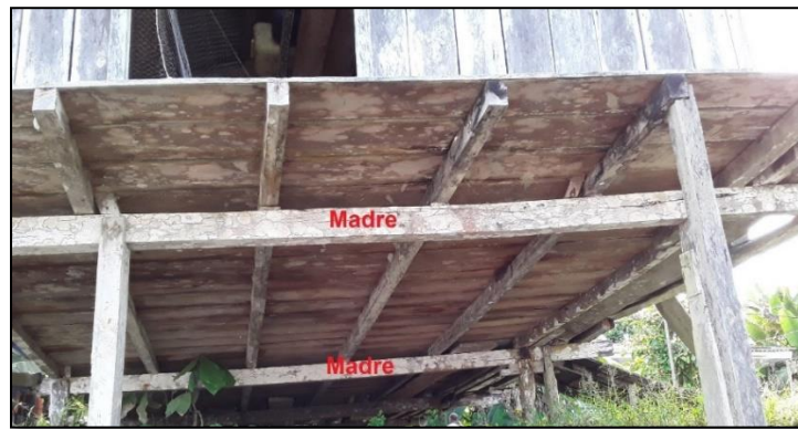
Fotografía 12. Madres en la estructura
