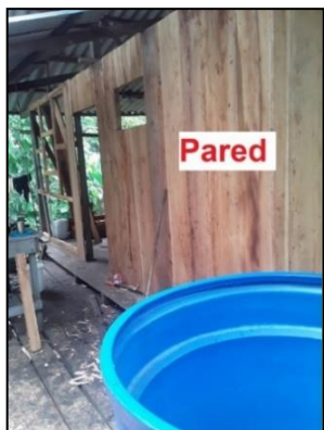
Fotografía 19. Pared en madera
