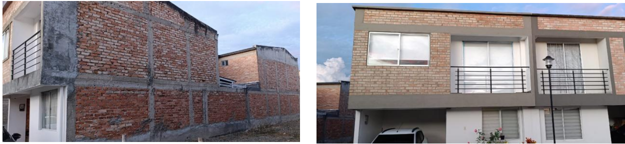
Figura 5. Sistema estructural de mampostería confinada en Popayán
