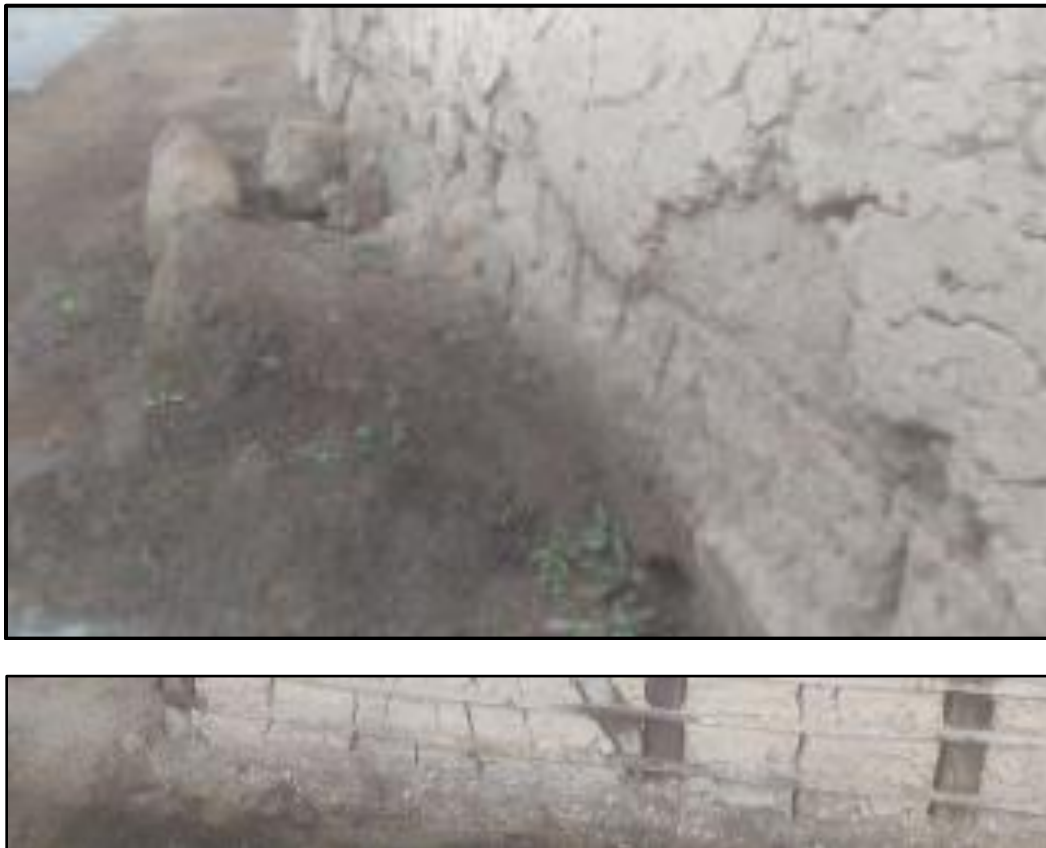
Ilustración 9: Cimientos construidos en vivienda de bahareque.
