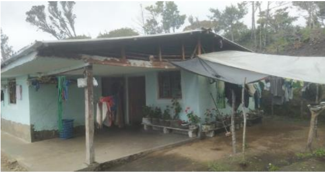
Fotografía 2: Casa en adobe con teja y repello
