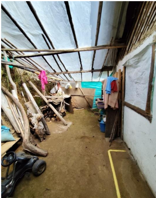
Fotografía 5: Localización externa del baño en una vivienda construida en bareque
