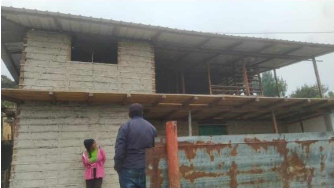
Fotografía 3: Construcción de casa en bareque
