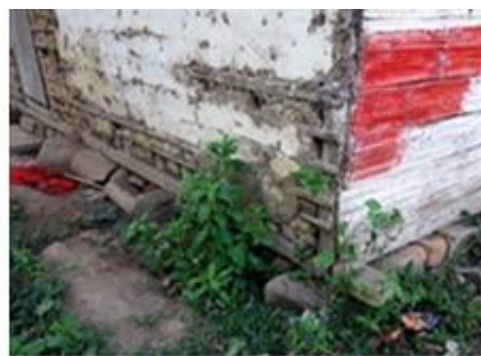
Sobrecimiento sobre piedra
