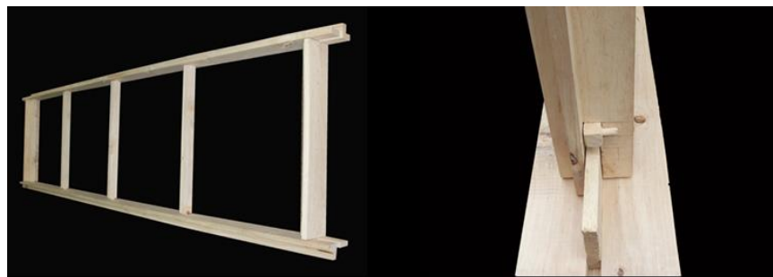
Ilustración 15: Estructura y detalle de unión con pasadores
