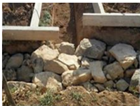
zanja de piedra de canto
