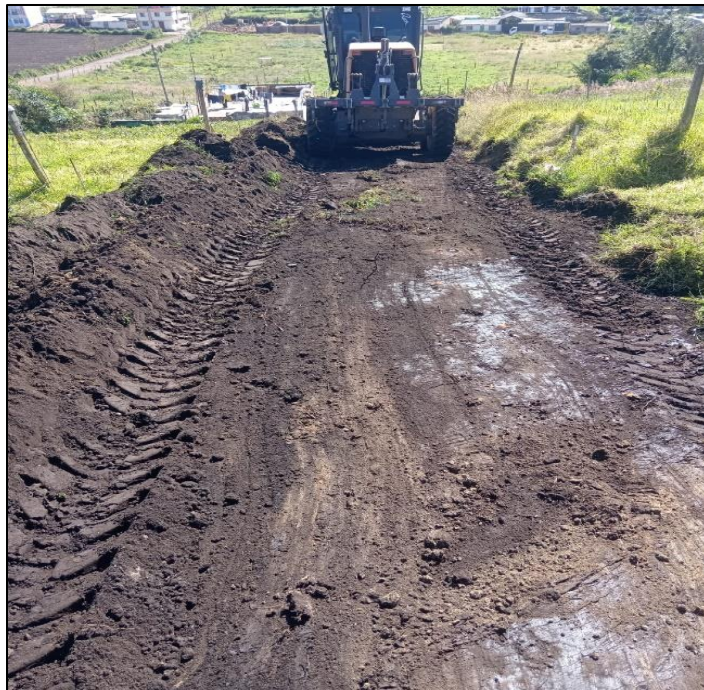
Ilustración 48: intervención de la vía
