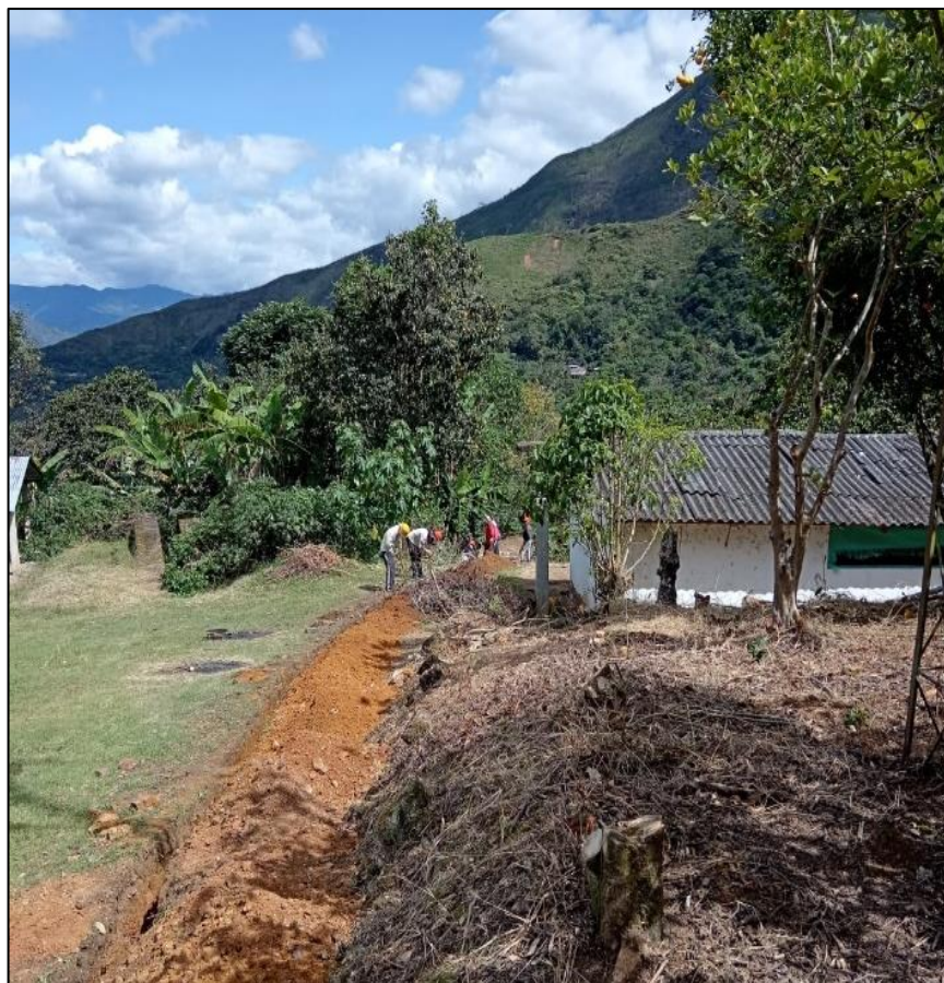
Ilustración 57: Relleno de material
