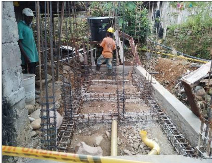
Ilustración 14: Acero de vigas de cimentación
