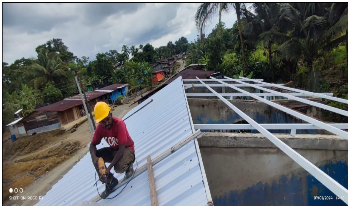
Ilustración 20: Instalación cubierta metálica
