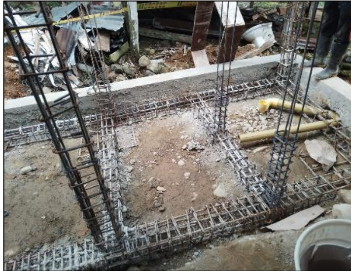
Ilustración 13: Instalación de acero
