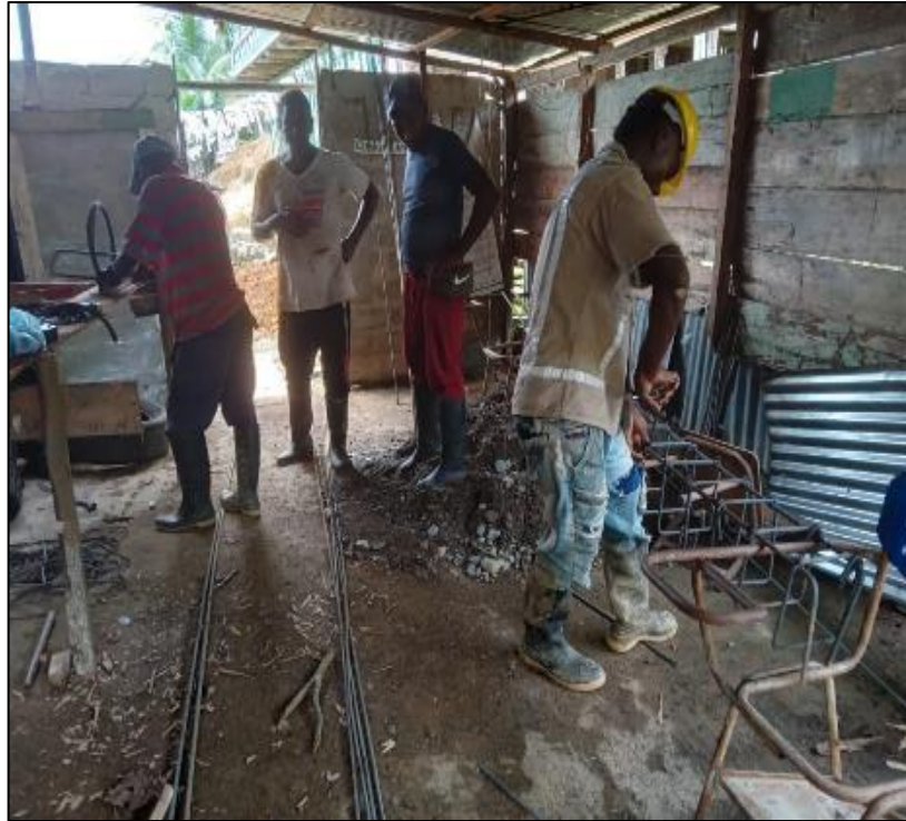
Ilustración 11: Figurado y amarre de acero
