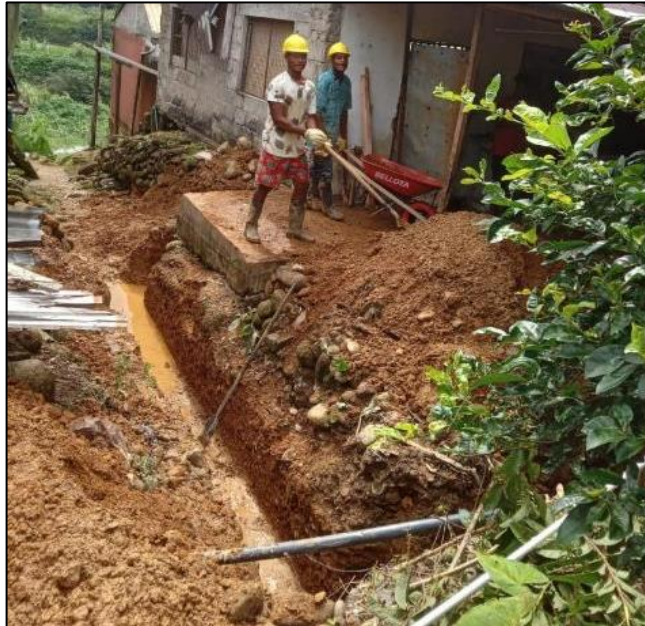
Ilustración 12: Instalación de desagües
