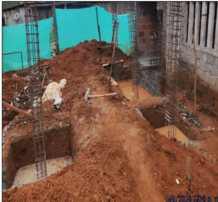
Ilustración 10: zapatas de cimentación
