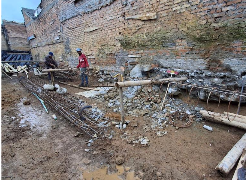
Ilustración 62. Armado de Castillo de Pilote Living 49.
