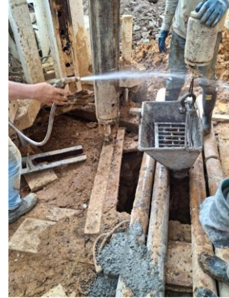
Ilustración 21. Fundición de Pilotes Living 49.
