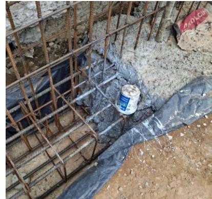
Ilustración 84. Aplicación de Adhesivo Epóxico en Juntas Frías Living 49.
