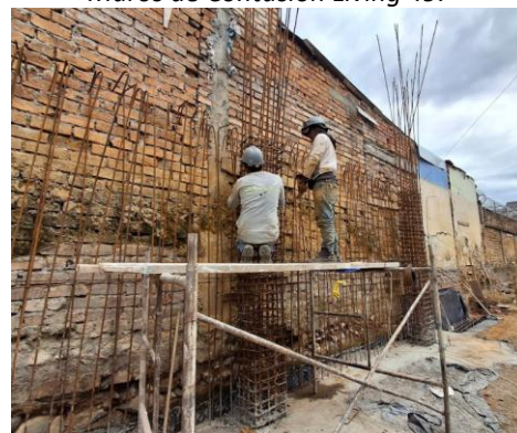
Ilustración 75. Supervisión de Armado de Acero de Columnas y Muros de Contusión Living 49.
