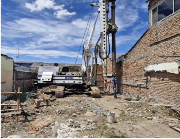
Ilustración 16. Perforación de Pilotes Living 49.
