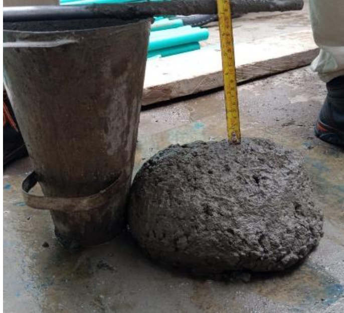
Ilustración 58. Asentamiento del Concreto.
