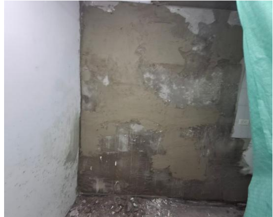
Ilustración 137. Relleno y Emparejamiento de Muro.
