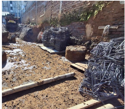
Ilustración 46. Depósito Temporal del Acero.
