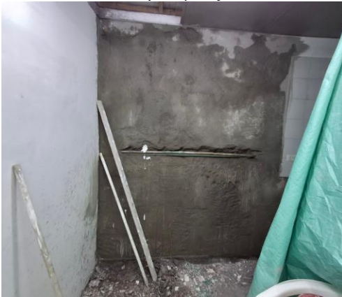
Ilustración 136. Relleno y Emparejamiento de Muro.
