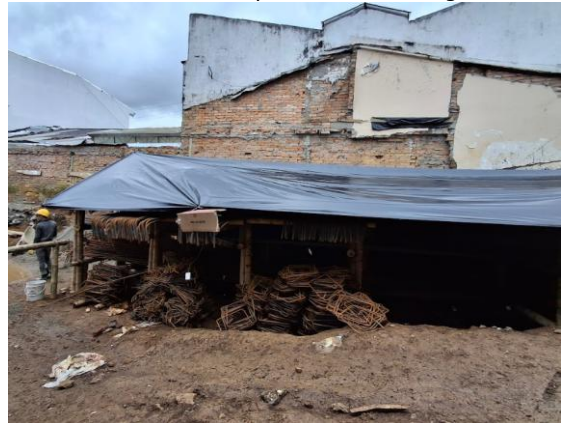
Ilustración 48. Acopio de Acero Living 49.
