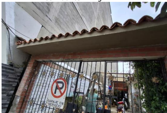
Ilustración 142. Embellecimiento de Fachada, Inmueble Colindante Living 42.
