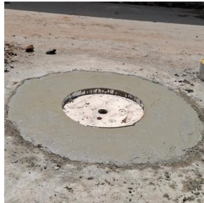
Ilustración 11. Elaboración de Alcantarilla Living 42.
