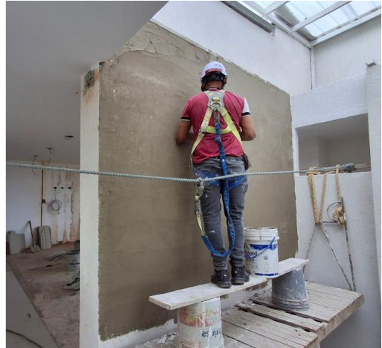
Ilustración 125. Supervisión del Uso de EPP.
