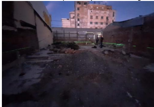
Ilustración 15. Replanteo y Niveles Living 49.
