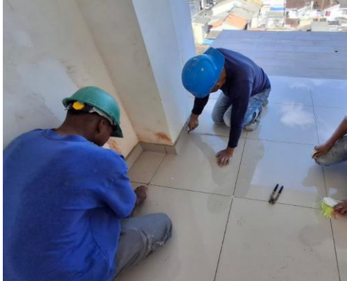
Ilustración 87. Limpieza y Fraguado de Separaciones.
