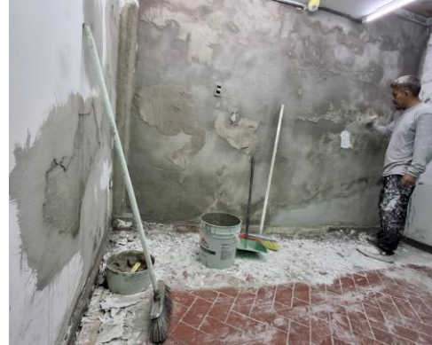
Ilustración 135. Impermeabilización de Muro Boutique.
