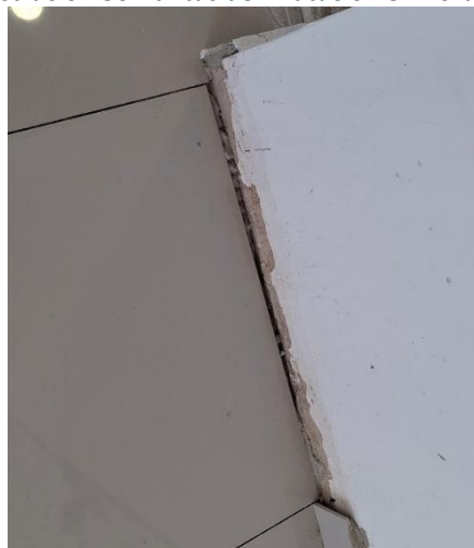
Ilustración 86. Juntas de Dilatación en Bordes.
