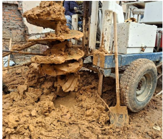
Ilustración 61. Perforación de Pilote Living 49.
