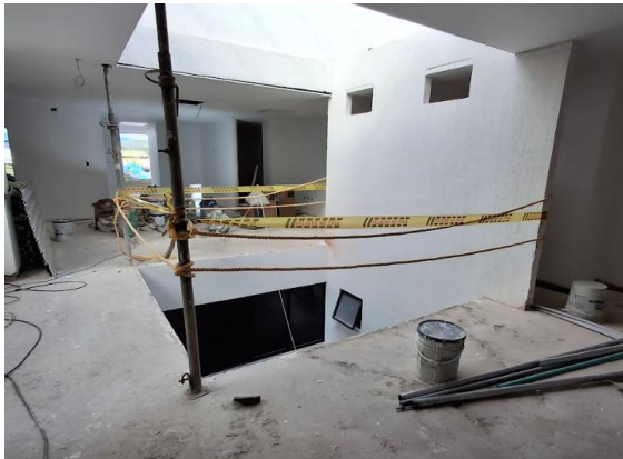
Ilustración 119. Señalización de Vacíos del Sexto Piso.
