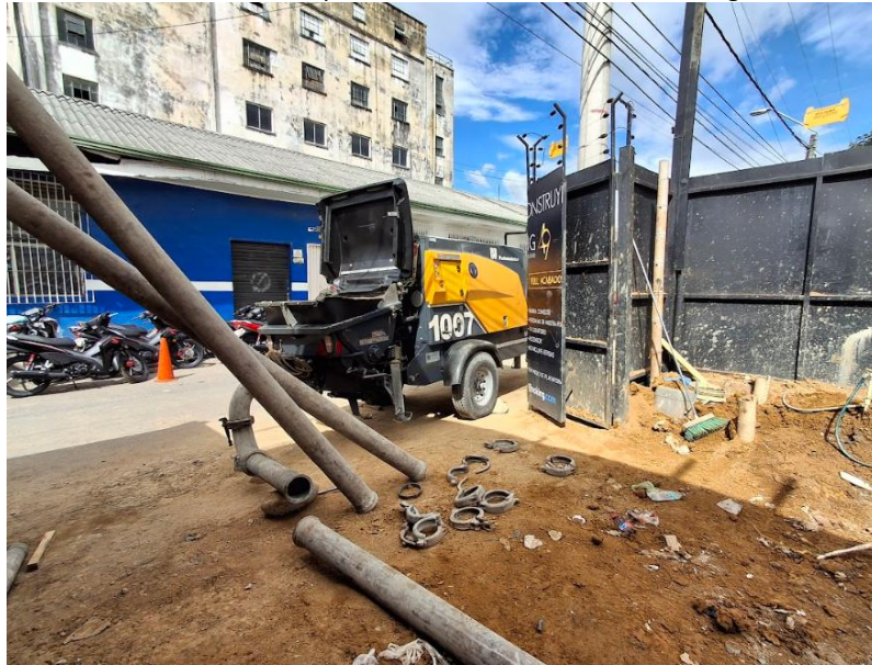
Ilustración 78. Recepción de Bomba Estacionaria Living 49.
