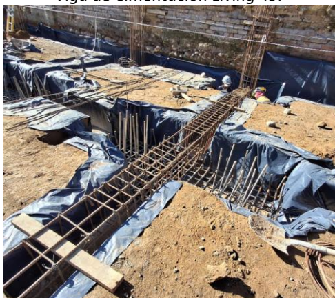
Ilustración 74. Supervisión de Separaciones de Estribos de Viga de Cimentación Living 49.
