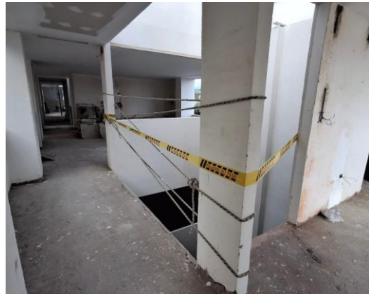
Ilustración 120. Señalización de Vacíos del Sexto Piso.
