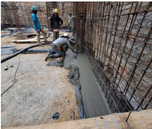
Ilustración 80. Nivelación de Elementos Fundidos Living 49.
