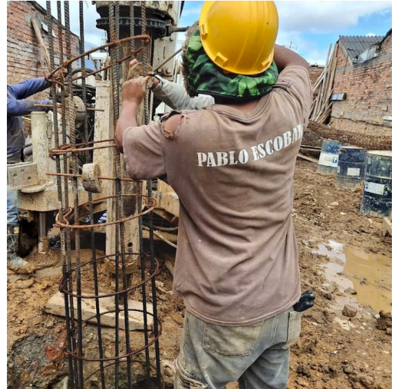
Ilustración 64. Colocación de Panelas de Separación en Castillos de Pilote Living 49.
