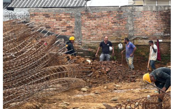
Ilustración 17. Acero de Pilotes Living 49.
