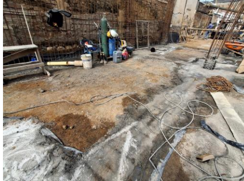
Ilustración 82. Curado del Concreto Living 49.
