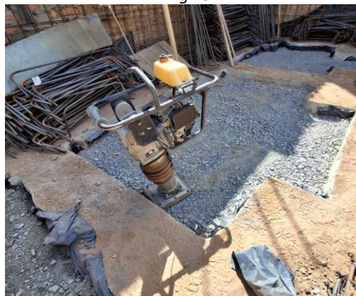
Ilustración 72. Reemplazo y Compactación de Suelo Living 49.
