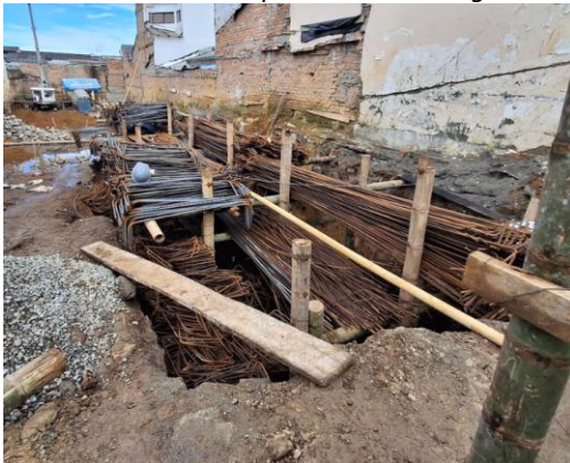
Ilustración 47. Acopio de Acero Living 49.
