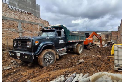
Ilustración 23. Nivelación de Terreno con Excavadora.
