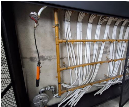
Ilustración 99. Prueba de Fugas en Redes de Gas Living 42.
