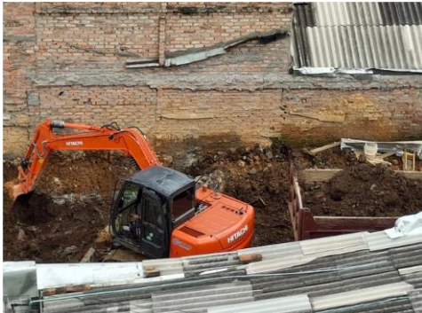
Ilustración 22. Nivelación de Terreno con Excavadora.
