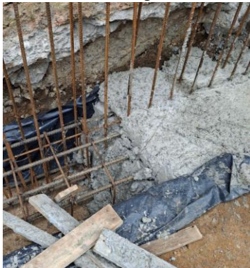
Ilustración 83. Aplicación de Adhesivo Epóxico en Juntas Frías Living 49.
