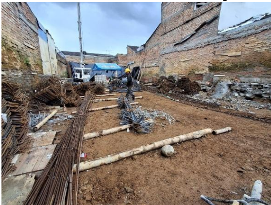
Ilustración 29. Recorrido de Obra Living 49.
