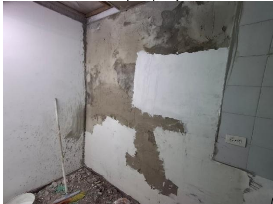
Ilustración 138. Relleno y Emparejamiento de Muro.
