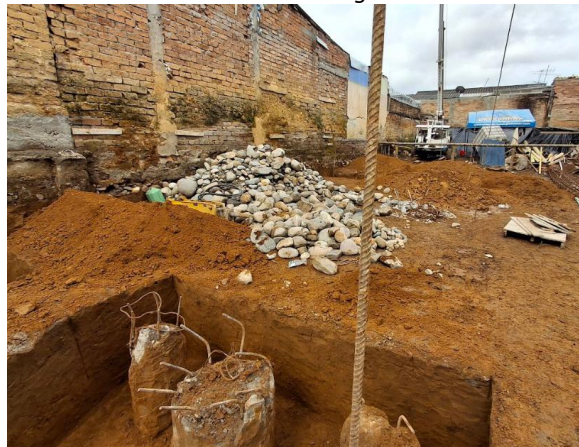
Ilustración 69. Referencia para Verificar Niveles de Excavación Living 49.
