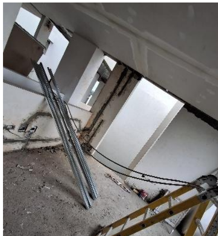
Ilustración 25. Recorrido de Obra Sexto Piso Living 42.
