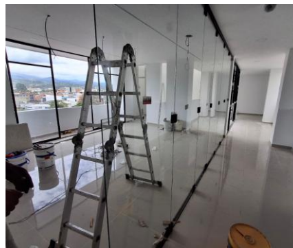
Ilustración 105. Avances en Carpintería Metálica Living 42.
