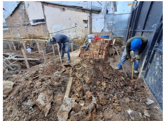
Ilustración 30. Recorrido de Obra Living 49.
