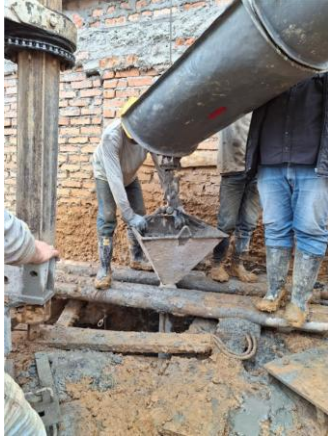
Ilustración 20. Fundición de Pilotes Living 49.
