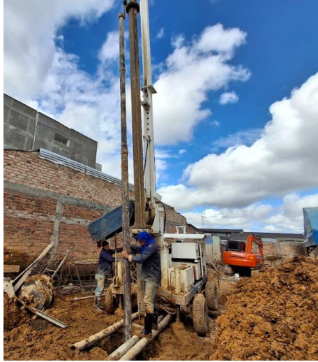
Ilustración 65. Colocación de Tubería Tremie en Perforación Living 49.
