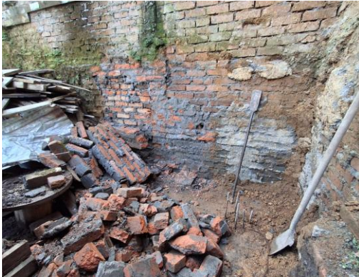
Ilustración 128. Limpieza de Muro.
