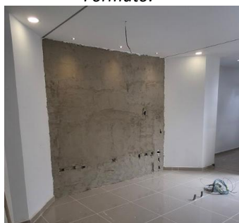
Ilustración 91. Instalación de Porcelanato de Gran Formato.
