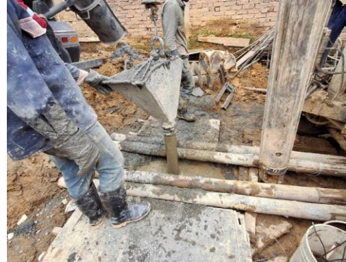
Ilustración 67. Fundición de Pilote Living 49.
