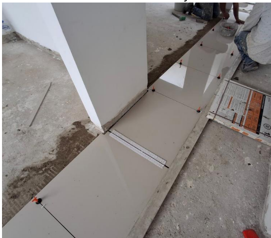
Ilustración 85. Hilada de Referencia.
