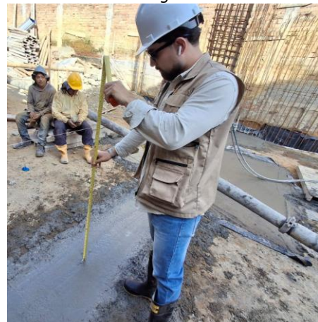
Ilustración 81. Verificación de Niveles de Fundición Living 49.
