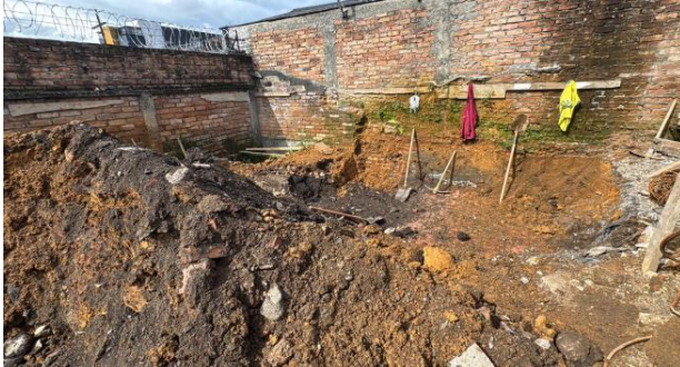
Ilustración 18. Excavación Manual Living 49.
