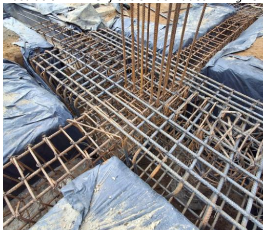
Ilustración 77. Verificación de Nudos Living 49.
