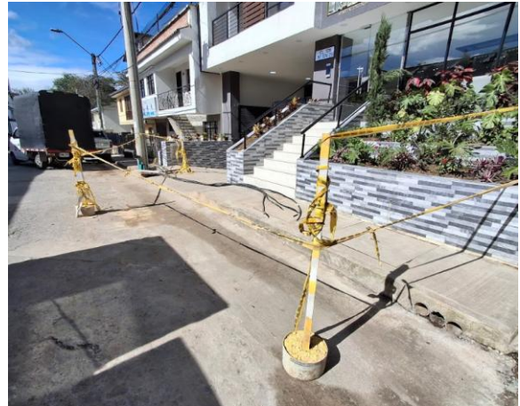
Ilustración 122. Señalización en la Vía Pública.
