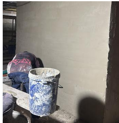
Ilustración 6. Acabados de Muros del Sótano Living 42.
