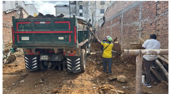
Ilustración 19. Extracción Manual del Material Living 49.
