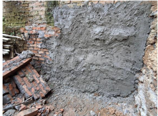
Ilustración 129. Impermeabilización de Muro.
