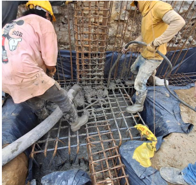
Ilustración 79. Vaciado de Concreto Living 49.
