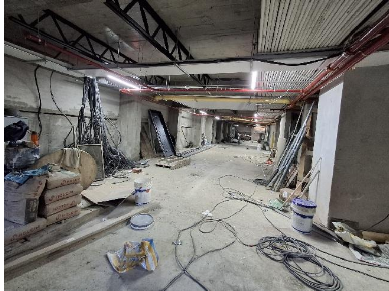
Ilustración 27. Recorrido de Obra Sótano Living 42.
