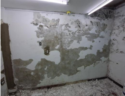
Ilustración 134. Limpieza de Muro Boutique.
