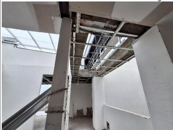
Ilustración 26. Recorrido de Obra Sexto Piso Living 42.
