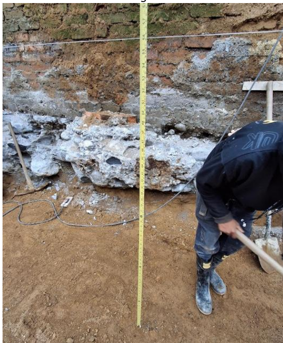
Ilustración 68. Verificación de Niveles de Excavación Living 49.
