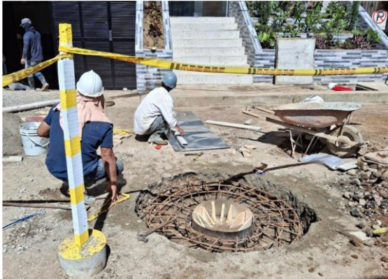
Ilustración 10. Elaboración de Alcantarilla Living 42.
