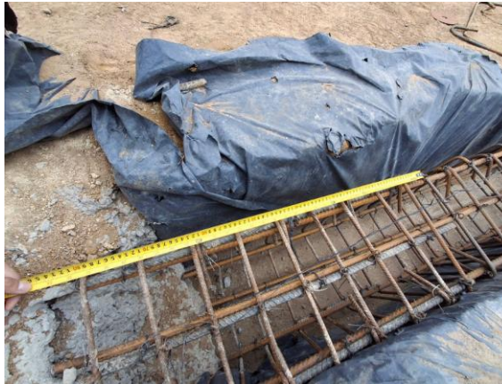
Ilustración 73. Verificación de Traslapos Living 49.
