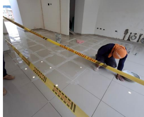
Ilustración 88. Limpieza y Fraguado de Separaciones.
