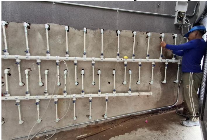
Ilustración 95. Revisión de Tuberías de Agua Potable Living 42.
