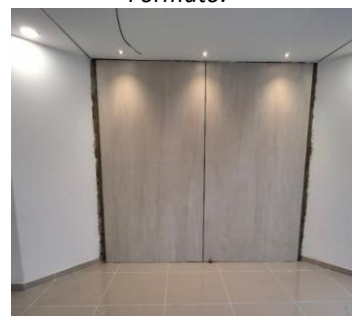
Ilustración 92. Instalación de Porcelanato de Gran Formato.
