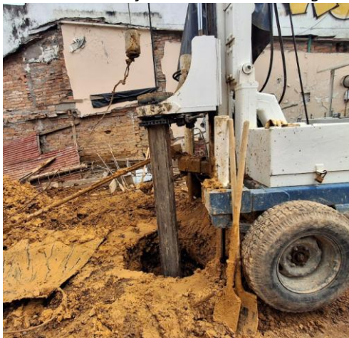
Ilustración 60. Perforación de Pilote Living 49.
