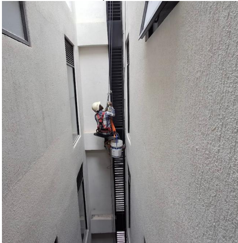
Ilustración 124. Supervisión del Uso de EPP.
