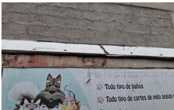
Ilustración 140. Instalación de Solapas, Inmueble Colindante Living 42.
