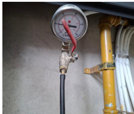
Ilustración 100. Prueba de Fugas en Redes de Gas Living 42.
