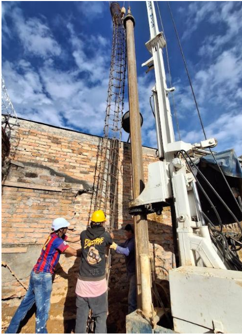
Ilustración 63. Introducción de Castillo a Perforación Living 49.
