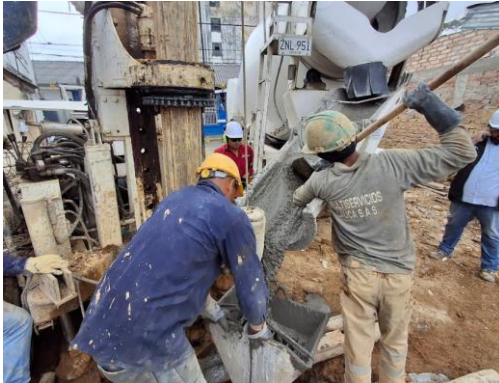
Ilustración 66. Fundición de Pilote Living 49.
