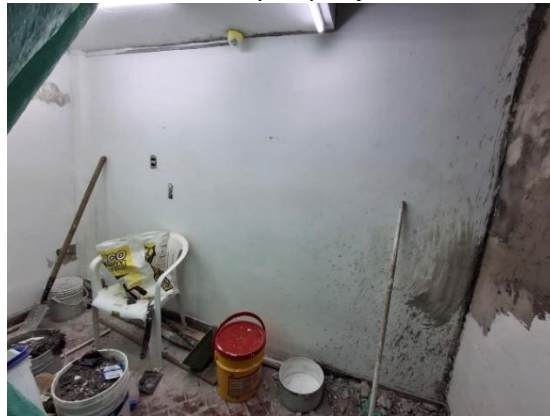
Ilustración 139. Relleno y Emparejamiento de Muro.
