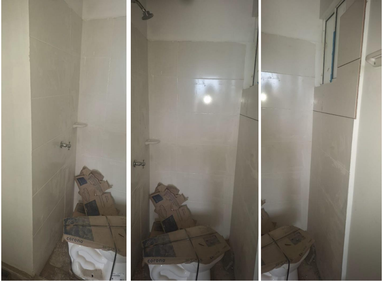
50 - Cantidad de enchape instalado en sitio en zona de baño auxiliar.
