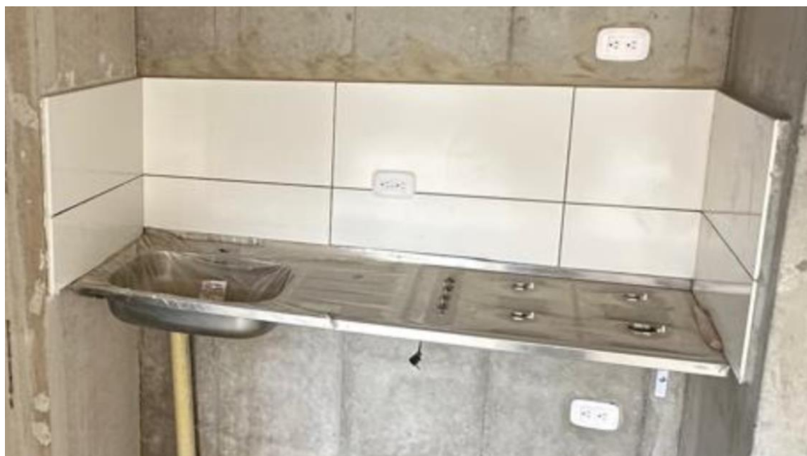
Fuente: foto tomada en sitio.
