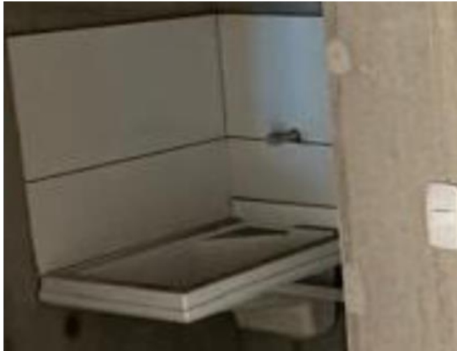
52 - Instalación de cerámica; zona de ropas en Tempus.
