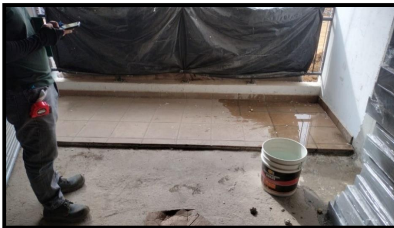
Fuente - Imágen tomada en sitio.
