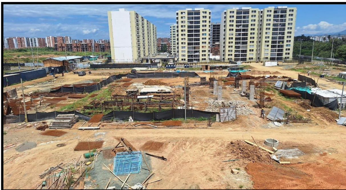
73 - Campamento de acero en Belaterra Tempus.
