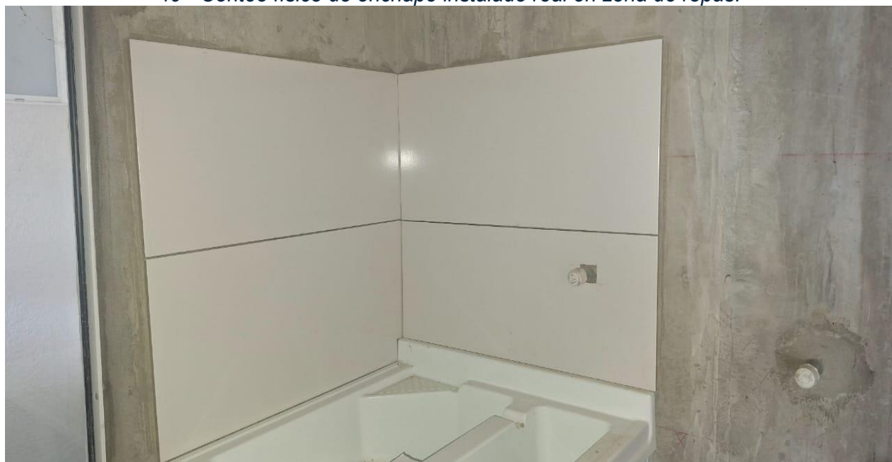
49 - Conteo físico de enchape instalado real en zona de ropas.
