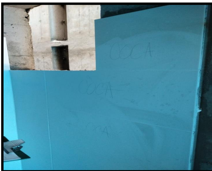
Fuente 4 - Imágen tomada en sitio
