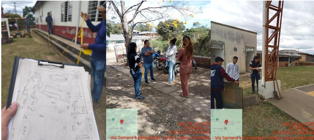
Ilustración 23. Visita técnica a la Institución Educativa La Cabaña para revisión de sistema de PTAR
