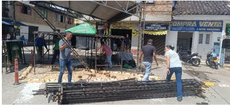
Ilustración 19. Apoyo al desmonte de la tarima principal del evento
