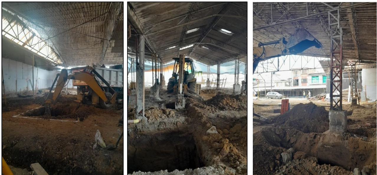
Ilustración 12. Supervisión proceso excavación mecánica
