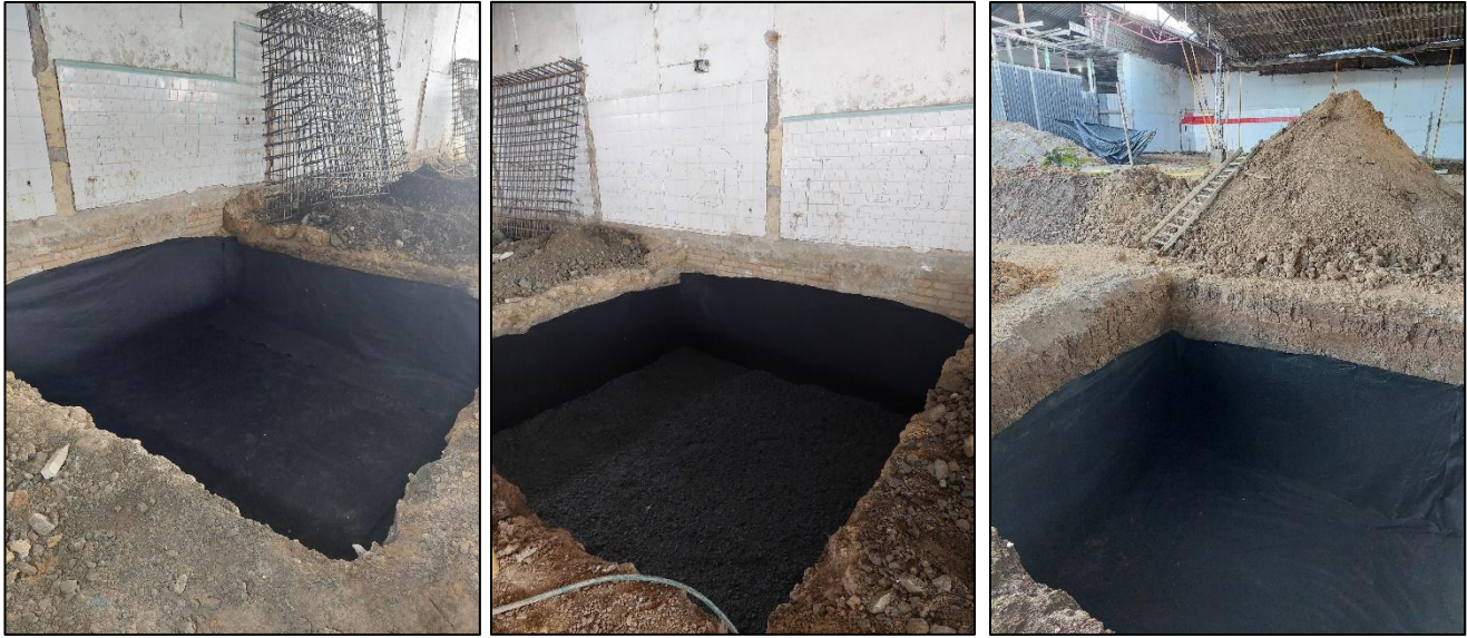
Ilustración 17. Supervisión instalación de geotextil
