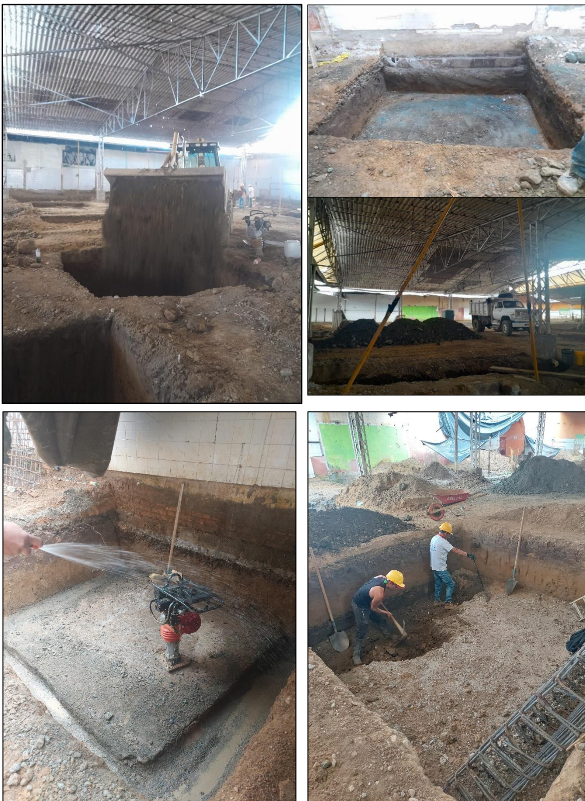
Ilustración 18. Supervisión mejoramiento de suelo
