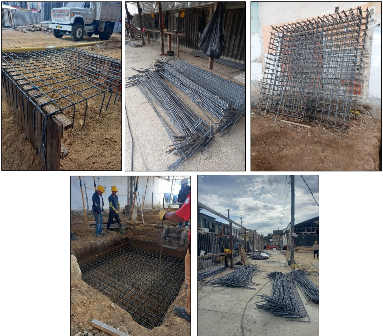
Ilustración 21. Supervisión armada de aceros para zapatas
