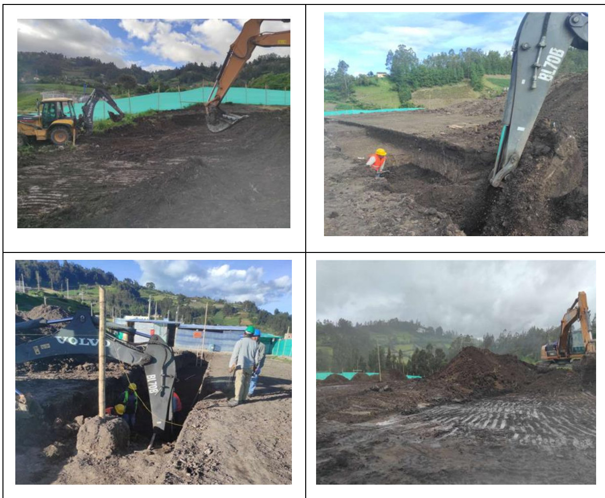
Figura 13 Fotografías ilustrativas, Excavación a máquina.
