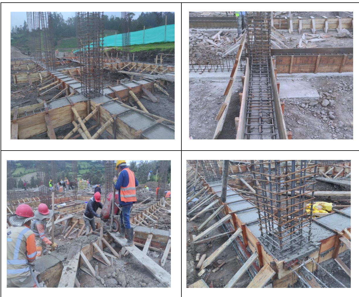
Figura 25 fotografías ilustrativas, vigas de cimentación.
