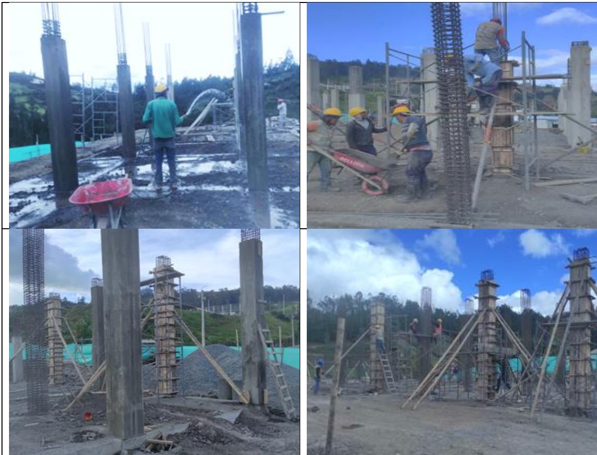
Figura 33 fotografías ilustrativas, Columnas en concreto de 3000 psi.
