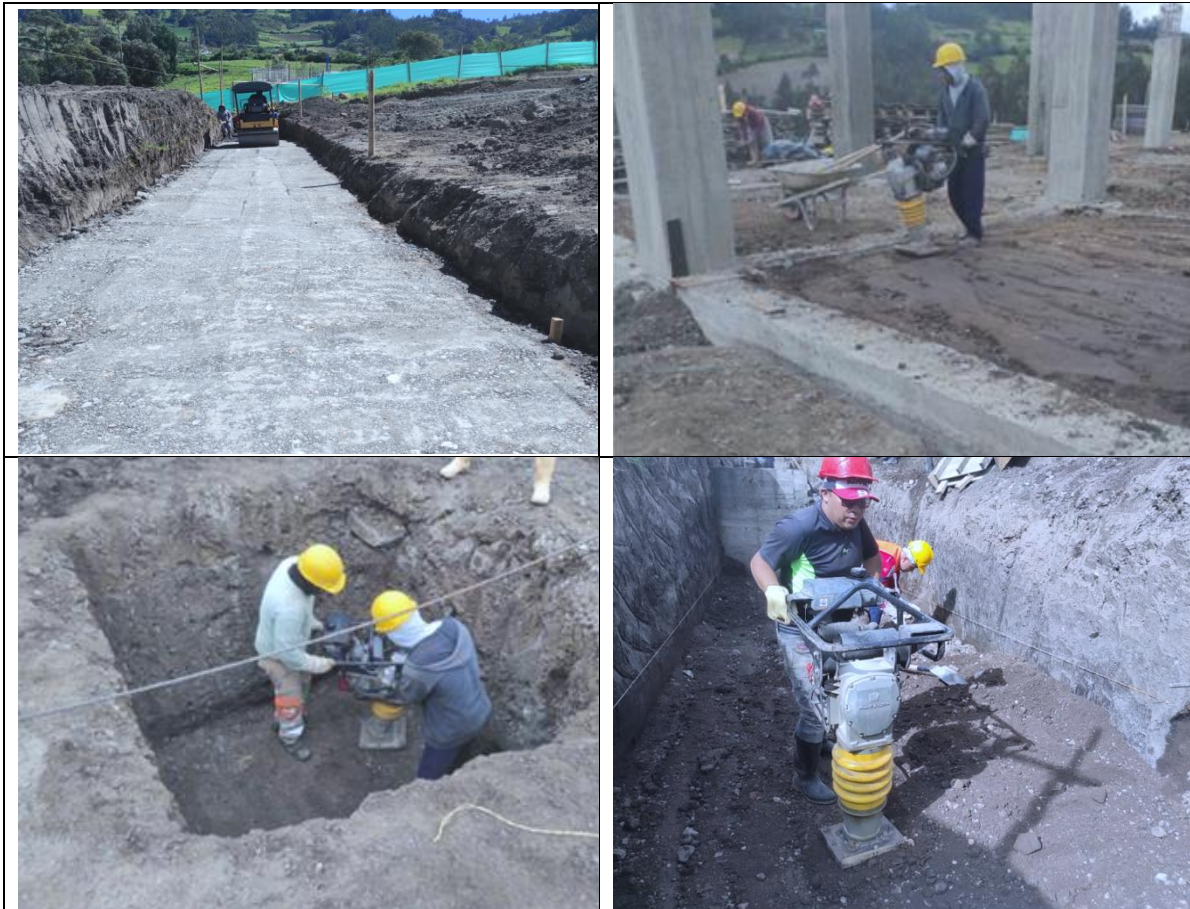
Figura 32 fotografías ilustrativas, Mejoramiento en suelo-cemento
