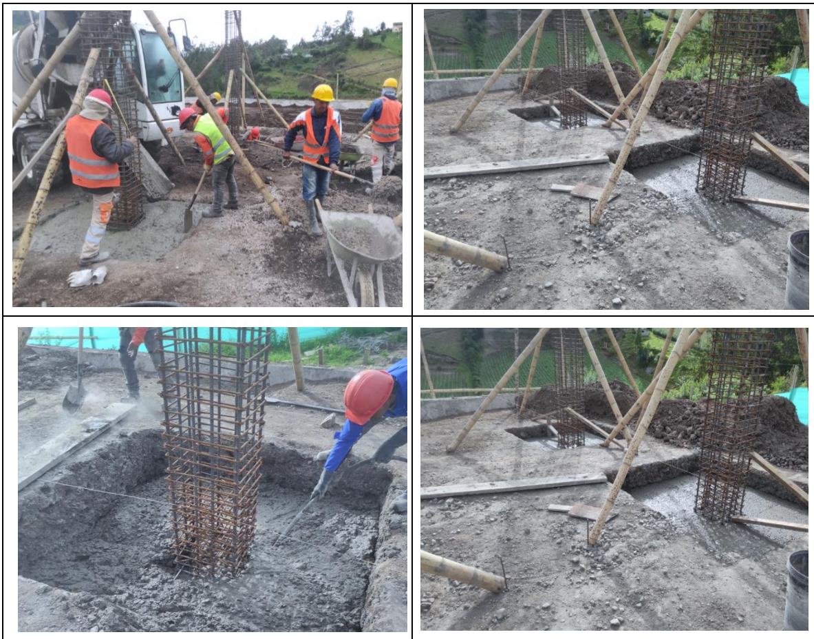
Figura 17 Fotografías ilustrativas, Zapatas en concreto de 3000 psi.
