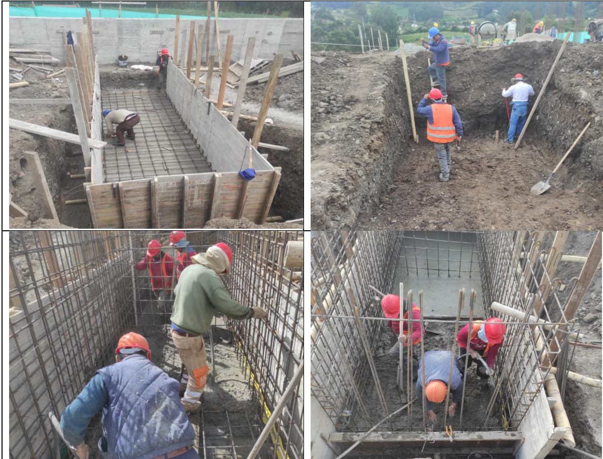
Figura 48 fotografías ilustrativas, tanque en concreto 3000 psi
