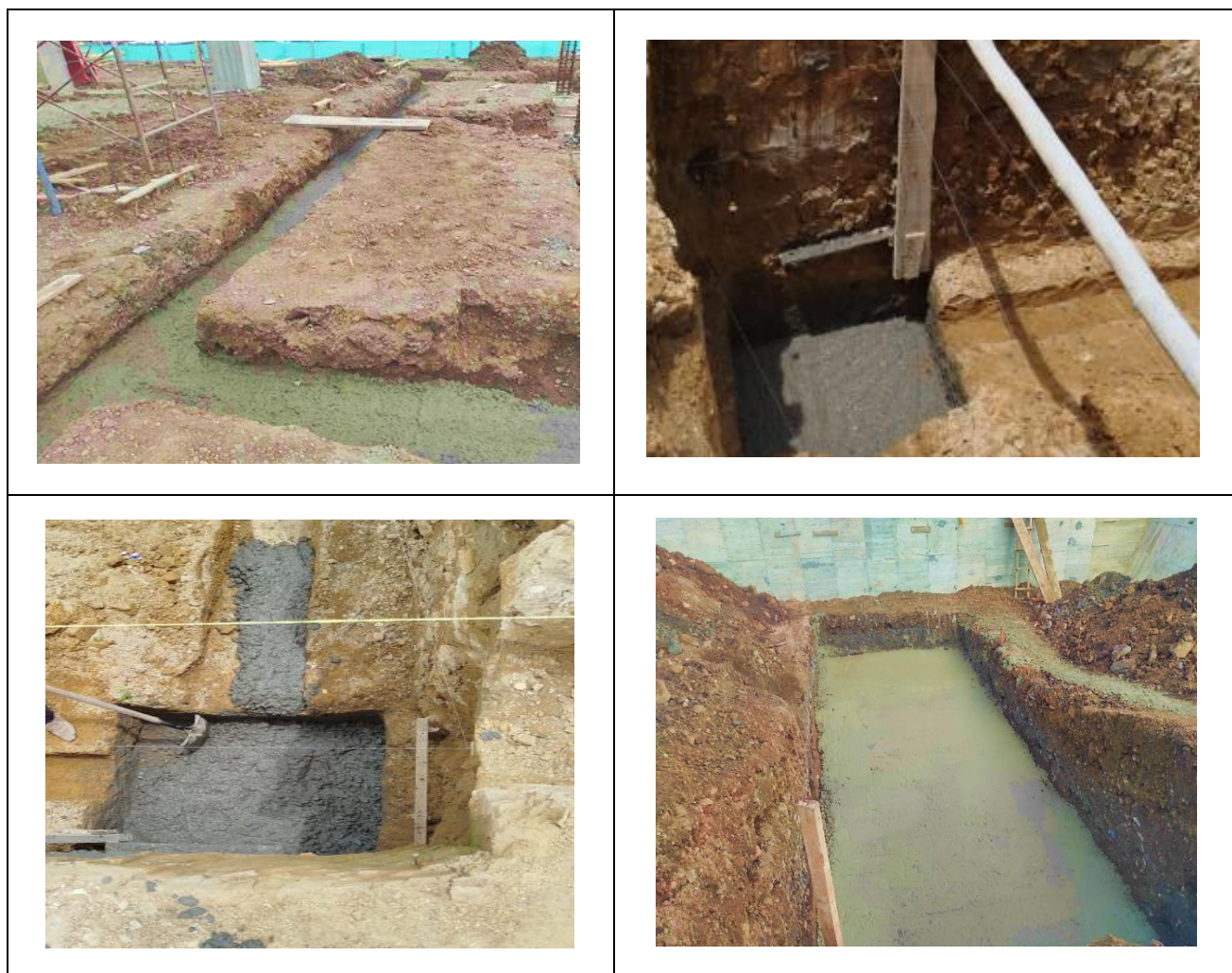
Figura 14 Fotografías ilustrativas, Solado en concreto pobre.
