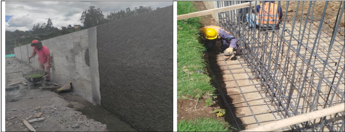
Figura 40 fotografías ilustrativas, Muro de contención
