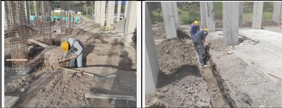
Figura 12 Fotografías ilustrativas, Excavaciones manuales sin clasificar
