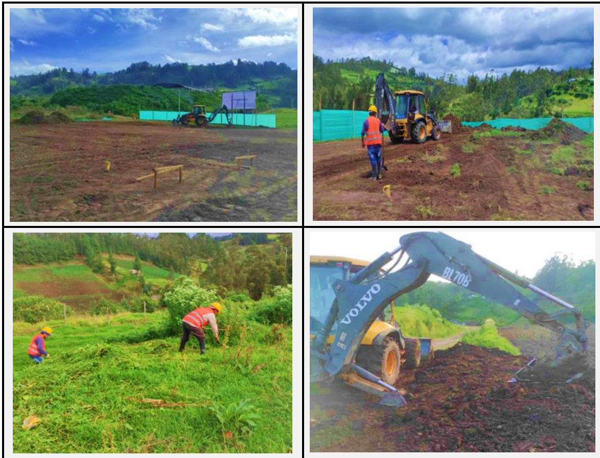
Figura 7 Fotografías ilustrativas, Descapote y limpieza del terreno.
