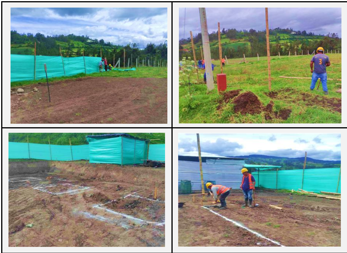
Figura 3 Localización y replanteo.
