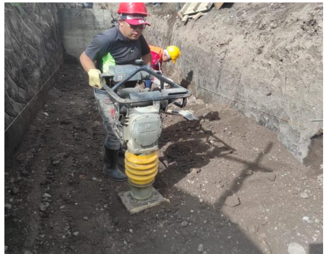
Figura 15 Fotografías ilustrativas, Relleno en recebo compacto.
