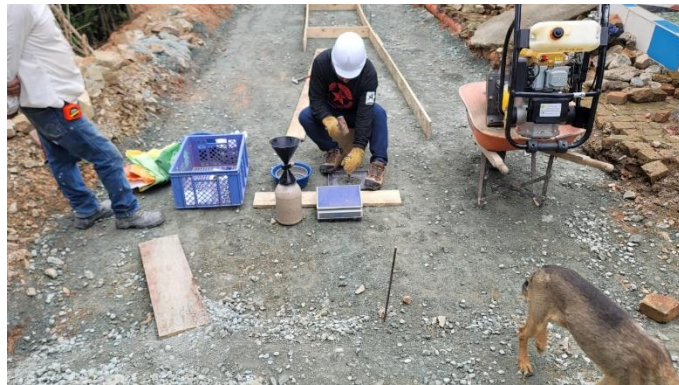
Ilustración 11 Ensayo de densidad del material compactado
