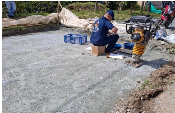
Ilustración 19 Subbase granular segundo tramo
