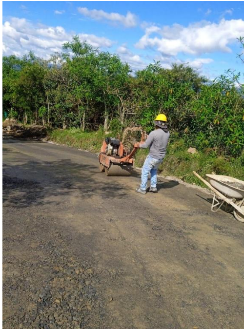
Ilustración 42 Actividad ejecutada en campo correspondiente a un ítem de un APU
