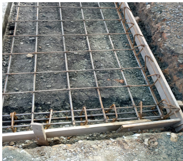
Ilustración 14 Instalación de acero de refuerzo
