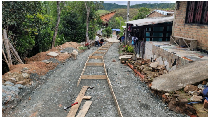
Ilustración 10 Primer tramo en ejecución
