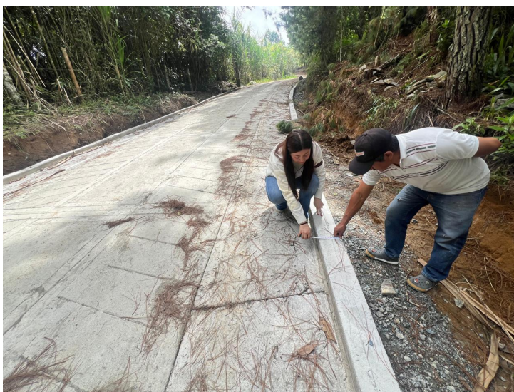
Ilustración 37 Medición de ancho de bordillo vereda Bajo Cauca
