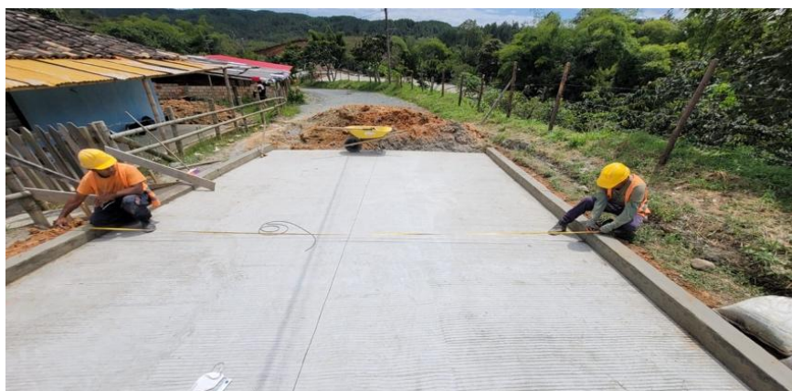
Ilustración 23 Segundo tramo en pavimento rígido ejecutado
