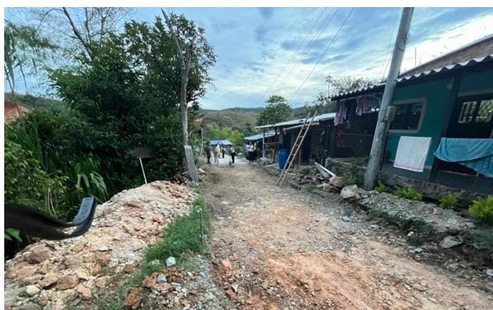
Ilustración 7 Estado inicial de la vía
