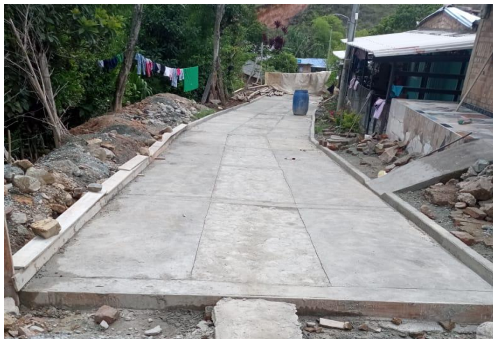
Ilustración 15 Ejecución del primer tramo en placa-huella
