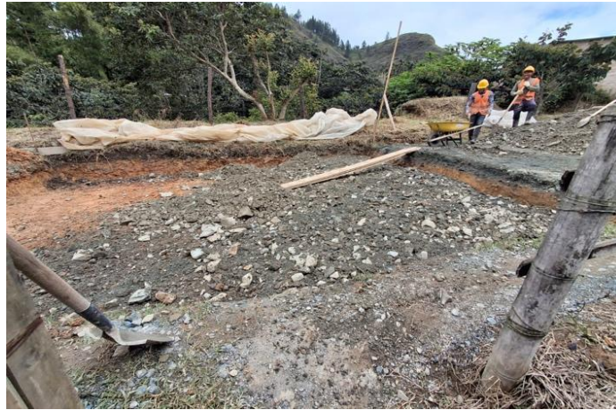
Ilustración 18 Mejoramiento de subrasante segundo tramo
