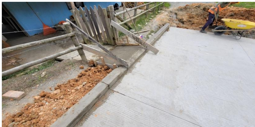
Ilustración 22 Bordillos segundo tramo en pavimento rígido
