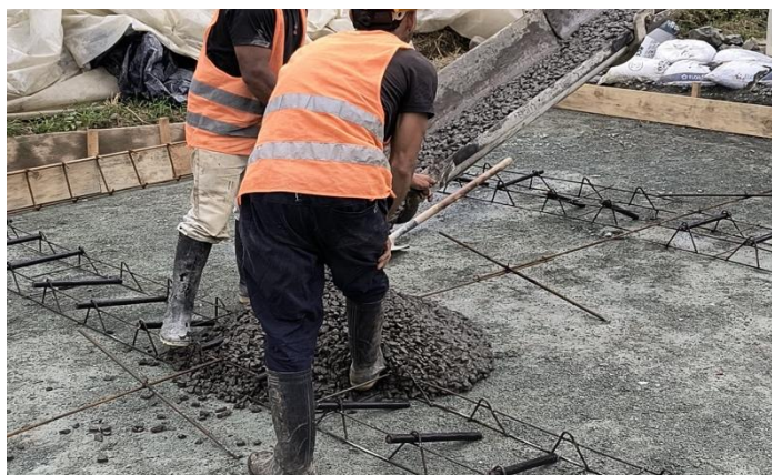
Ilustración 21 Vaciado de concreto segundo tramo en pavimento rígido
