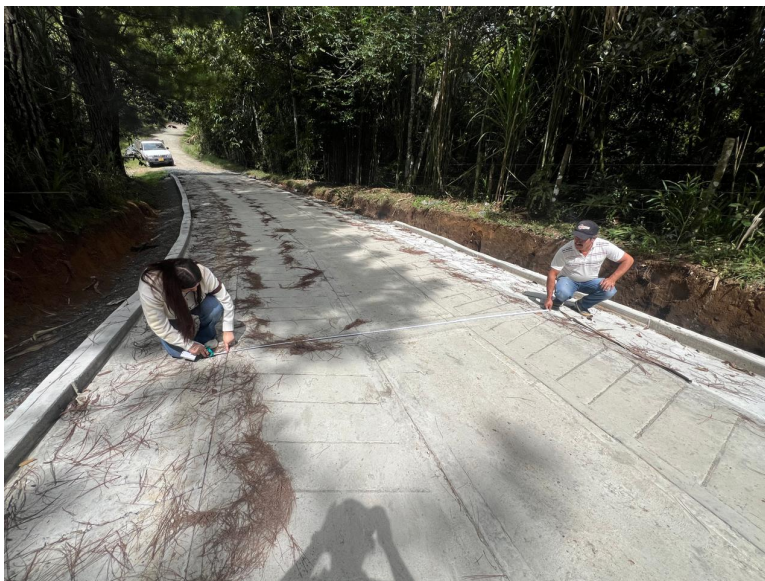
Ilustración 36 Medición de ancho de la sección típica vereda Bajo Cauca
