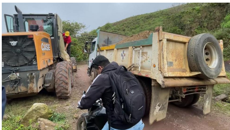
Ilustración 15. Trabajo de la maquinaria.
