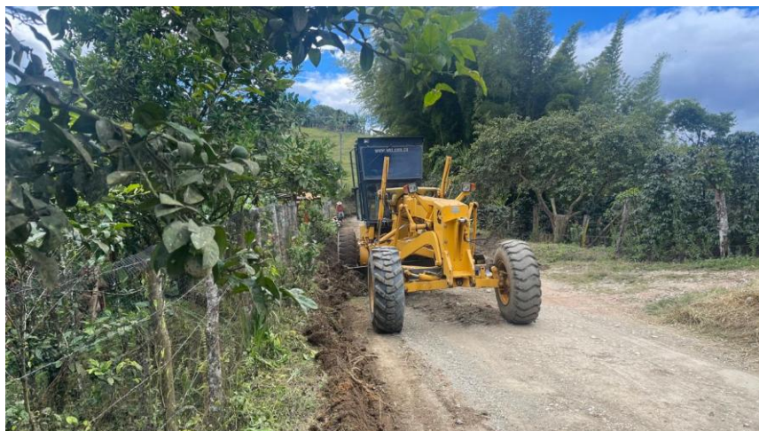
Ilustración 30. Motoniveladora realizando corte de cunetas.
