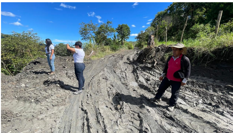
Ilustración 27. Estado de la vía.
