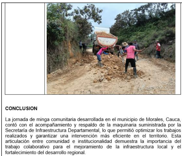
Ilustración 37. Registro fotográfico y conclusión en informe de visita.
