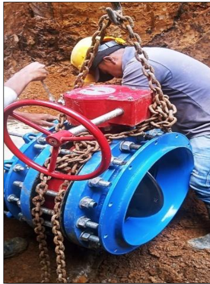
Ilustración 7-44 Válvula 20" con cierre mariposa.
