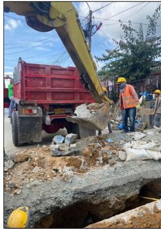
Ilustración 7-136 Retiro de escombros- Carrera 9 con 70N Fuente. Elaboración propia
