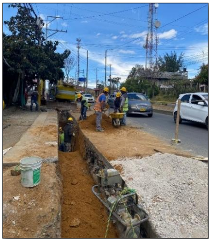
Ilustración 7-65 Excavación novena sector placer Fuente. Elaboración propia.
