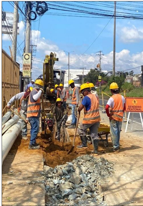
Ilustración 7-97 Relleno con tierra amarilla-carrera 9 con calle 73N Fuente. Elaboración propia.
