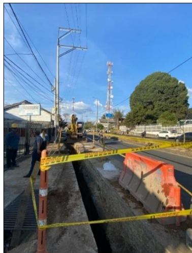
Ilustración 7-55 Señalización de área excavada Carrera 9 entre calle 71N y 72N Fuente. Elaboración propia.
