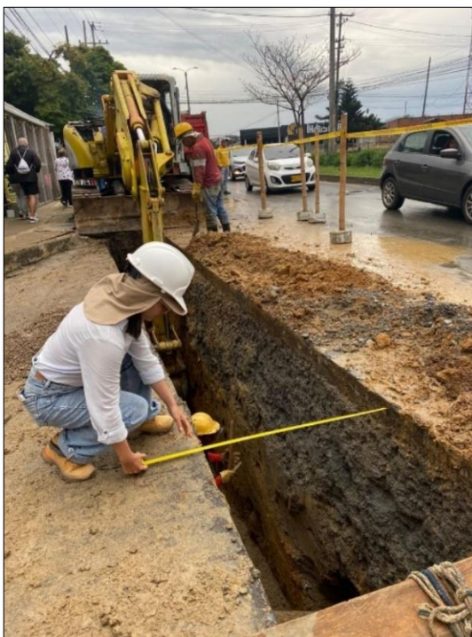
Ilustración 7-122 Toma de medidas de ancho de la excavación- Carrera 9 con 73N Fuente. Elaboración propia
