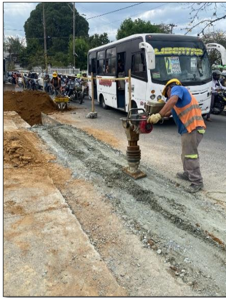
Ilustración 7-45 Compactación de base granular- carrera 9 entre calle 71N y 72N Fuente. Elaboración propia.
