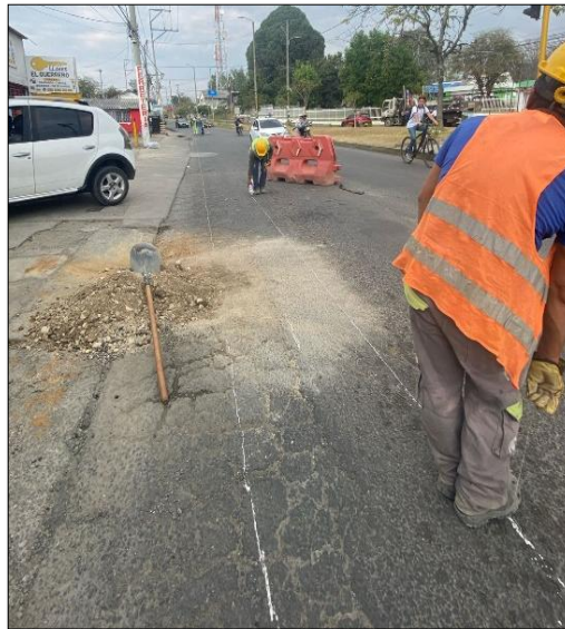
Ilustración 7-26 Replanteo Carrera 9 entre calle 70N y 71N Fuente. Elaboración propia.
