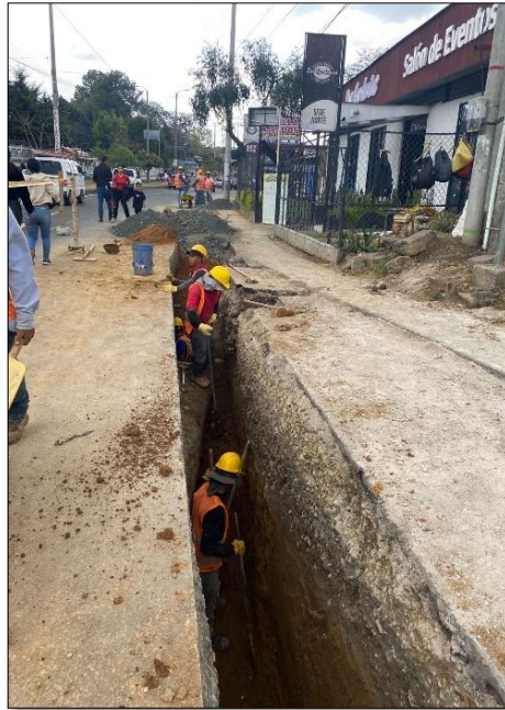
Ilustración 7-77 Excavación manual-carrera 9 entre calle 72N y 73N Fuente. Elaboración propia.
