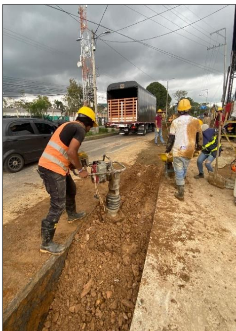
Ilustración 7-127 Compactación de base granular- Carrera 9 con 73N Fuente. Elaboración propia.
