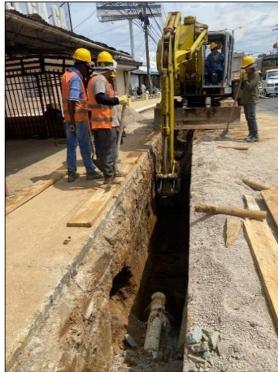
Ilustración 7-104 Excavación mecánica carrera 9 con calle 73N Fuente. Elaboración propia.
