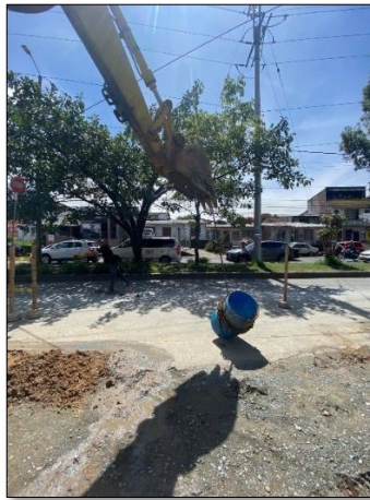
Ilustración 7-133 Retiro de accesorio codo de 20"x45° - Carrera 9 con 73N Fuente. Elaboración propia.
