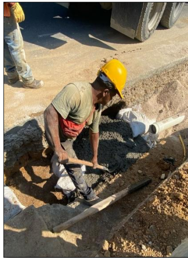
Ilustración 7-20 Anclaje de codo 20"x22° Carrera 9 entre calle 70N y 71N Fuente. Elaboración propia.
