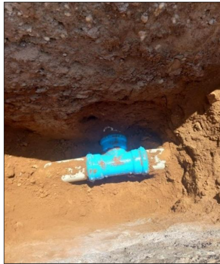
Ilustración 7-106 Instalación de TEE 6"X6"- carrera 9 con calle 73N Fuente. Elaboración propia.
