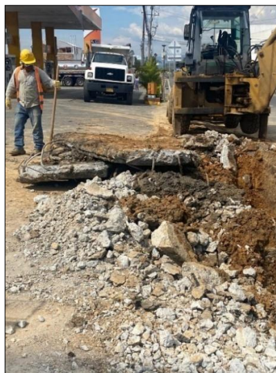
Ilustración 7-113 Demolición de pavimento rígido- carrera 9 con calle 73N Fuente. Elaboración propia
