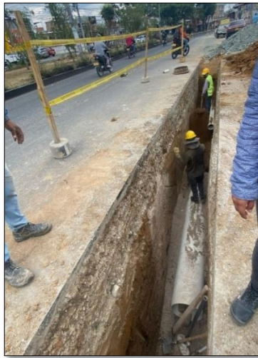
Ilustración 7-30 Relleno con tierra Carrera 9 entre calle 70N y 71N Fuente. Elaboración propia.
