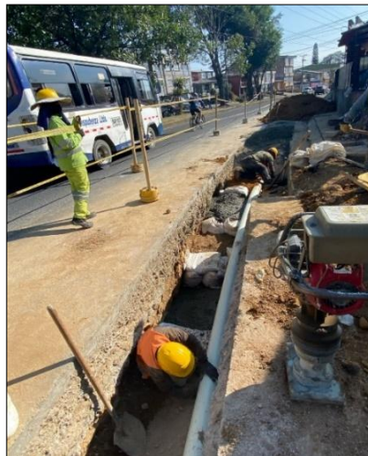
Ilustración 7-18 Instalación de tubería de 6" RDE21 Carrera 9 entre calle 70N y 71N Fuente. Elaboración propia.
