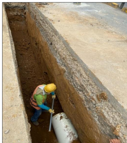
Ilustración 7-27 Excavación manual Carrera 9 entre calle 70N y 71N Fuente. Elaboración propia.
