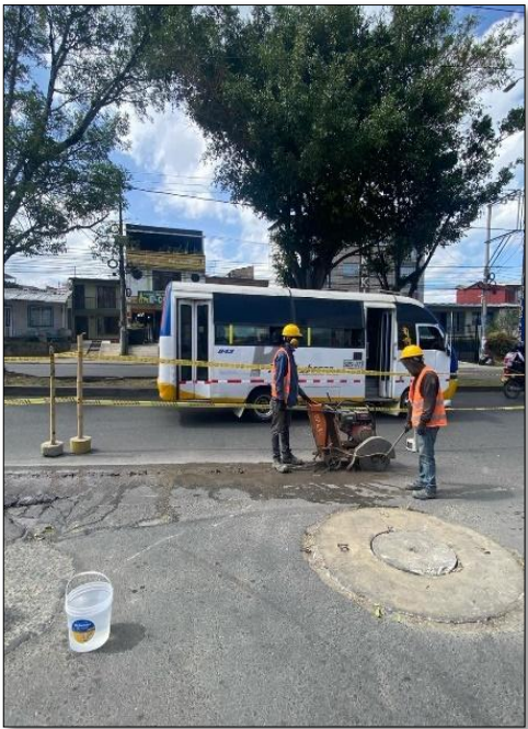
Ilustración 7-6 Corte de pavimento Carrera 9 con calle 70N Fuente. Elaboración propia.
