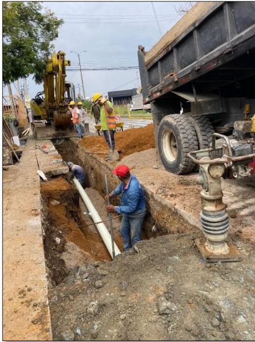
Ilustración 7-105 Instalación de tubería de 6" RDE 21 carrera 9 con calle 73N Fuente. Elaboración propia.
