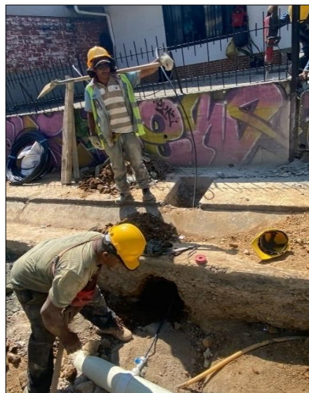
Ilustración 7-21 Conexión domiciliar Carrera 9 entre calle 70N y 71N Fuente. Elaboración propia.
