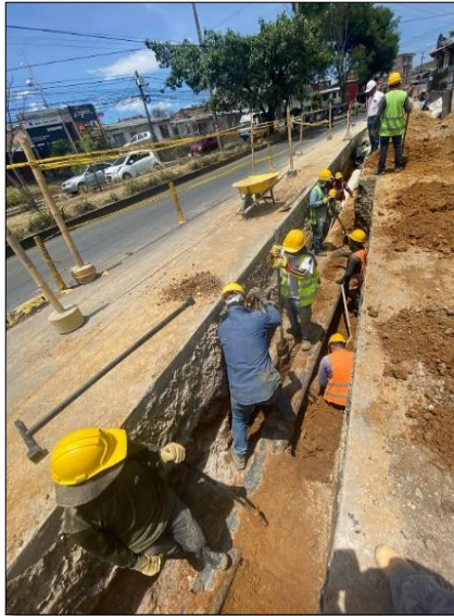
Ilustración 7-17 Excavación manual Carrera 9 entre calle 70N y 71N Fuente. Elaboración propia.
