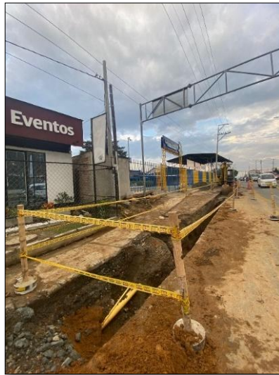
Ilustración 7-82 Señalización de área excavada -carrera 9 entre calle 72N y 73N Fuente. Elaboración propia.
