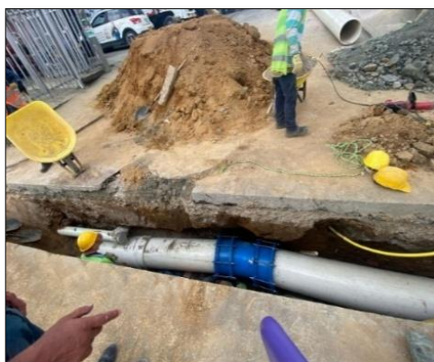
Ilustración 7-9 Instalación de codo de 20"x22° con dos dresser- Carrera 9 entre calle 70N. Fuente. Elaboración propia.
