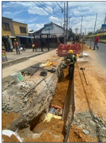
Ilustración 7-54 Compactación de capa de tierra Carrera 9 entre calle 71N y 72N Fuente. Elaboración propia.
