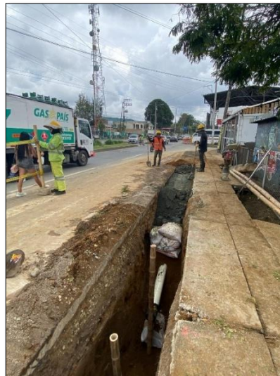
Ilustración 7-101 Espacio para instalar la reducción- carrera 9 con calle 73N Fuente. Elaboración propia.
