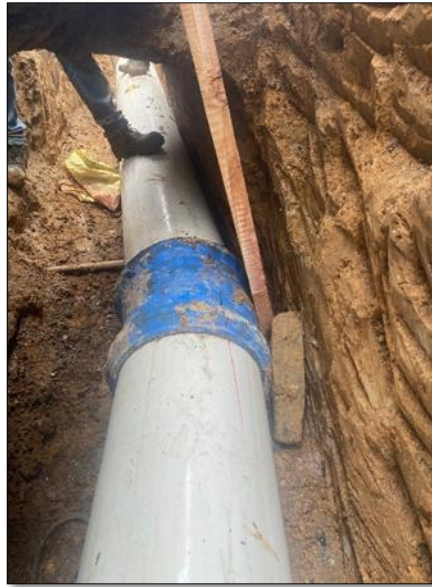
Ilustración 7-79 Instalación de codo de 14"x11" -carrera 9 entre calle 72N y 73N Fuente. Elaboración propia.
