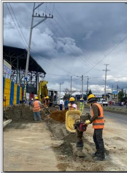
Ilustración 7-81 Compactación de base granular -carrera 9 entre calle 72N y 73N Fuente. Elaboración propia.
