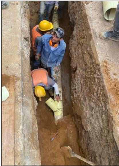
Ilustración 7-103 Instalación de silla YEE 6X8- carrera 9 con calle 73N Fuente. Elaboración propia.
