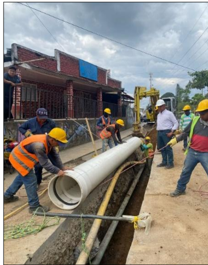
Ilustración 7-8 Instalación de tubería carrera 9 entre calle 70Ny 71N Fuente. Elaboración propia.
