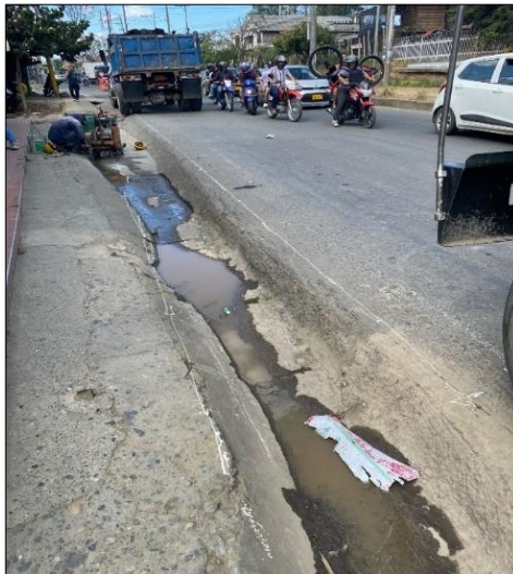
Ilustración 7-39 Cimbrado- carrera 9 entre calle 71N y 72N Fuente. Elaboración propia.
