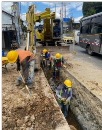
Ilustración 7-56 Demolición de anclaje de tubería existente Carrera 9 entre calle 71N y 72N Fuente. Elaboración propia.
