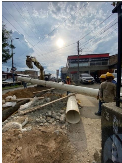
Ilustración 7-134 Retiro de tubería de 20" RDE 21- Carrera 9 con 70N Fuente. Elaboración propia.
