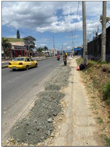
Ilustración 7-11 Compactación de base granular Carrera 9 entre calle 70N y 71N Fuente. Elaboración propia.
