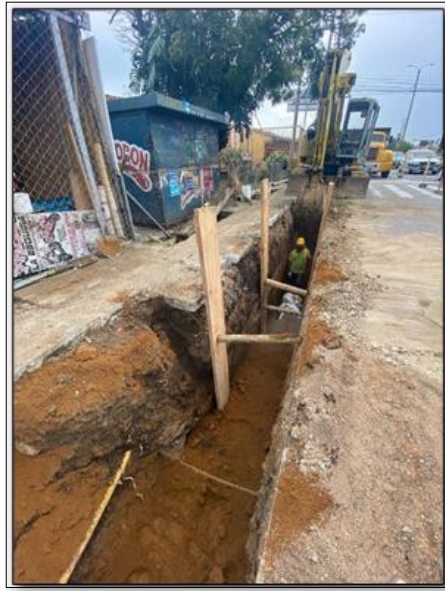
Ilustración 7-94 Excavación mecánica carrera 9 con calle 73N Fuente. Elaboración propia.
