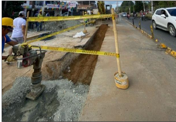
Ilustración 7-98 Señalización de área de trabajo excavada-carrera 9 con calle 73N Fuente. Elaboración propia.
