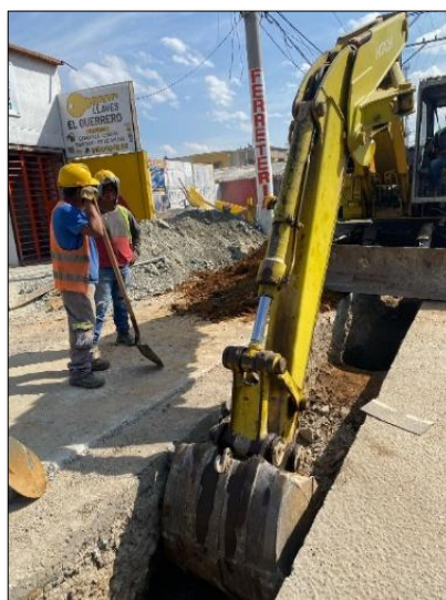
Ilustración 7-40 Excavación mecánica-Carrera 9 entre calle 71N y 72N Fuente. Elaboración propia.
