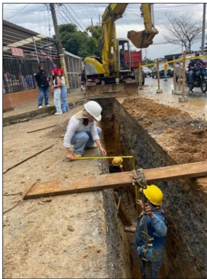
Ilustración 7-122 Toma de medidas de ancho de la excavación- Carrera 9 con 73N Fuente. Elaboración propia
