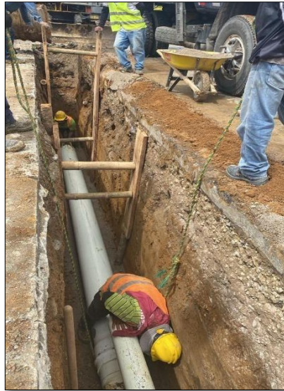
Ilustración 7-95 Instalación de tubería de 14" RDE 21. carrera 9 con calle 73N Fuente. Elaboración propia.
