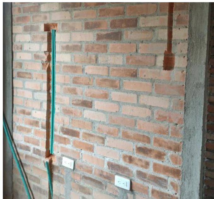
Ilustración 26: Puntos de tomacorriente e interruptor.
