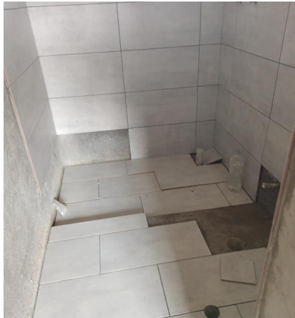
Ilustración 53: Enchape de piso y pared en baño principal.
