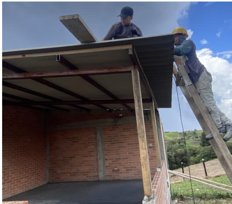
Ilustración 39: Montaje de cubierta en zona de juegos
