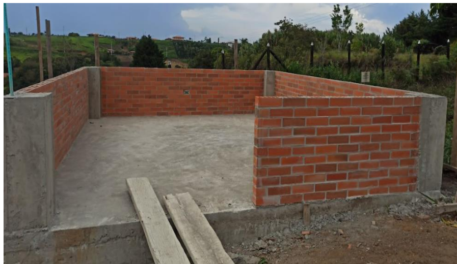
Ilustración 34: Fundición de columnetas en zona de gimnasio
