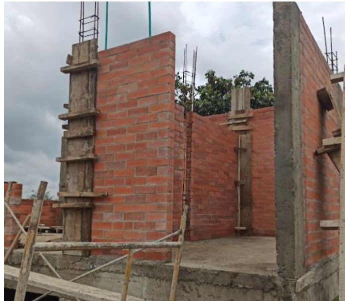
Ilustración 33: Fundición de columnetas en zona de juegos.
