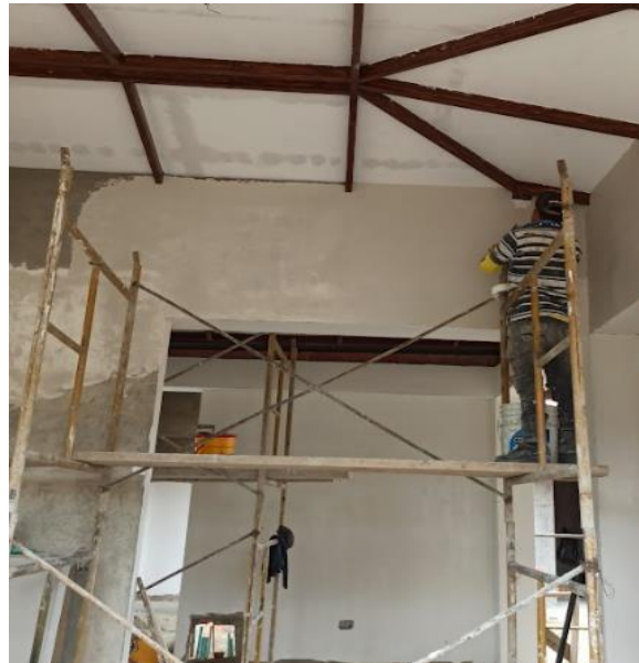
Ilustración 46: Estucado en zona de sala- comedor
