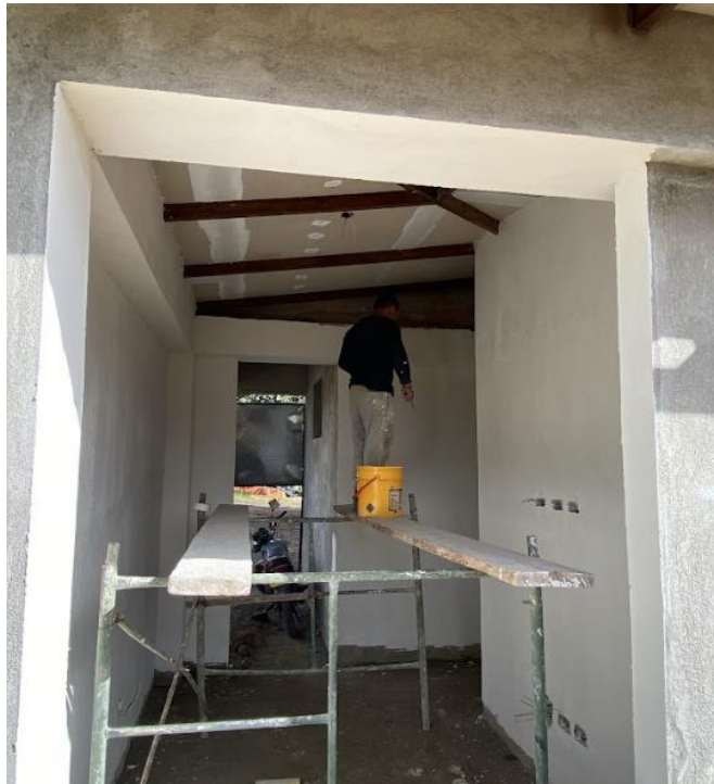
Ilustración 45: Estucado de habitación auxiliar
