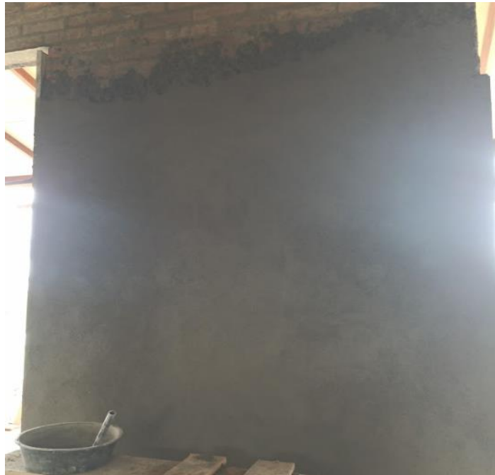
Ilustración 43: Repello muro parte posterior
