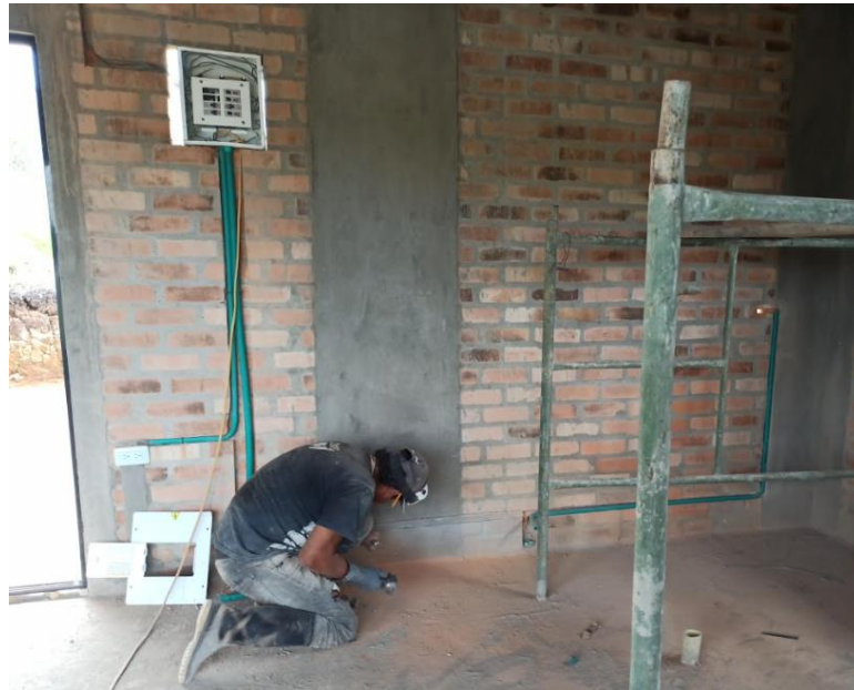
Ilustración 26: Puntos de tomacorriente e interruptor.
