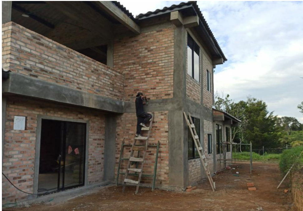
Ilustración 19: Estado inicial de la obra La suiza (posterior)
