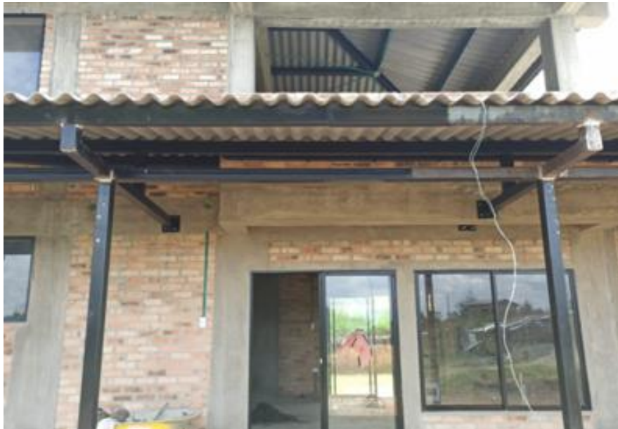
Ilustración 17: Estado inicial de obra La suiza.
