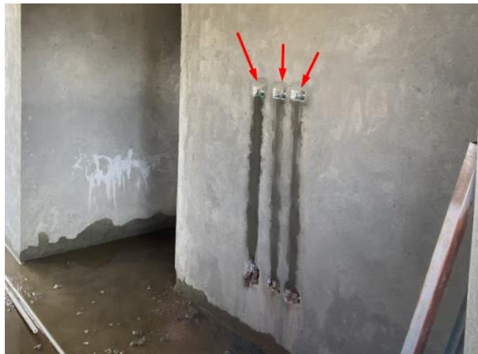
Ilustración 23: Puntos de televisión, internet y toma corriente.
