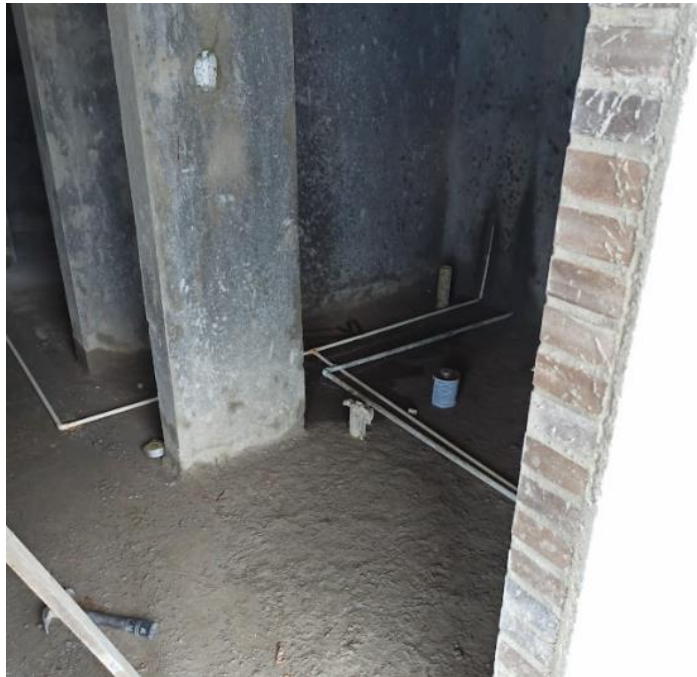
Ilustración 29: Conexión hidráulica.
