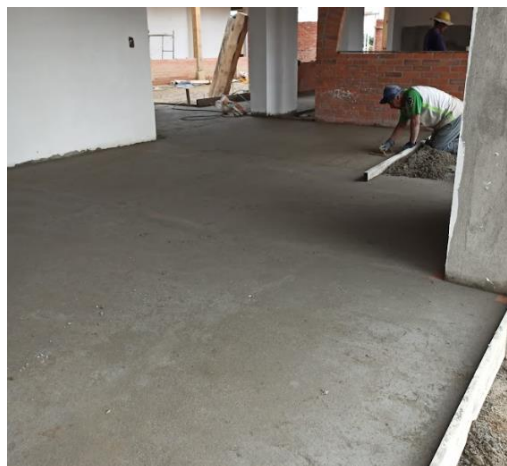
Ilustración 47: Afinado de piso en zona sala - comedor
