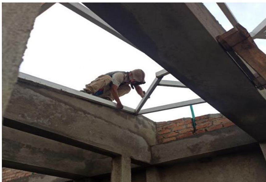
Ilustración 35: Instalación de perlines.
