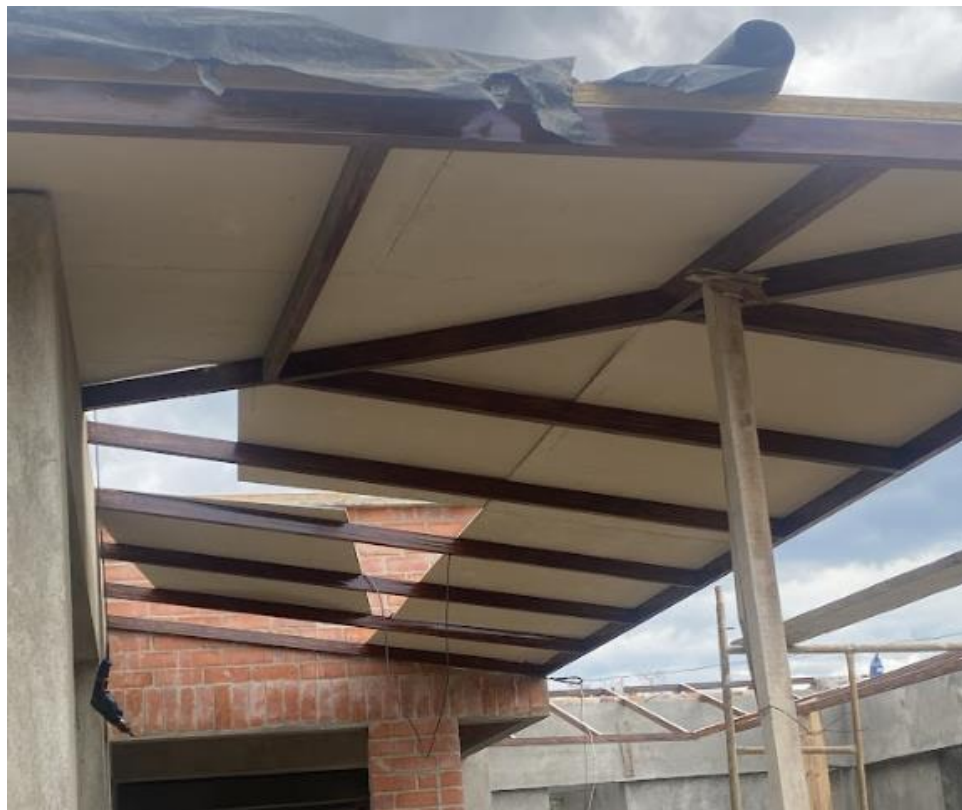
Ilustración 37: Instalacion de board
