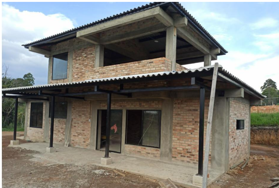
Ilustración 18: Estado inicial de obra La suiza (frontal)
