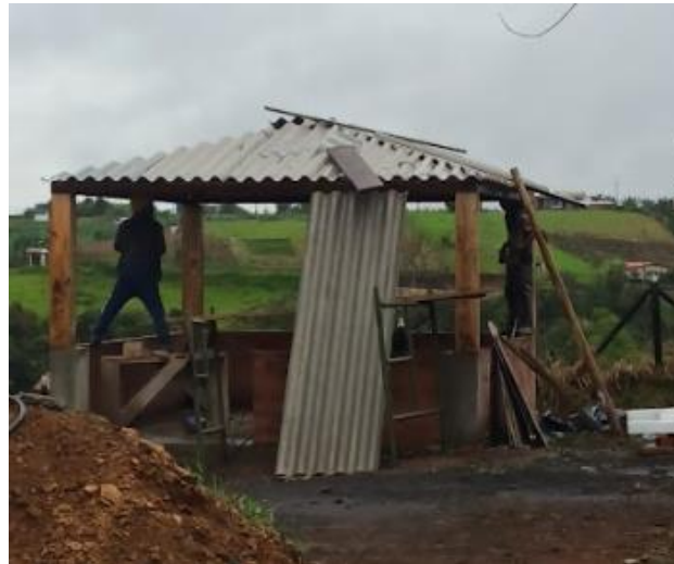
Ilustración 40: Montaje terminado de cubierta y perlines zona de gimnasio.
