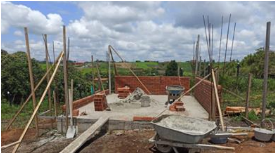
Ilustración 20: Levantamiento de muros bajos en la zona de gimnasio.
