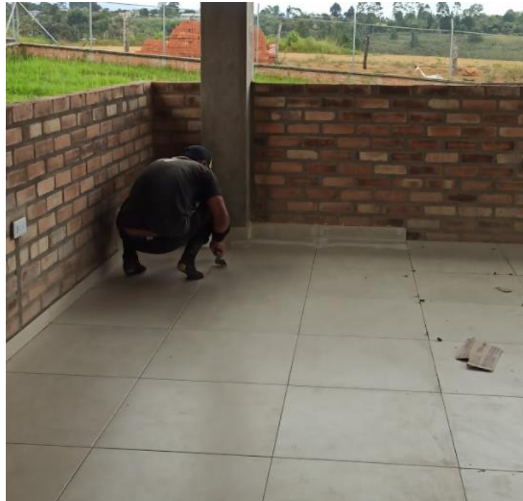
Ilustración 51: Enchape de piso y guardaescoba en zona de terraza.
