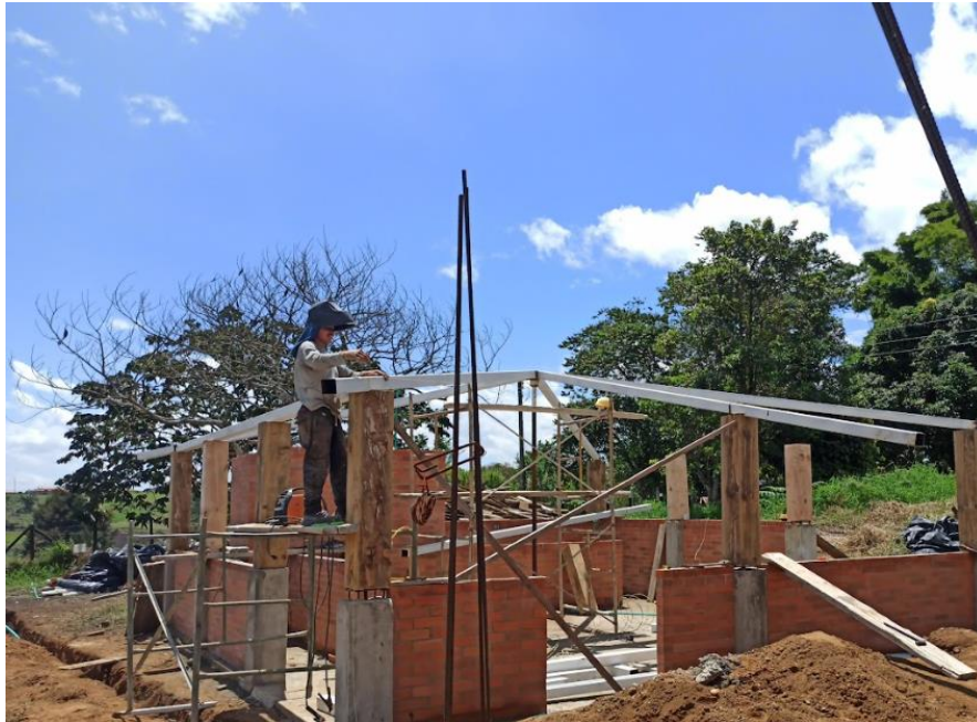
Ilustración 38: Montaje de perlineria en zona social.
