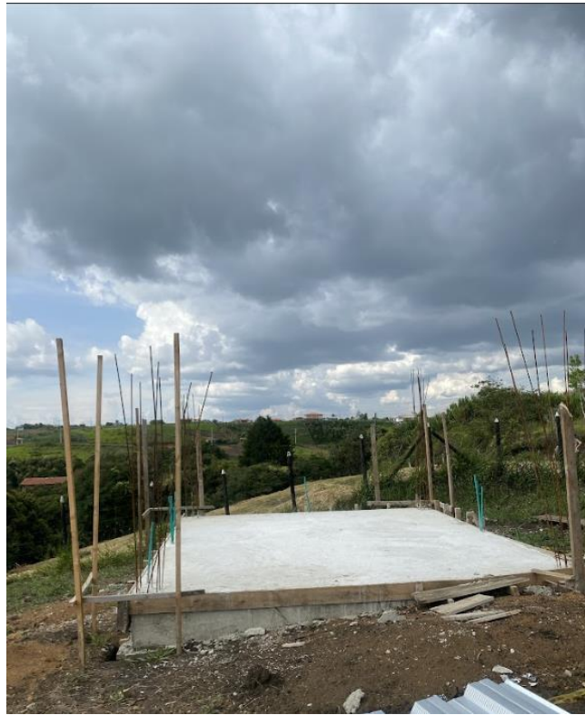
Ilustración 15: Estado inicial de zona de gimnasio.
