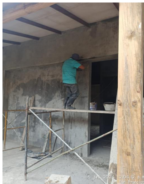
Ilustración 42: Repello de carteras
