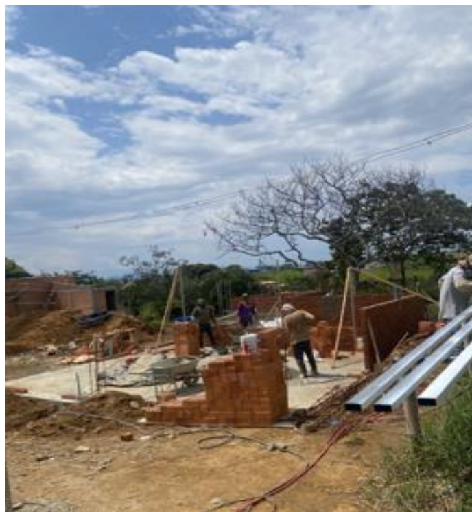
Ilustración 21: Levantamiento de muros en zona social.
