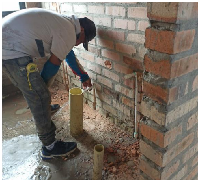
Ilustración 30: Conexión hidráulica y sanitaria.
