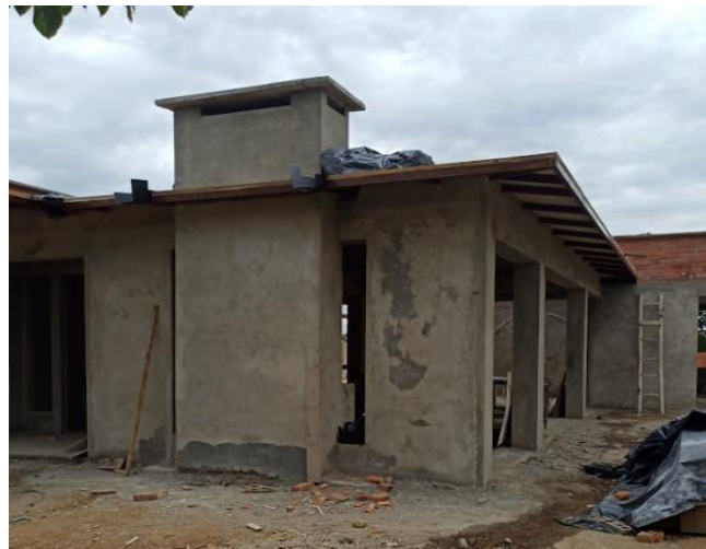
Ilustración 41: Repello de muros zona lateral
