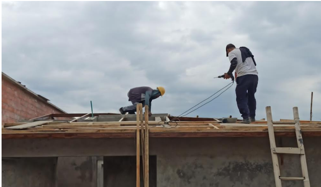
Ilustración 36: Instalacion de teja de fibrocemento (amarras)
