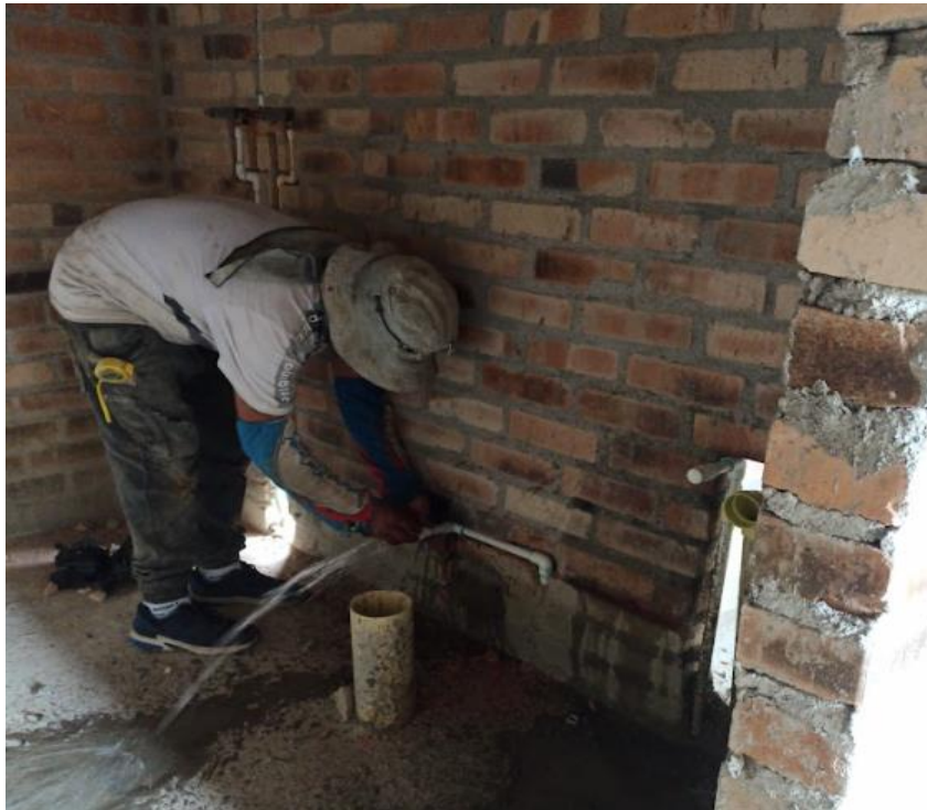
Ilustración 31: Pruebas de conexión hidráulica y sanitaria
