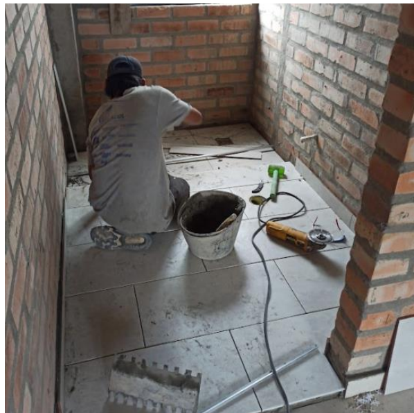
Ilustración 50: Enchape de piso en zona de baño social.
