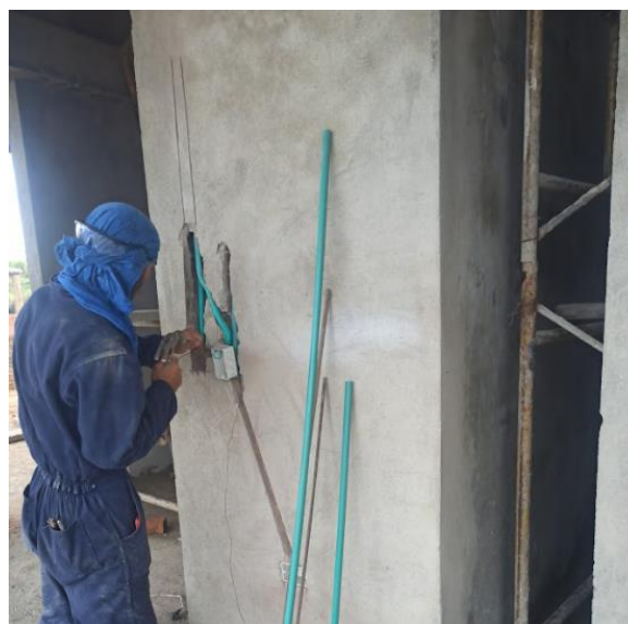
Ilustración 24: Interruptor y toma corriente.
