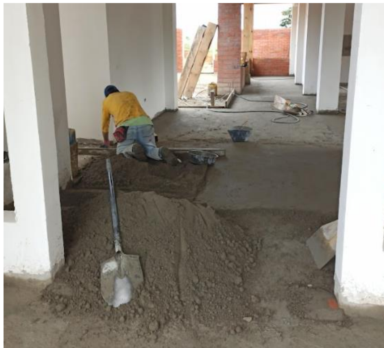
Ilustración 49: Afinado de piso en acceso principal
