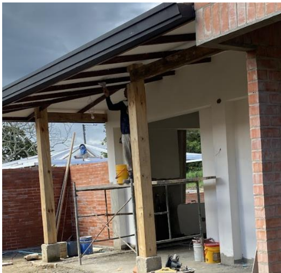
Ilustración 44:Estucado en board
