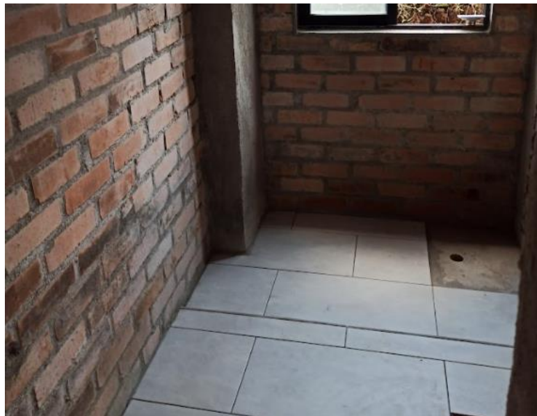
Ilustración 54: Enchape de baño auxiliar segundo piso.
