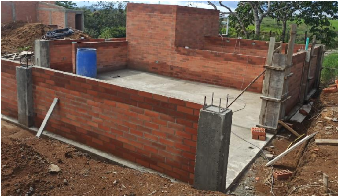
Ilustración 32: fundición de columnetas en zona social.
