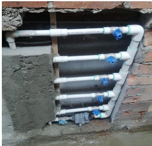
Sistema de medición de consumo y válvulas de control por unidad funcional
