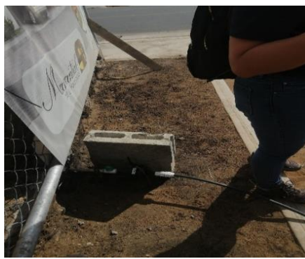
Excavacion para caja de inspeccion
