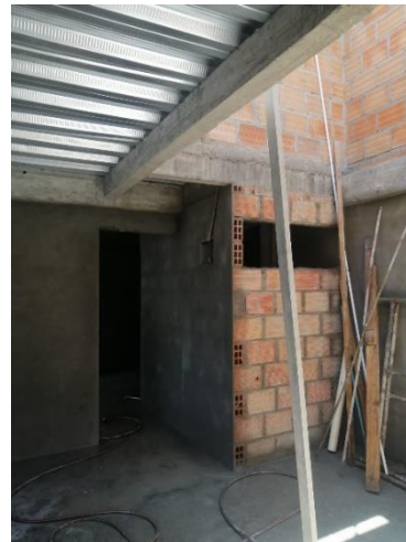
Avance de obra
