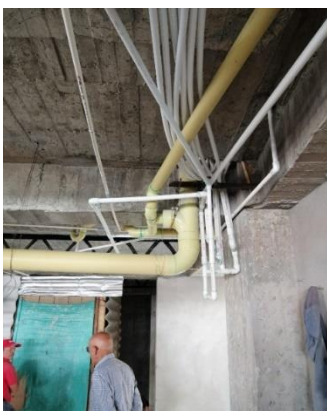
Instalación red sanitaria e hidráulica por debajo de la losa de entepiso
