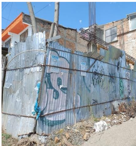
Vista exterior de la obra
