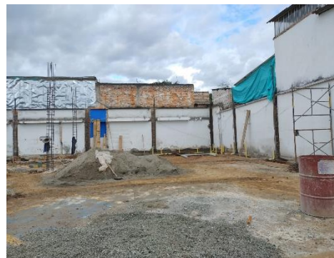
Instalación de la red sanitaria
