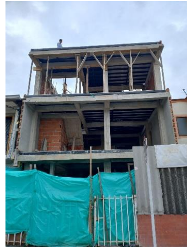
Acceso al interior de la edificación
