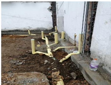
Inicio de obra local comercial
