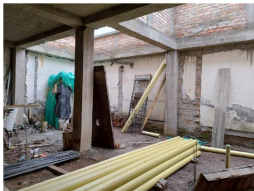
Obra en remodelación
