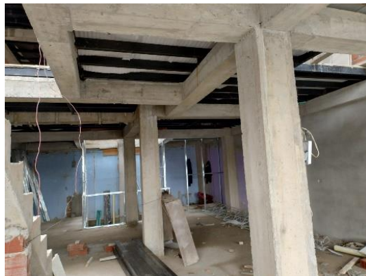
Columna y losa en construcción
