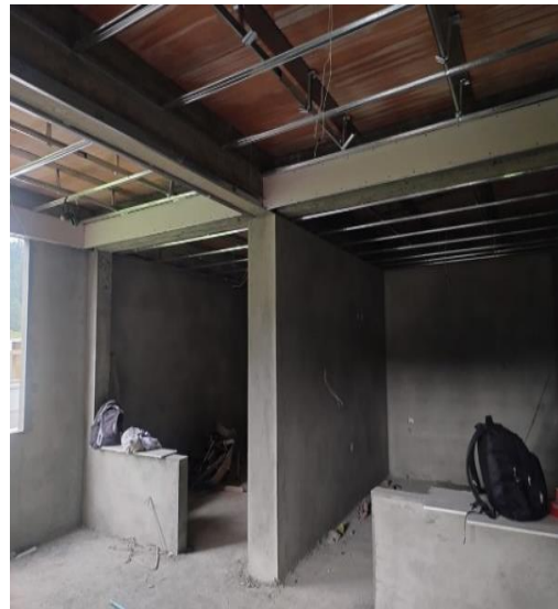
Avance de obra
