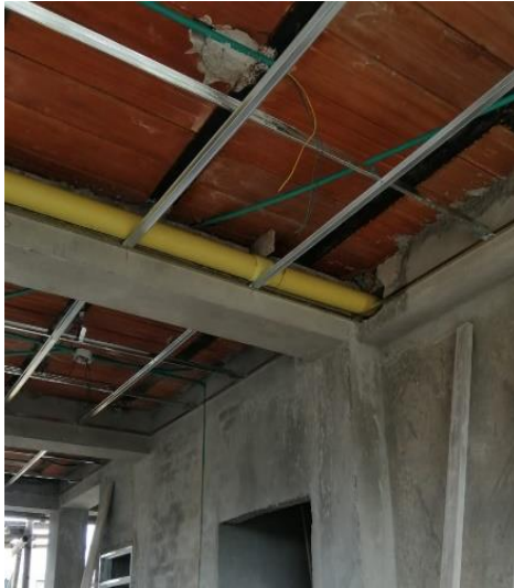
Instalación tubería sanitaria
