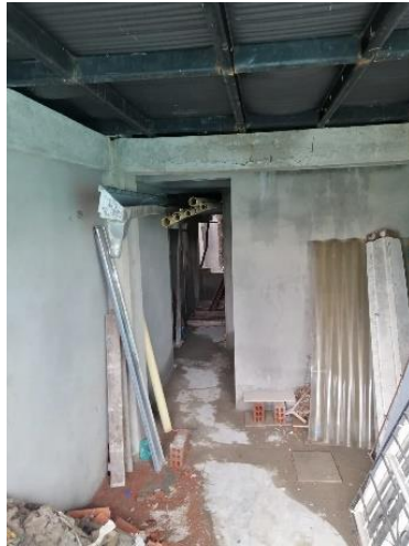
Vista frontal de la edificación en obra
