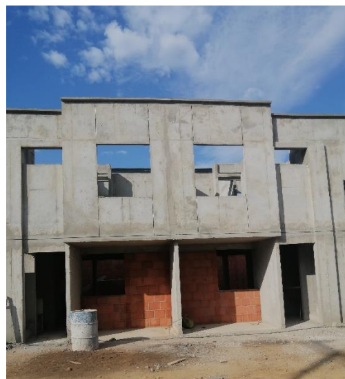
Fachada de las unidades residenciales
