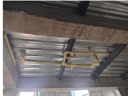
Tubería sanitaria
