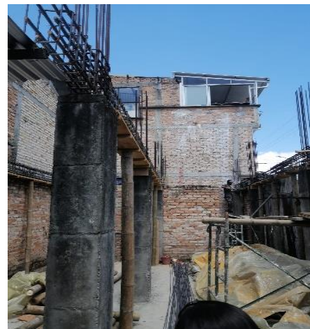
Vista interior de la obra
