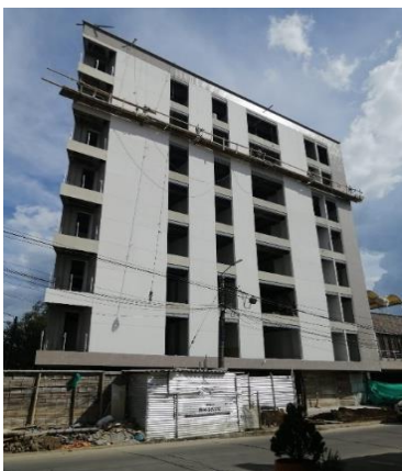
Vista frontal del edificio
