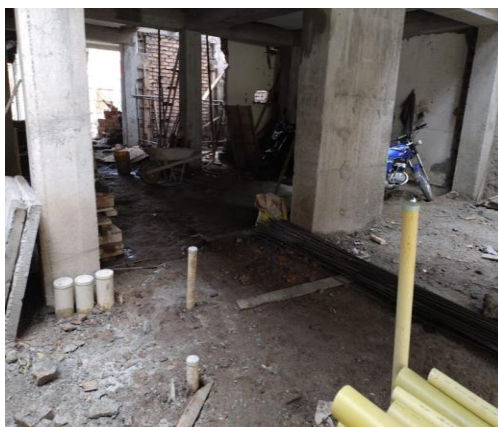
Tubería sanitaria instalada en el primer piso.
