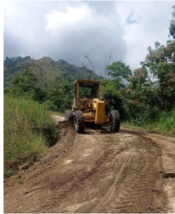
Figura 11. Perfilamiento de la subrasante
