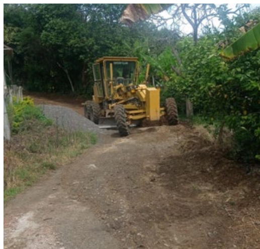
Figura 13. Perfilamiento de la subrasante
