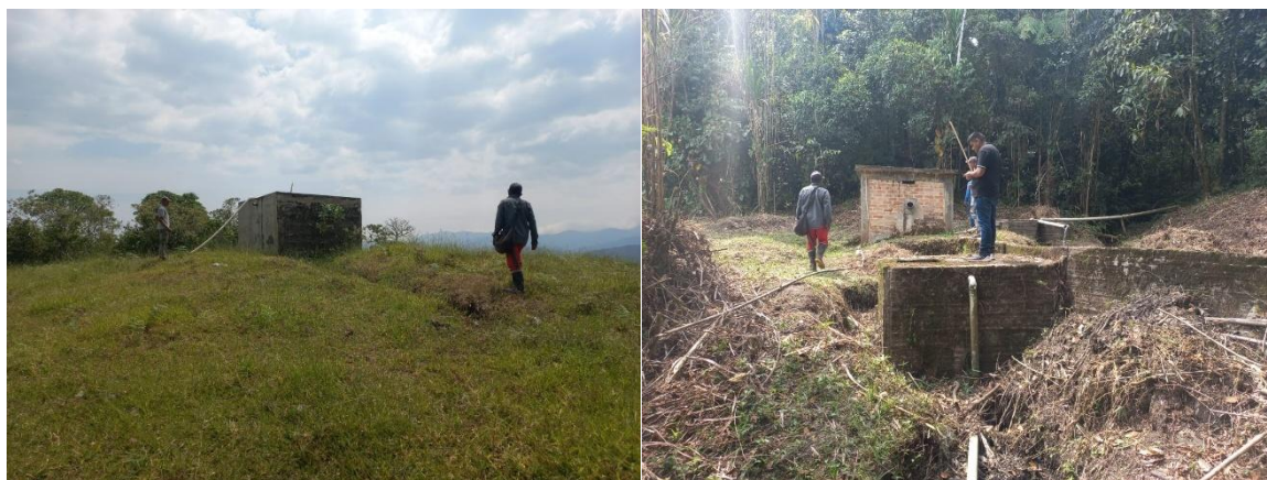
Fotografía 6 Tanque de Almacenamiento y suministro La Balastrea Fuente: Elaboración propia
