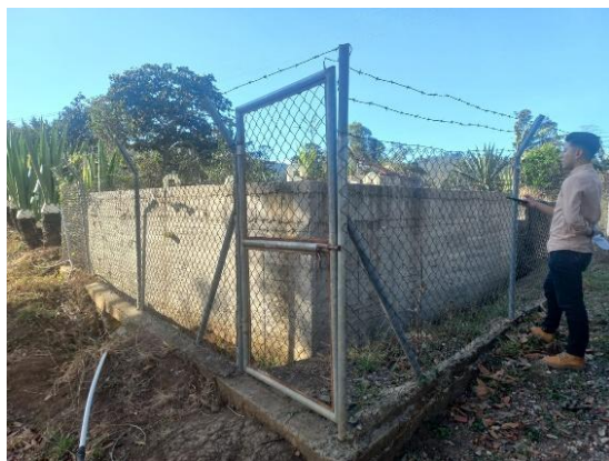
Fotografía 2 Cerramiento Tanque La Claudia Fuente: Elaboración propia
