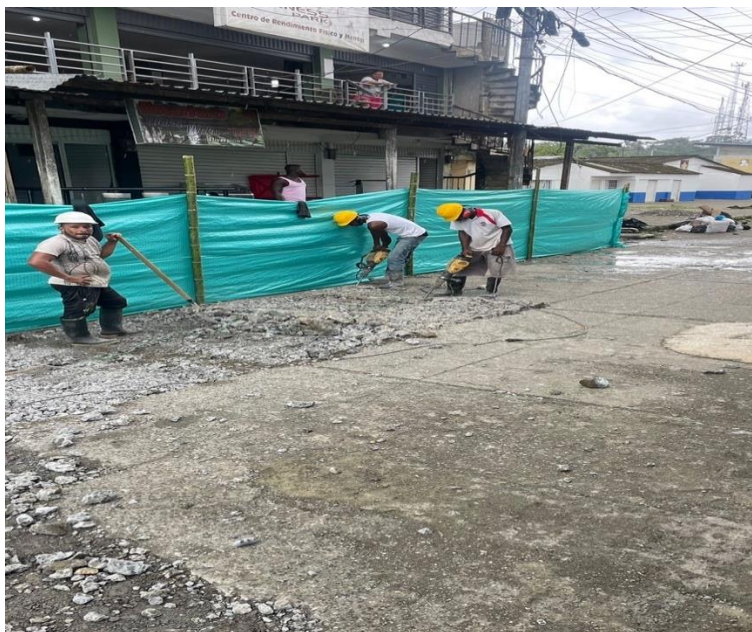
Ilustración 3 Demolición de pavimento existente
