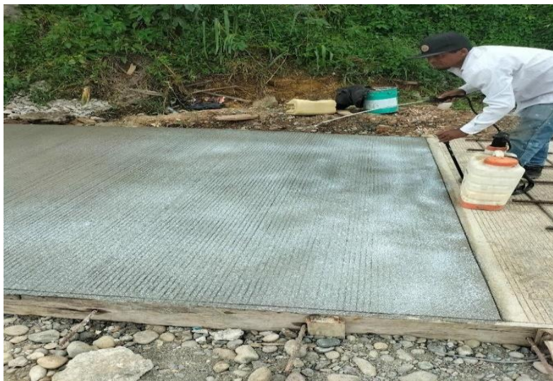
Ilustración 21 Aplicación de anti-sol
