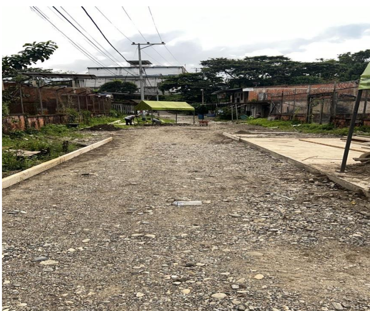
Ilustración 11 Instalación de formaleta
