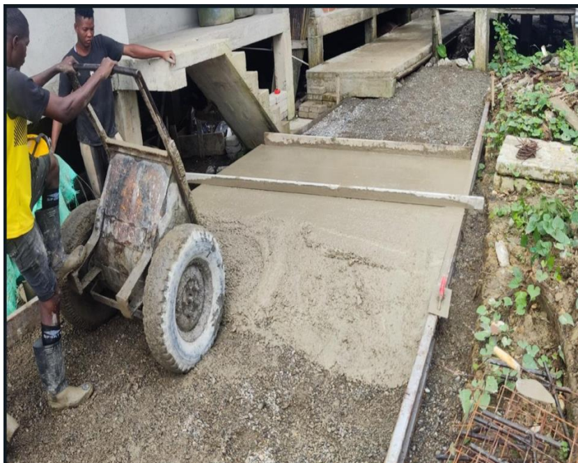
Ilustración 15 Transporte y vaciado del concreto
