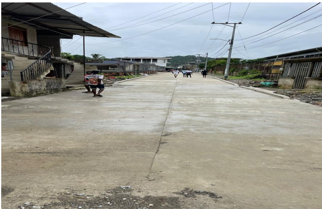
Ilustración 25 Concreto terminado calle Sendero tramo 1
