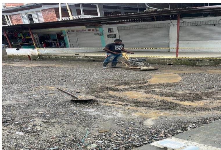
Ilustración 10 Compactación de subbase
