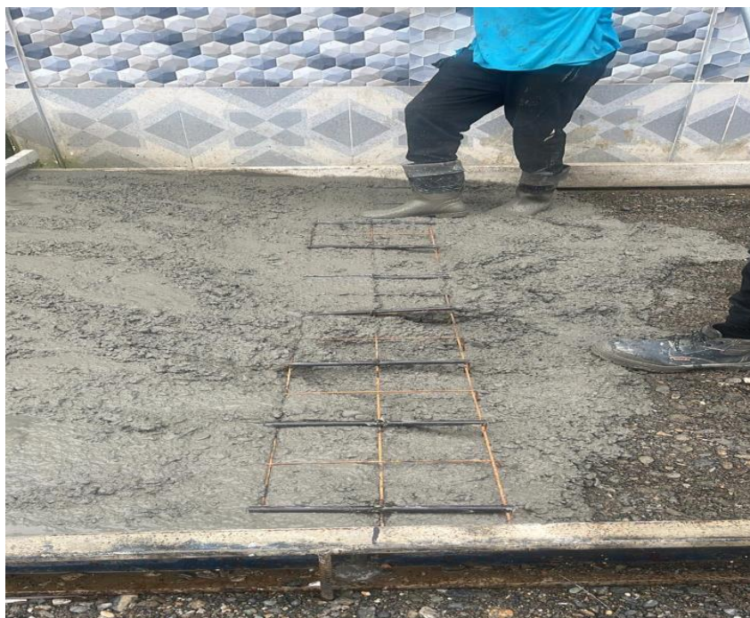
Ilustración 12 Colocación de acero de carga
