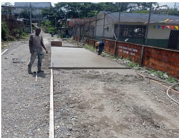
Ilustración 13 Colocación de acero de anclaje
