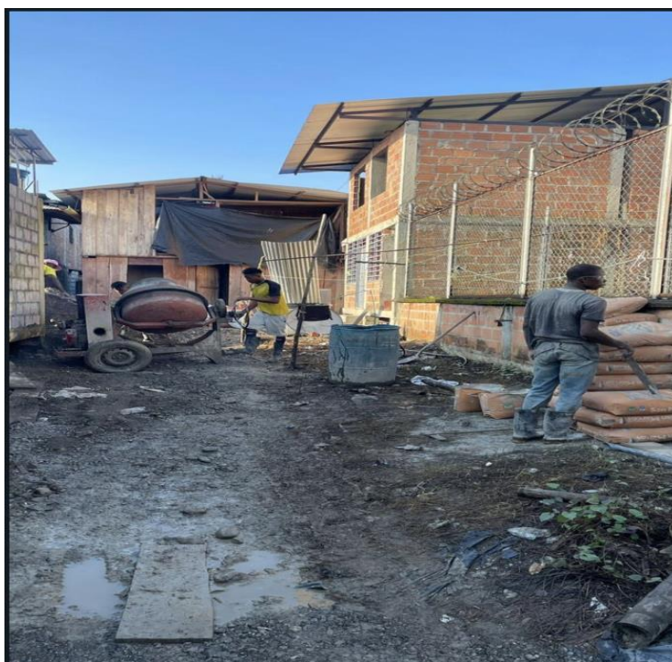
Ilustración 14 Elaboración del concreto en obra
