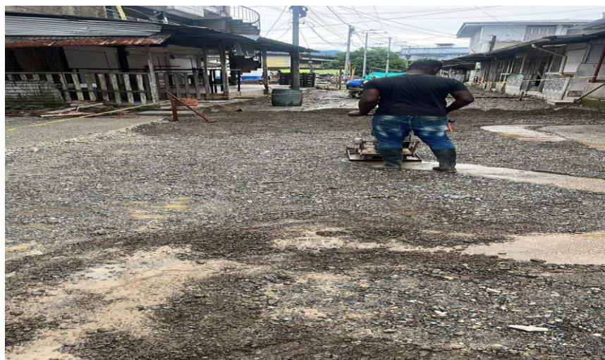
Ilustración 9 Proceso de compactación
