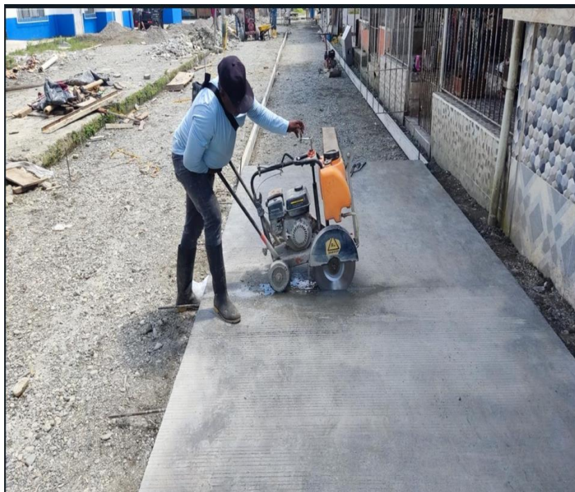
Ilustración 22 Corte de las juntas del pavimento
