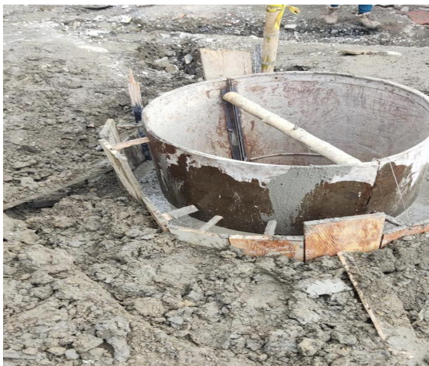
Ilustración 33 Fundición de recamara de inspección
