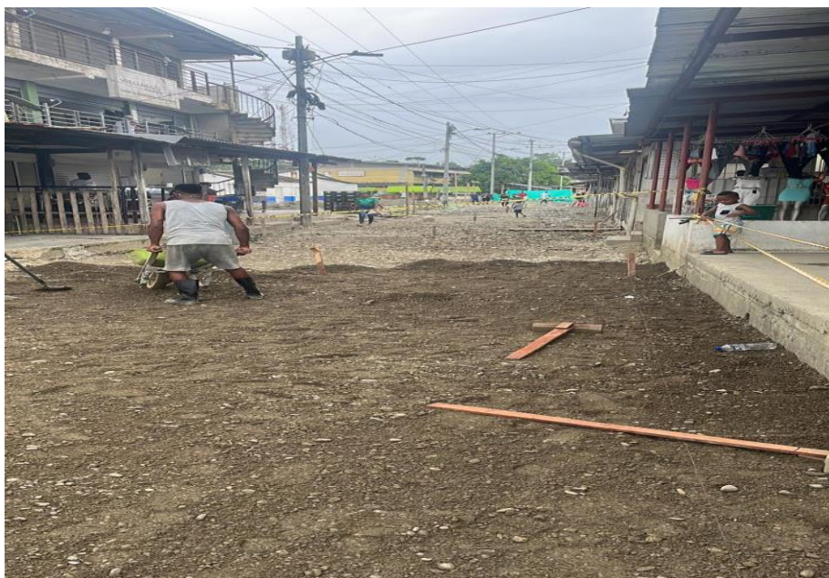
Ilustración 6 Depósito del material subbase
