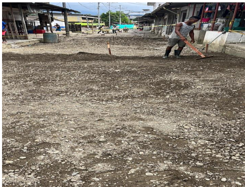
Ilustración 8 Nivelación del material para subbase
