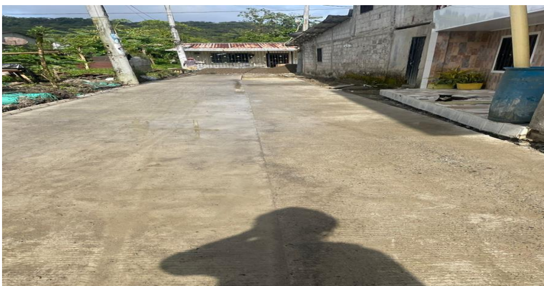
Ilustración 26 Concreto terminado calle La Gloria tramo 1
