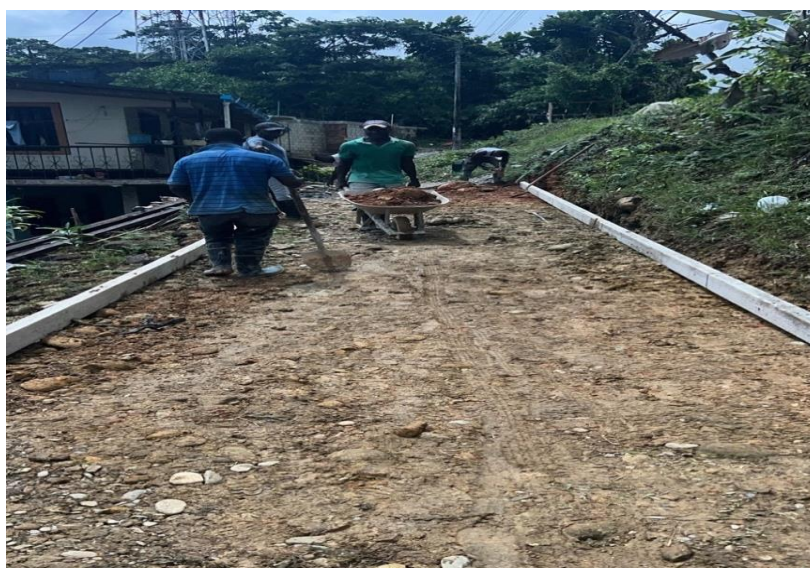
Ilustración 4 Excavación a mano
