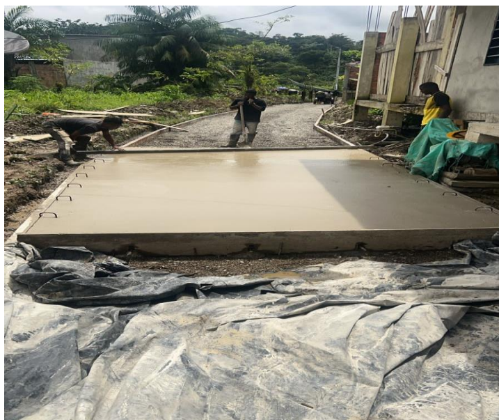
Ilustración 18 Extendido del concreto mediante el uso de codal
