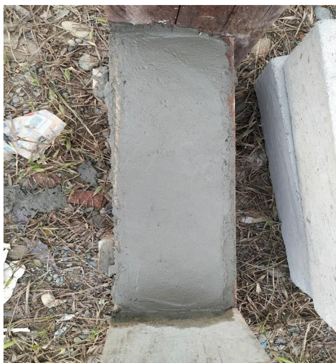
Ilustración 17 Vigas para ensayo de resistencia del concreto
