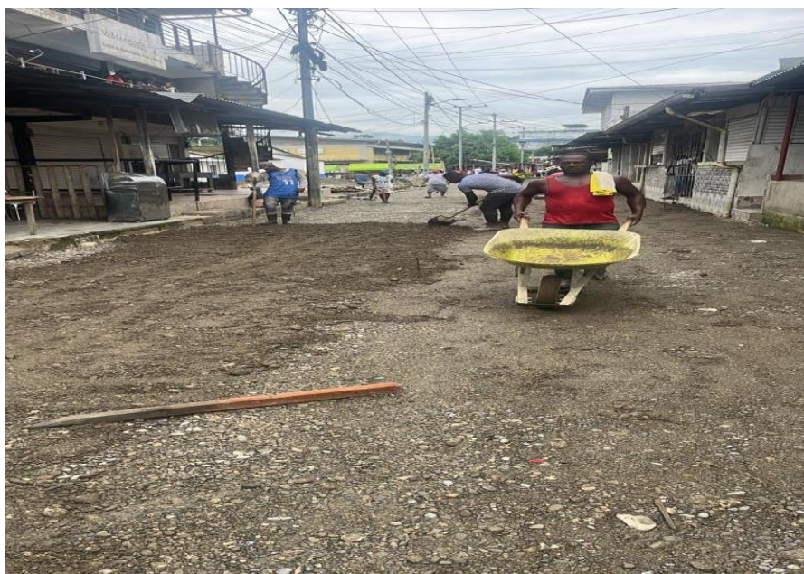
Ilustración 7 Extendido del material para subbase
