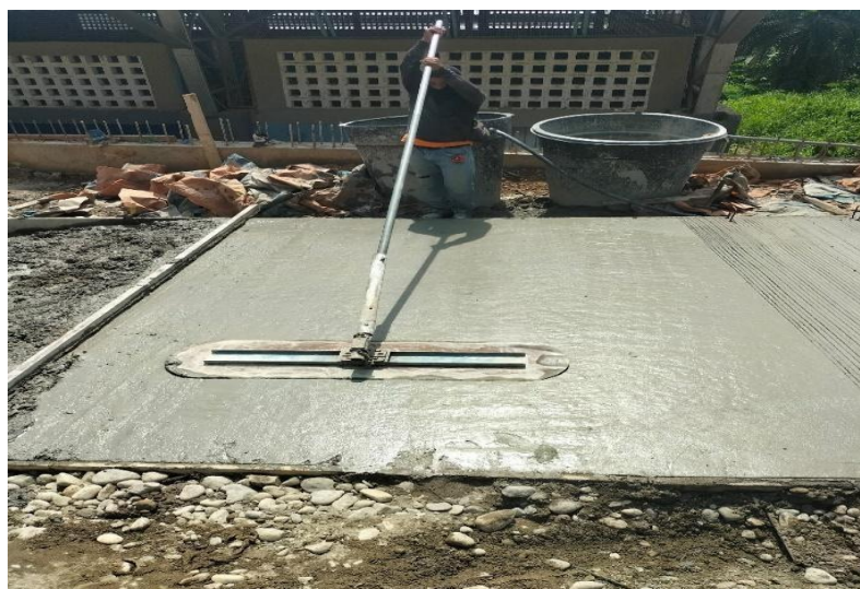
Ilustración 19 Flotado del concreto
