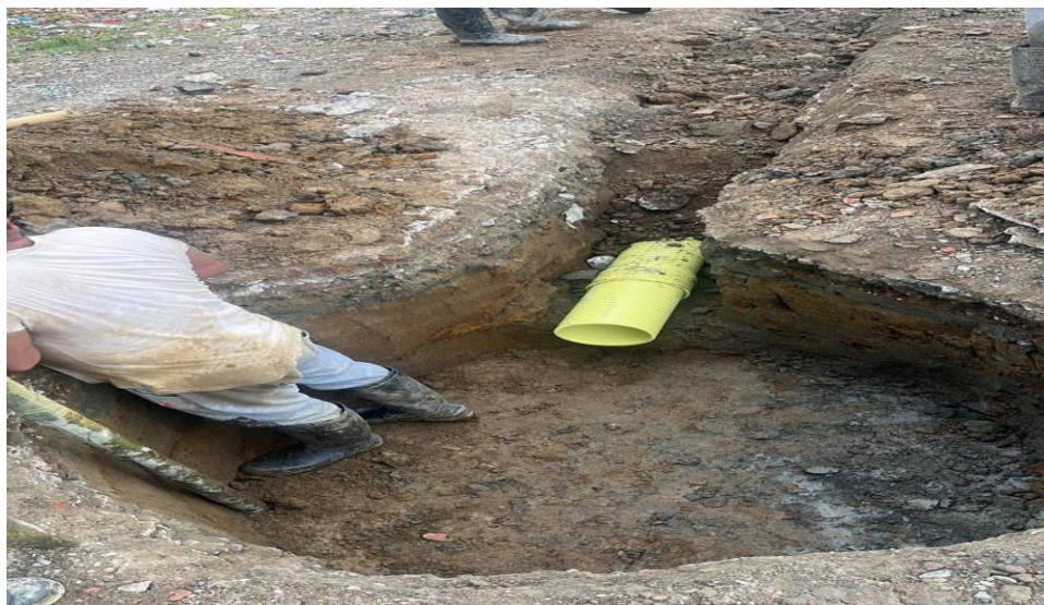
Ilustración 32 Excavación para recamara de inspección
