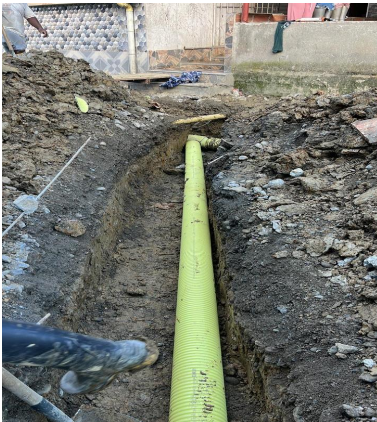
Ilustración 31 Instalación de domiciliaria de aguas residuales
