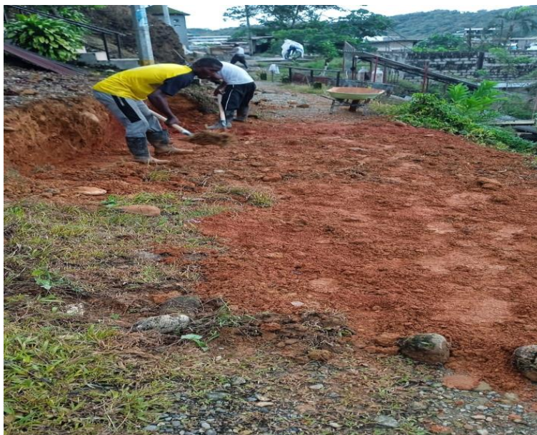
Ilustración 5 Nivel terminado de la subrasante
