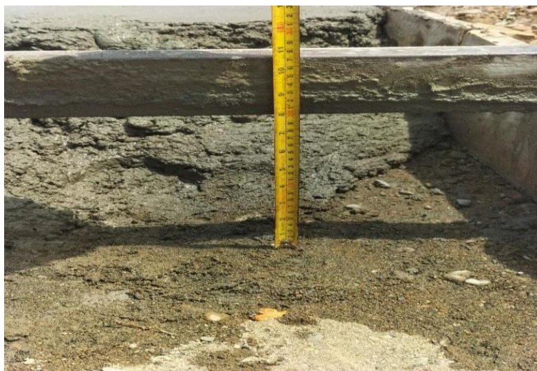
Ilustración 28 Chequeo del espesor de la losa
