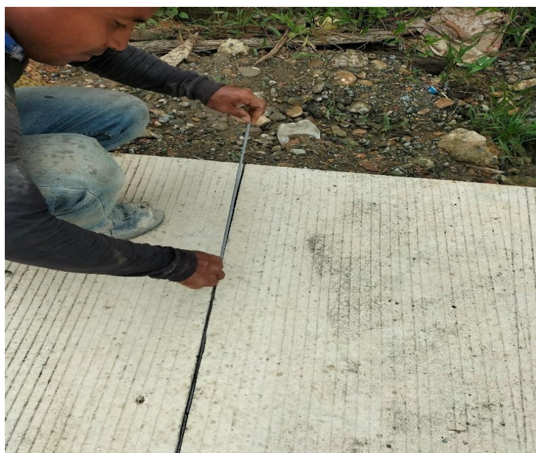
Ilustración 23 Colocación de cordón para el sello de juntas
