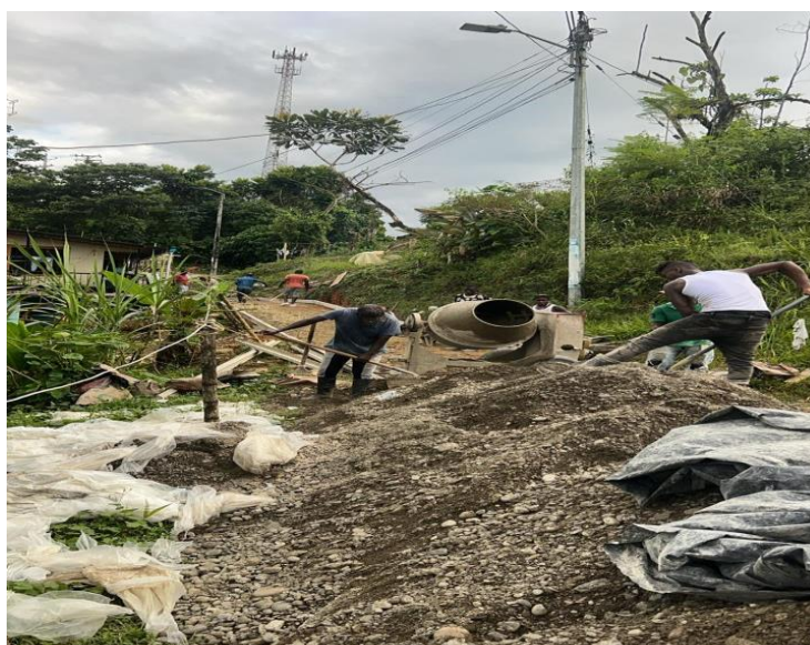
Ilustración 36 Uso del material granular en obra
