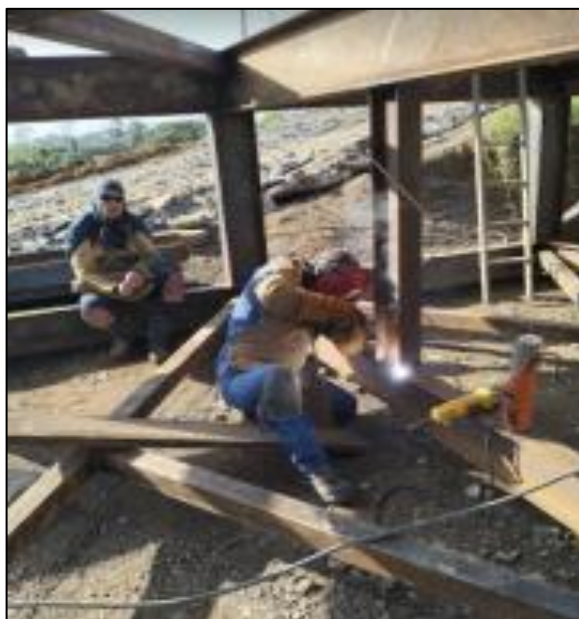
Figura 25 Armado de módulos en el lado A
