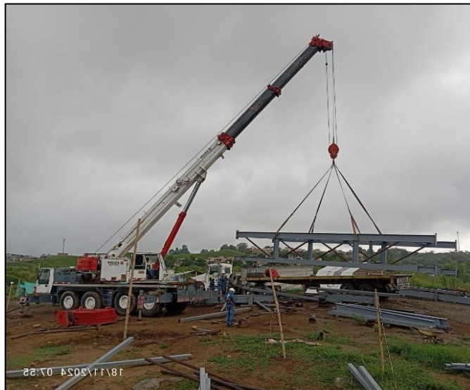
Figura 46 Izaje de módulos del lado B
