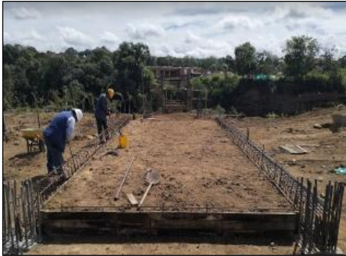
Figura 23 Nivelación de piso para rampa
