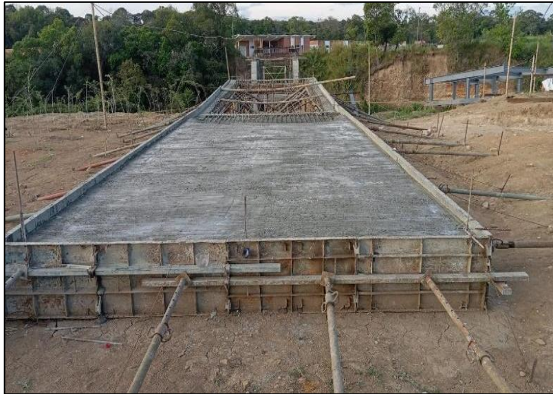
Figura 35 Vaciado de concreto para rampa
