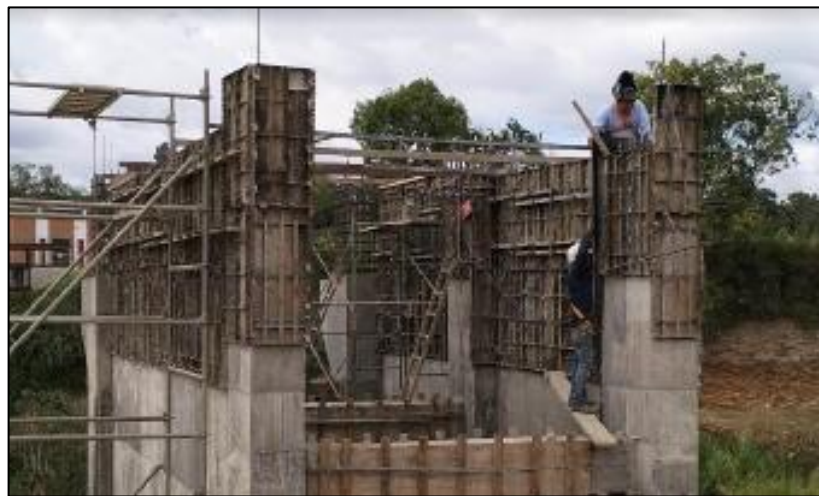
Figura 16 Instalación de acero y formaleta de pórticos 1,2 y 3 del lado B
