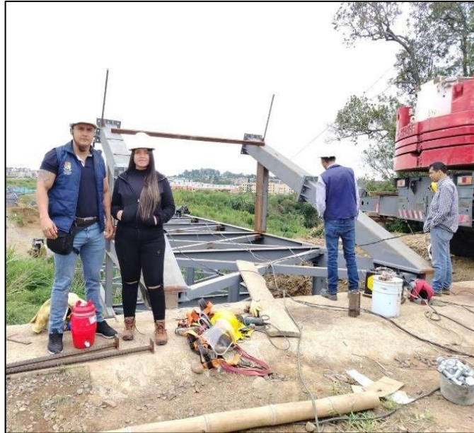
Figura 44 Visita a obra
