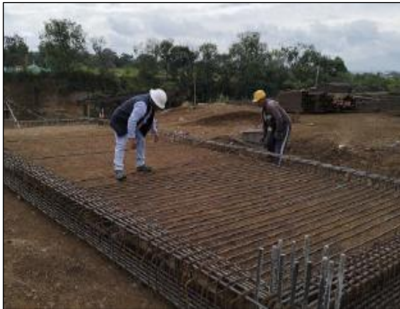
Figura 26 Instalación de acero para rampa
