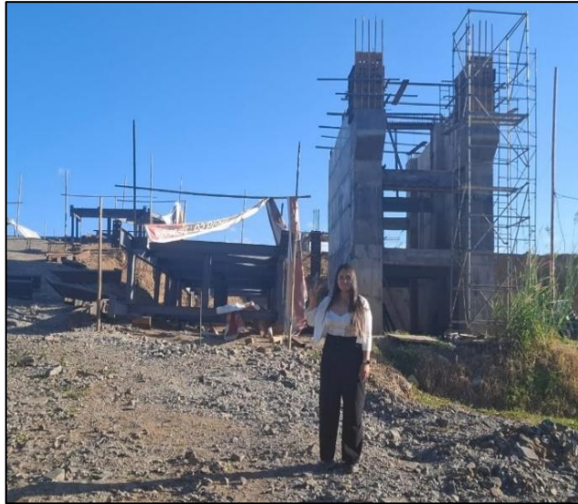
Figura 33 Visita a obra
