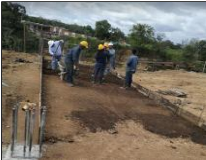
Figura 23 Nivelación de piso para rampa
