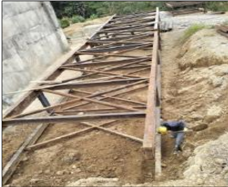
Figura 18 Realización de módulos metálicos
