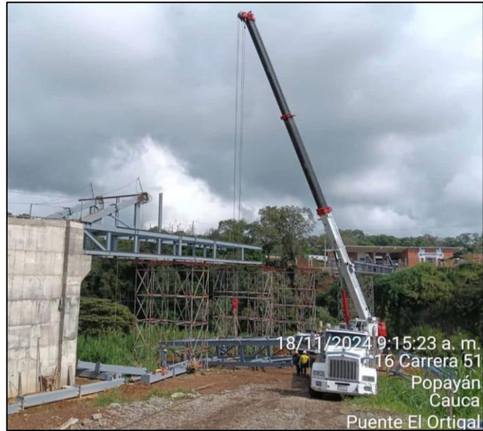
Figura 45 Izaje de módulos del lado B
