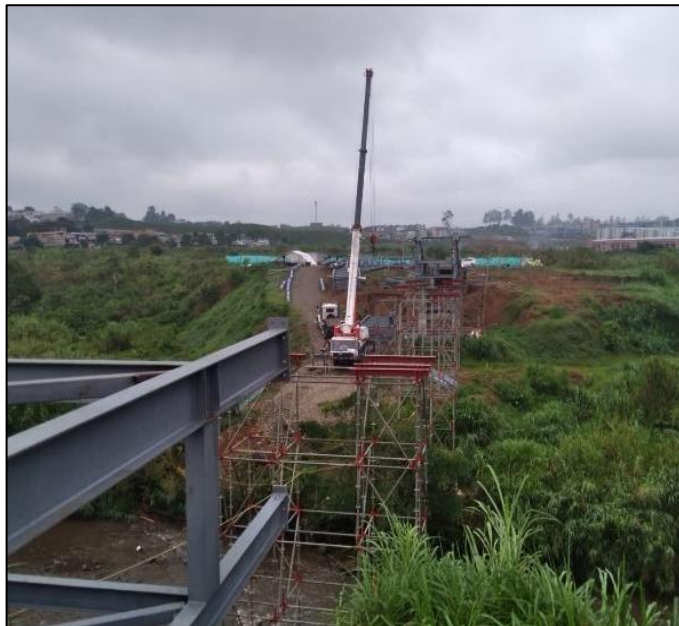
Figura 42 Izaje de módulos vista desde el lado A
