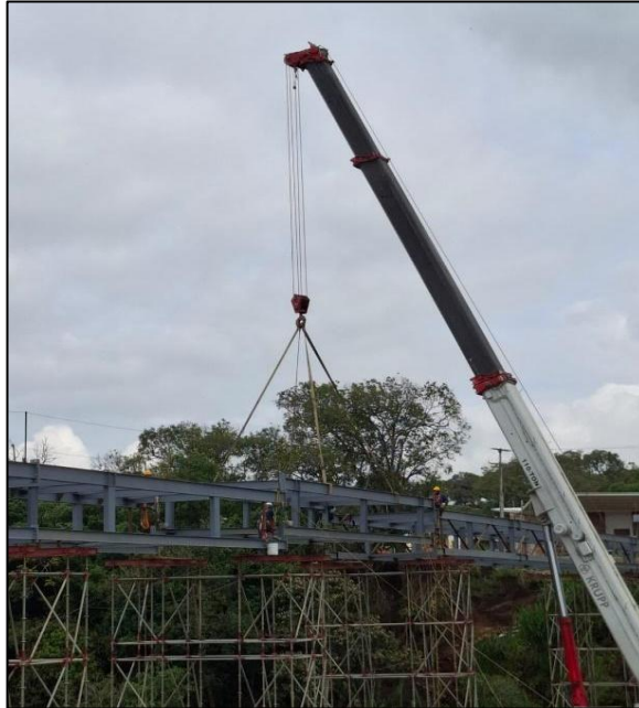
Figura 48 Cierre de la estructura metálica
