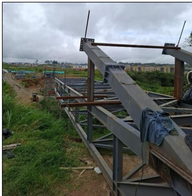
Figura 43 Montaje de estructura metálica
