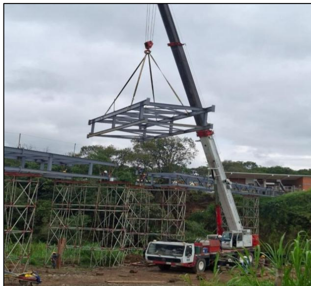
Figura 47 Izaje del último módulo
