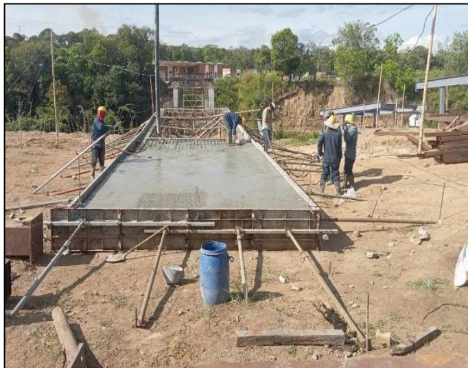
Figura 34 Vaciado de concreto para rampa
