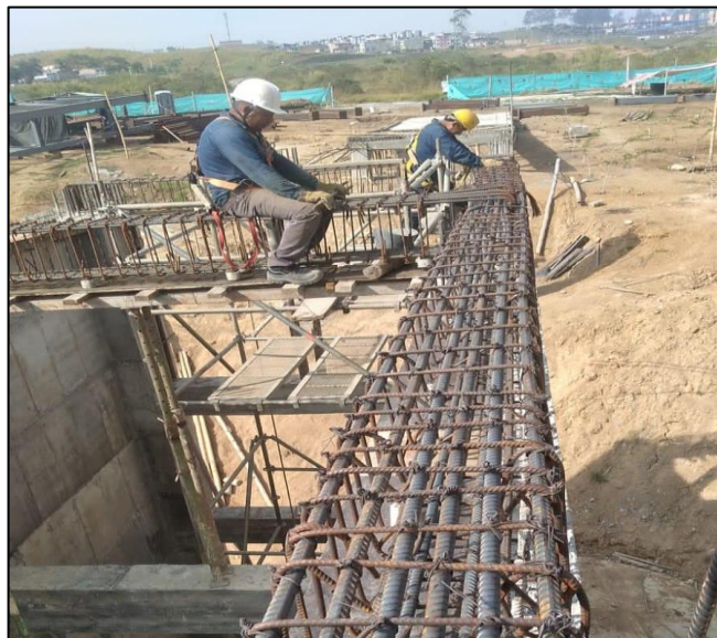
Figura 39 Instalación de acero para el cabezal
