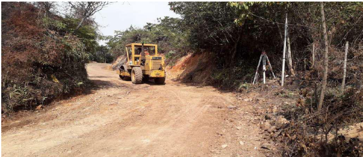
Fotografía 7 Sobreancho calzada
