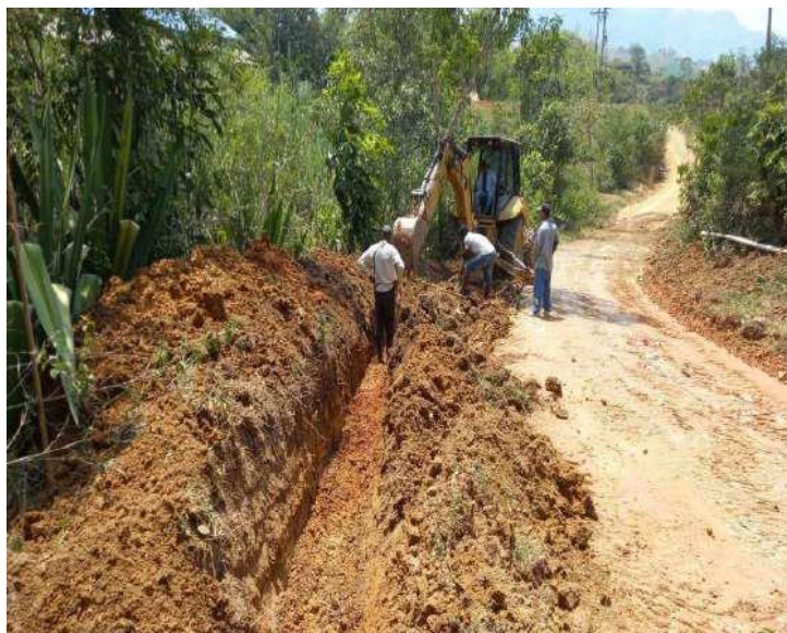
Fotografía 5 Excavación de Canales
