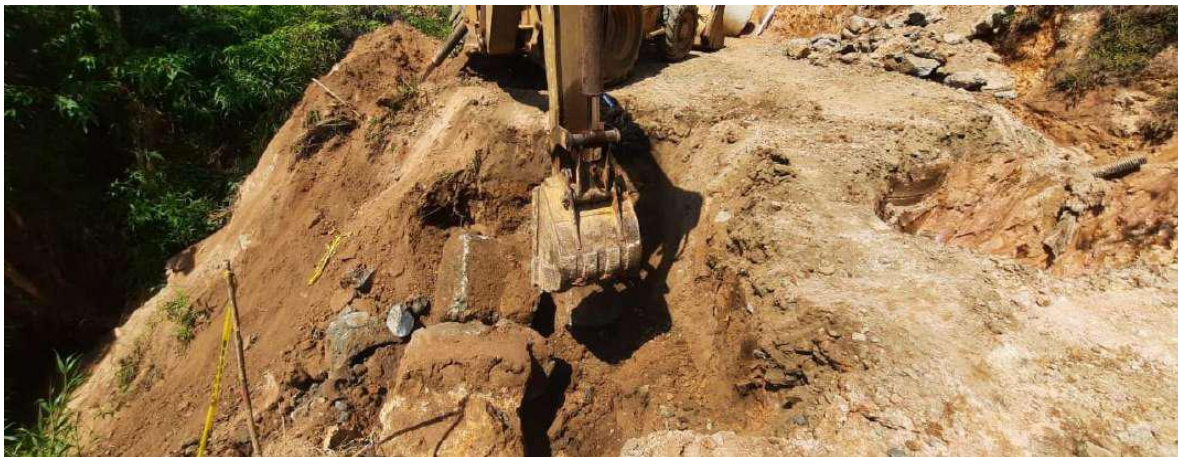
Fotografía 3 Demolición de estructuras
