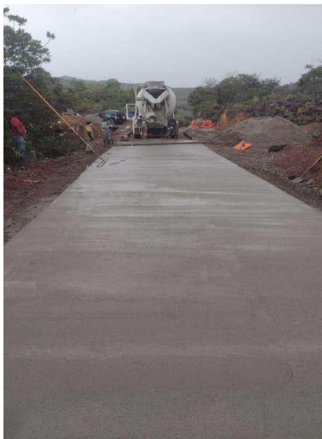
Fotografía 10 Colocación concreto hidráulico
