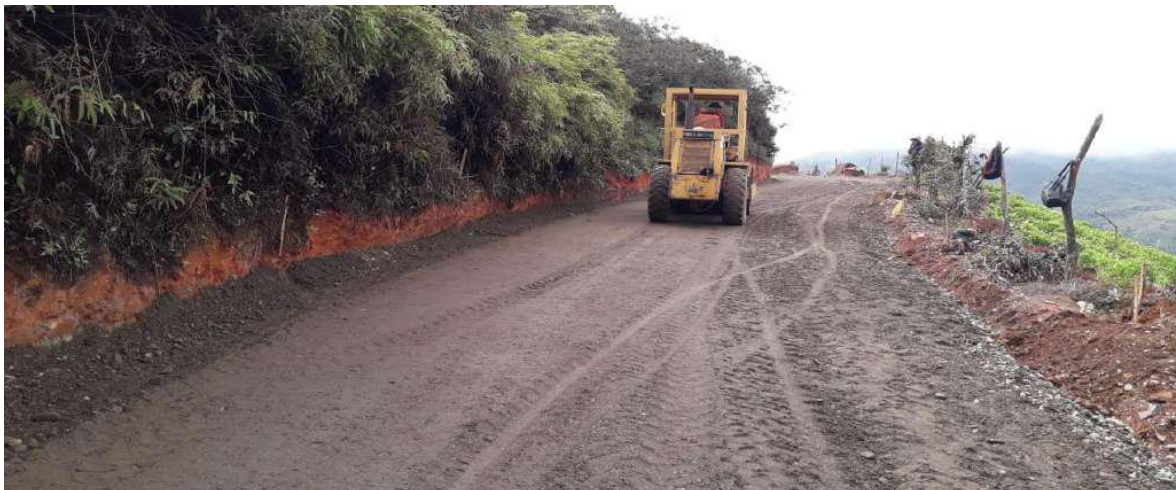
Fotografía 9 Conformación de subbase
