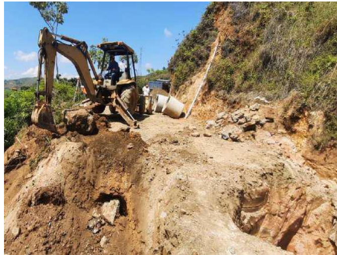
Fotografía 1 Demolición de estructuras
