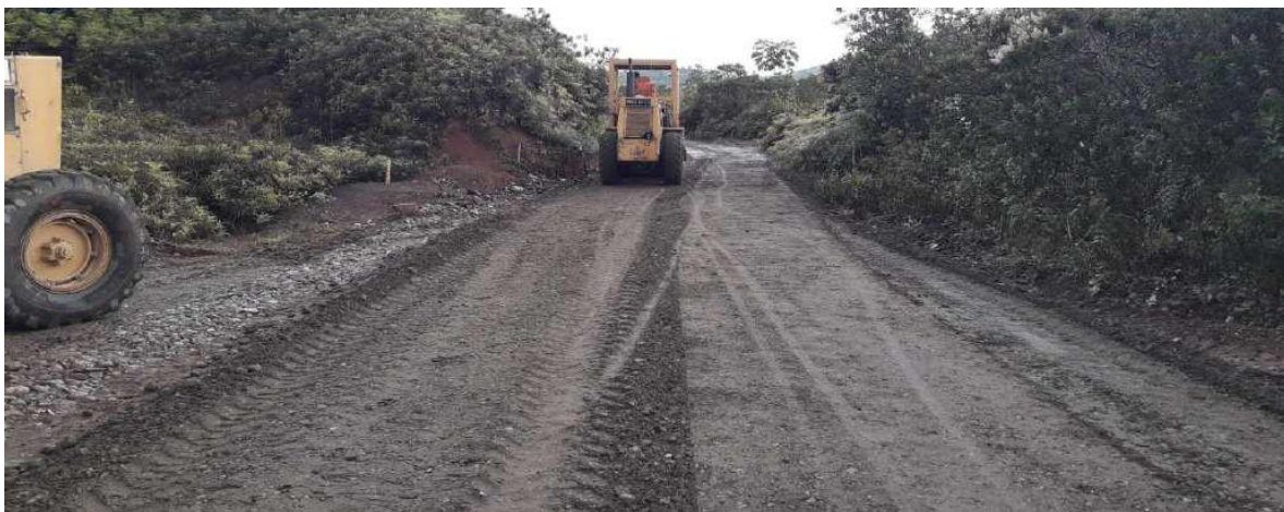
Fotografía 8 Conformación de subbase
