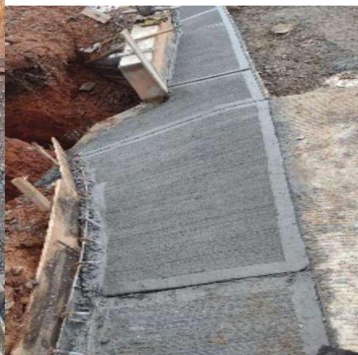
Fotografía 13 Colocación berma cuneta
