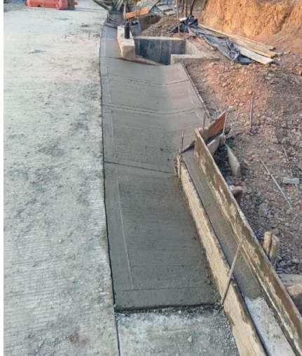
Fotografía 12 Colocación berma cuneta
