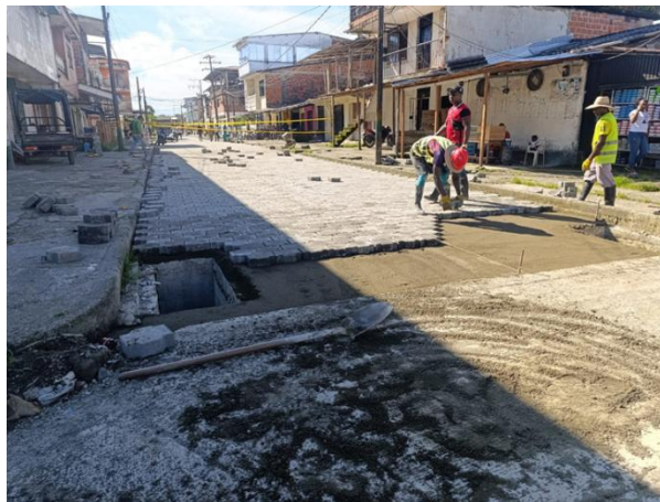
Figura 14. Suministro e instalación de adoquín en cruz
