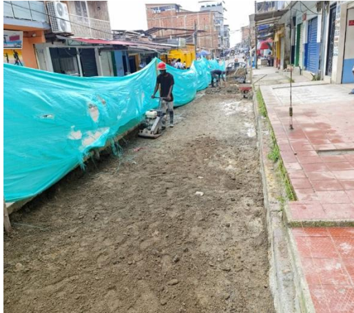
Figura 9. Nivelación, compactación y conformación de la subrasante
