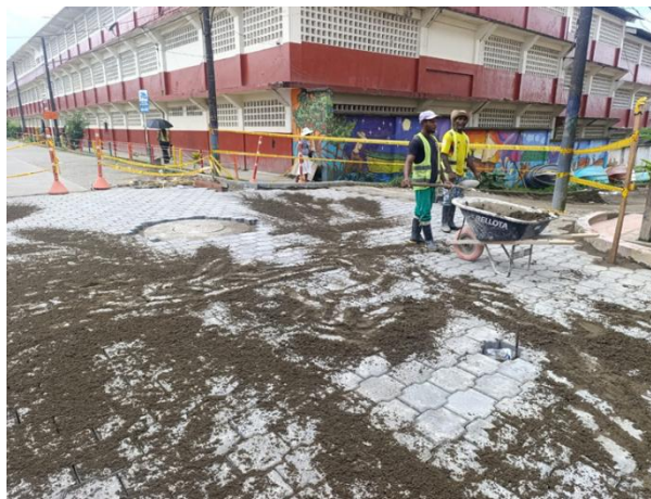
Figura 15. Sellado con arena
