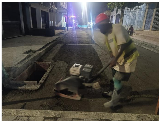
Figura 12. Compactación de subbase granular estabilizada con cemento
