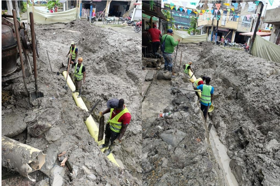
Figura 8. Instalación de tubería
