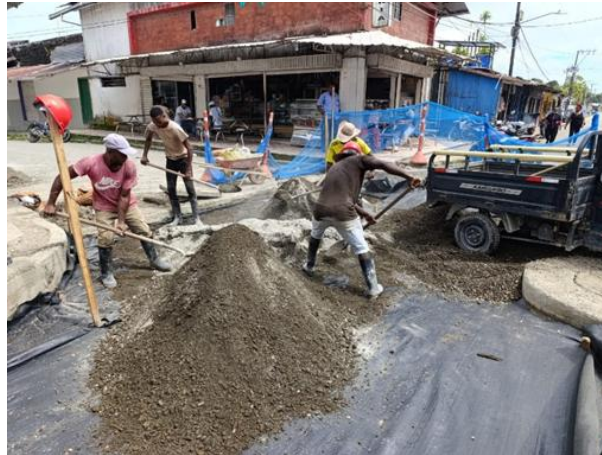
Figura 11. Suministro e instalación de subbase granular estabilizada con cemento
