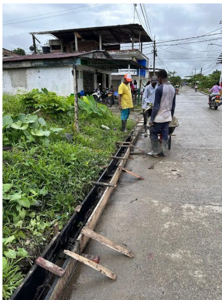
Figura 42. Supervisión de construcción de sardineles calle 13
