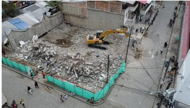
Figura 40. Demolición de Palacio Municipal
