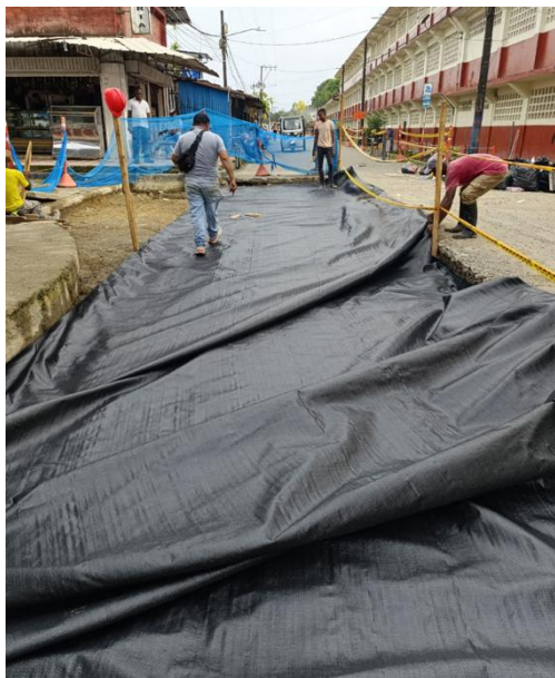
Figura 10. Suministro e instalación de geotextil tejido
