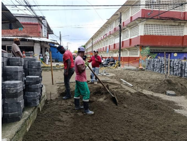
Figura 13. Suministro e instalación de capa de arena de asiento
