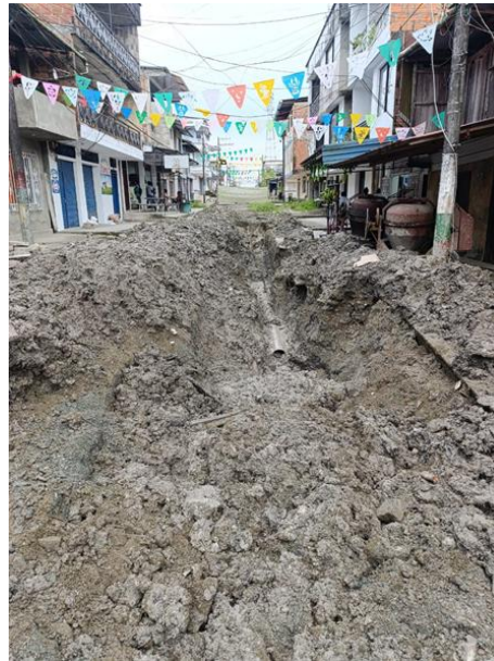
Figura 7. Excavaciones en material común
