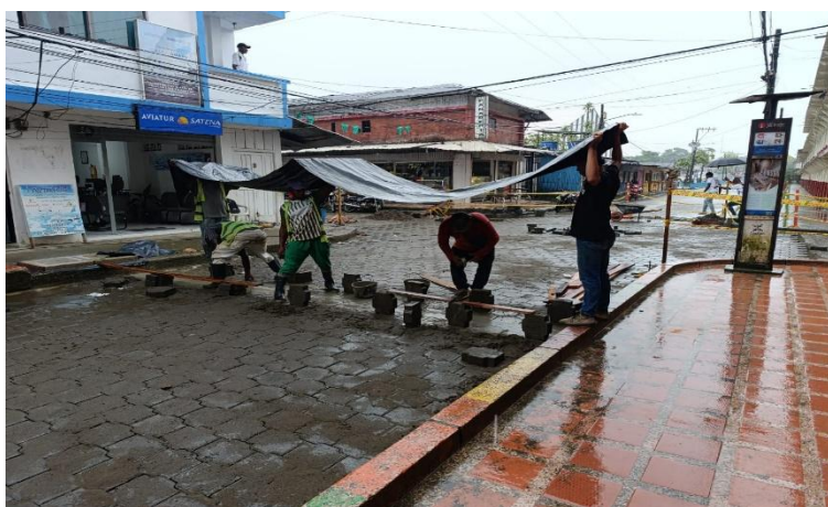
Figura 17. Viga de confinamiento cada 10 MTS.
