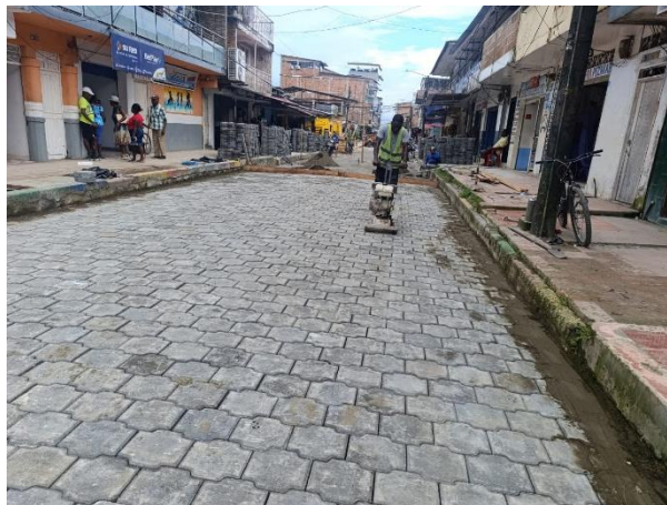
Figura 16. Compactación de adoquín
