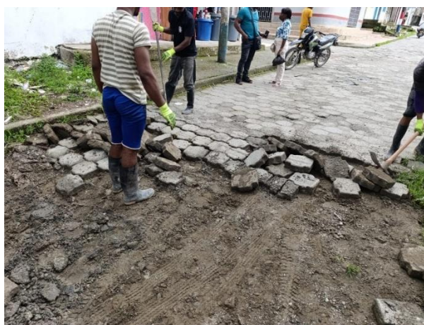
Figura 6. Retiro de adoquín existente
