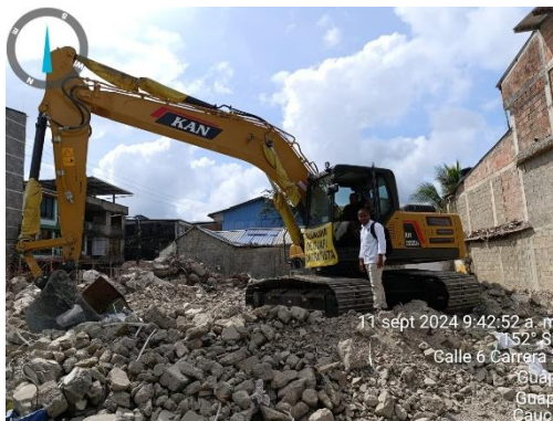
Figura 39. Actividad de retiro de escombros
