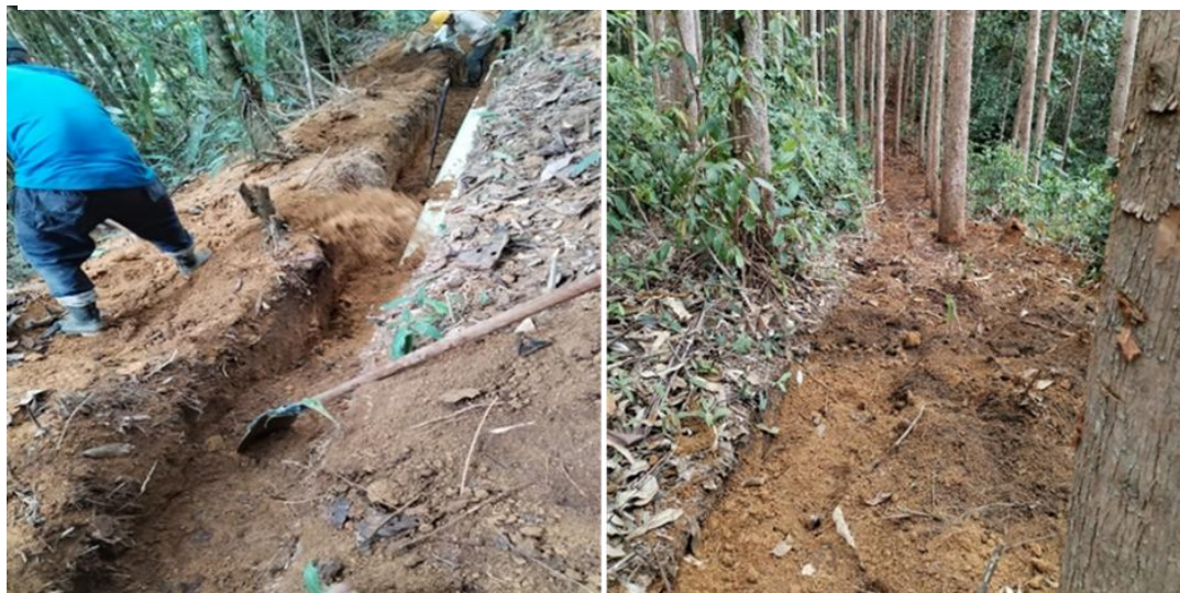
Ilustración 7: Relleno con material de excavación
