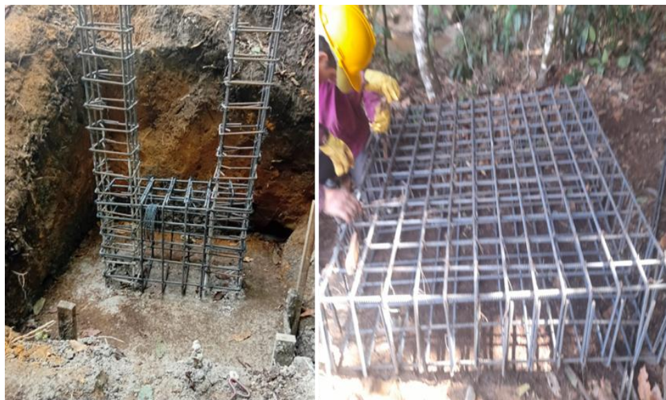
Ilustración 23: Instalación de acero de refuerzo
