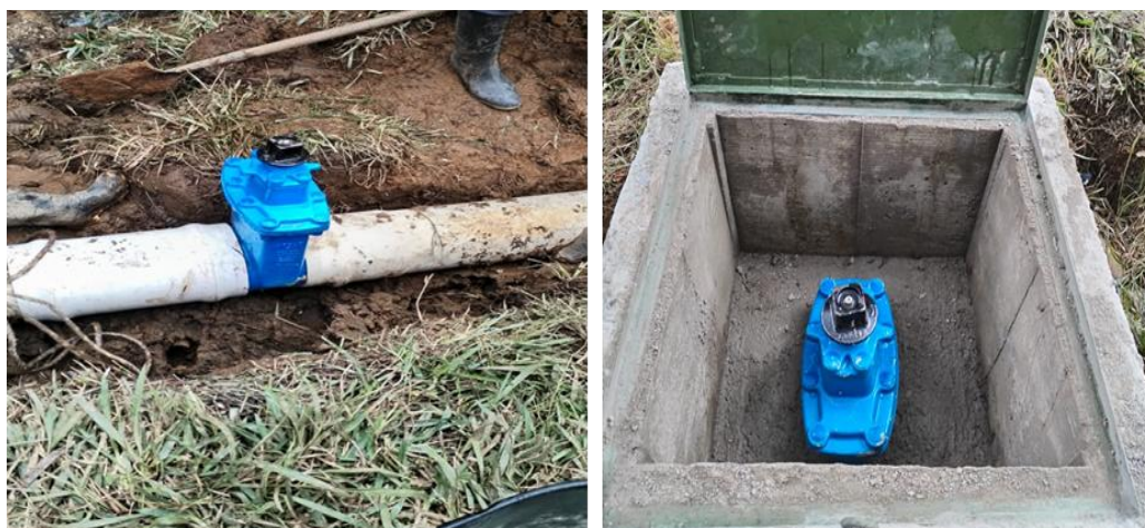
Ilustración 17: Suministro e instalación válvula
