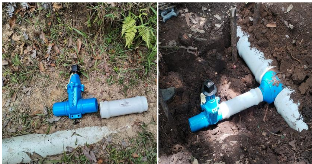
Ilustración 11: Suministro e instalación válvula
