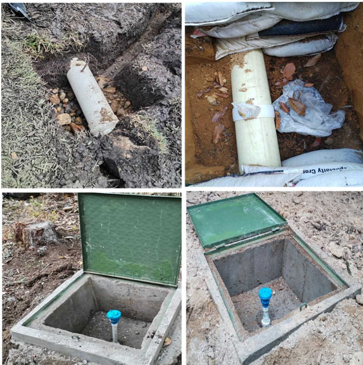
Ilustración 13: Suministro e instalación Válvula ventosa
