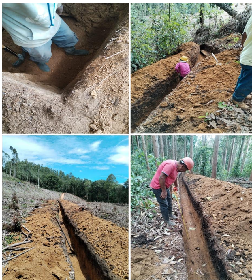
Ilustración 5: Excavaciones material común
