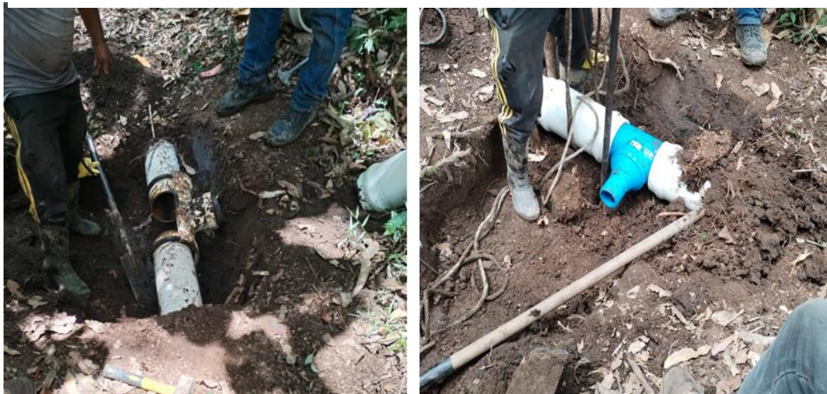
Ilustración 19: Suministro e instalación TEE extremo
