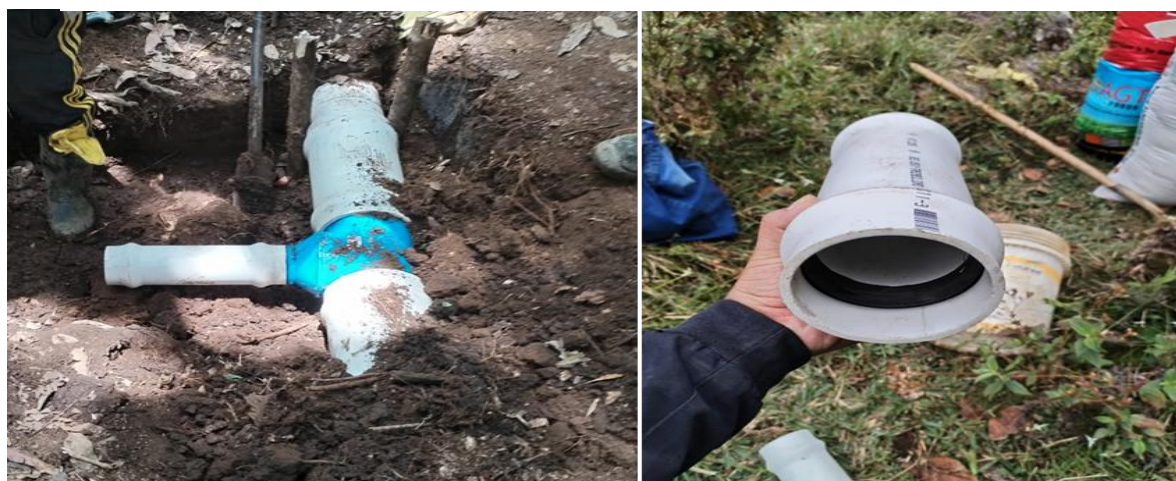
Ilustración 15: Suministro e instalación unión de reparación PVC Presión 3"
