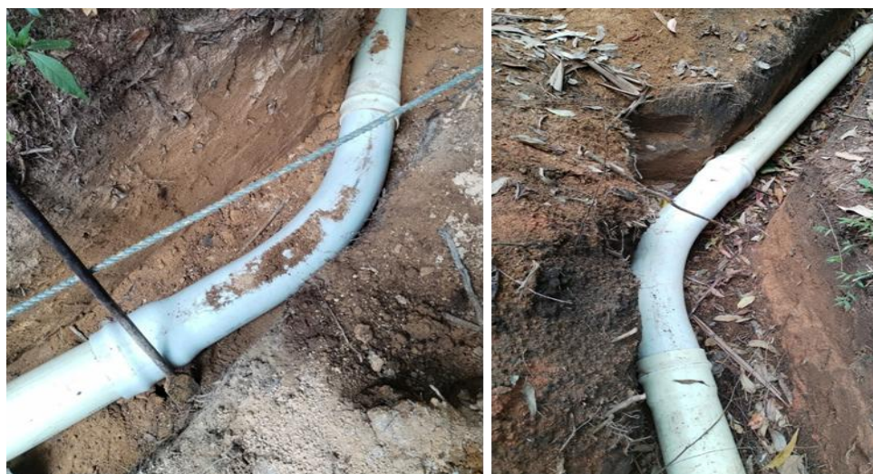
Ilustración 12: Suministro e instalación codo PVC
