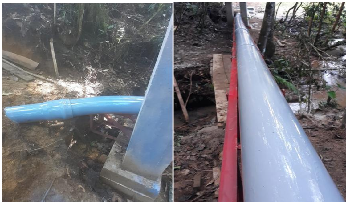
Ilustración 24: Pintura de tubería
