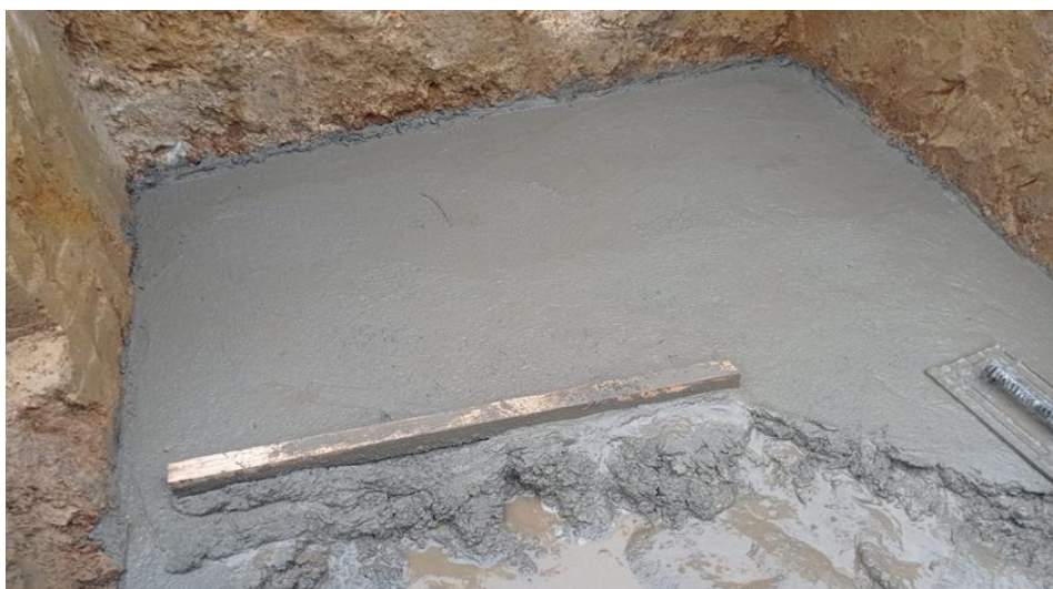
Ilustración 20: Fundición de solado de limpieza
