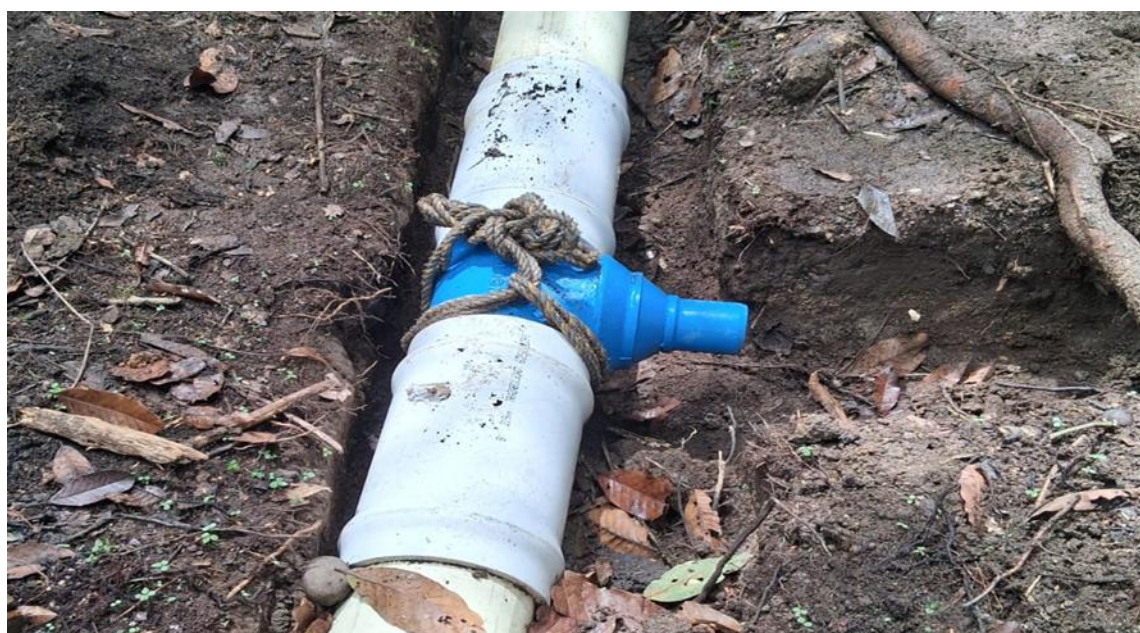
Ilustración 18: Suministro e instalación TEE extremo
