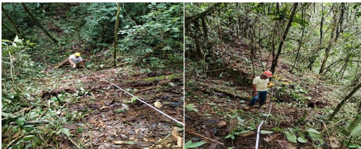
Ilustración 8: Rocería para trazado de trayecto de excavación
