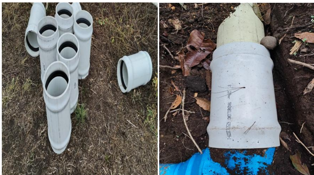
Ilustración 14: Suministro e instalación unión de reparación PVC Presión 8"
