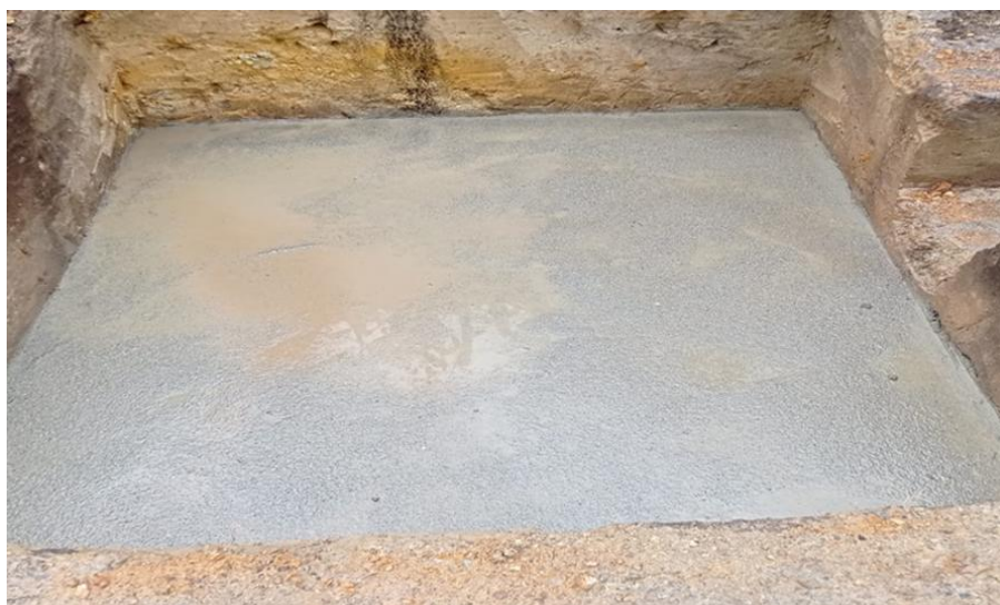
Ilustración 21: Fundición muertos de anclaje
