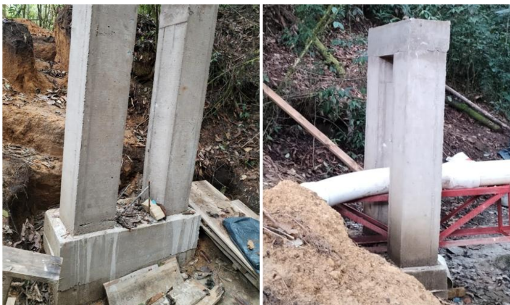
Ilustración 22: Construcción de pedestales de apoyo
