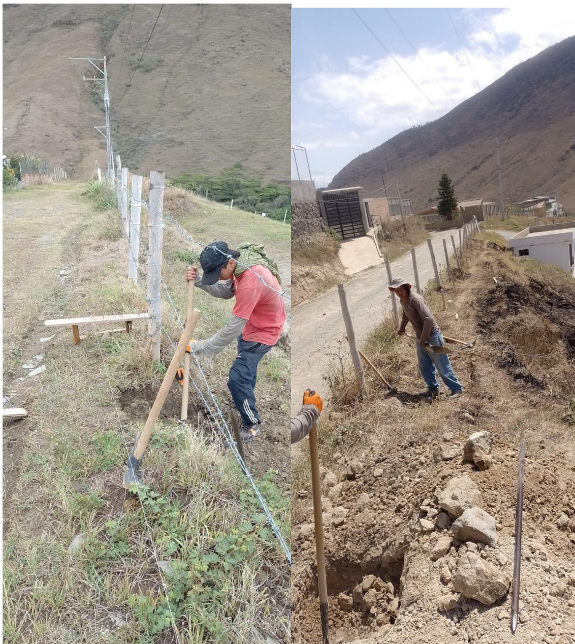
Ilustración 7. Cerramiento inicial en guadua y alambre de púa
