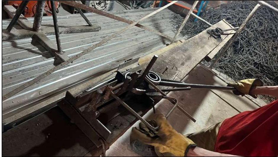
Ilustración 12 Figurado de acero para estribos Fuente: Elaboración propia
