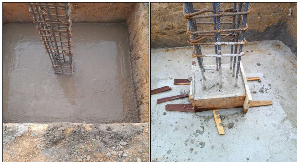
(a) (b) Ilustración 14 Concreto para zapatas 3000 psi Fuente: Elaboración propia
