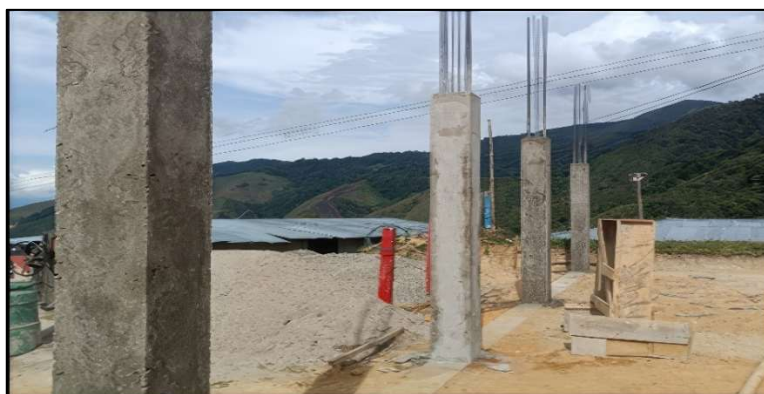
Ilustración 16 Columnas en concreto 3000psi Fuente: Elaboración propia
