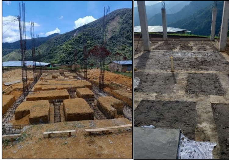
(a) (b) Ilustración 15 Concreto para vigas de cimentación 3000 psi Fuente: Elaboración propia
