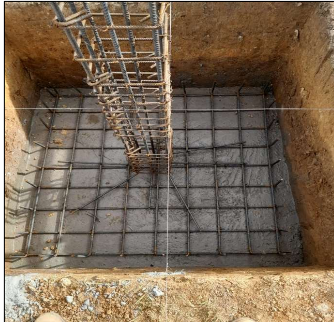
Ilustración 11 Concreto de limpieza
