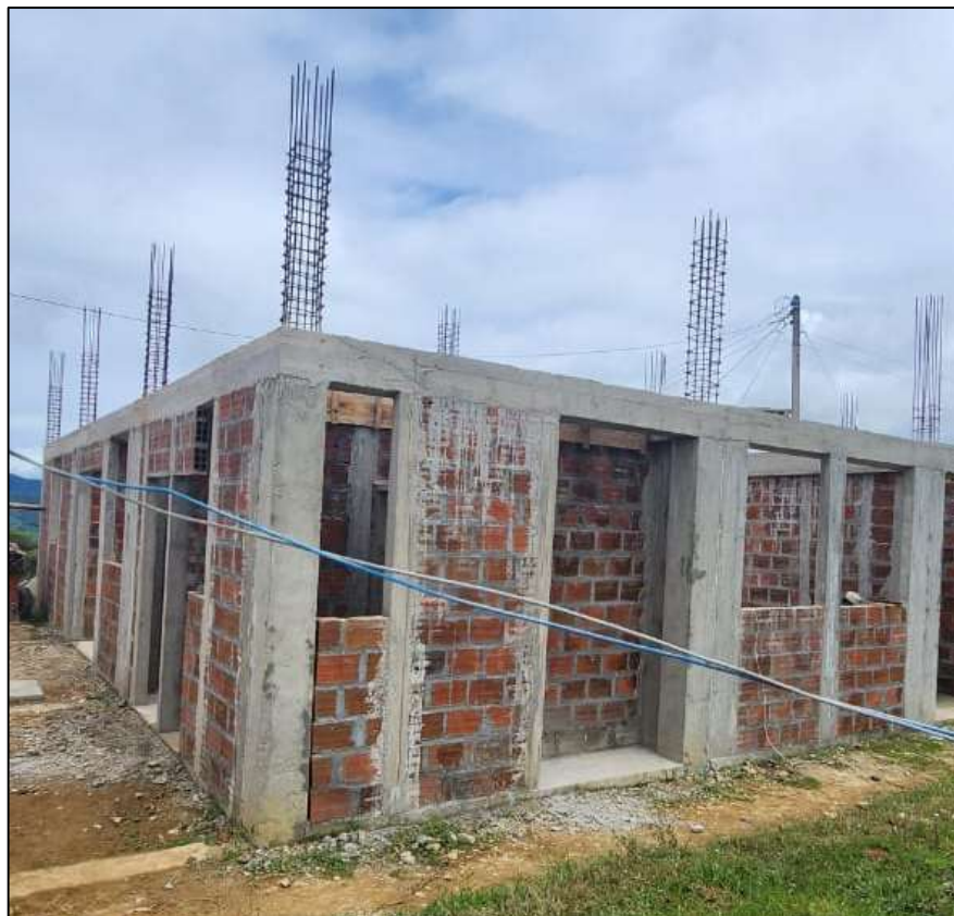
Ilustración 19 Mampostería Fuente: Elaboración propia
