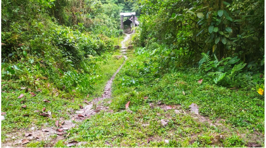
Fotografía 47. Puente de San Francisco – Vereda la Cristalina.
