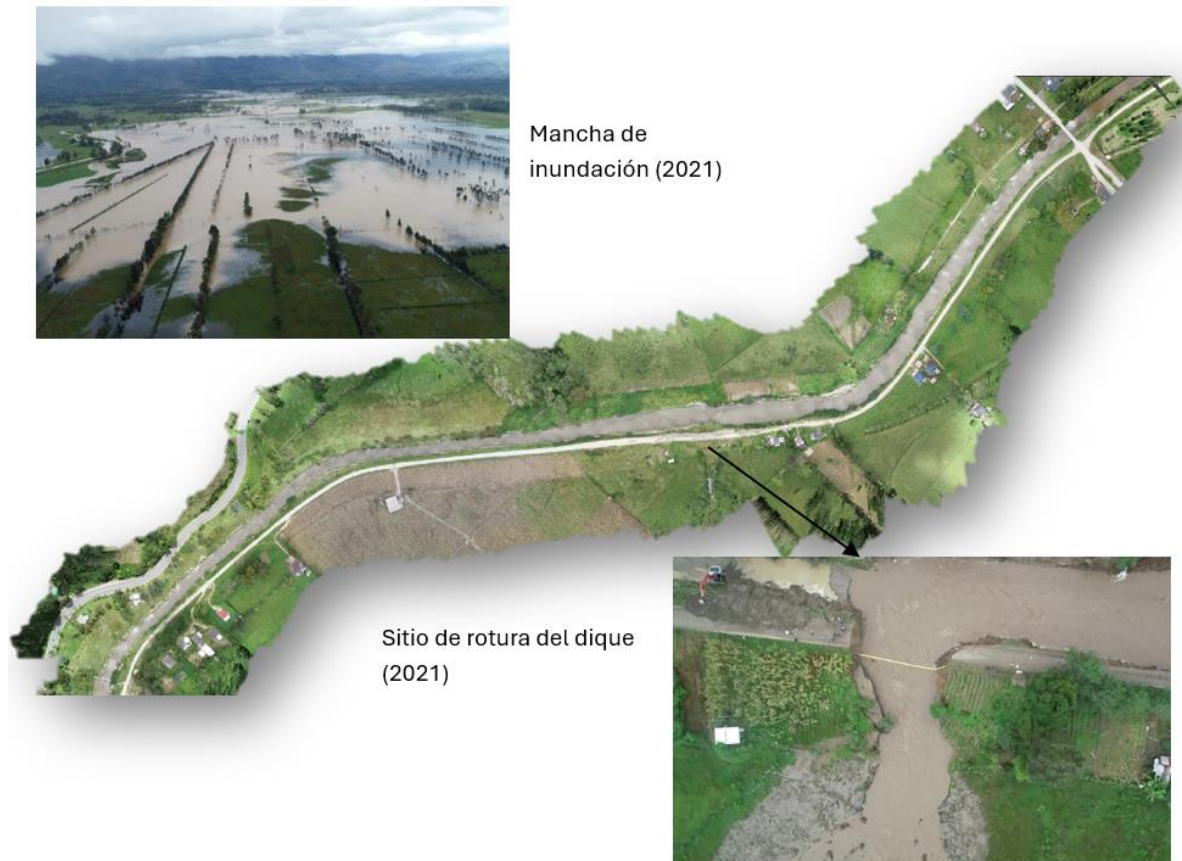
Foto 5-3: Desbordamiento y rotura de dique Canal D (julio 2021)
