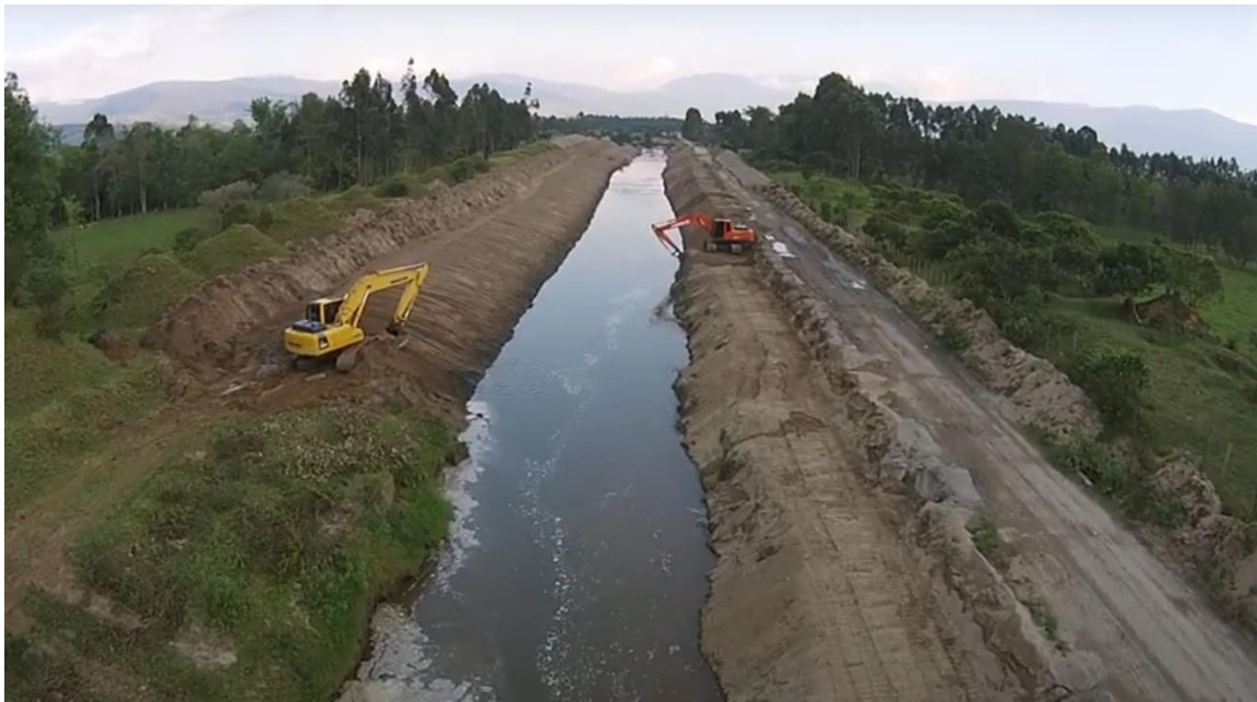
Foto 5-2: Obras de descolmatación Canal D (noviembre 2015)
