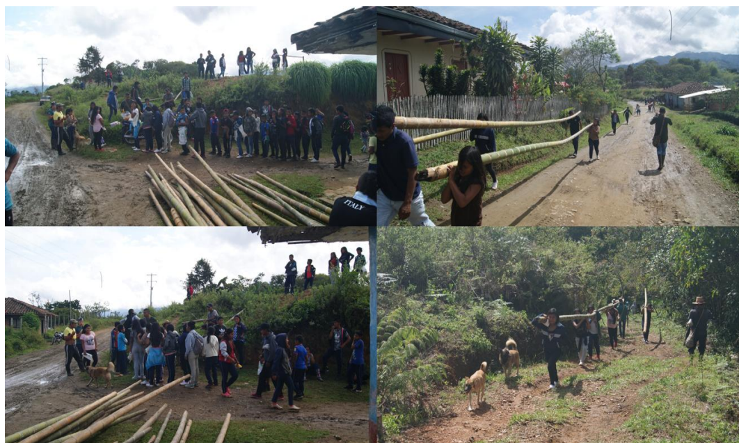
Figura 9. Minga para construcción del Centro de Formación
