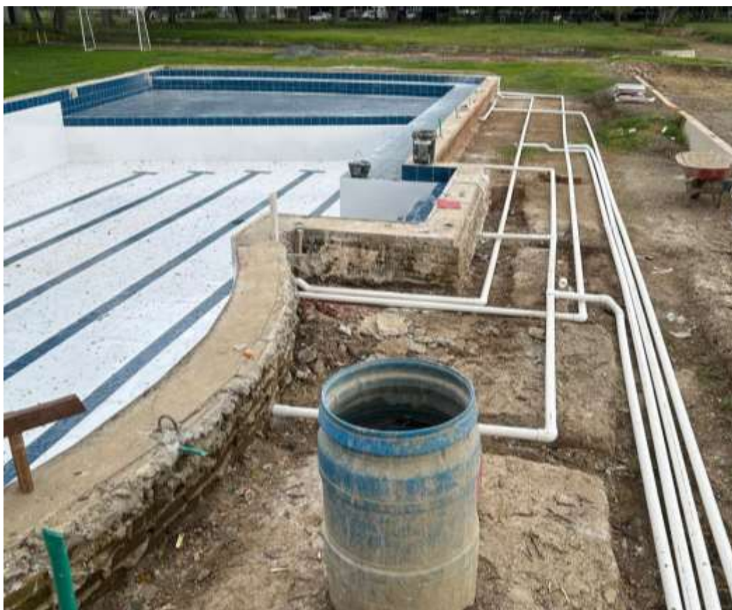
Figura 8.39 Instalación de tubería al cuarto de maquinas
