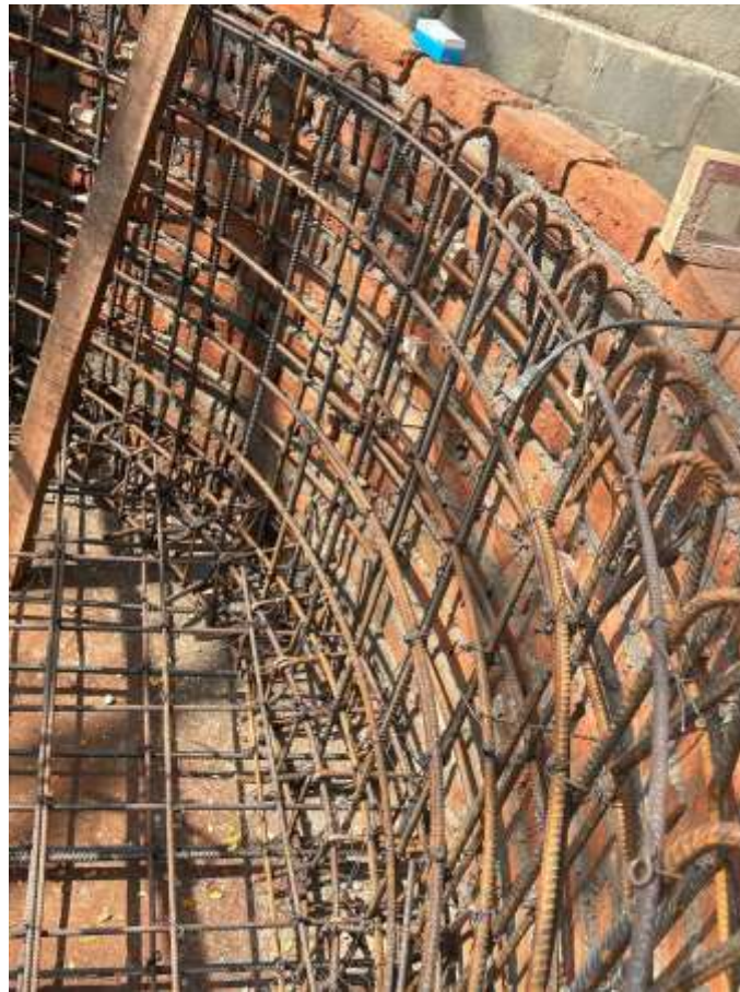
Figura 8.29 Mallas de acero para paredes del jacuzzi
