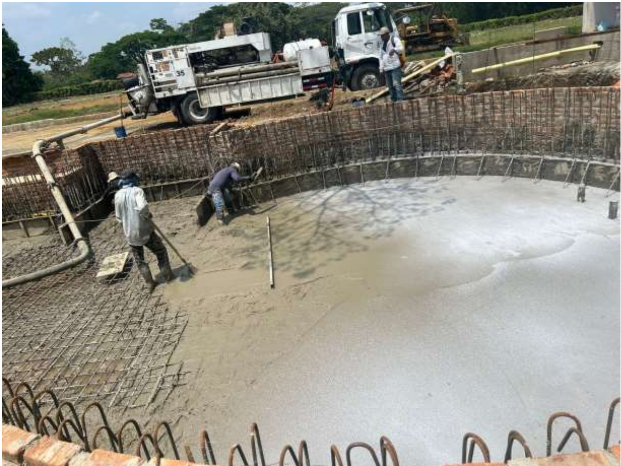
Figura 8.11 Aplicación de aditivo retardante
