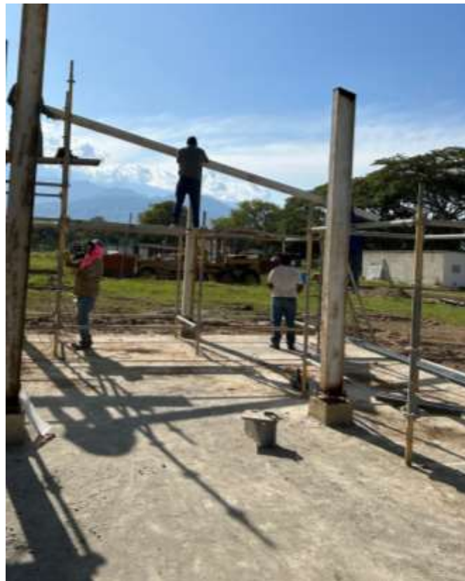
Figura 8.72 Instalación de estructura metálica para salón social
