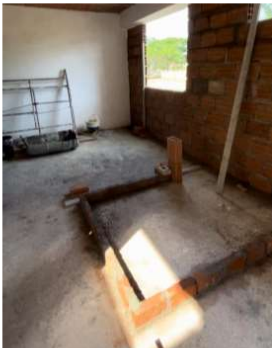
Figura 8.54 Inicio de muros para baño de alcoba
