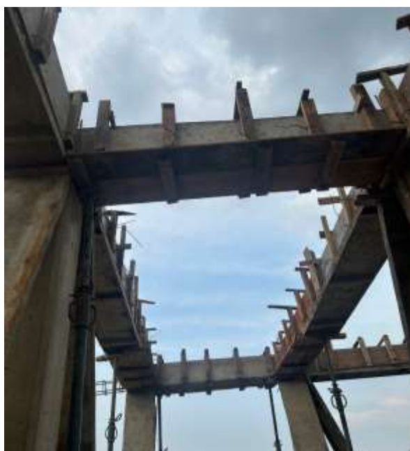
Figura 8.53 Vigas de amarre tercer piso formaleteadas
