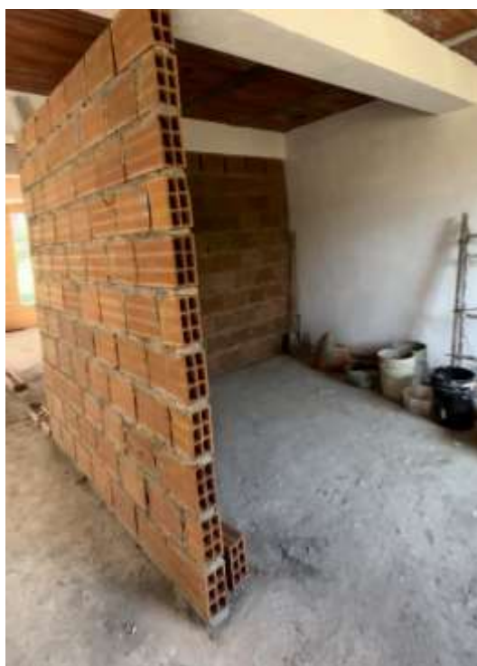
Figura 8.56 Muro divisorio entre alcoba y pasillo
