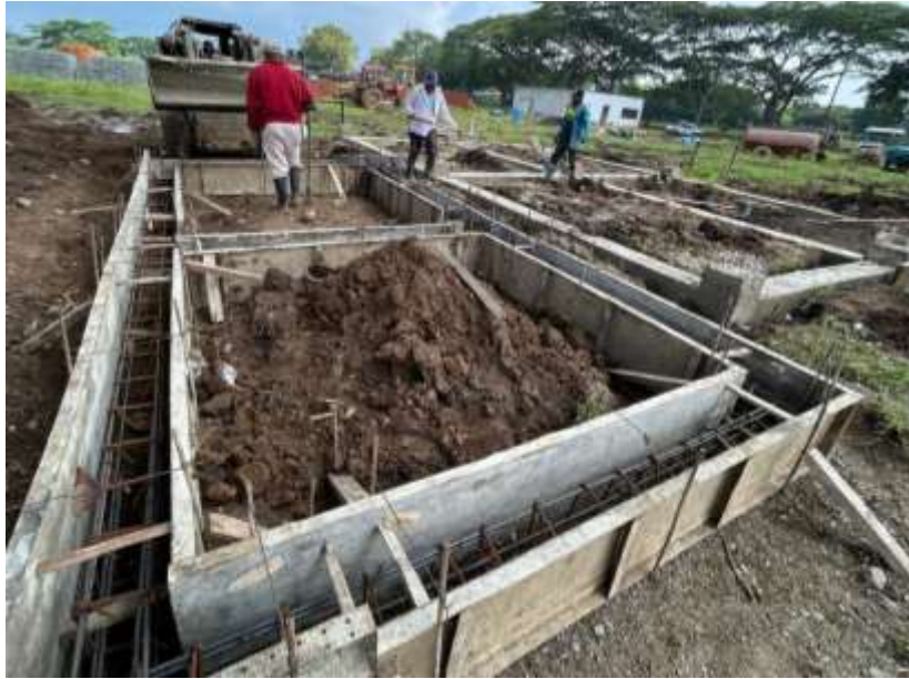
Figura 8.75 Estructura viga de cimentación lista para fundición
