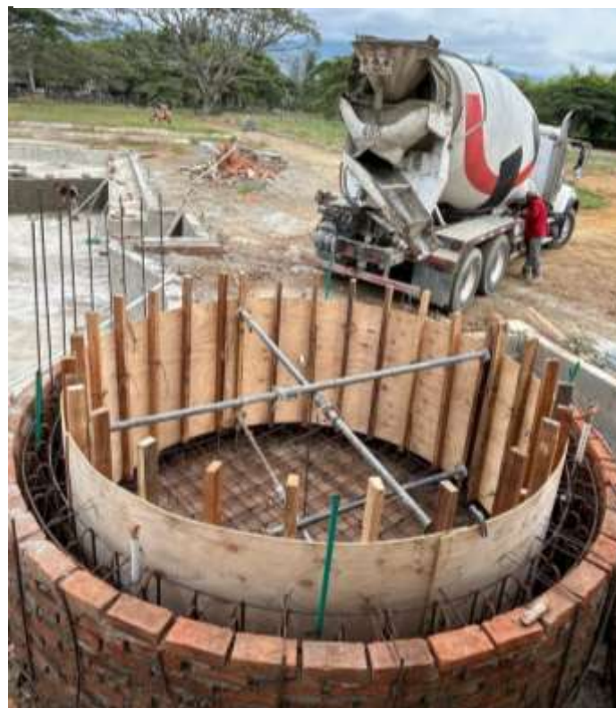
Figura 8.30 Paredes de jacuzzi formateadas listas para fundir
