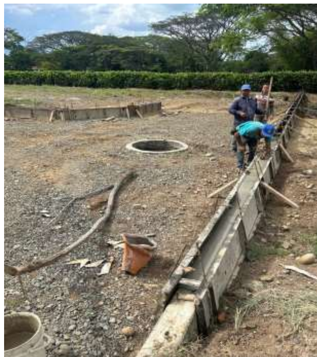
Figura 8.65 Construcción de cordones
