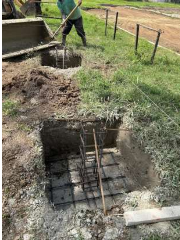
Figura 8.67 Excavación de zapata con el armado de acero
