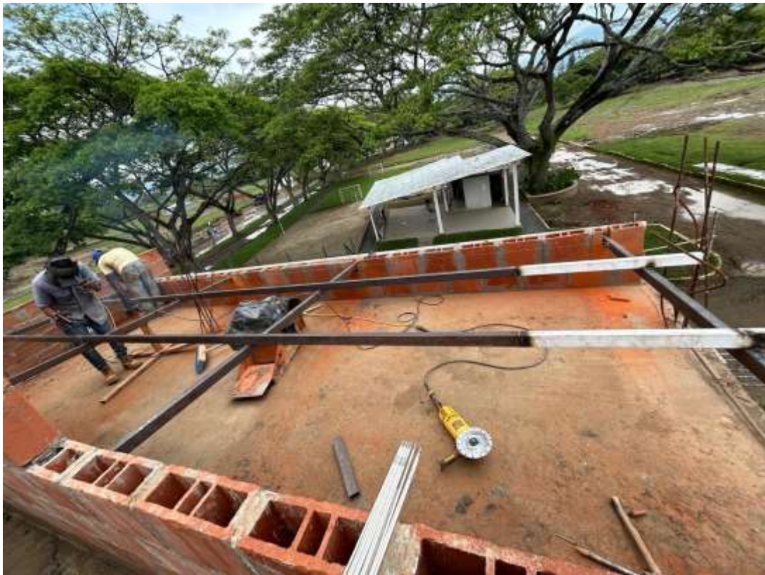
Figura 8.62 Estructura metálica de cubierta a una sola agua
