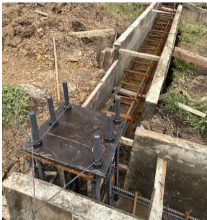
Figura 8.69 Placa anclada para las vigas IPE
