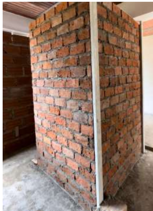
Figura 8.55 Muros de baño para alcoba finalizados
