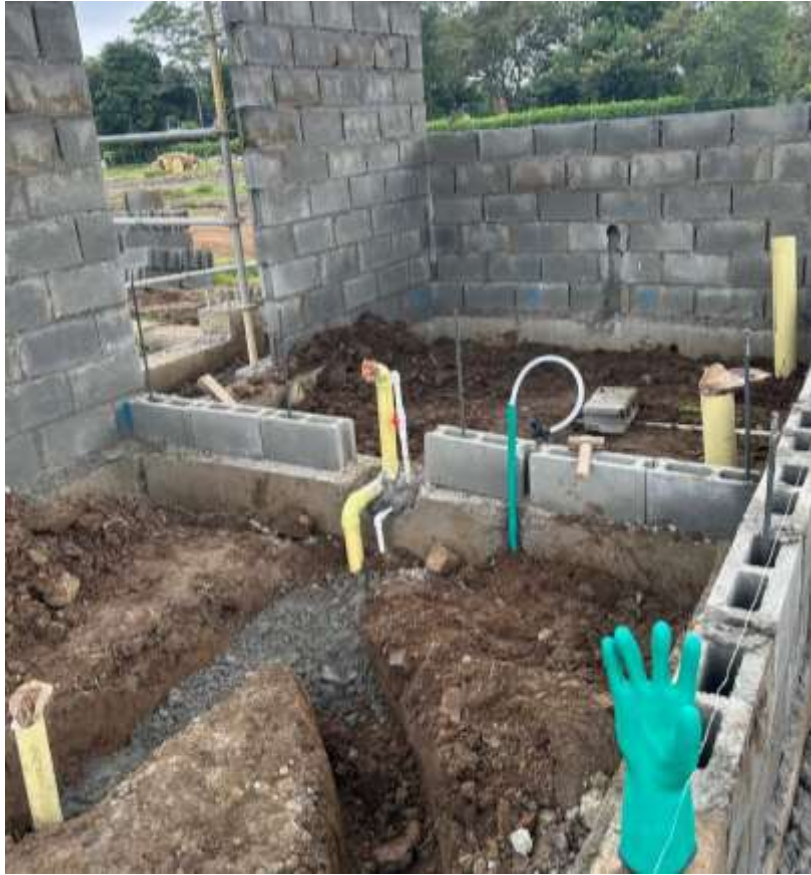
Figura 10.77 Instalación de tubería en los baños
