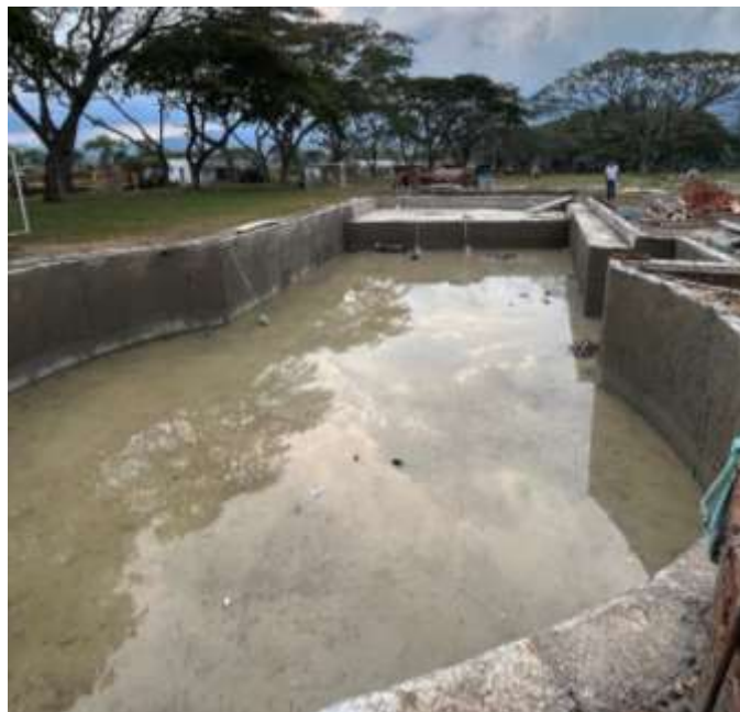
Figura 8.22 Inicio de repello para las paredes
