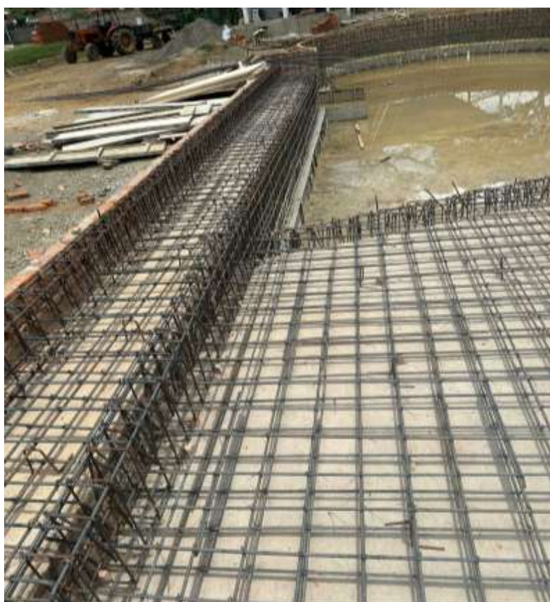
Figura 8.16 Acero restante finalizado
