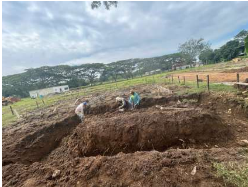
Figura 8.73 Excavación viga de cimentación finalizada
