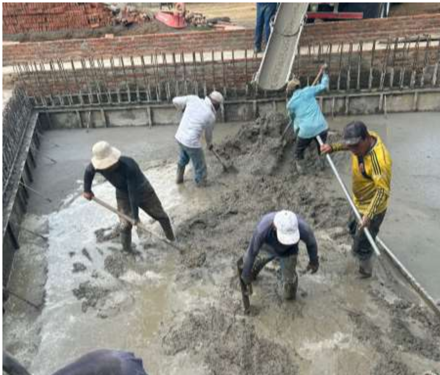
Figura 8.10 Fundición piso de piscina
