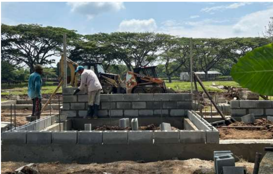
Figura 8.76 Construcción de muros en bloques de cemento
