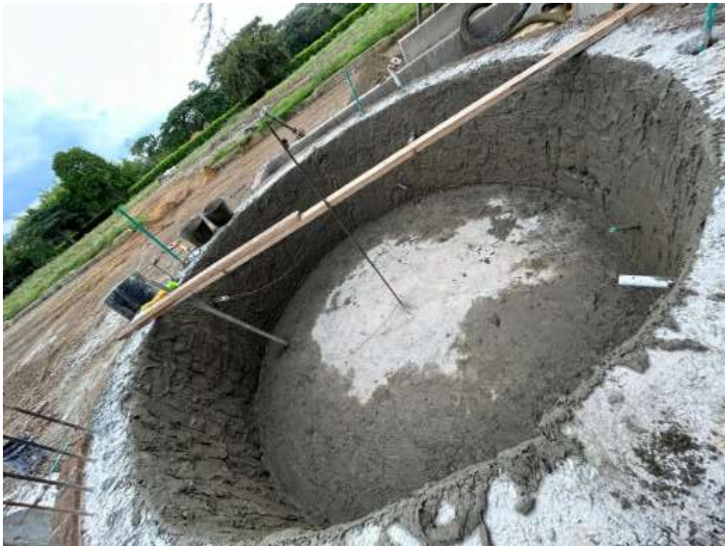
Figura 8.33 Repello de paredes en el jacuzzi
