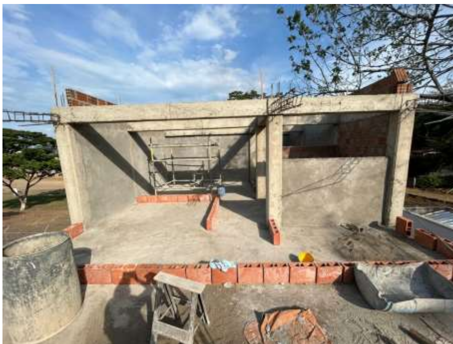
Figura 8.59 Replanteo de muros tercer pisos
