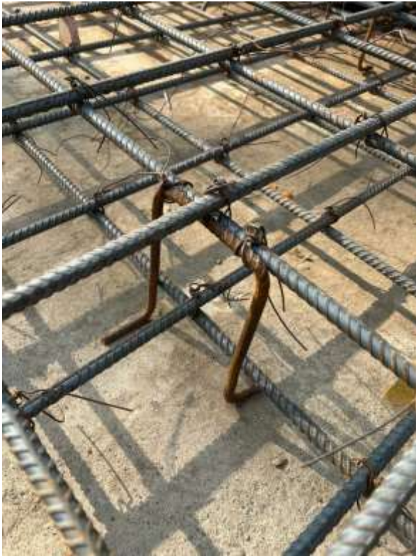
Figura 8.5 Acero "burritos" para asegurar la doble malla
