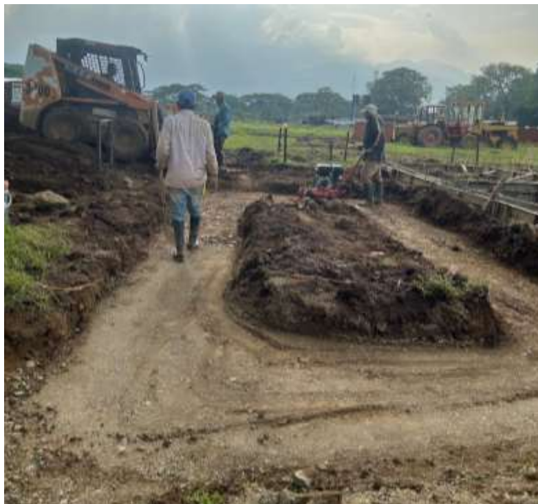
Figura 8.74 Compactación de material con rana
