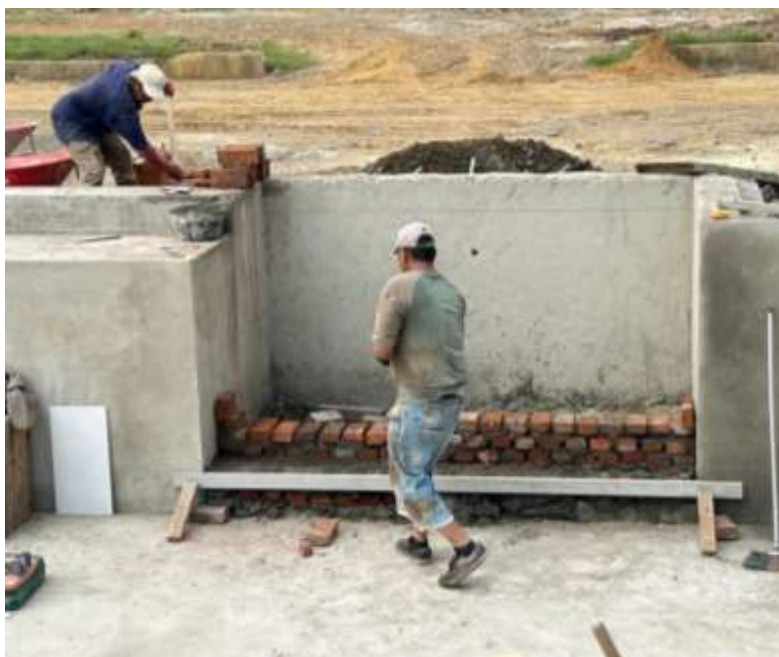
Figura 8.23 Inicio de construcción escalera para piscina
