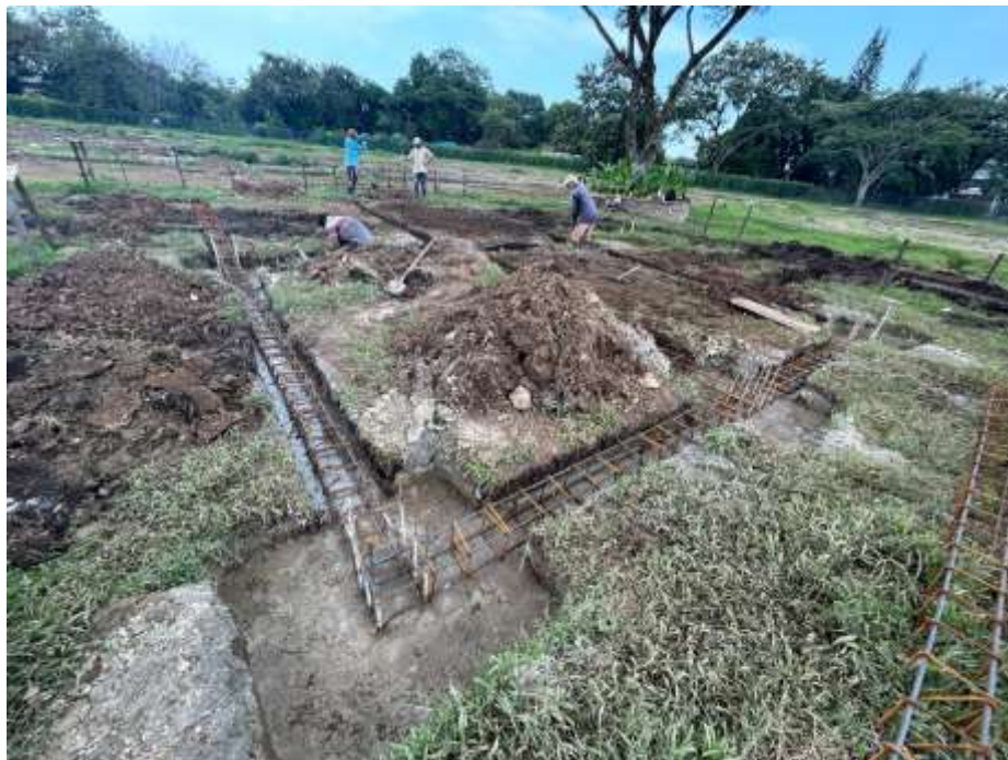
Figura 8.68 Ubicación del armado para las vigas de cimentación
