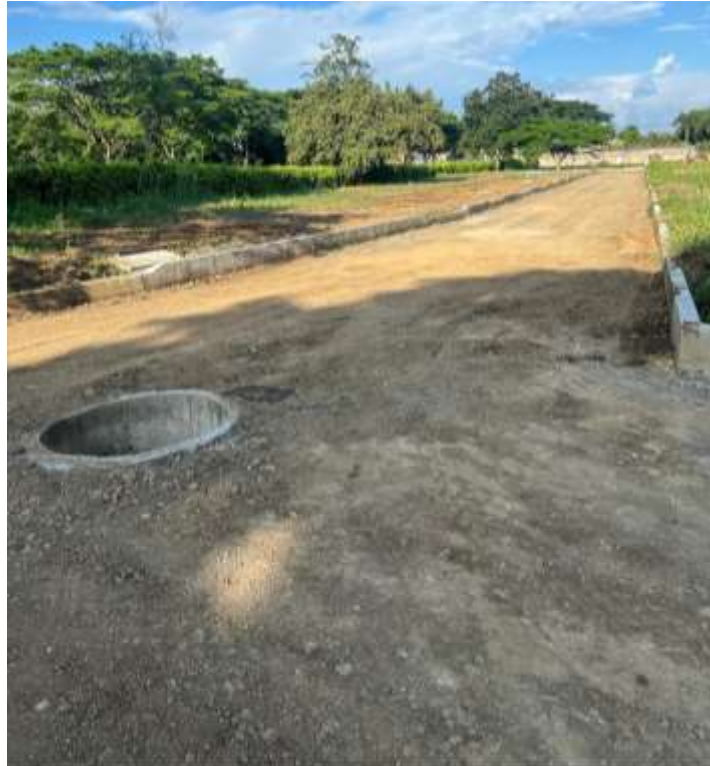
Figura 8.64 Vía A nivelada
