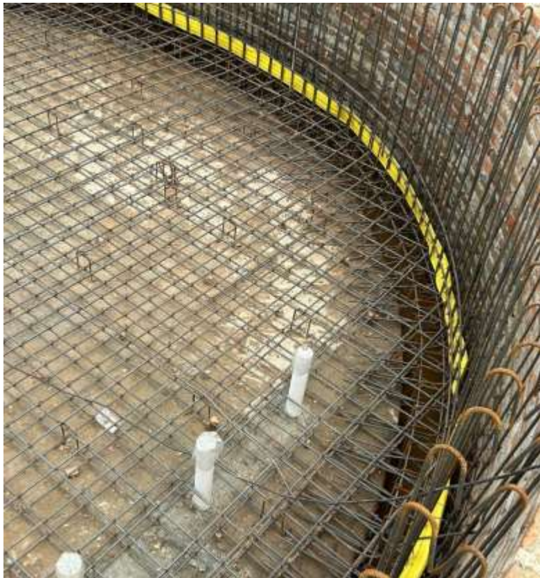
Figura 8.7 Armado de acero y cinta PVC para juntas de muros en piscinas
