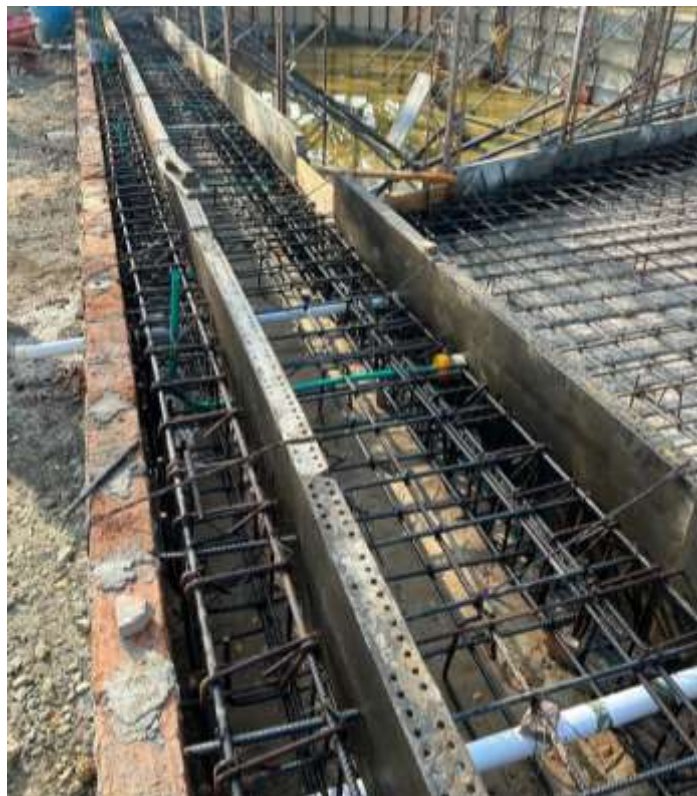
Figura 8.18 Instalación de tubería para desnatadoras, inyectoros, etc.
