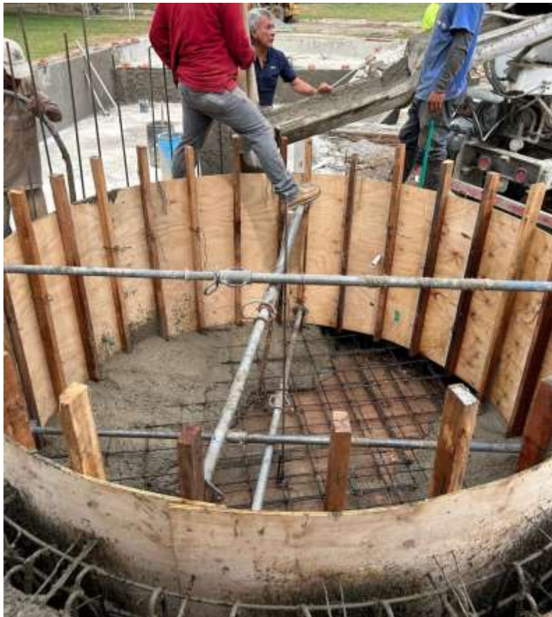
Figura 8.31 Fundición de paredes y piso para jacuzzi
