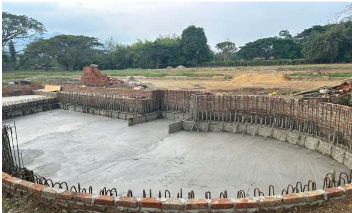
Figura 8.12 Fundición de piso y paredes finalizada
