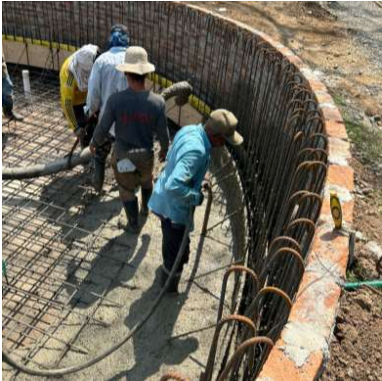
Figura 8.9 Inicia fundición con los 40 cm de las paredes
