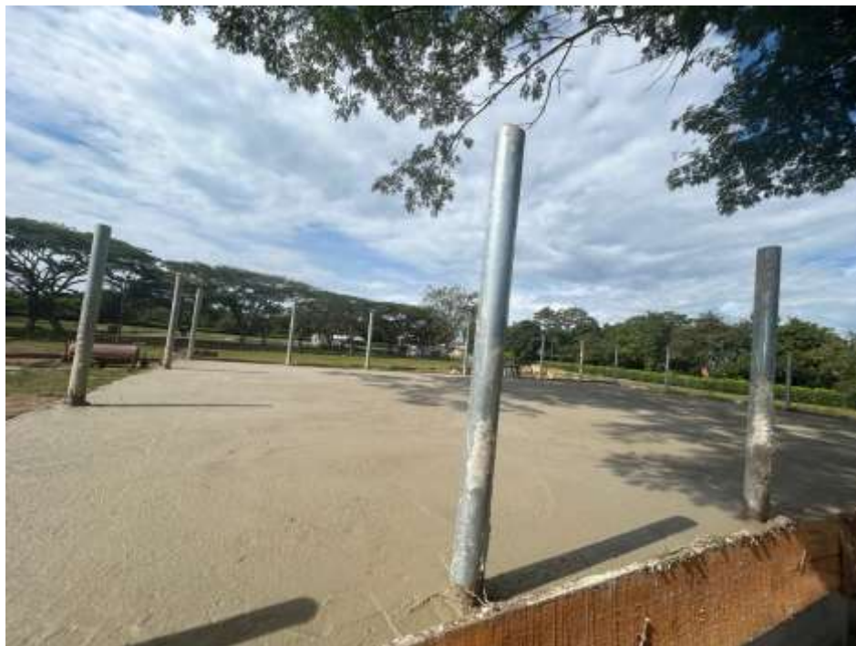
Figura 8.81 Losa aligerada finalizada
