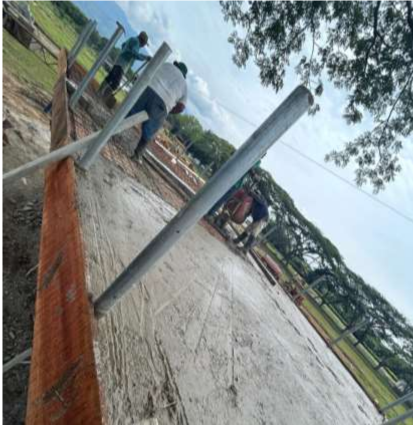
Figura 8.80 Fundición de losa aligerada
