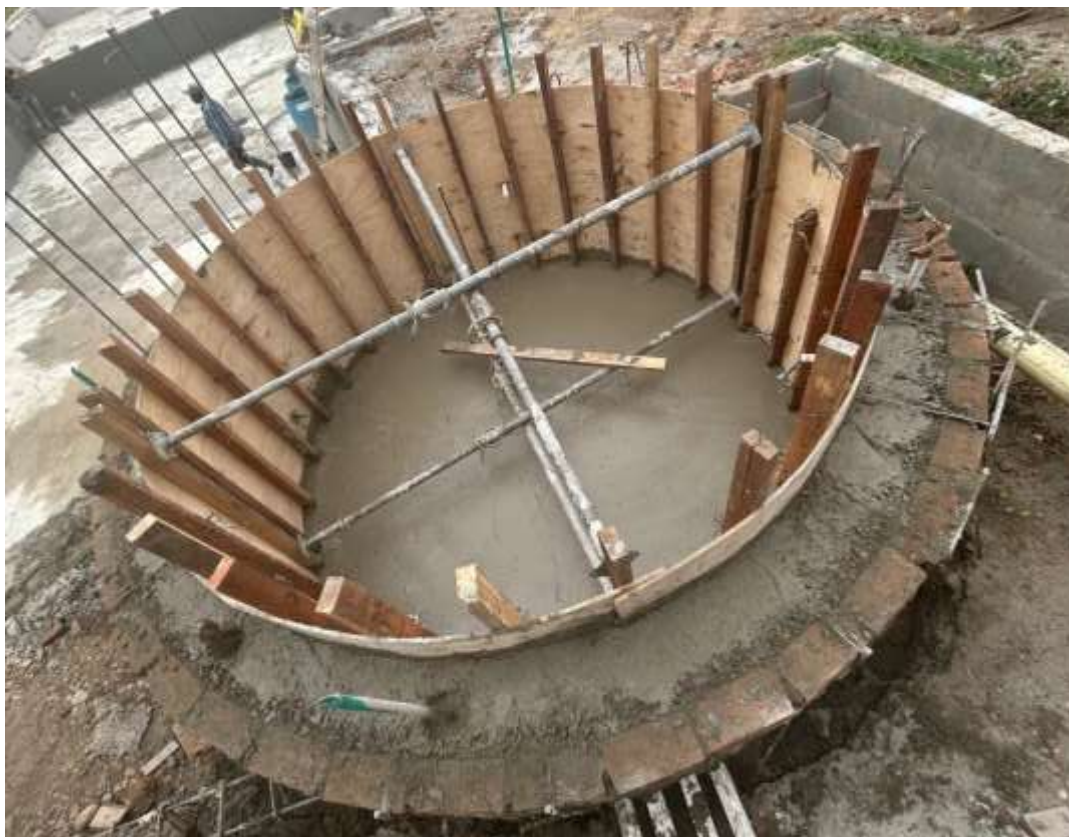
Figura 8.32 Fundición de jacuzzi finalizada
