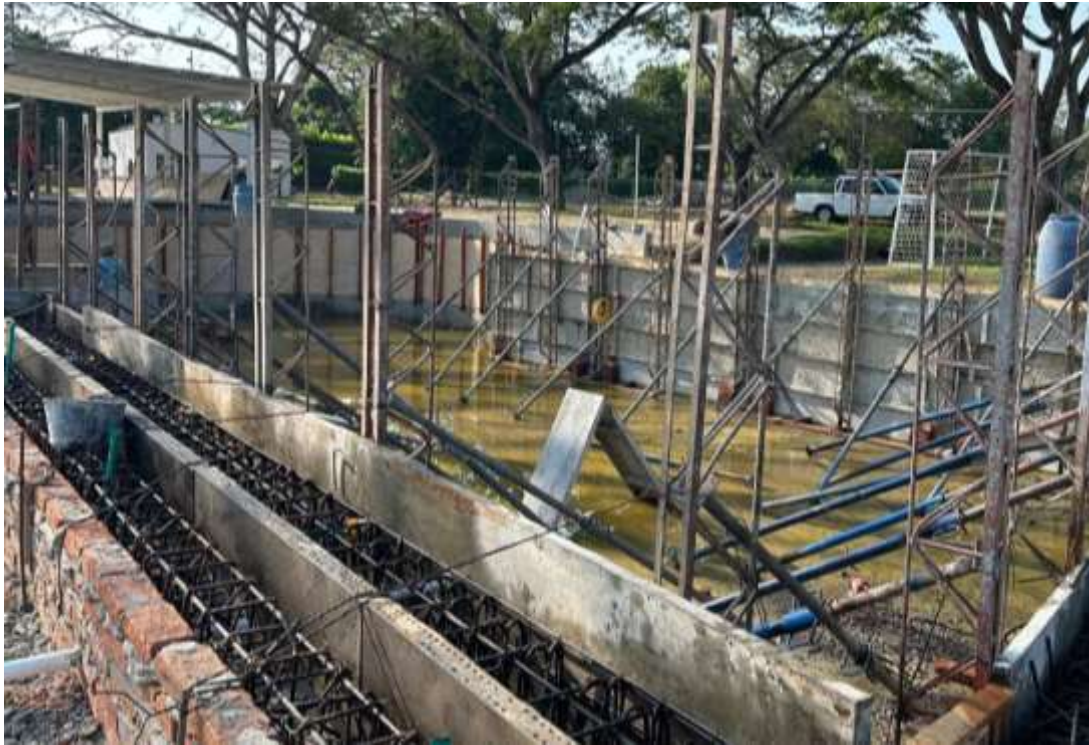
Figura 8.17 Estructura formaleada lista para fundición
