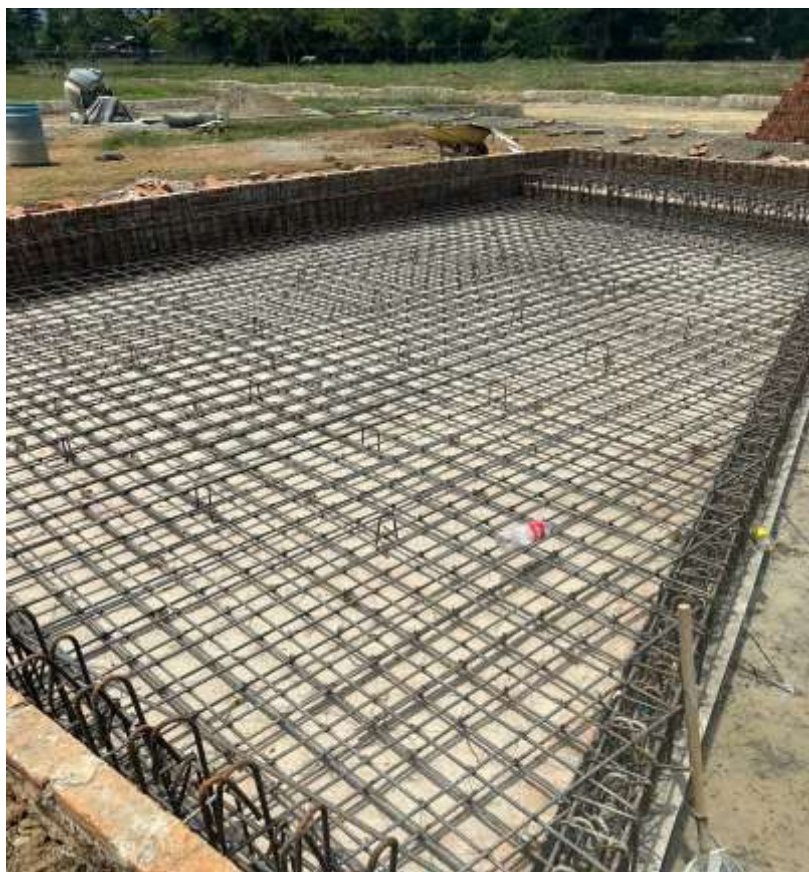
Figura 8.15 Malla en la zona de niños finalizada
