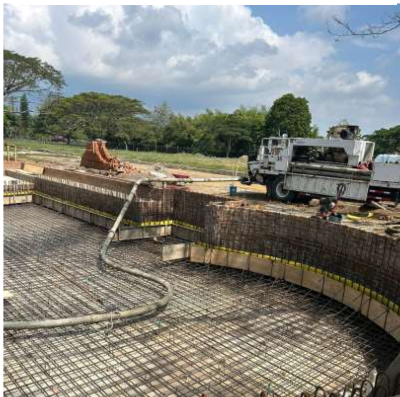
Figura 8.8 Estructura formaleteada y lista para fundición
