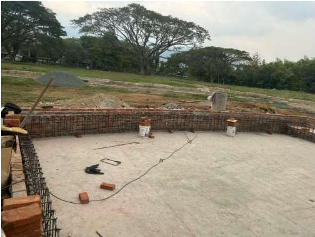
Figura 8.13 Acero viga perimetral en la zona de niños
