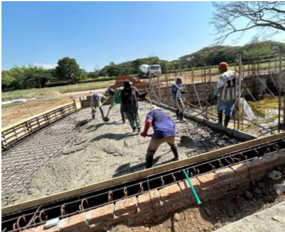
Figura 8.20 Fundición de piso y viga en la zona de niños
