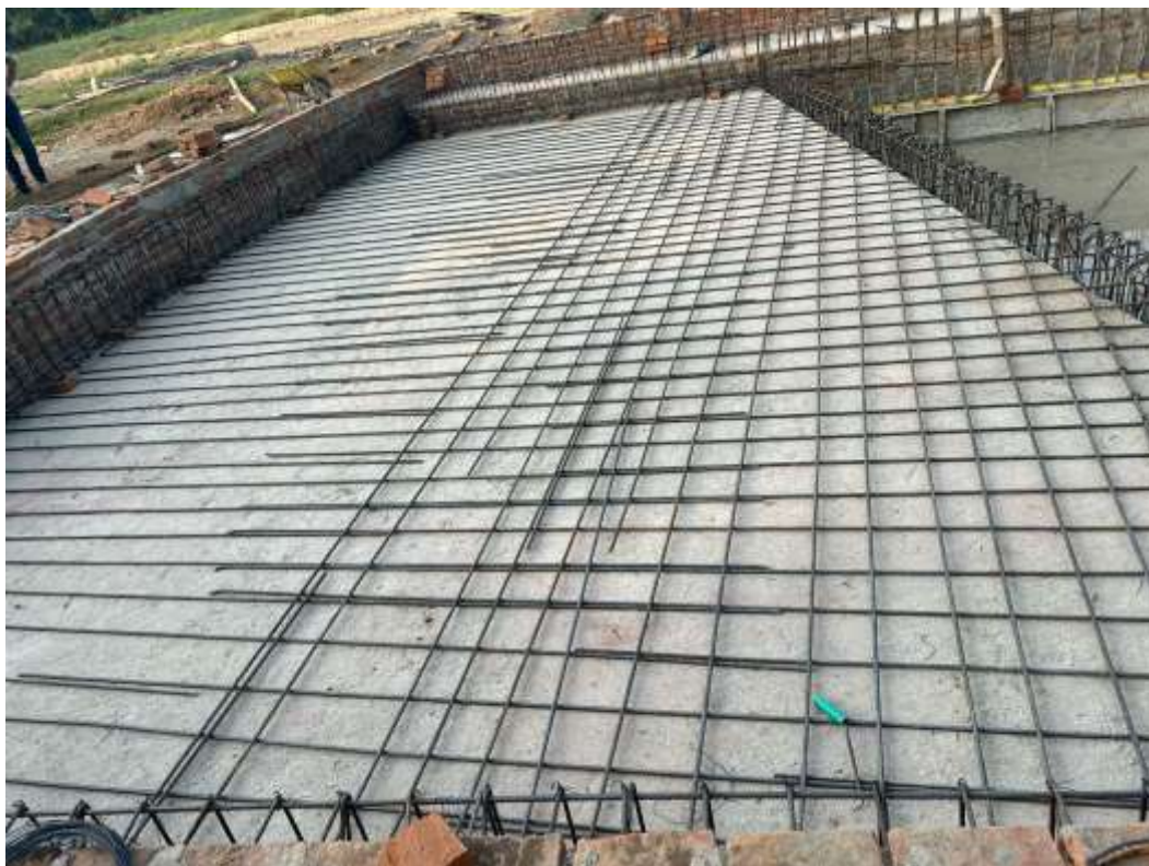
Figura 8.14 Acero de malla para piso en la zona de niños
