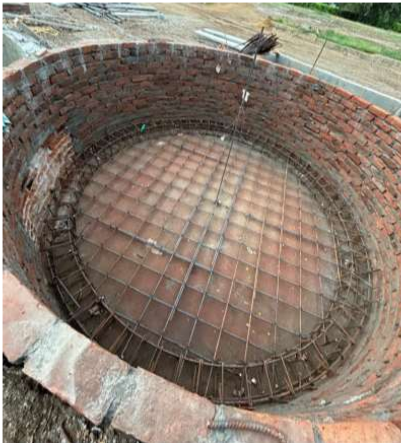
Figura 8.28 Acero de la viga de amarre y malla del piso
