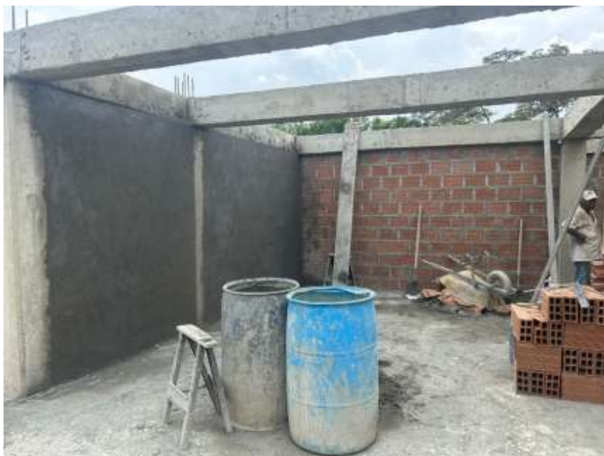
Figura 8.58 Muros del tercer piso repellados
