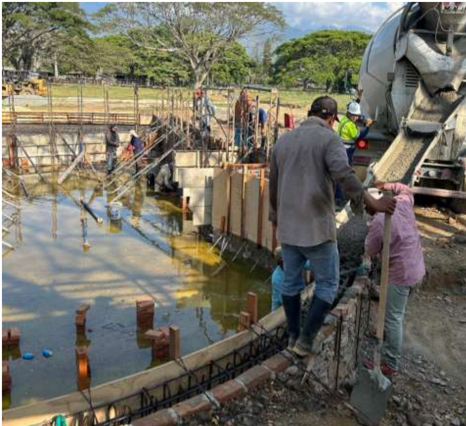
Figura 8.19 Fundición final de las paredes
