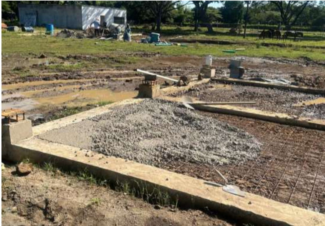
Figura 8.71 Fundición de sobrepiso a nivel de las vigas
