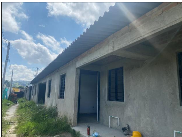
Ilustración 35. Senderos peatonales en mal estado. Fuente: Elaboración propia.
