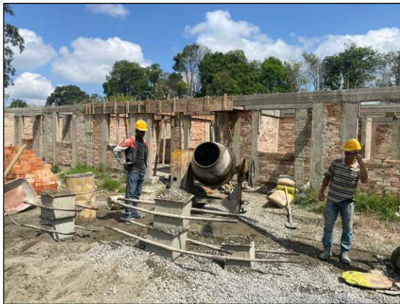
Ilustración 31. Dosificación del concreto.
