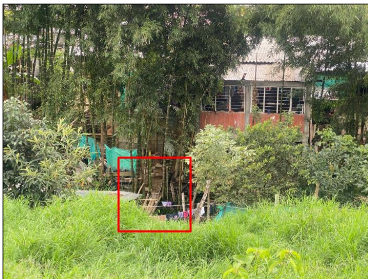
Ilustración 40. Afectación a la zona de protección ambiental. Fuente: Elaboración propia.
