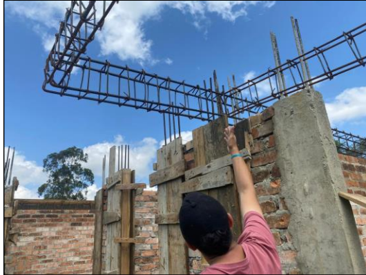
Ilustración 33. Verificación en la zona de confinamiento estructural. Fuente: Elaboración propia.
