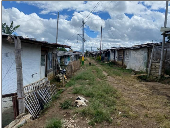
Ilustración 60. Construcciones ilegales asentamiento Sinái. Fuente: Elaboración propia.
