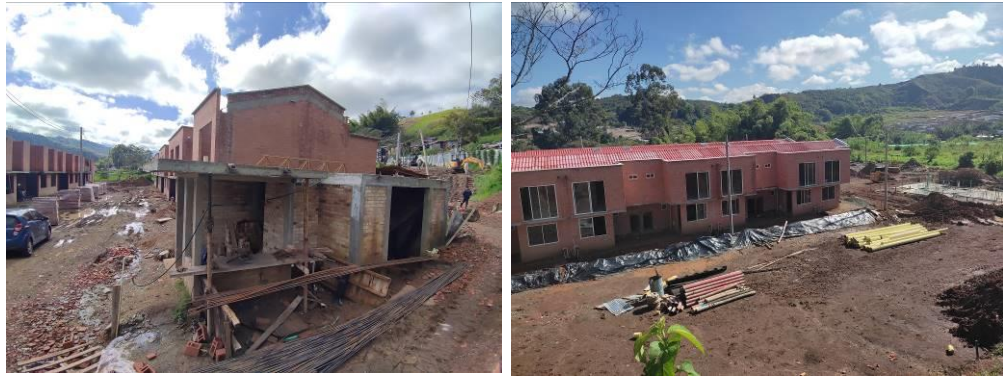
Imágenes 7.9.1 Avance de obra manzana referencia
