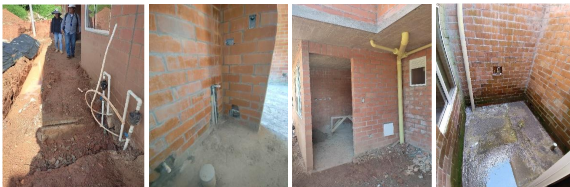
Imágenes 7.9.4 distribución agua potable, pluvial y sanitaria
