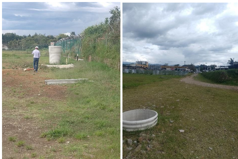
Imágenes 7.3.2 Recamaras de inspección sistema de alcantarillado
