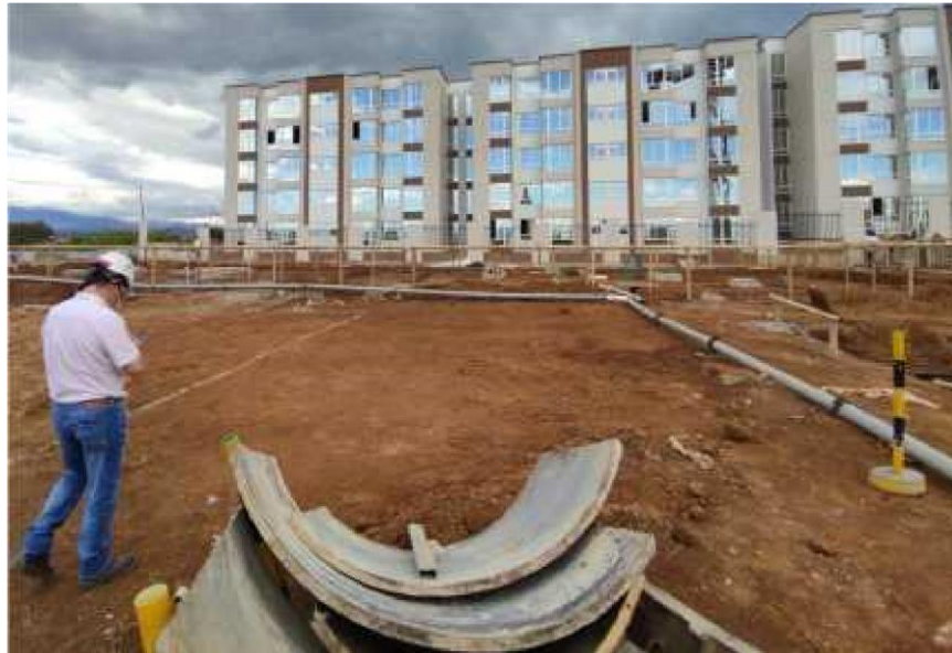
Imagen 7.6.7 Formaleta para fundición de recámara 1.5m D
