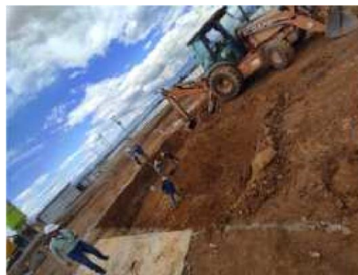
Imagen 7.6.5 Excavación tanque de almacenamiento
