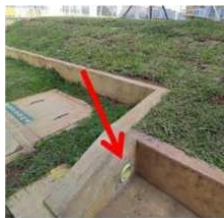
Imágenes 7.4.5 Tanque almacenamiento con salida de excesos
