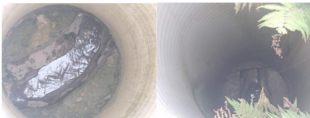
Imágenes 7.3.3 Interior de recamaras de inspección sistema de alcantarillado
