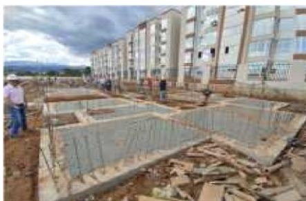
Imagen 7.6.3 Cimientos torre H
