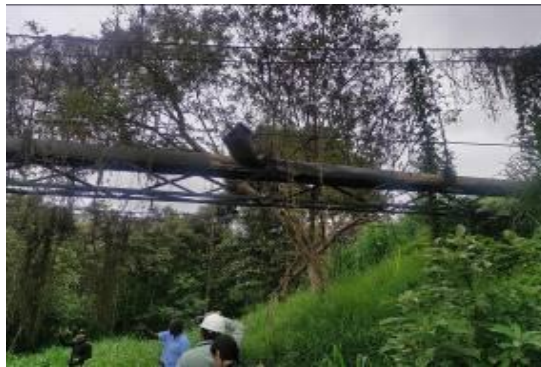
Imagen 7.8.5 viaducto de aguas servidas Zuldemaida
