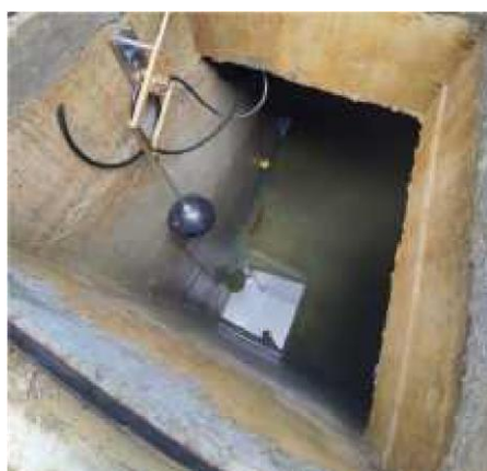
Imágenes 7.4.5 Tanque almacenamiento con salida de excesos
