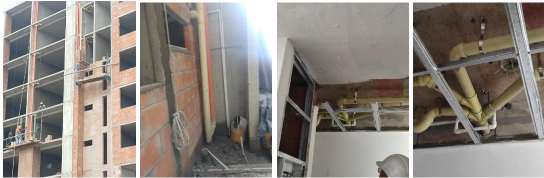
Imágenes 7.10.6 Torre en construcción
