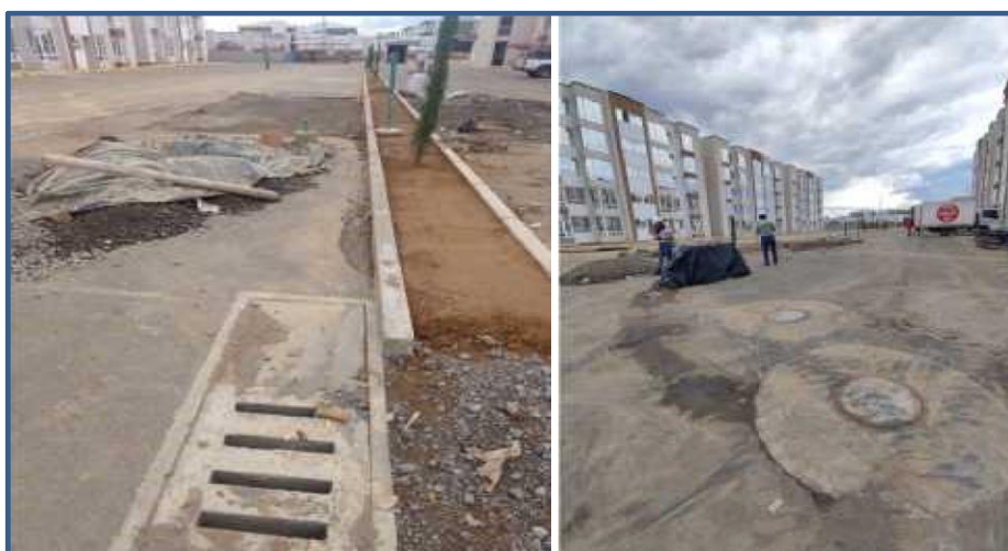
Imágenes 7.5.9 Sumidero zona de parqueaderos y recamaras de inspección sanitaria
