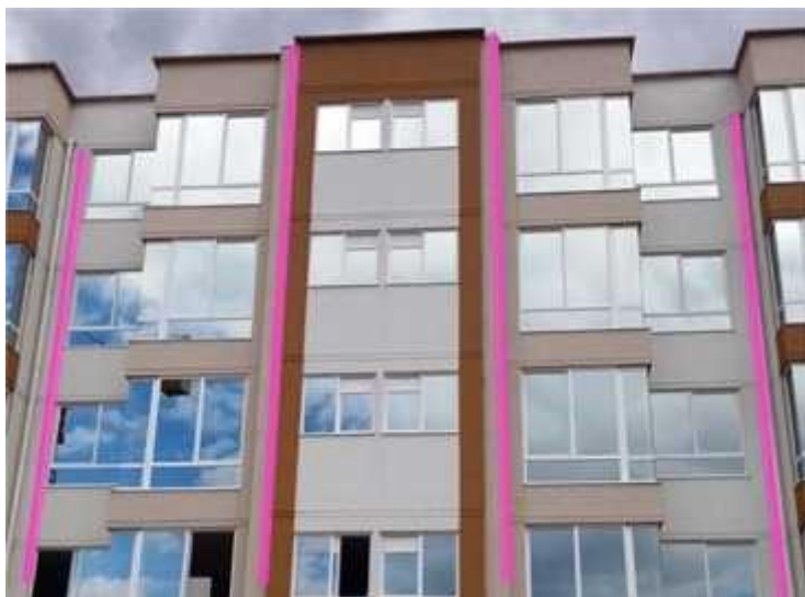
Imagen 7.5.8 Señalización de bajantes por Torre - Fachada
