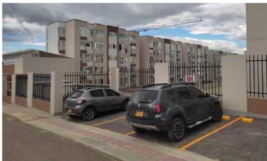
Imagen 7.5.3 Fachada principal Urbanización Arrayanes
