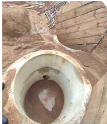
Imagen 7.6.9 Detalle recámara alcantarillado
