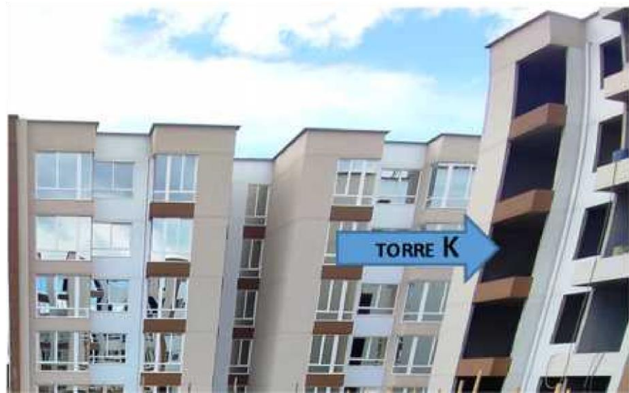
Imagen 7.5.4 Torre K en proceso de construcción acabados e instalaciones
