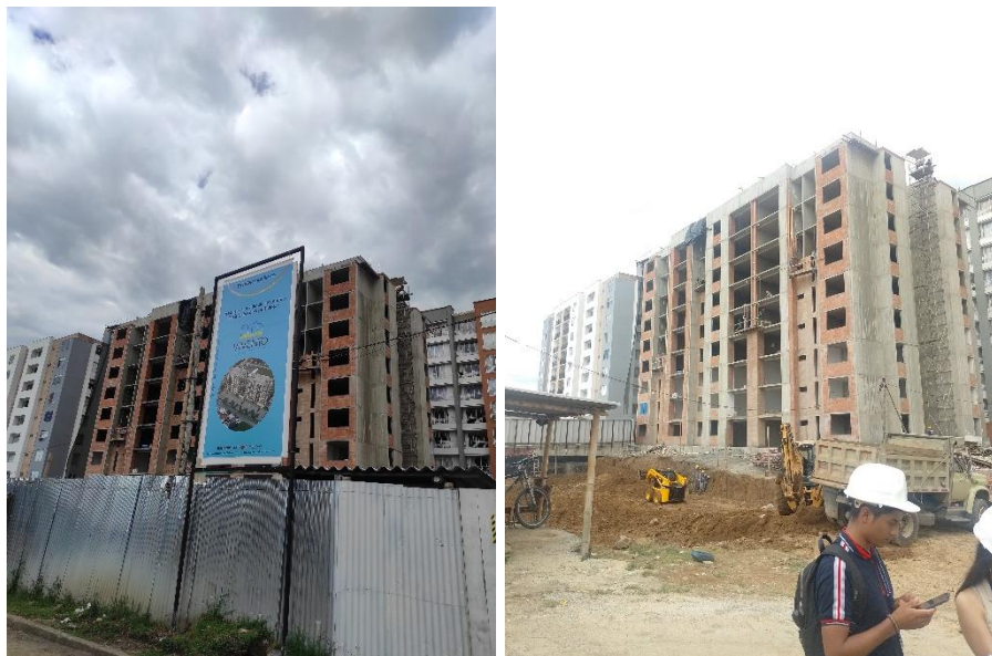
Imágenes 7.10.1 Torres condominio Viento
