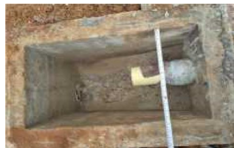
Imagen 7.6.2 Caja de inspección 40cm
