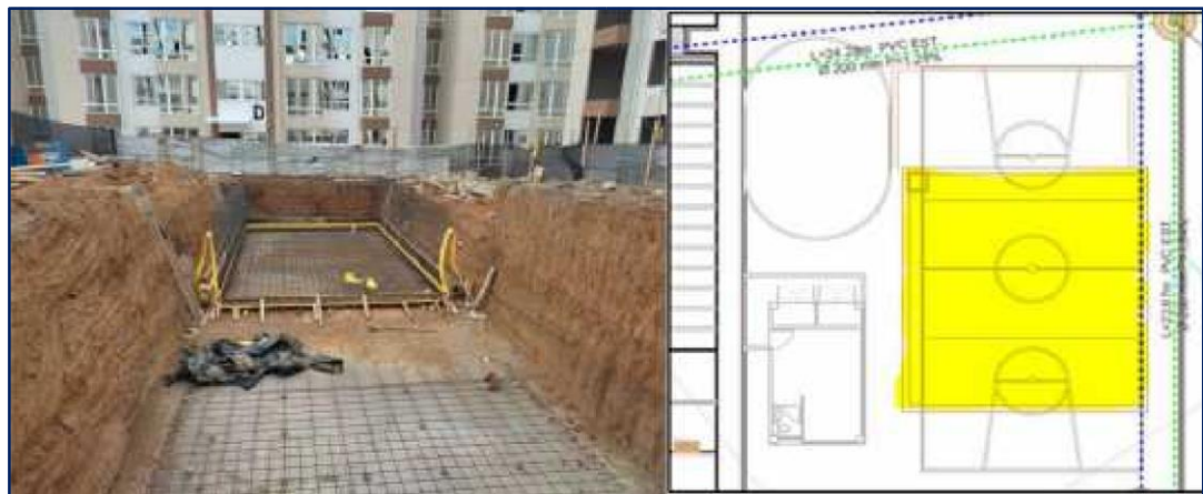
Imagen 7.5.5 Tanque de almacenamiento compartido en proceso de construcción – Esquema
