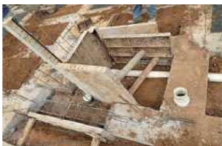
Imagen 7.6.4 Encofrado Fundición Viga
