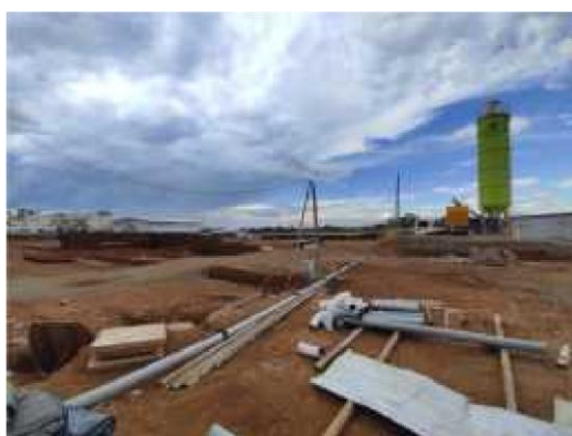
Imagen 7.6.6 Línea de suministro de concreto mediante bombeo
