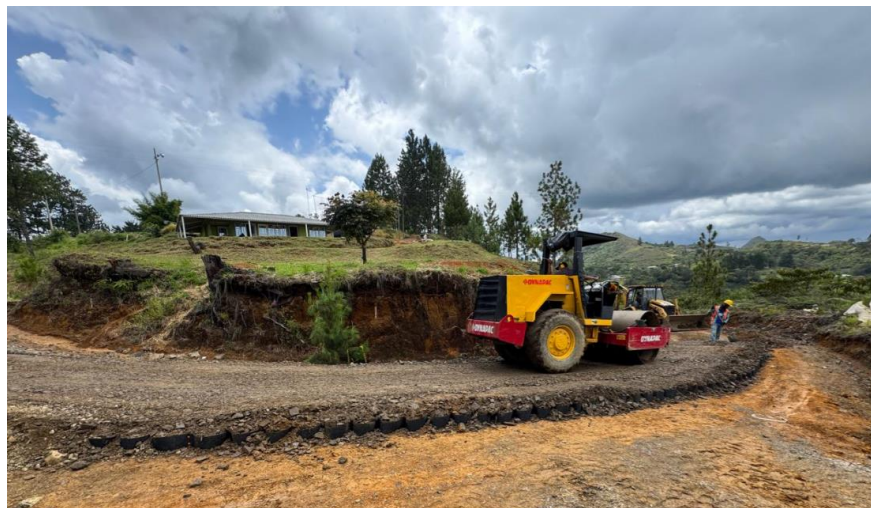
Figura 51. Compactacion de Material en Geoceldas.
