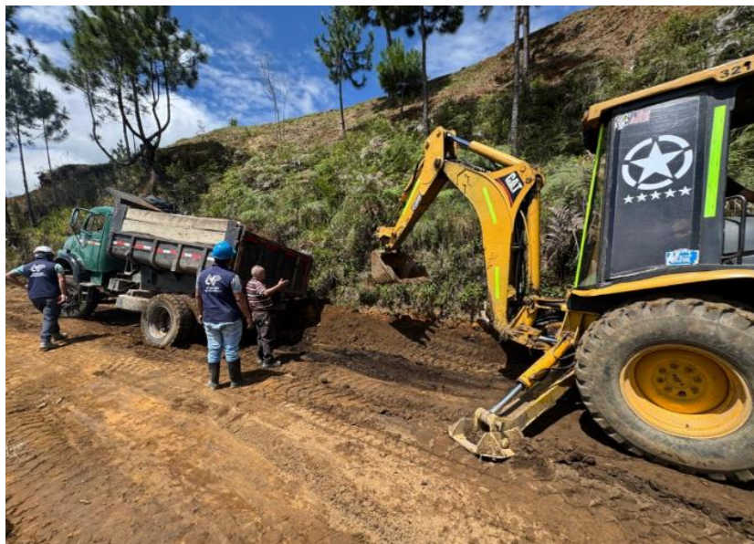
Figura 37. Excavación puntual para retiro de material no apto en subrasante – Zona B.
