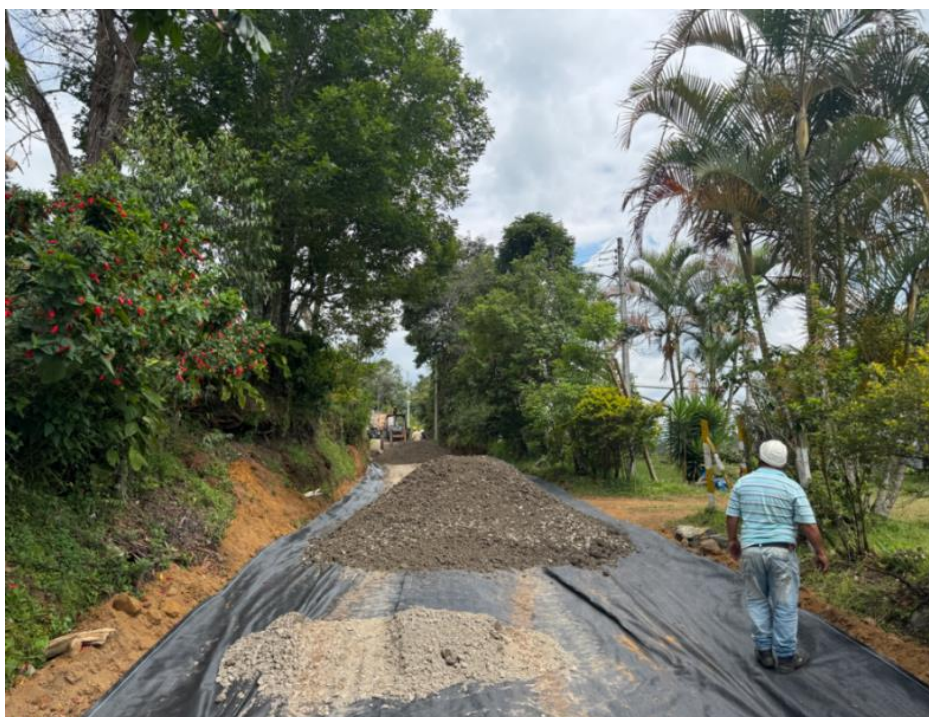
Figura 26. Descarga y distribución del mejoramiento granular sobre geotextil instalado.
