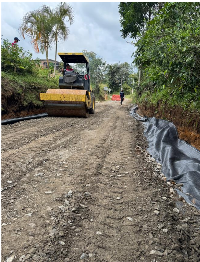
Figura 29. Compactación Capa de 0.10m de Mejoramiento sobre Geotextil.
