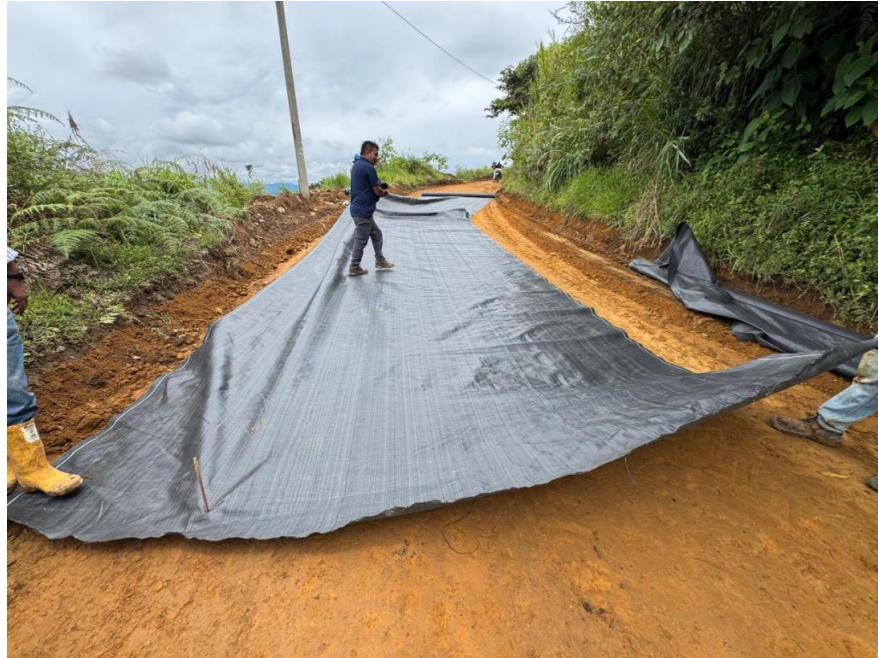
Figura 61. Instalación de Geotextil-Tramo 3.
