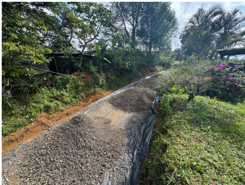
Figura 27. Acopio y distribución de material de mejoramiento.
