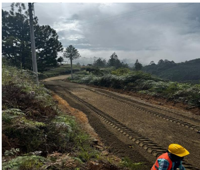
Figura 53. Instalación y Conformación de Material tipo RCD
