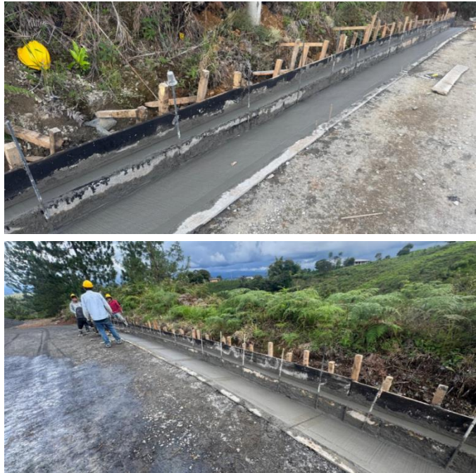
Figura 90. Detalle constructivo: Conformación de cunetas
