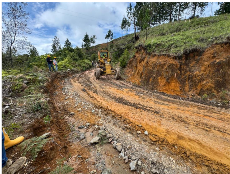
Figura 35. Excavación inicial de subrasante con motoniveladora – Tramo 2.
