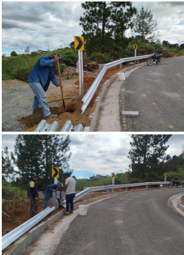
Figura 106. Instalación de Defensas Metálicas Viales tipo Guardavías.
