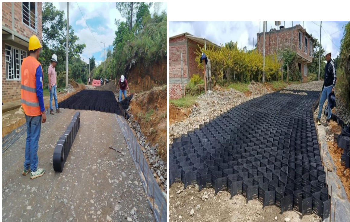
Figura 69. Instalación de Geoceldas Tramo 3
