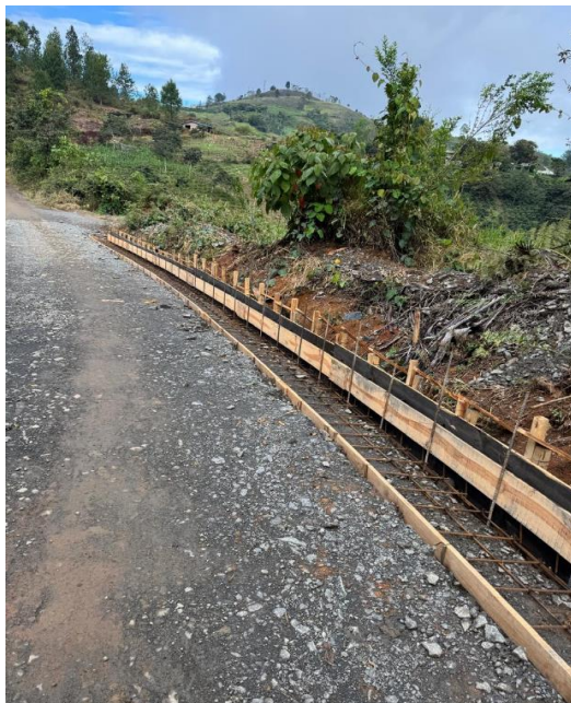
Figura 88. Encofrado e instalación de acero de refuerzo para Cunetas.
