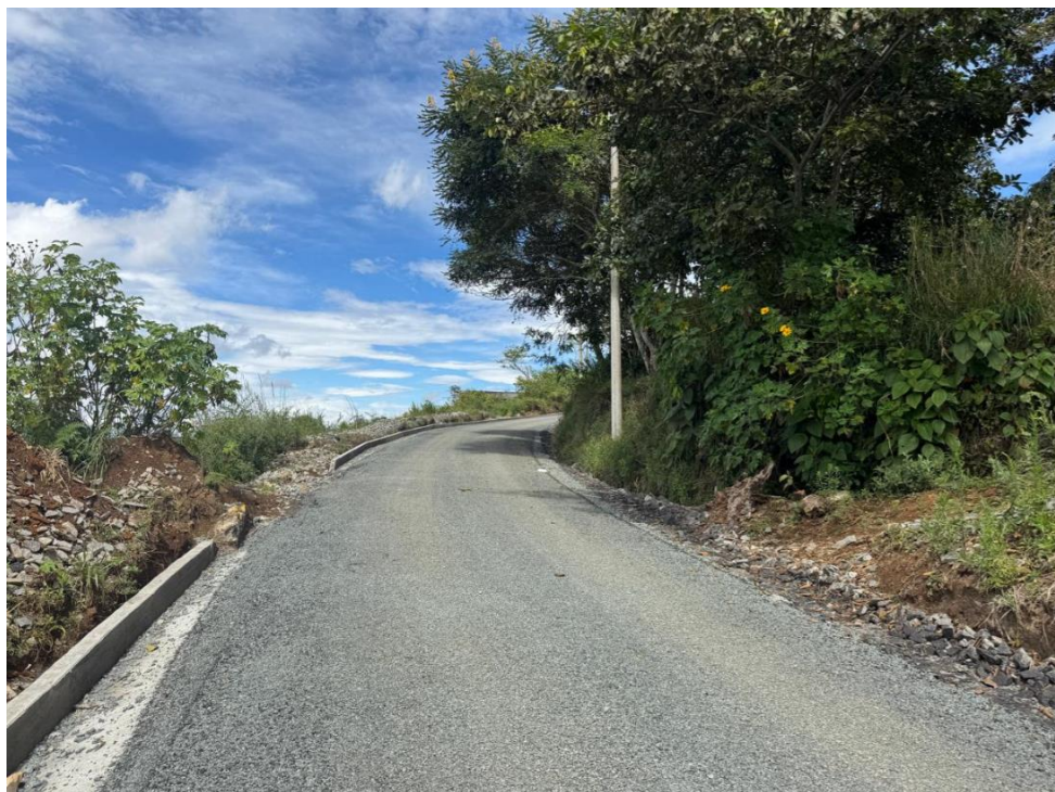
Figura 104. Tratamiento Superficial Doble - Tramo 3: K15+371,4 - K15+650.
