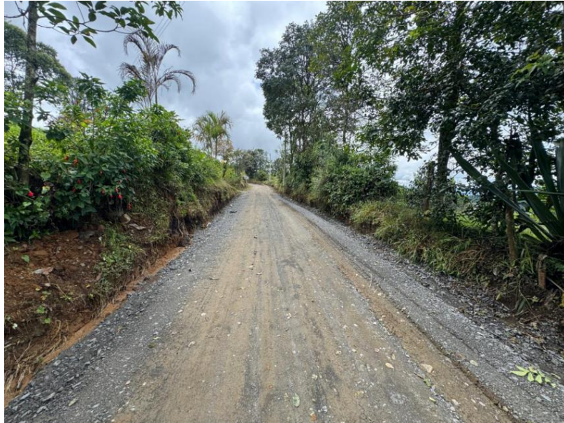
Figura 32. Finalización de la estructura vial del Tramo 1 con geotextil, mejoramiento y afirmado.
