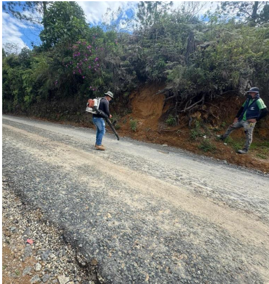
Figura 92. Limpieza y Preparación de la calzada para Imprimación.
