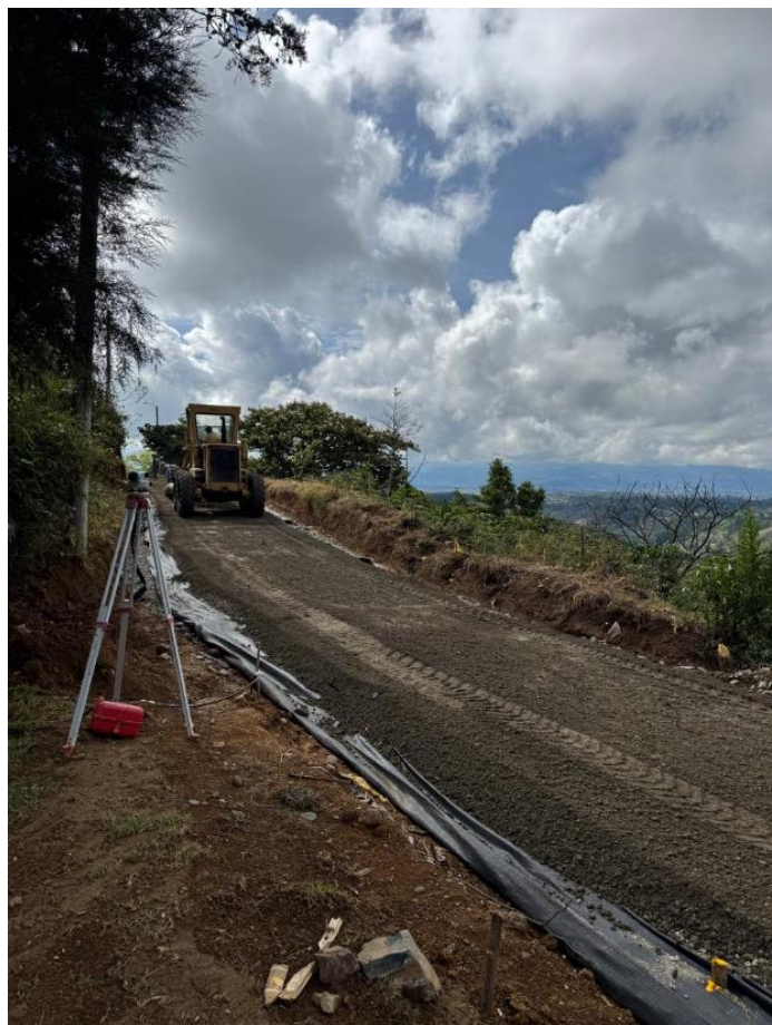
Figura 64. Nivelación y distribución de material tipo Mejoramiento con Motoniveladora.
