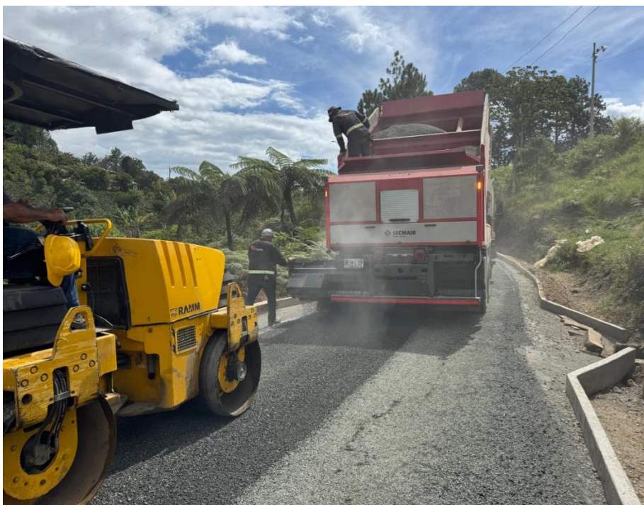
Figura 96. Instalación de Tratamiento Superficial Doble - Acompañamiento de Vibrocompactador
