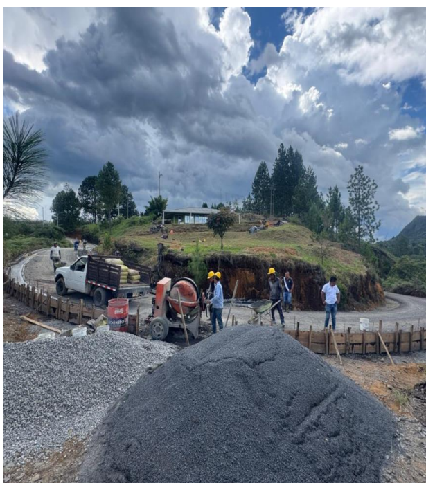
Figura 89. Vaciado de concreto en Cunetas.
