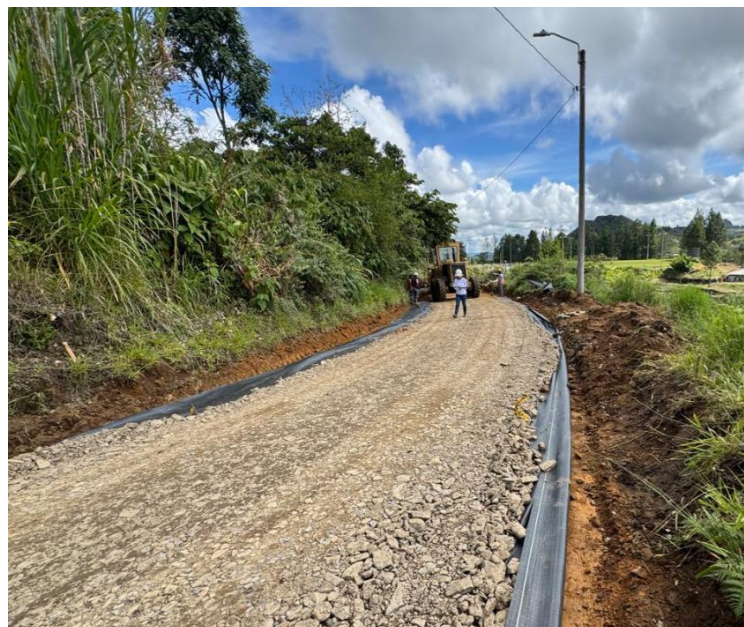
Figura 66. Instalación Capa afirmado sobre Geotextil.
