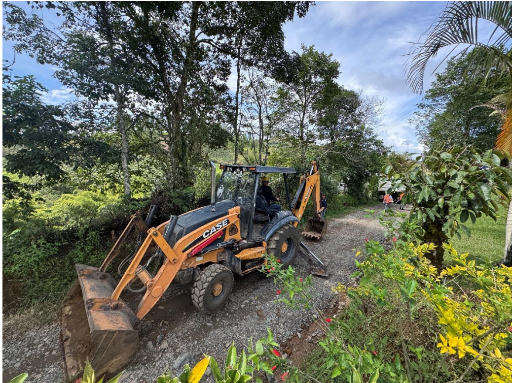
Figura 15. Retroexcavadora utilizada para la excavación
