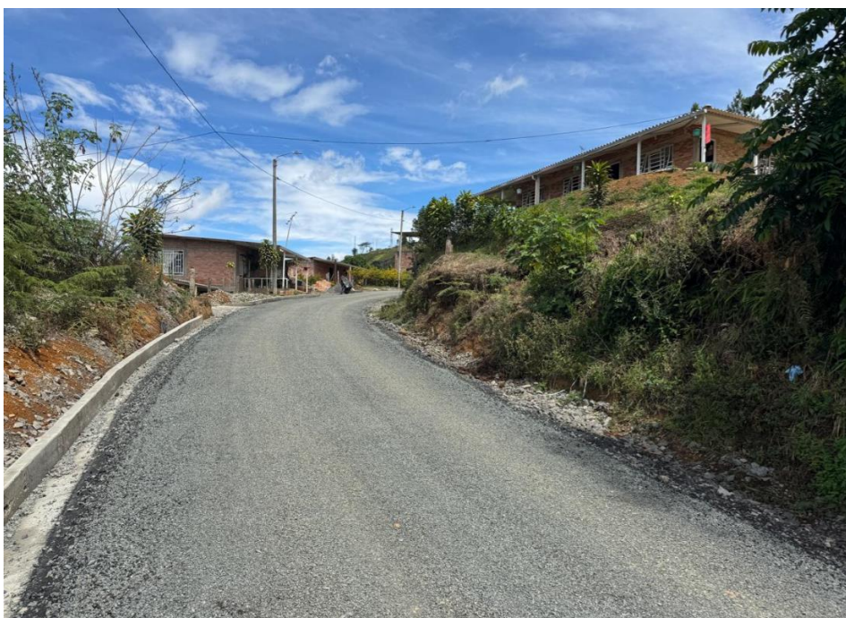
Figura 105. Tratamiento Superficial Doble - Tramo 3: K15+371,4 - K15+650.
