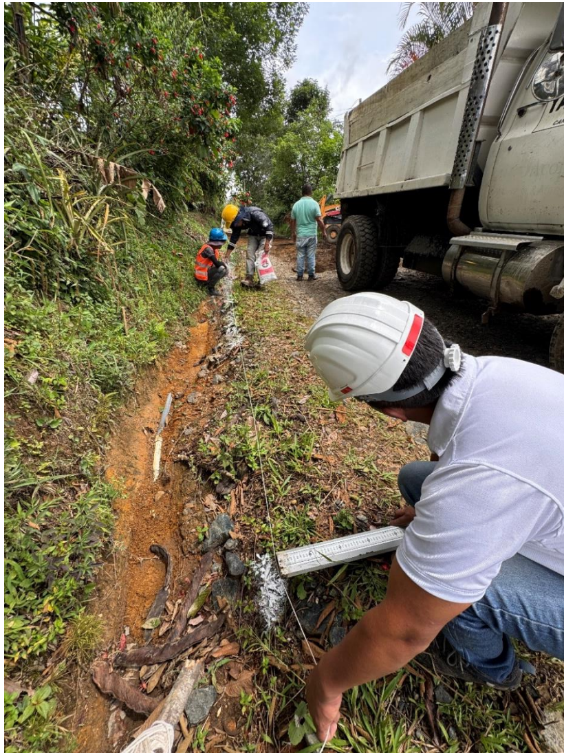
Figura 14. Delimitación de Bordes Laterales para Excavación.
