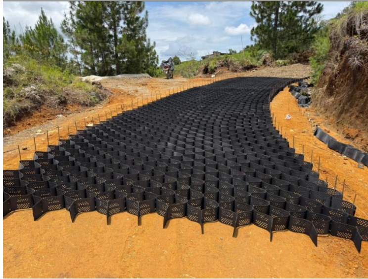
Figura 48. Instalación de Geoceldas en curva-Tramo 2.
