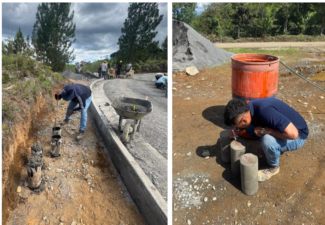
Figura 109. Resistencia del Concreto – Cilindros Tramo 2 y 3: K15+076,4 - K15+650.
