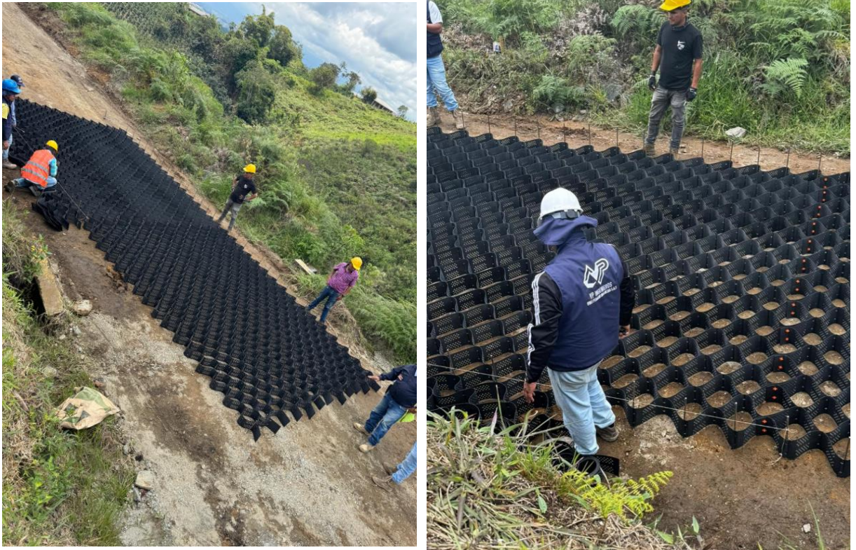
Figura 47. Instalación y Unión mediante Pines entre paneles de Geoceldas.
