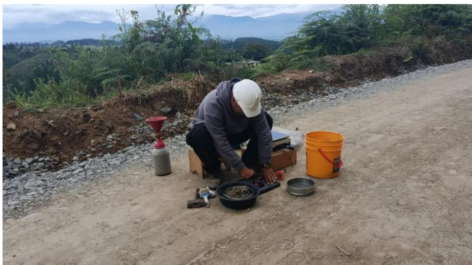
Figura 108. Cono de Arena Tramo 3: K15+371,4 - K15+650.
