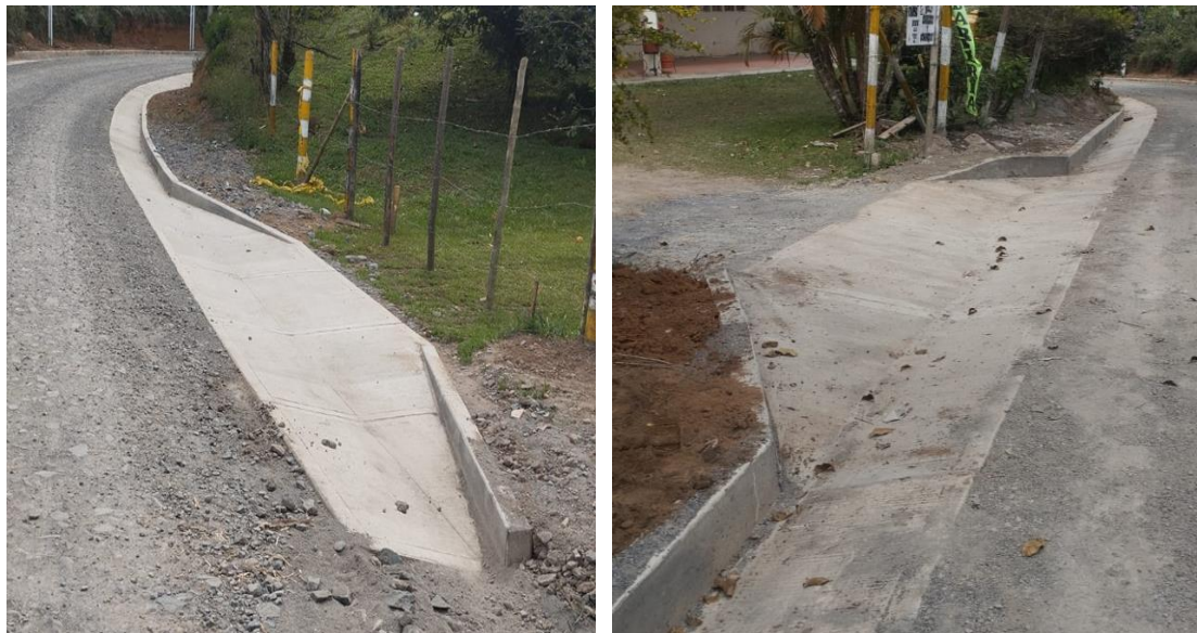
Figura 91. Conformación final de Cunetas.
