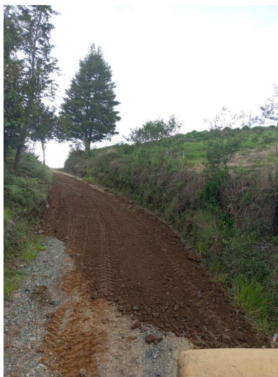
Figura 115. Reparación y Estado Final de Calzada.
