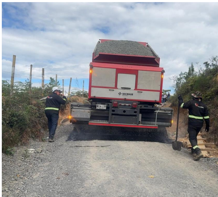
Figura 95. Instalación de Tratamiento Superficial Doble - Capa \frac{3}{4}
