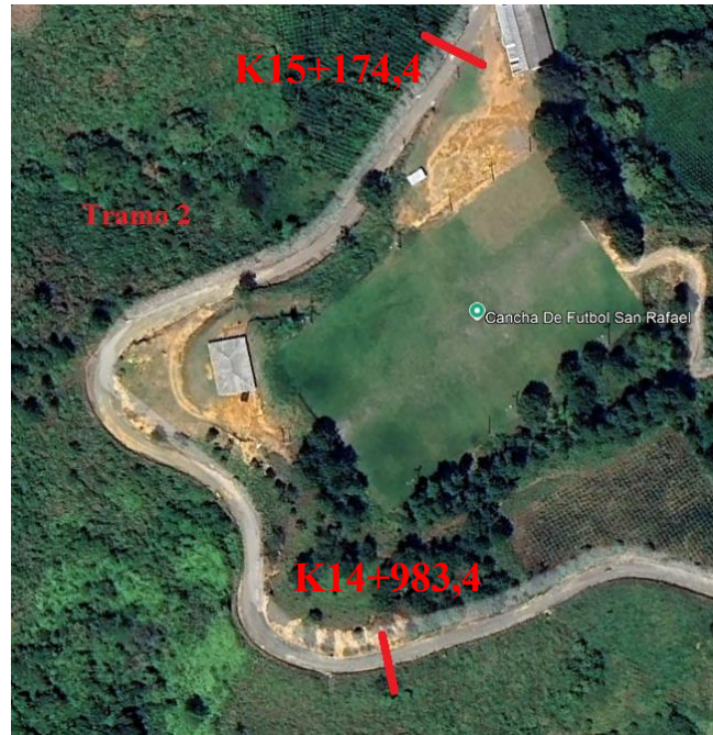
Figura 33. Identificación Tramo 2: K14+983,4 - K15+174,4.
