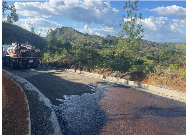
Figura 93. Instalación de Imprimación.
