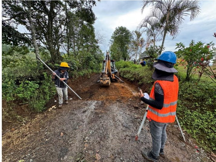
Figura 17. Verificación topográfica de niveles durante excavación.
