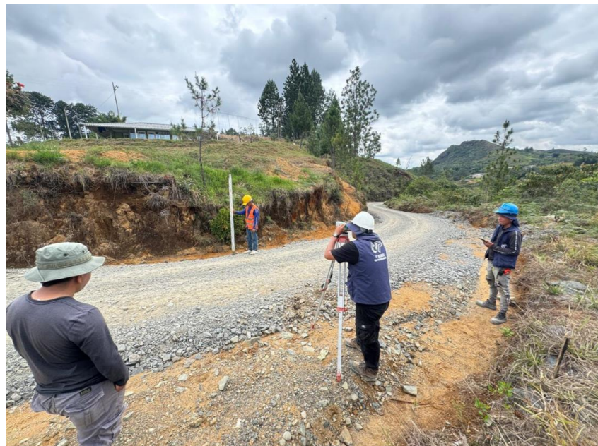
Figura 42. Revisión topográfica del espesor y bombeo en afirmado del Tramo 2
