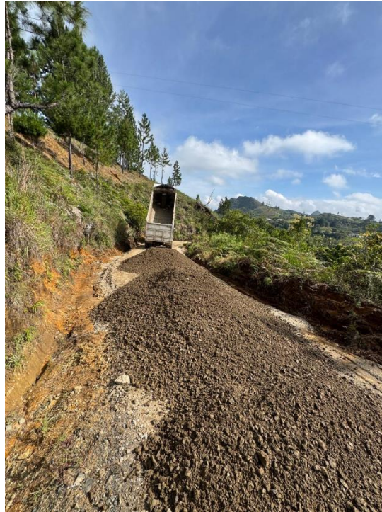
Figura 39. Descargue de Material tipo Afirmado Tramo 2.
