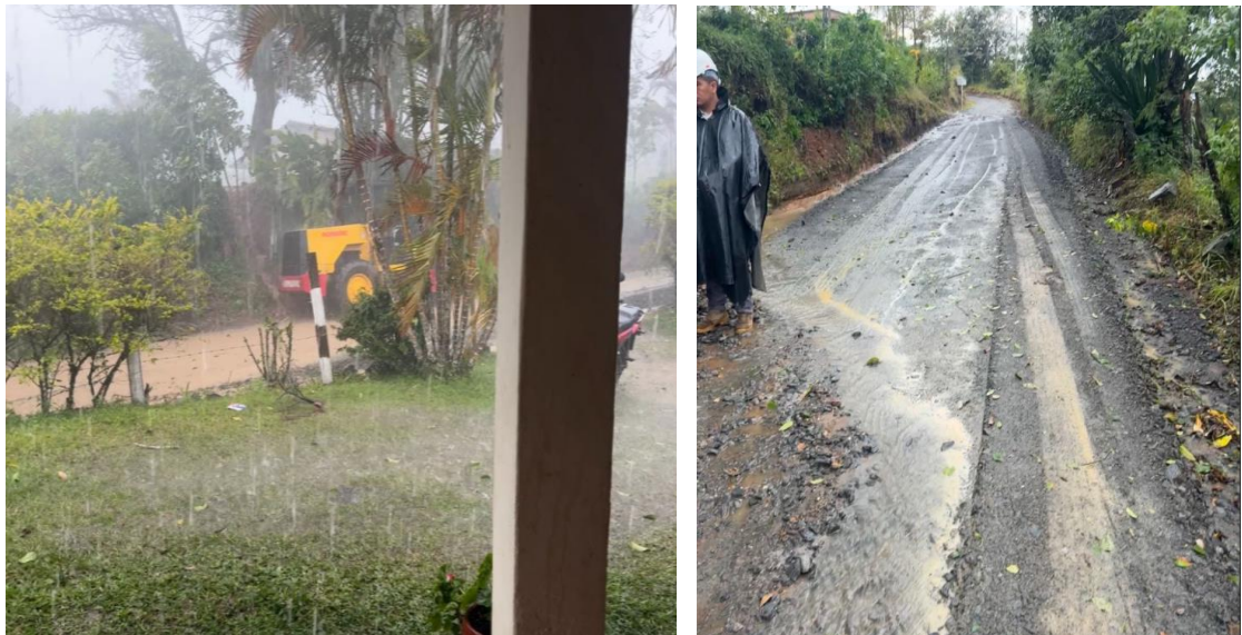
Figura 116. Condiciones Climáticas Adversas en la Obra
