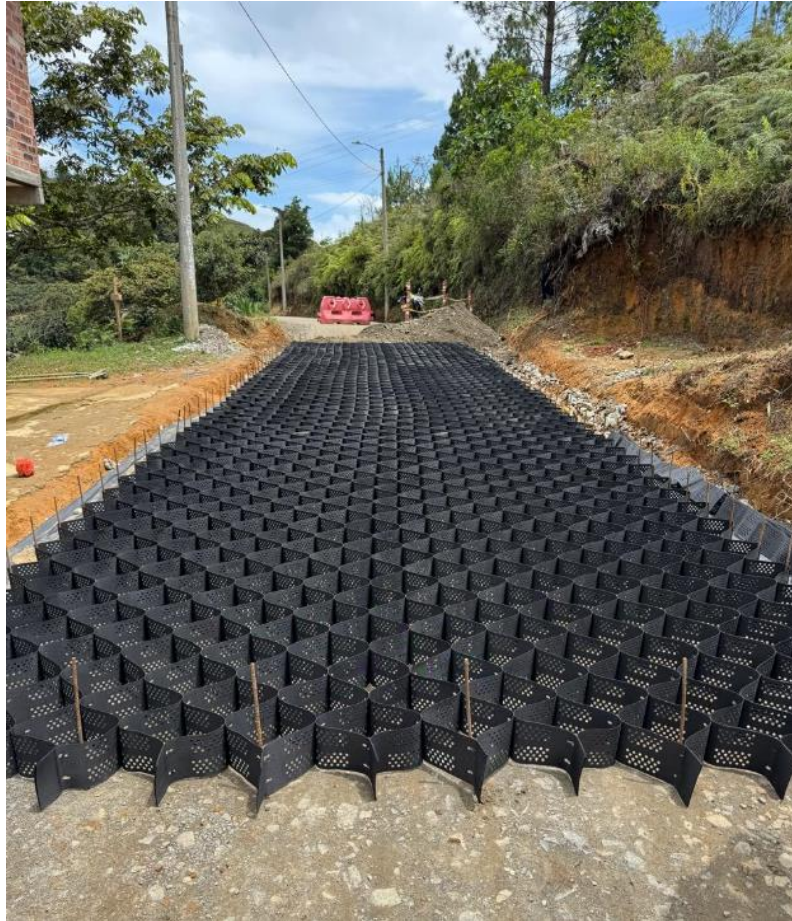
Figura 70. Instalación Geoceldas Tramo 3.
