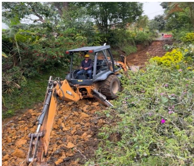
Figura 18. Excavación hasta nivel de subrasante.
