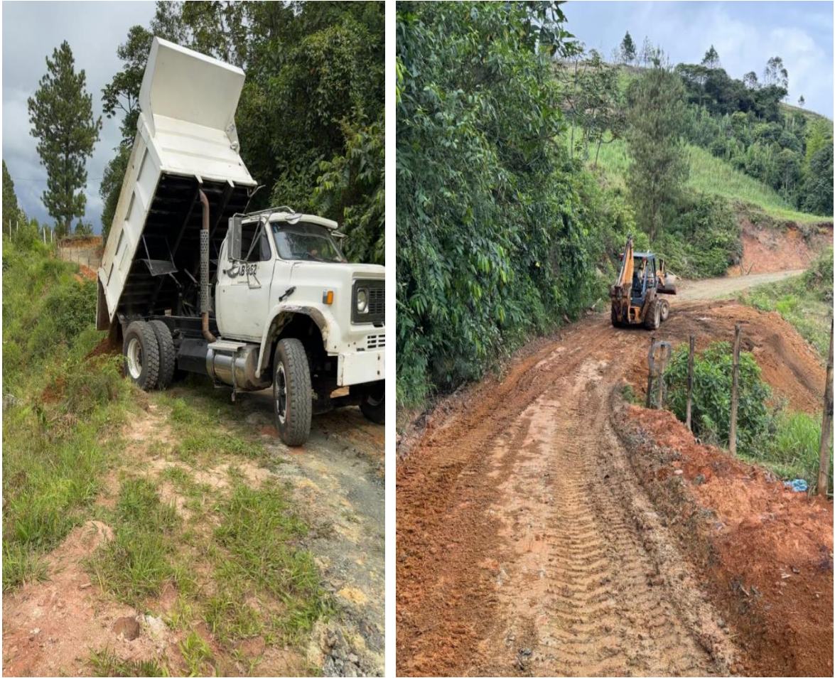
Figura 112. Centro de Acopio de Material de Excavación.
