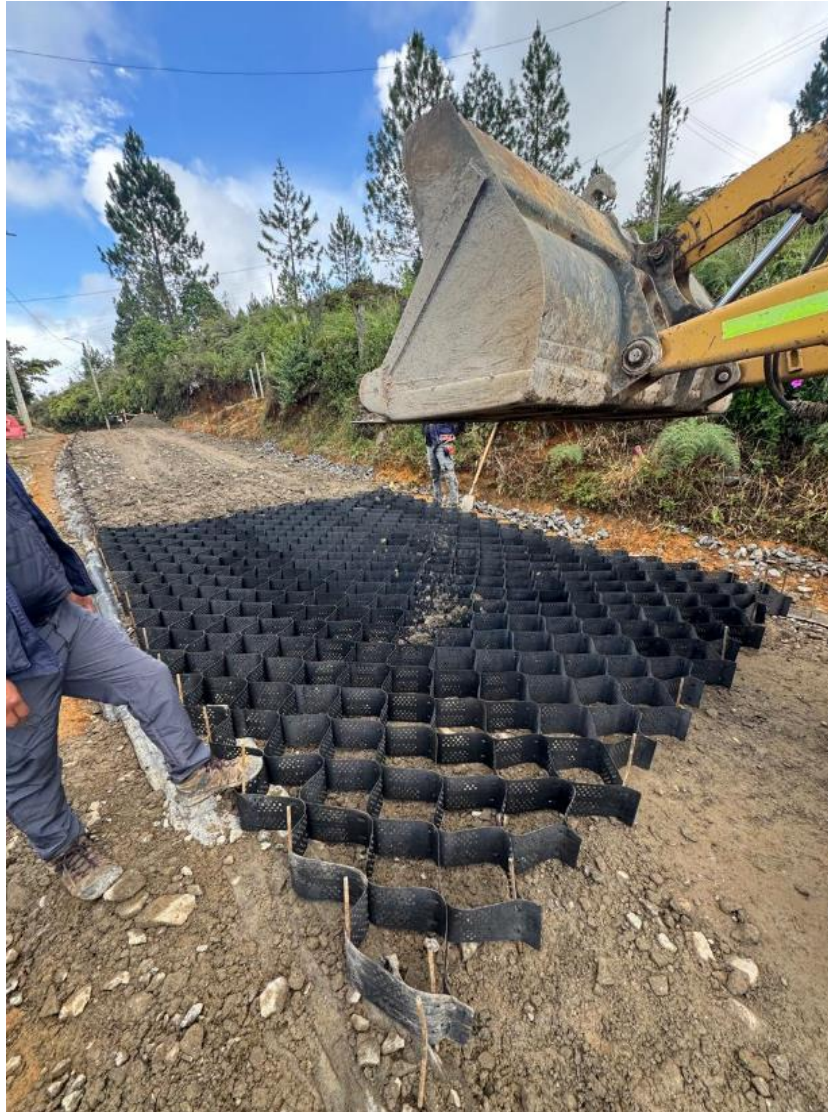
Figura 71. Llenado de Material tipo Afirmado en Geoceltadas-Tramo 3
