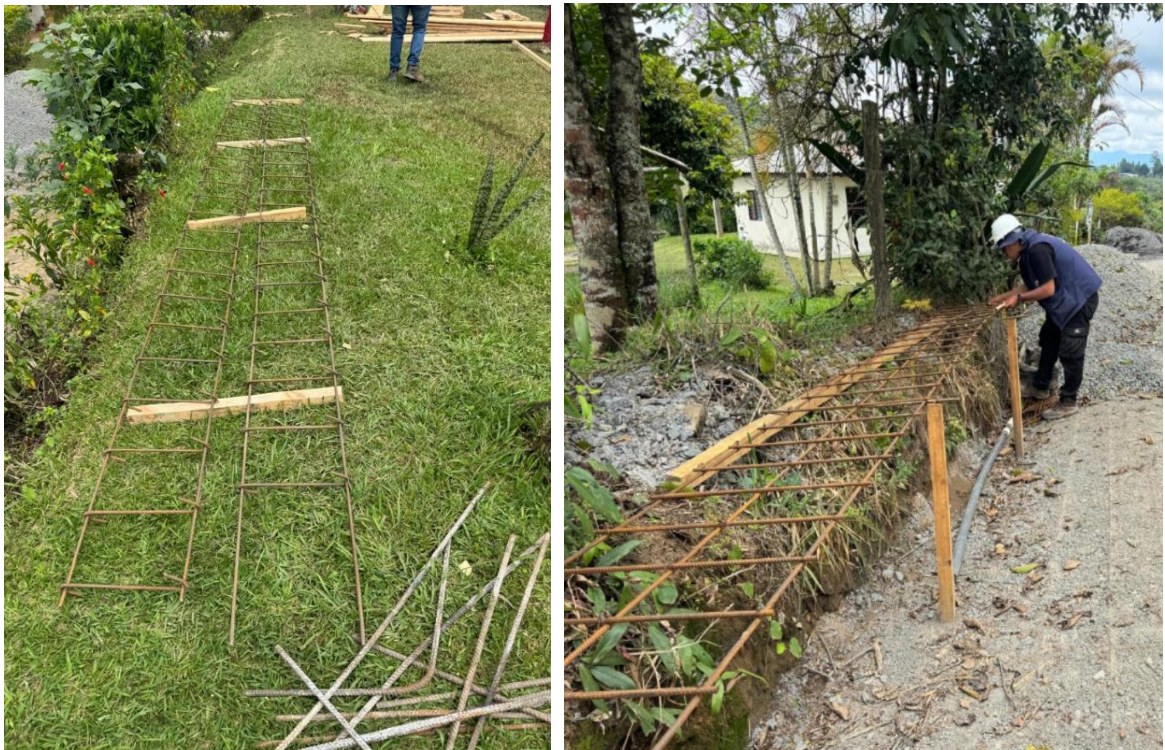
Figura 87. Armado de Acero para cunetas y Chequeo de separaciones de estribos.
