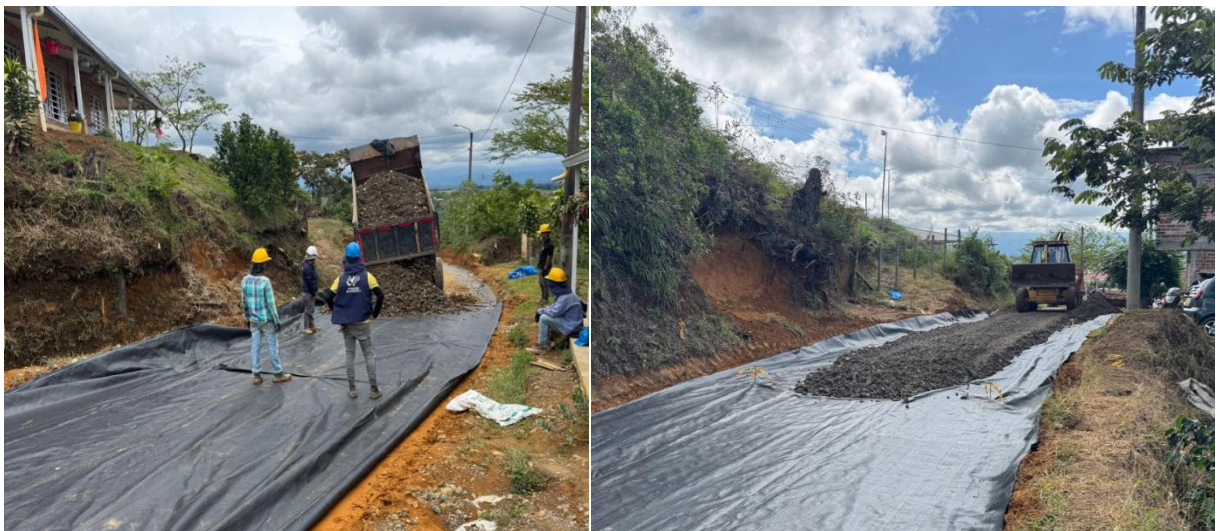
Figura 63. Distribución e Instalación de capa de Material tipo Mejoramiento sobre geotextil.
