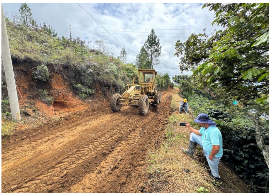
Figura 58. Excavación y Nivelación de Subrasante-Tramo 3.
