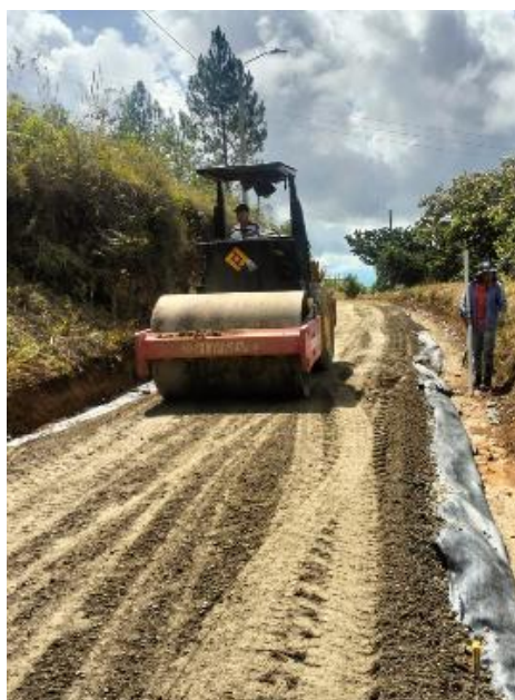
Figura 76. Compactación material tipo RCD-Tramo 3.
