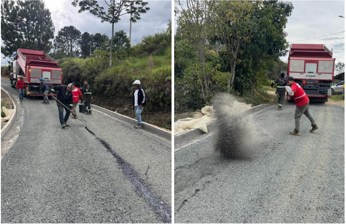
Figura 99. Aplicación manual de material y asfalto modificado para corrección superficial
