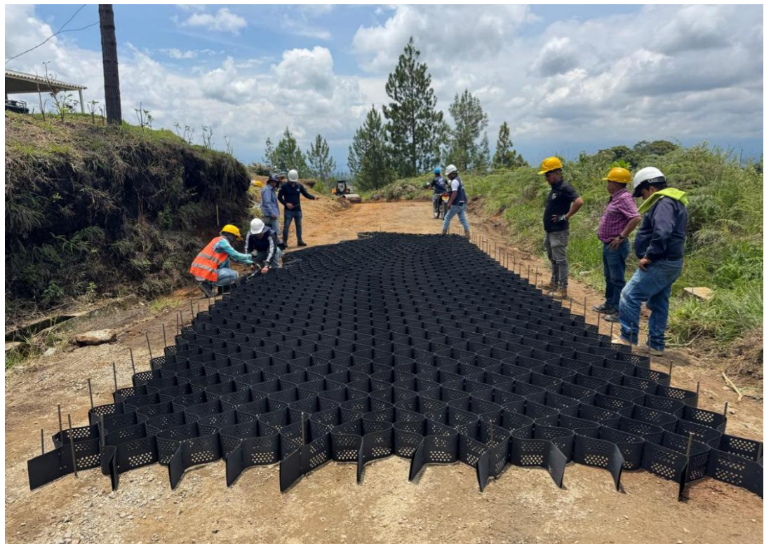
Figura 46. Instalación de Geoceldas Tramo 2.
