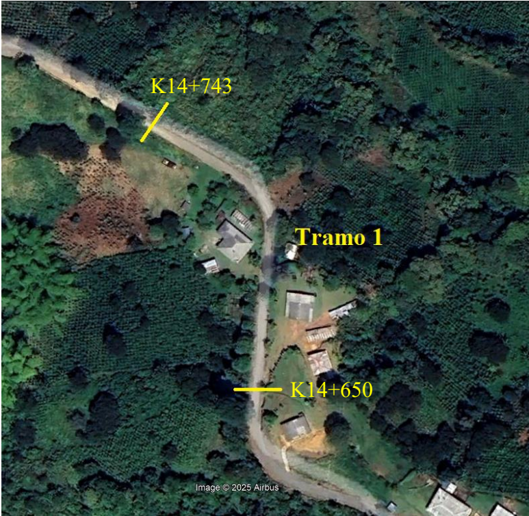
Figura 12. Identificación Tramo 1: K14+650 - K14+743.
