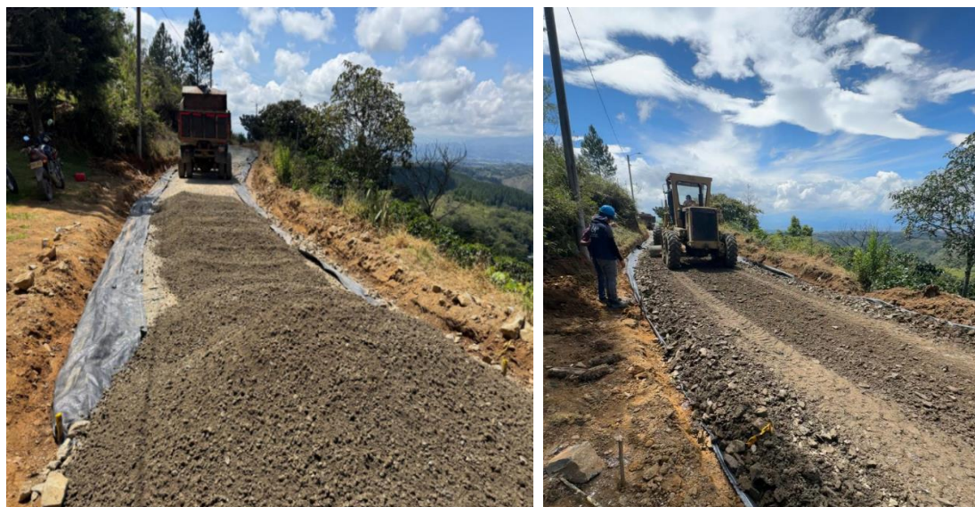
Figura 75. Instalación y Nivelación de Ecobase (RCD)- Tramo 3
