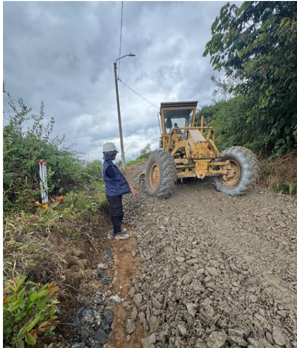
Figura 72. Nivelación Material Tipo Afirmado en Geoceldas.
