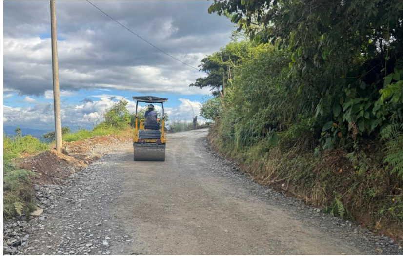
Figura 67. Compactación Material tipo Afirmado primer subtramo-Tramo 3.
