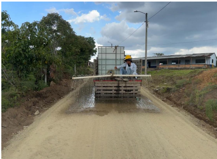
Figura 78. Hidratación de material para su respectivo Sello.
