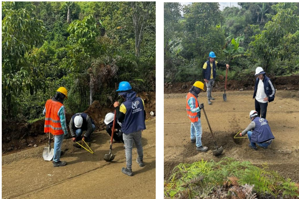
Figura 110. Chequeo de Espesores
