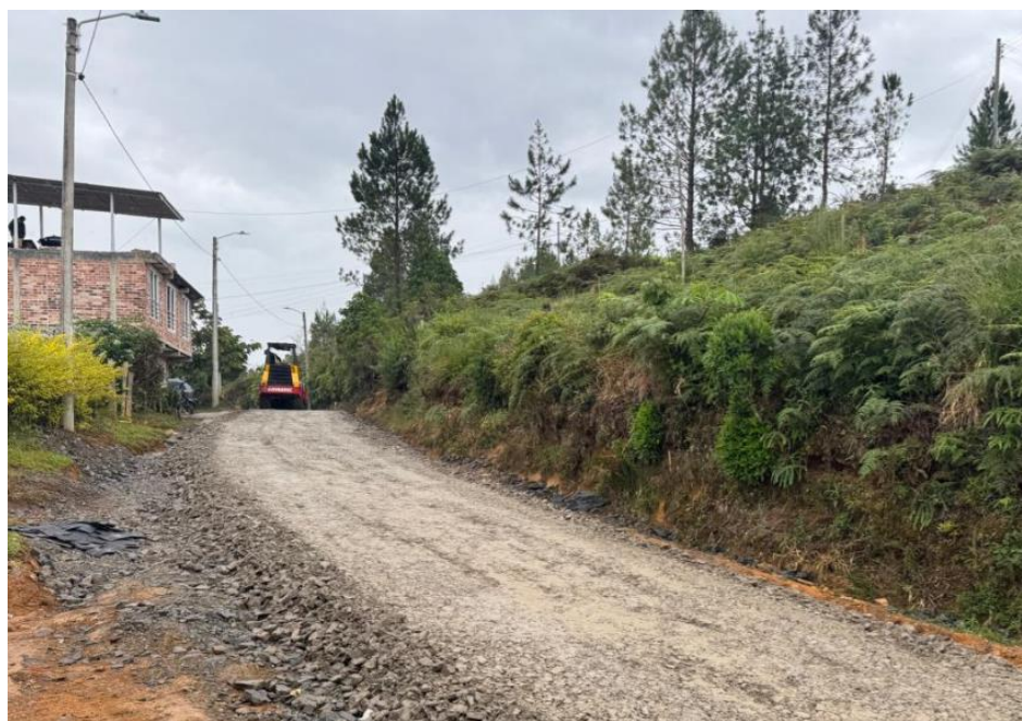
Figura 73. Compactacion de material Afirmado en Geoceldas-Tramo 3
