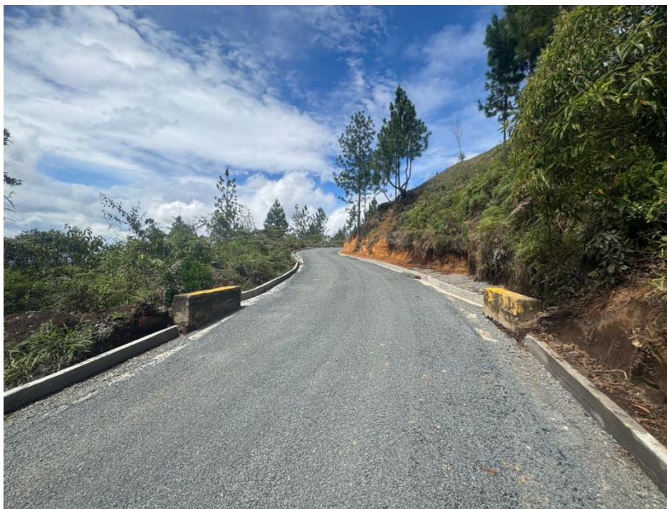
Figura 102. Tratamiento Superficial Doble - Tramo 2: K14+983,4 y K15+174,4.
