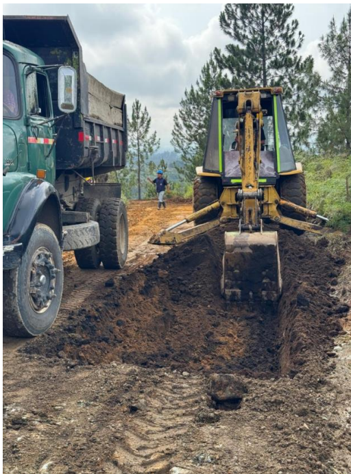
Figura 36. Excavación puntual para retiro de material no apto en subrasante – Zona A.
