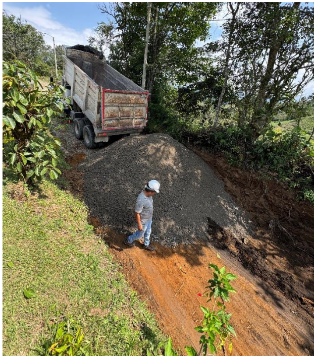
Figura 22. Descargue de afirmado para reemplazo de material inestable en subrasante.
