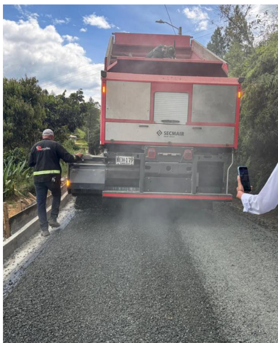
Figura 97. Instalación de TSD - Capa 3/8
