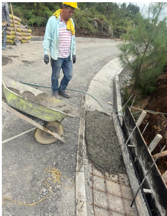
Figura 89. Vaciado de concreto en Cunetas.
