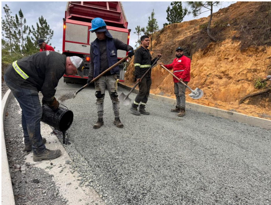
Figura 98. Vertimiento manual de asfalto modificado
