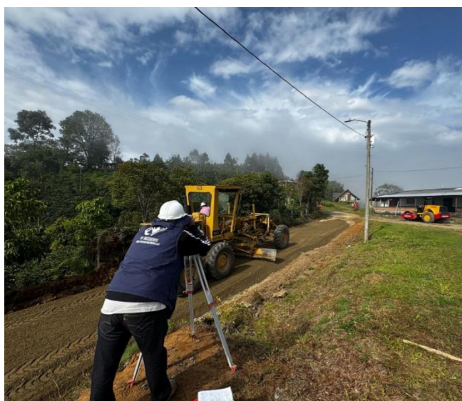
Figura 54. Instalación y Nivelación de Material tipo RCD con Motoniveladora.
