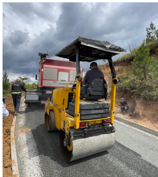
Figura 97. Instalación de TSD - Capa 3/8
