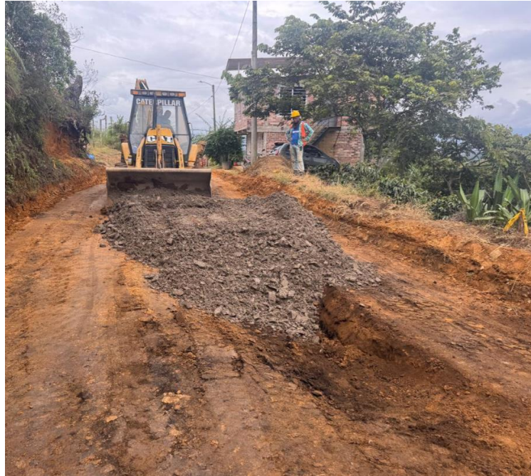
Figura 60. Reemplazo de material no apto para Subrasante.
