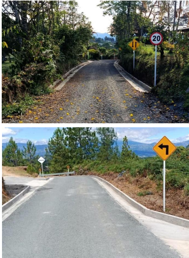
Figura 107. Instalación de Señales de Tránsito.
