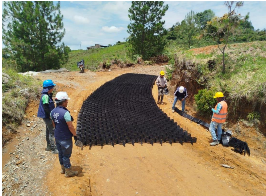
Figura 49. Instalación de Geoceldas en curva-Tramo 2.
