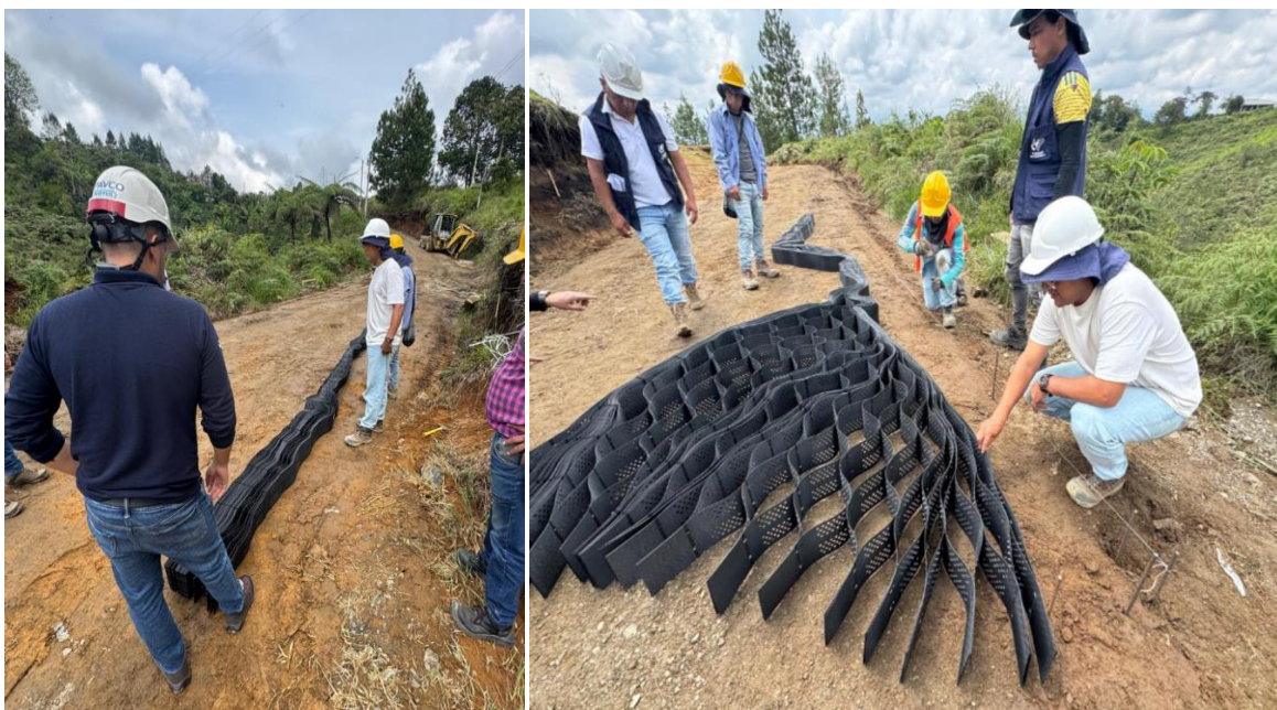
Figura 44. Despliegue y preparación de geoceldas para su instalación en calzada
