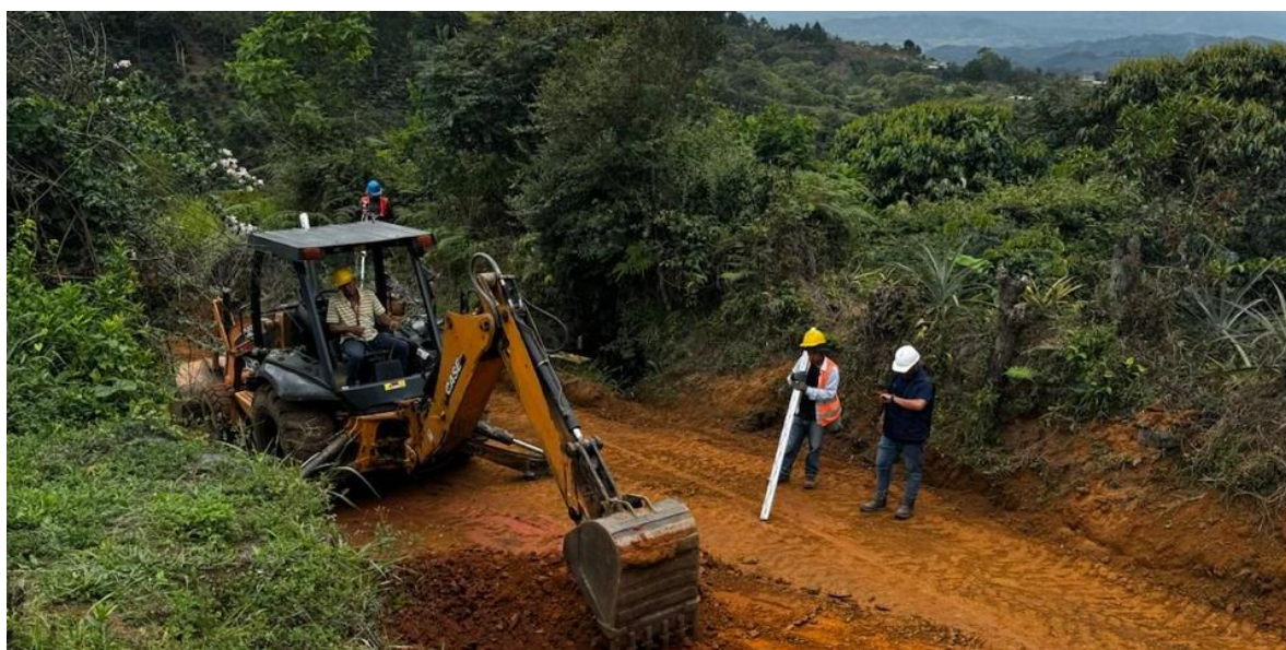
Figura 20. Excavcion y preparación de Subrasante.
