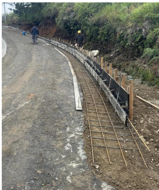
Figura 88. Encofrado e instalación de acero de refuerzo para Cunetas.
