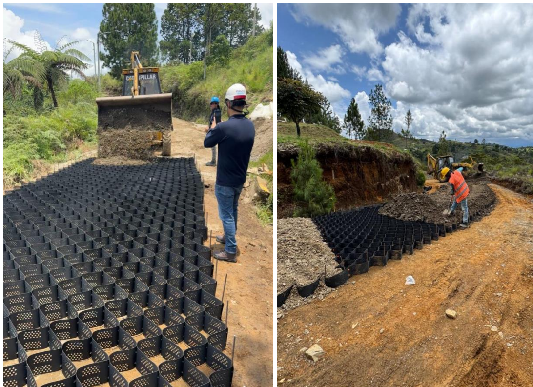
Figura 50. Vertimiento de Material en Geoceldas
