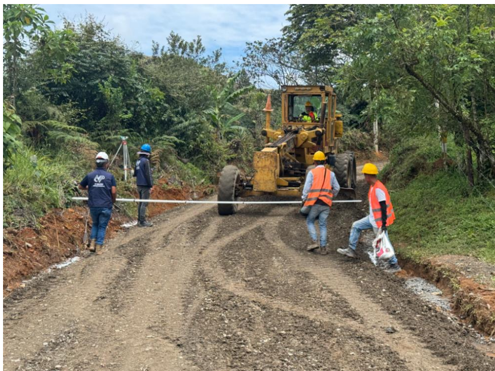
Figura 28. Distribución de Material y Chequeo de espesores.
