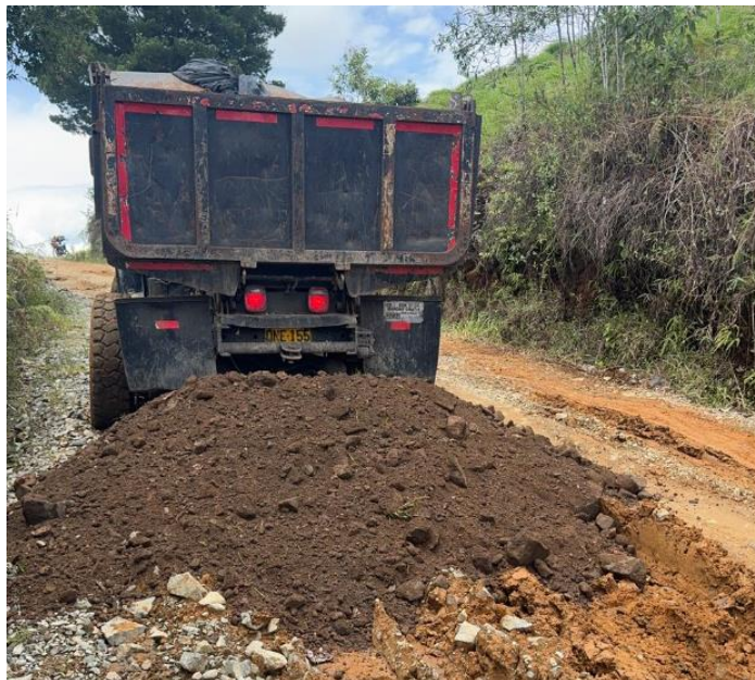
Figura 114. Instalación de Material Granular para Reparación.
