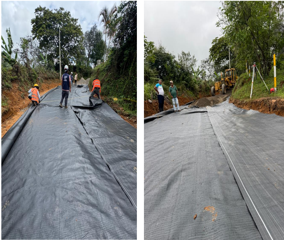
Figura 25. Instalación del geotextil T-2400 sobre subrasante.
