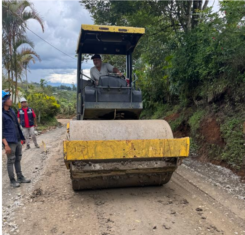
Figura 31. Compactación de Afirmado, Capa 0.25m.
