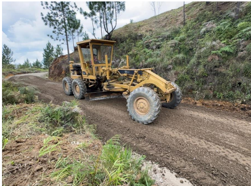
Figura 40. Nivelación y Distribución de Material tipo Afirmado tipo Afirmado, Tramo 2
