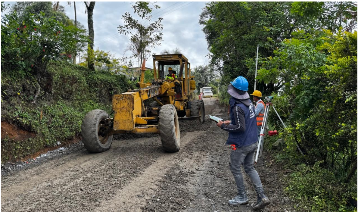
Figura 30. Nivelación del afirmado con motoniveladora y apoyo topográfico.
