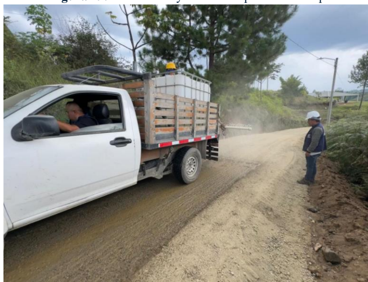
Figura 79. Hidratación y acabado superficial de capas.
