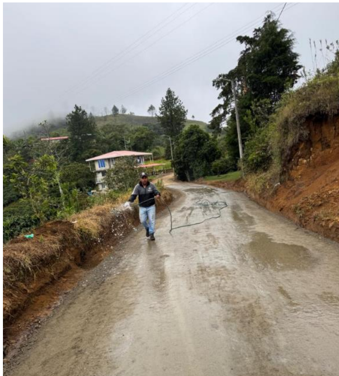
Figura 77. Hidratacion de material tipo Ecobase (RCD).
