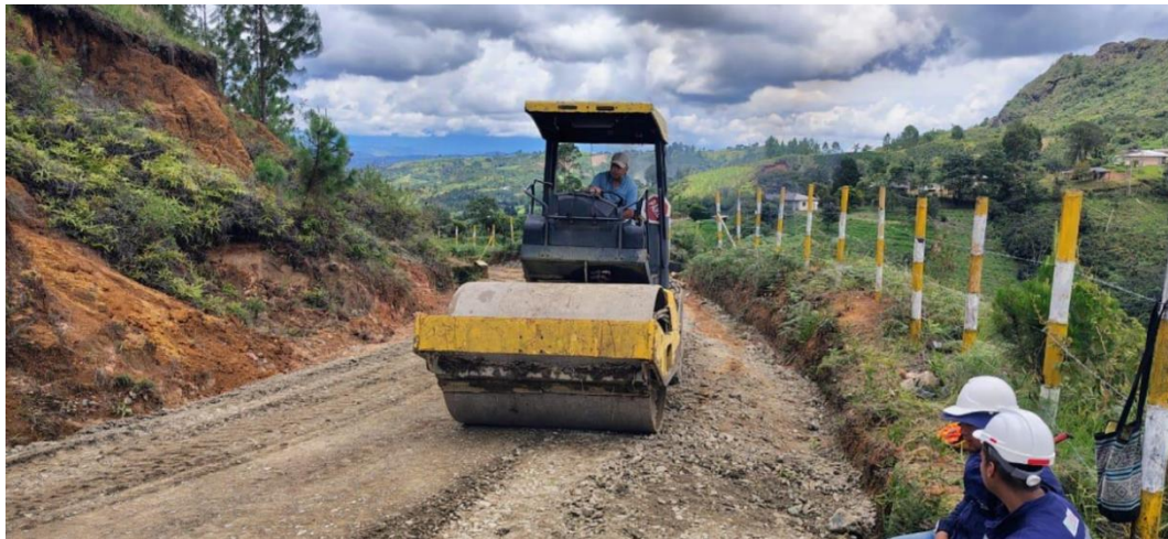
Figura 41. Compactación Material Tipo Afirmado Tramo 2.
