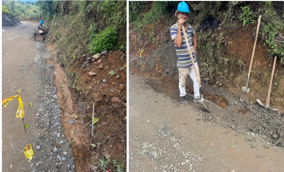
Figura 86. Delimitación y Excavación para Cunetas.
