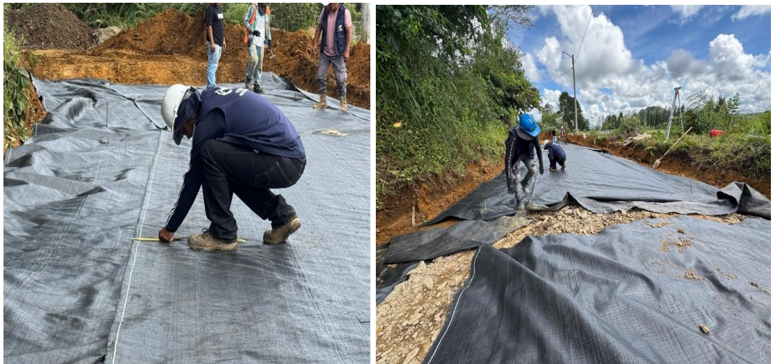
Figura 62. Instalación y verificación de Traslapo en Geotextil.
