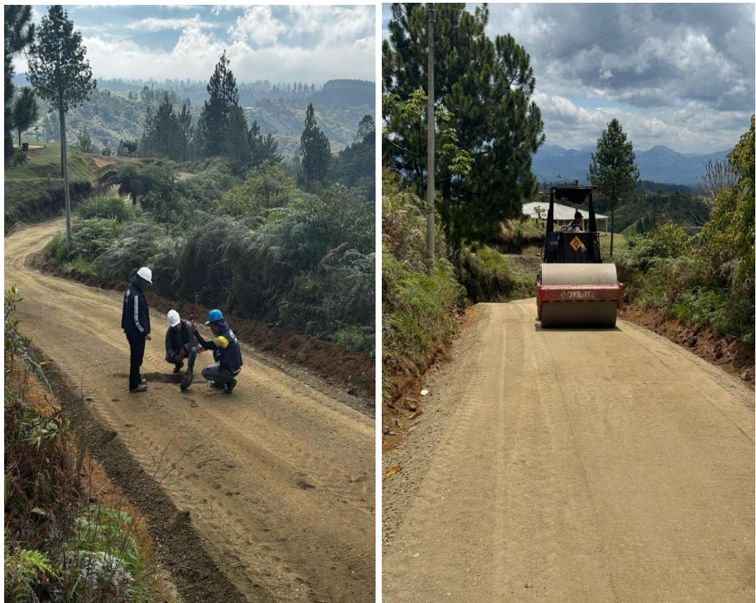
Figura 55. Seguimiento y Compactación de Material tipo RCD
