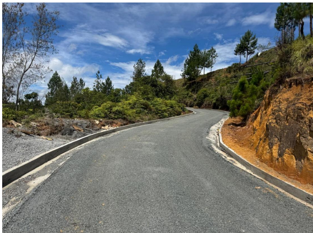
Figura 101. Tratamiento Superficial Doble – Tramo 2: K14+983,4 y K15+174,4
