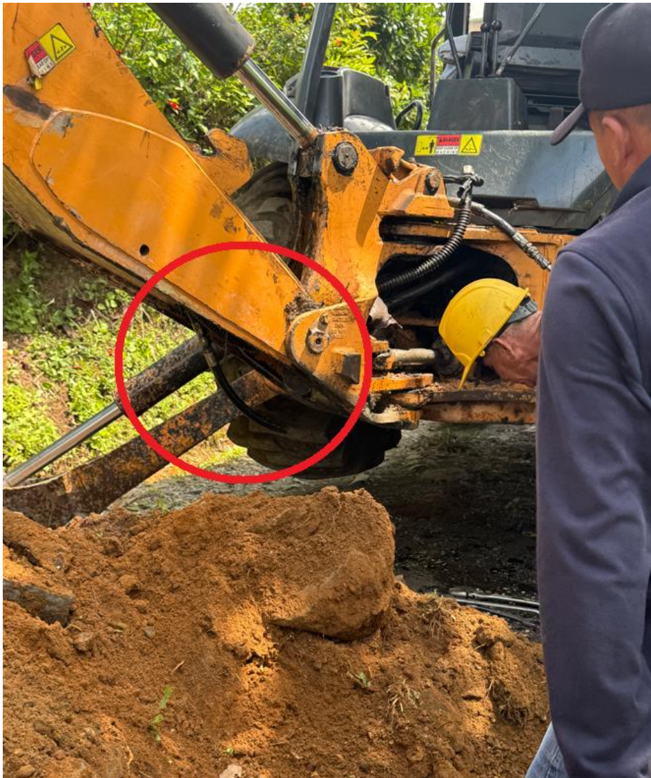
Figura 16. Falla Mecánica en Retroexcavadora
