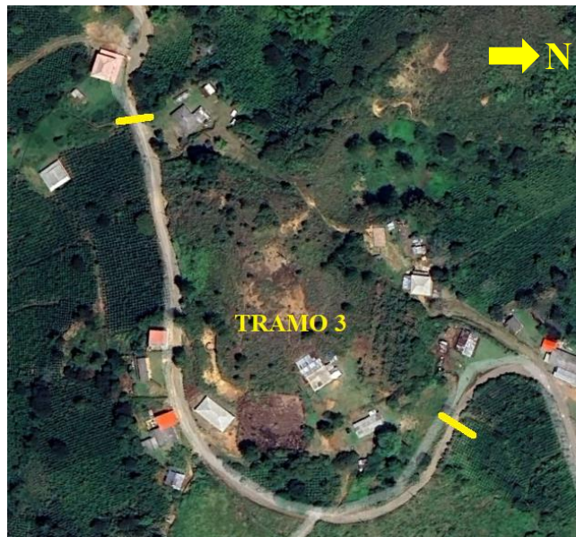
Figura 56. Identificación Tramo 3: K15+371,4 - K15+650.
